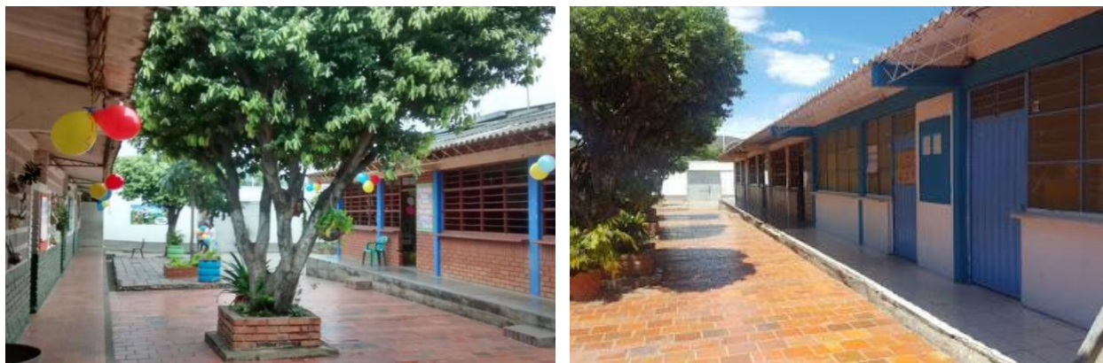
Figura 3. Colegio Instituto Técnico Patios Centro 2-Sede Patios Centro Uno
