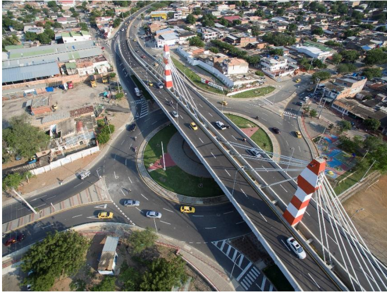
Figura 4, panorámica de Cúcuta
