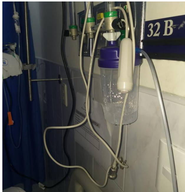
Figura 76. Ronda de seguridad hospitalización bloque B, sede principal.
