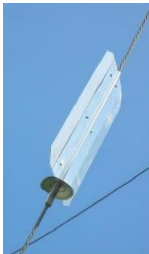
Figura 23. Dispositivo anti escalamiento tipo paleta 20X50 cm, CNFL 2022.
