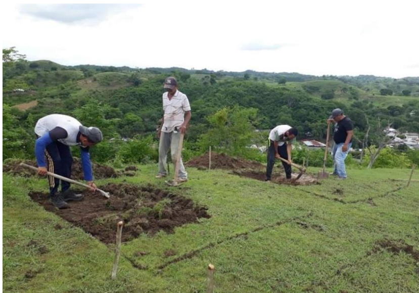
Ilustración 5 proceso de excavación para el depósito de compost, fuente autor.
