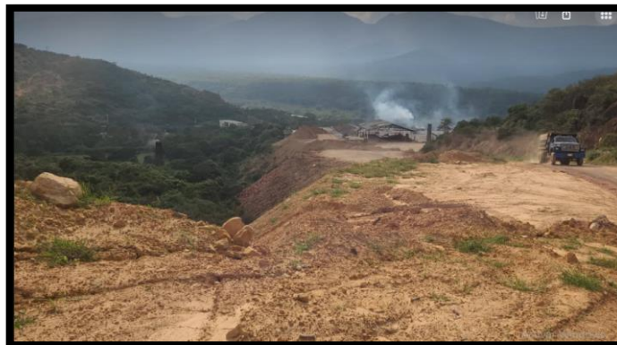
Ilustración 16. Deslizamiento natural de tierra por lluvias y demás factores Ambientales Fuente propia, 2022.
