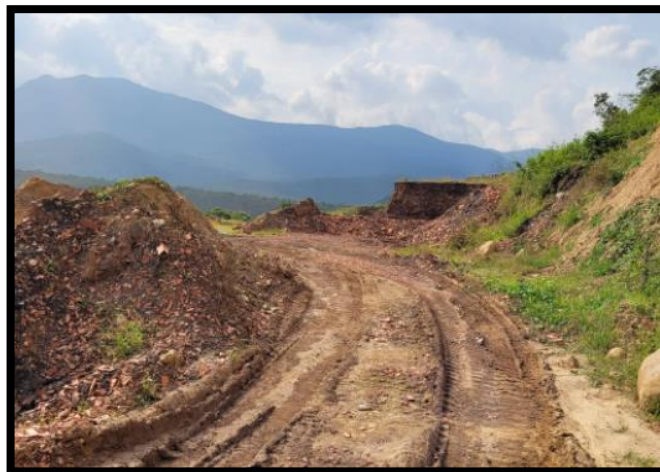
Ilustración 19. Vías de Cerámicas América, por mejorar, debido a la cantidad de lluvias presentadas. Tomada al área de estudio, 2022.
