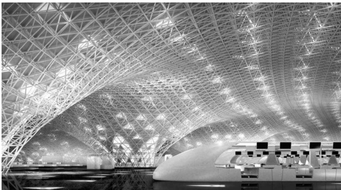
Figura 1. Estructura metálica de cubierta principal diseñada y ejecutada mediante metodologías Bim.
