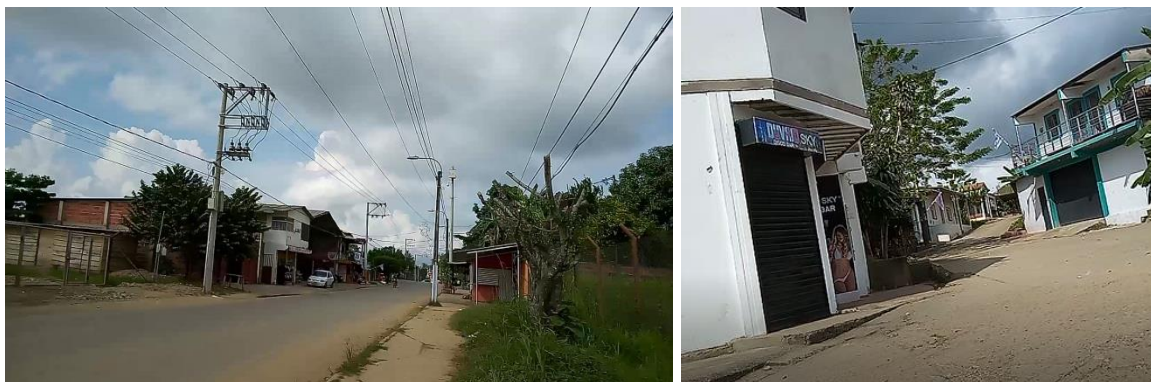
Fotografía 2. Estado de Calle 5 o vía principal, a la derecha el lote; y el estado de la vía en la Carrera 6E.
