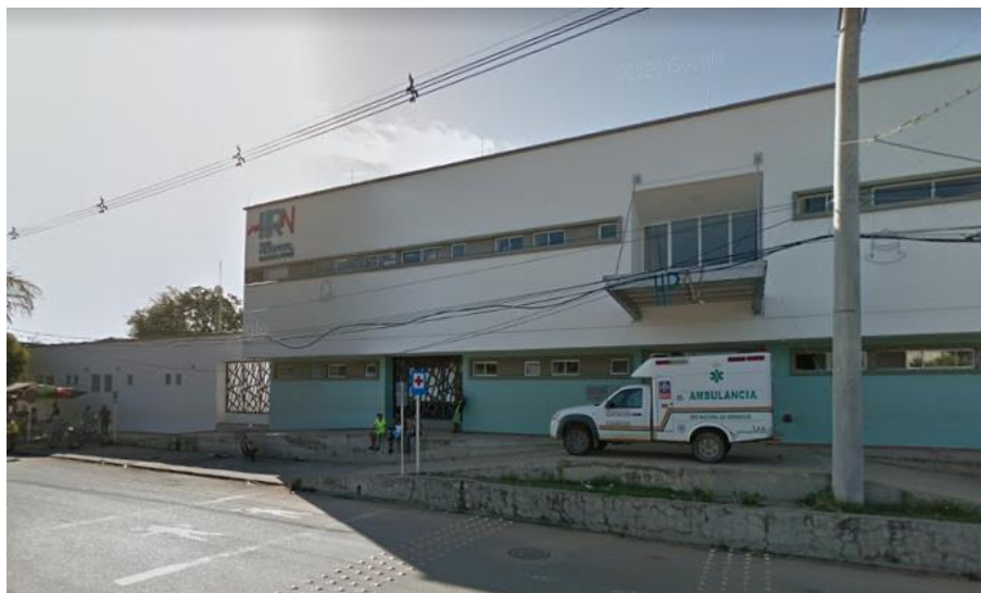
Figura 6. Fachada y acceso principal Hospital San José de Tibú. (Fuente: La Opinión, 2019)
