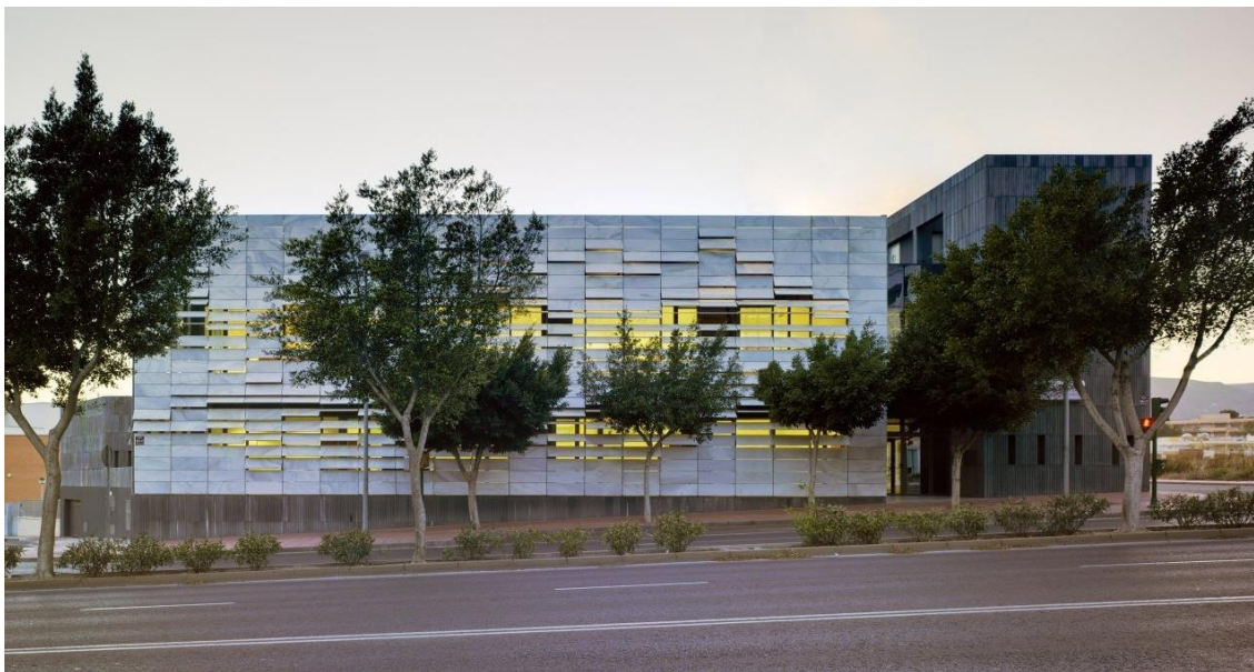
Figura 11. Fachada principal de acceso al Centro de Salud Mediterráneo Norte. (Fuente: Archdaily.co, 2012)
