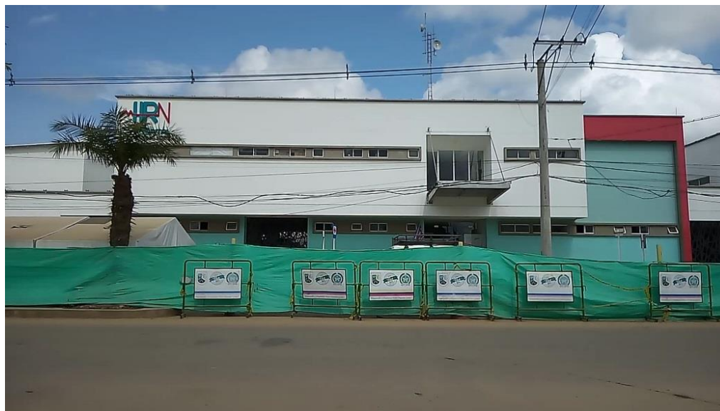
Fotografía 1. Cerramiento de la vía para uso del Hospital San José de Tibú.
