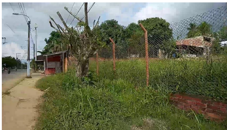
Fotografía 3. Estado de los andenes y la vegetación en el lote. (Fuente: Trabajo de campo febrero 2021)
