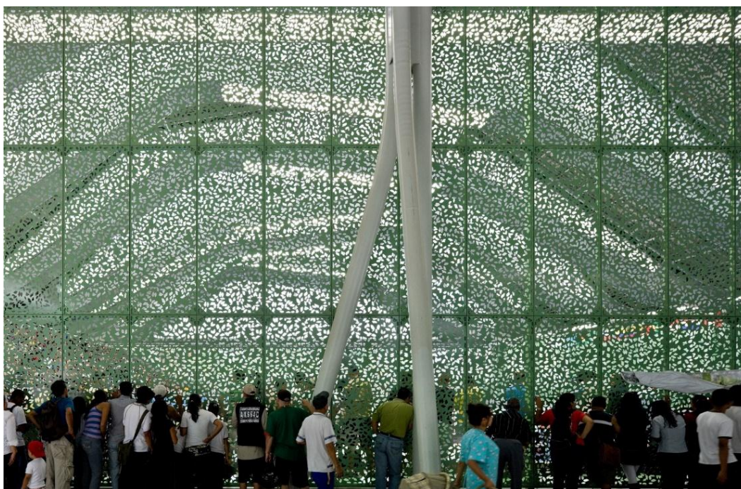
Figura 4. Fachada acero microperforado / escenarios deportivos Medellín /Giancarlo Mazzanti
