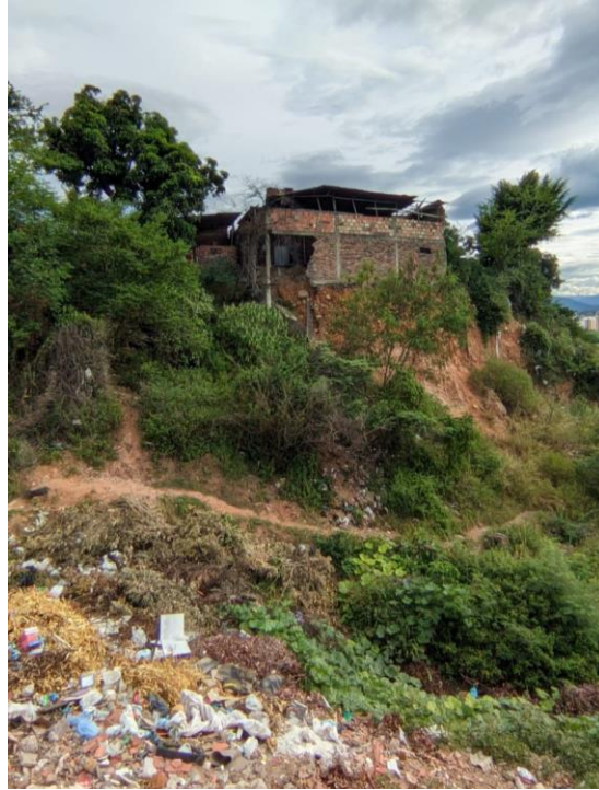
Figura 16. Casa deteriorada, zona alta de la laguna.
