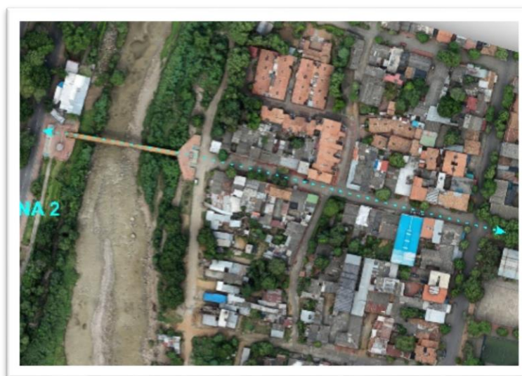
Figura 28. Imagen satelital del puente peatonal.
