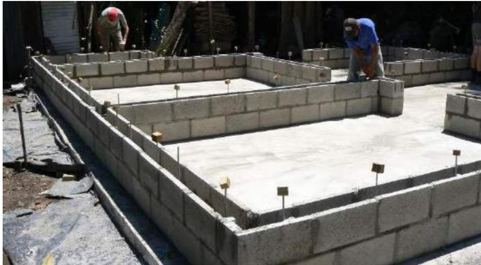
*Figura 67 Ejemplo de soporte vertical simple de viviendas de bahareque encementado, que consta de dos cursos de bloques reforzados, con un total de 400 mm de altura desde la base.*
