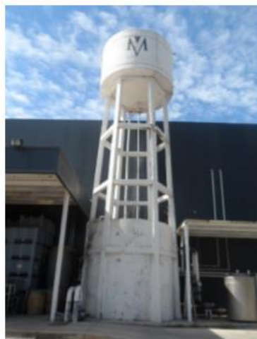
Figura 27. Estructura de soporte de tanque elevado Fuente: Guzmán, et al, (2019)
