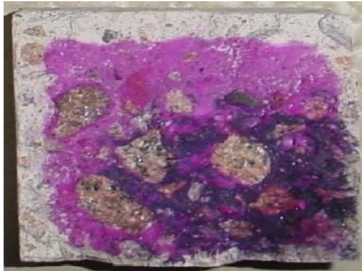
Figura 5. Prueba de la profundidad de carbonatación spray de fenolftaleína. Violeta: hormigón todavía alcalino, incoloro: hormigón carbonatado.
