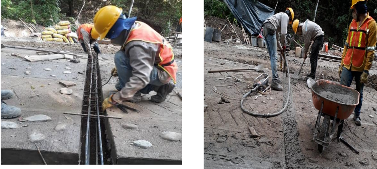
Imagen 28. Armado de acero para vigas y viguetas
