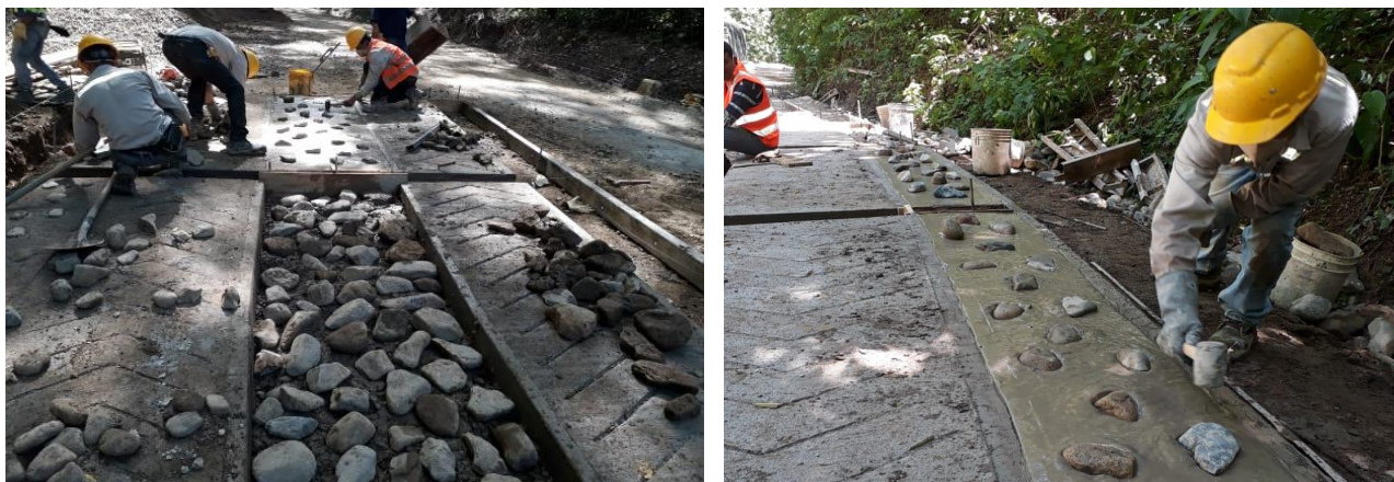
Imagen 24. colocación de piedra para concreto ciclópeo para franja central y lateral
