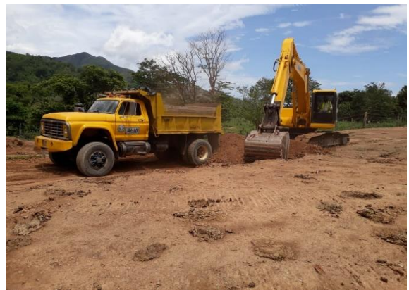
Imagen 17. Conformación y compactación de la subrasante
