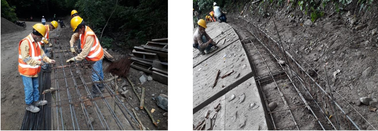
Imagen 21. Armado y colocación de acero de refuerzo
