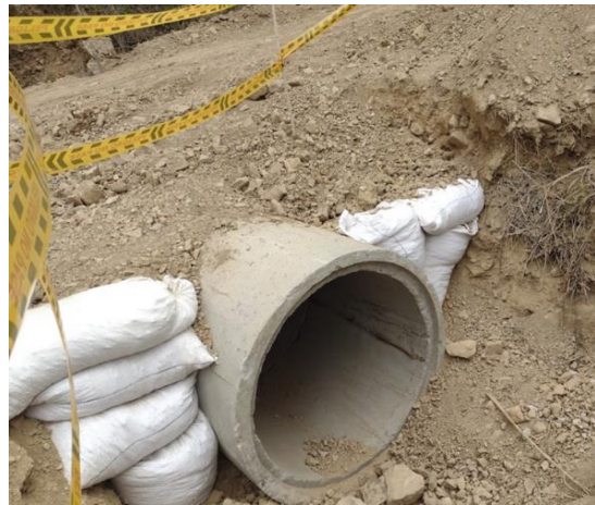
Imagen 15. Relleno con material seleccionado.
