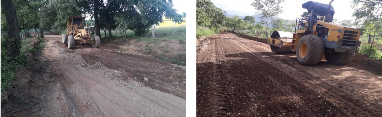
Imagen 18. Suministro y extendida de Subbase cbr 30% tipo Invias para pavimento
