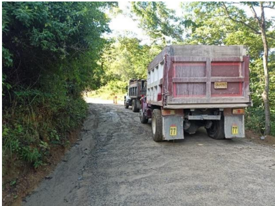
Imagen 7. Transporte de materiales provenientes de la excavación, de la explanación, canales y prestamos
