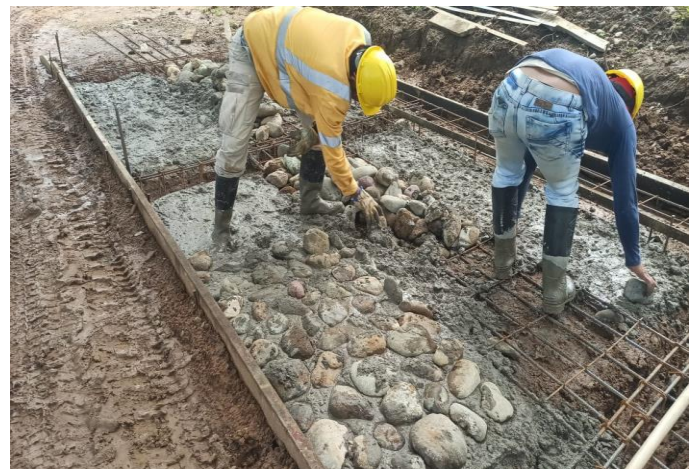
Imagen 23. Concreto ciclópeo, para franja central y lateral-colocación de piedras sobre el concreto
