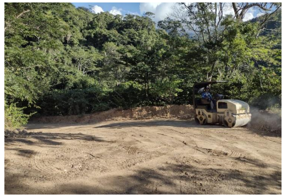
Imagen 16. Conformación de subrasante
