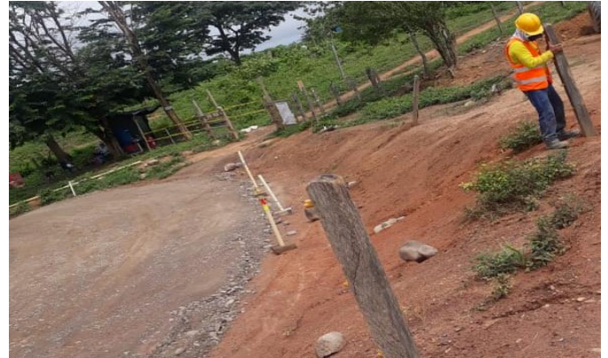
Imagen 5. desmonte y limpieza en zonas no boscosas
