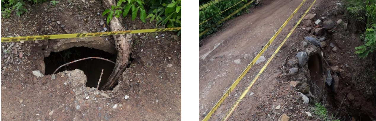
Imagen 10. Remoción de alcantarillas existentes
