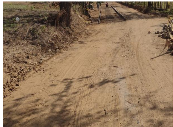
Imagen 13. extendida de material de terraplén
