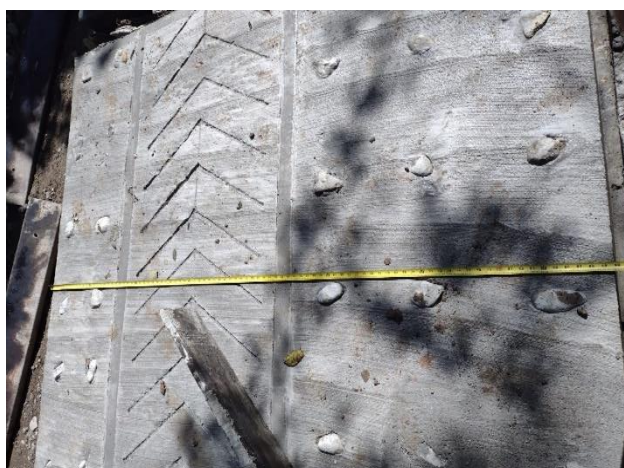
Imagen 25. Verificación de calidad de la obra
