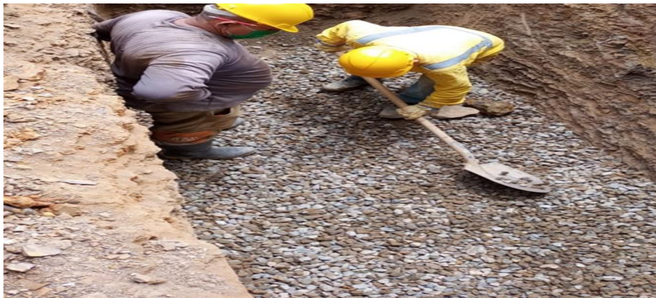
Imagen 22. Instalación de material filtrante
