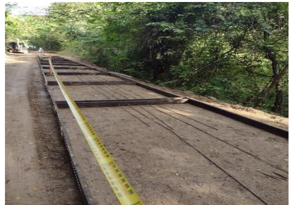
Imagen 20. Colocación y verificación de acero de refuerzo
