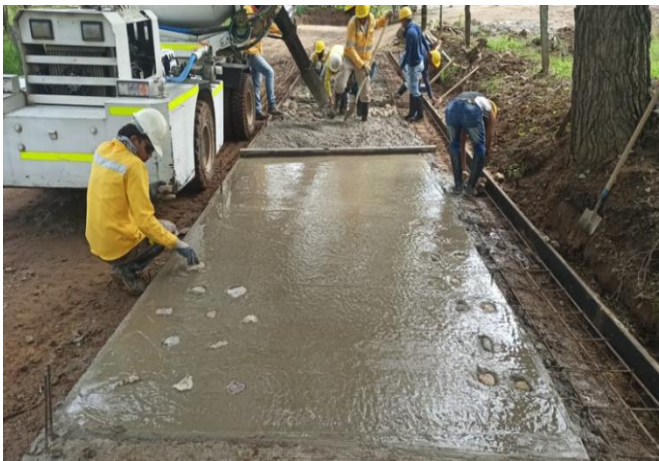
Imagen 23. Concreto ciclópeo, para franja central y lateral-colocación de piedras sobre el concreto
