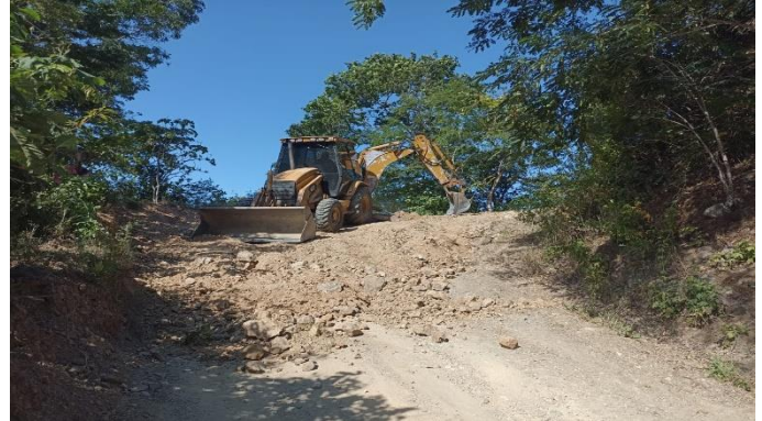
Imagen 11. excavación en material común de la explanación y canales
