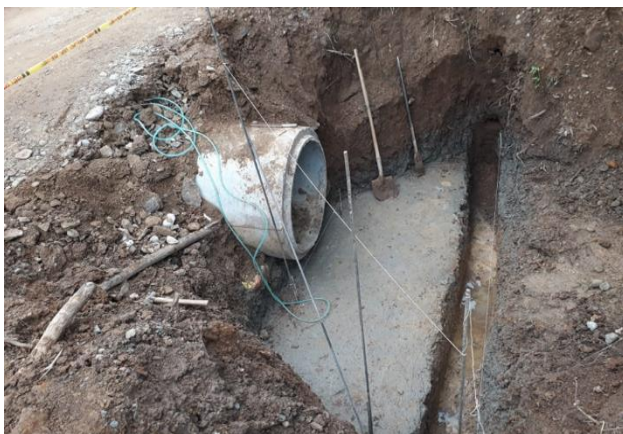
Imagen 19. verificación de niveles para alcantarilla e instalación de tubería
