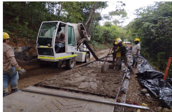
Imagen 26. concreto de 3000 psi, para estructuras de drenaje
