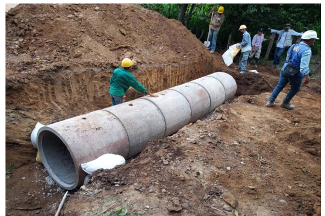
Imagen 19. verificación de niveles para alcantarilla e instalación de tubería
