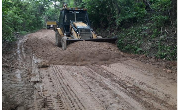
Imagen 12. distancia de acarreo 20 km-material terraplén
