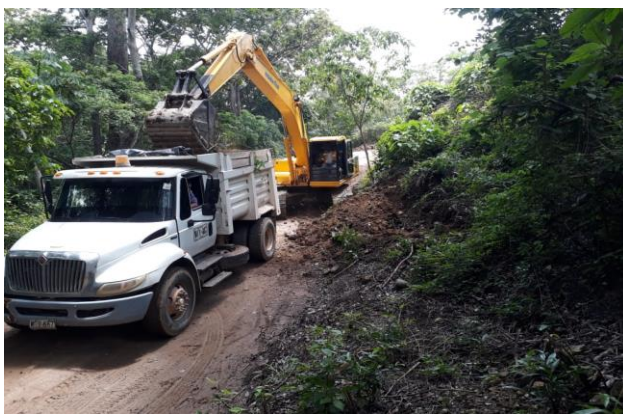
Imagen 8. Transporte de materiales provenientes de la excavación, de la explanación, canales y prestamos
