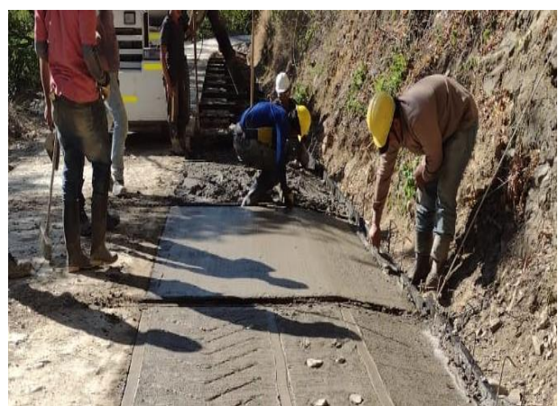
Imagen 27. Concreto de 3000 psi, para cuneta
