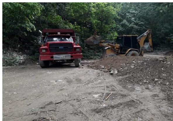
Imagen 8. Transporte de materiales provenientes de la excavación, de la explanación, canales y prestamos
