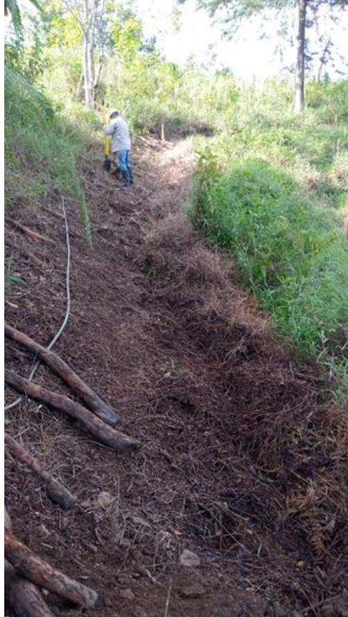
**Figura 55.** Hueco para trincho en madera.
