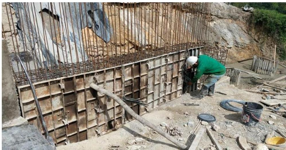
**Figura 16.** Acero de refuerzo para viga cabezal. Fundida de zarpa.
