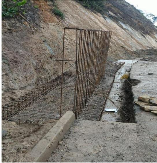
**Figura 33.** Acero de refuerzo para pantalla 60.000 psi.
