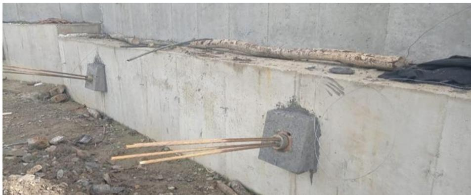
**Figura 22.** Dado cabezal en concreto 40 Mpa
