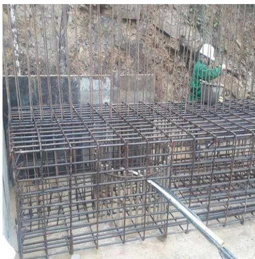
**Figura 15.** Acero de refuerzo para viga cabezal.
