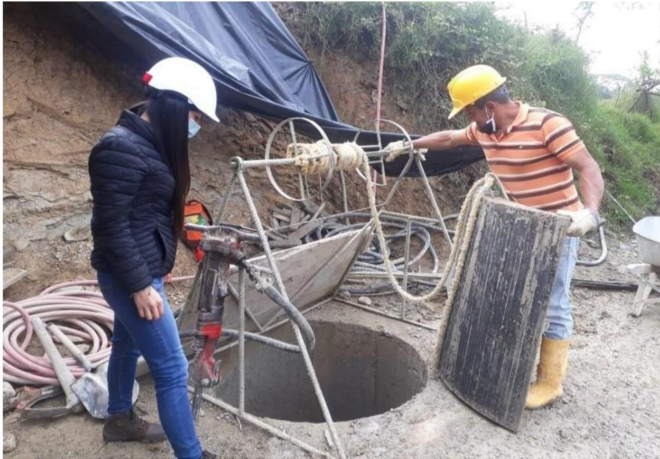
**Figura 9.** Formaleta para anillos de caisson
