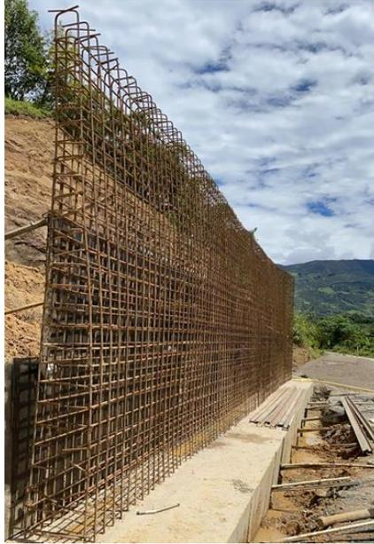
**Figura 40.** Armado de muro para pantalla.
