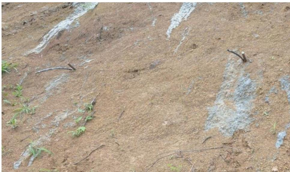
**Figura 52.** Lechada para anclajes.
