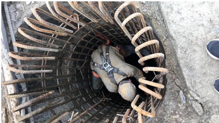
**Figura 13.** Acero de refuerzo para caisson 60000 psi.
