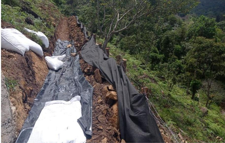
**Figura 56.** Trincho cuneta
