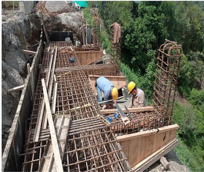
**Figura 43.** Armado acero de refuerzo para para viga va y vt y columna ct
