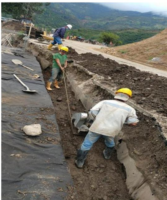
**Figura 25.** Relleno compactado mecánico.
