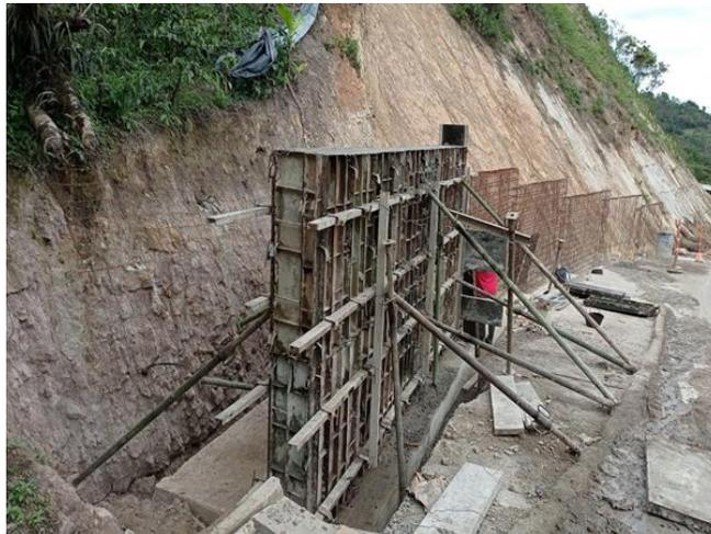
**Figura 34.** Armado de formaleta para fundida de pantalla
