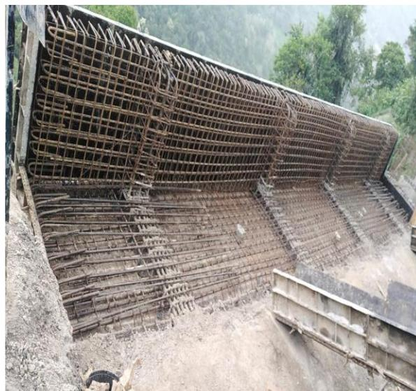
**Figura 44.** Armado acero de refuerzo para muro Mb
