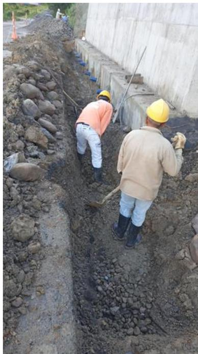
**Figura 42.** Relleno con material filtrante extendida humectada y compactada.
