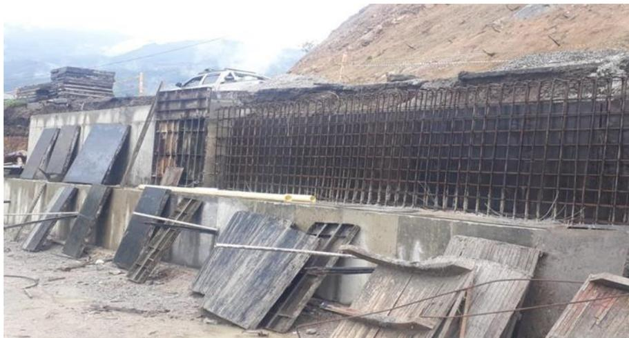
**Figura 19.** Armado de formaleta metálica para pantalla de muro.
