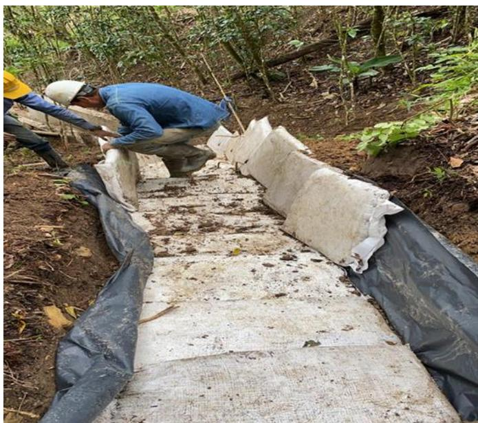
**Figura 58.** Sección grada disipadoras en sacos.
