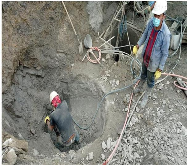
**Figura 10.** Excavación mecánica Prof. 0-12.
