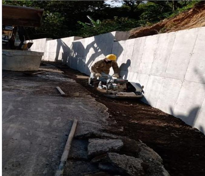
**Figura 37.** Relleno con material filtrante extendida humectada y compactada.
