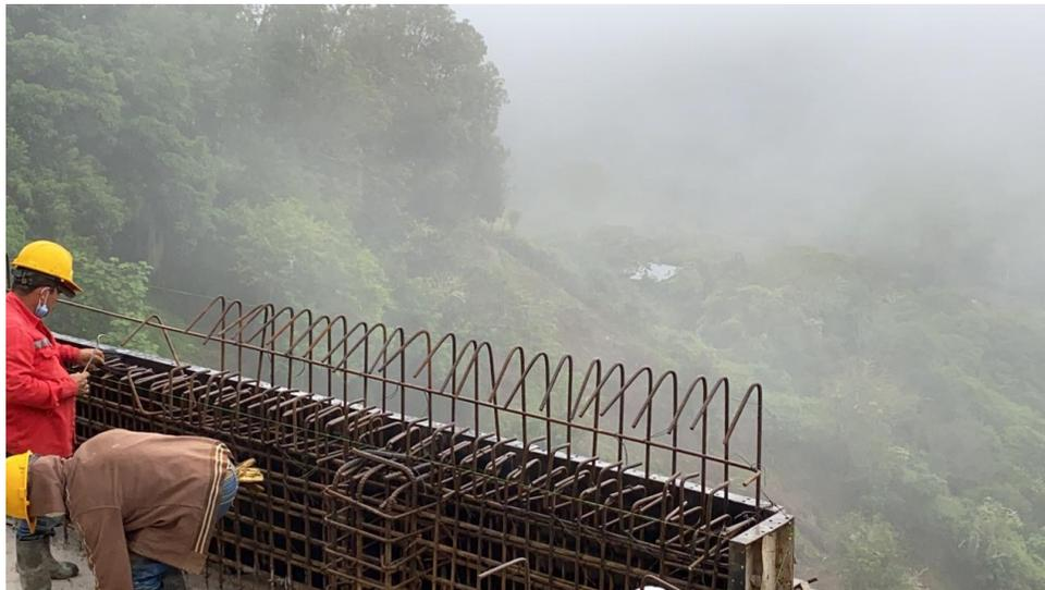
**Figura 45.** Armado acero de refuerzo para barrera tipo new jersey.
