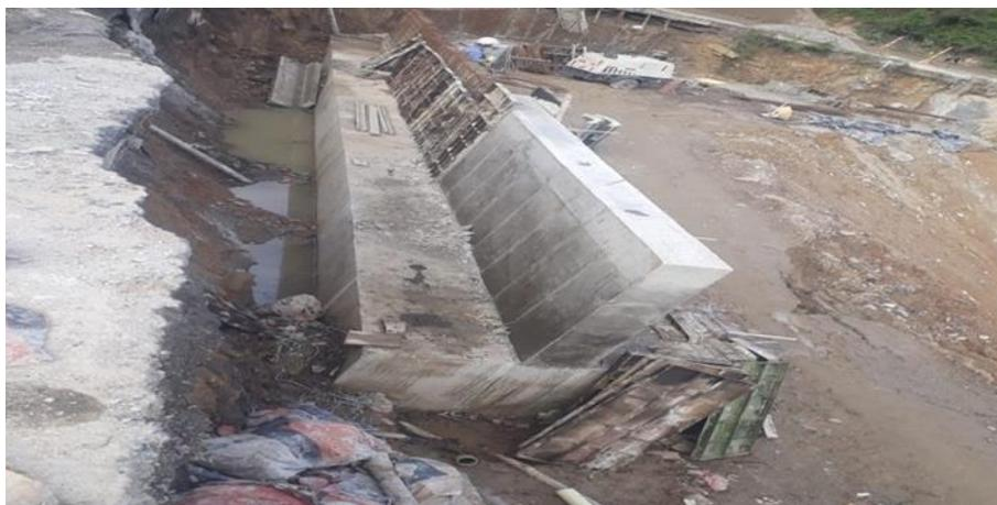
**Figura 18.** Fundida de pantalla de muro.
