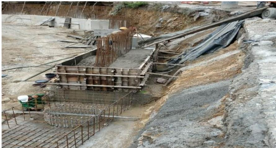
**Figura 17.** Formaleta metálica para viga.
