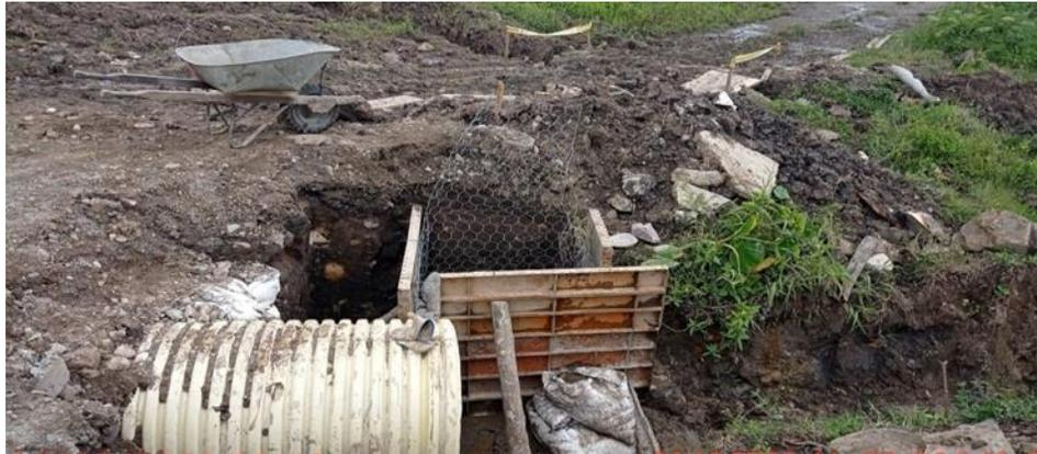
**Figura 61.** Instalación de malla galvanizada para descole en gaviones.
