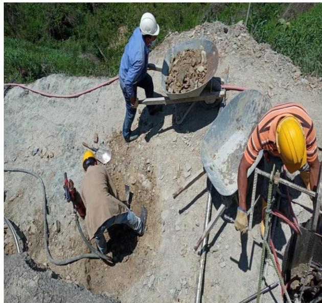
**Figura 4.** Excavación de material sin clasificar
