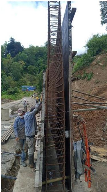
**Figura 41.** Armado de formaletas metálicas para pantalla de muro.
