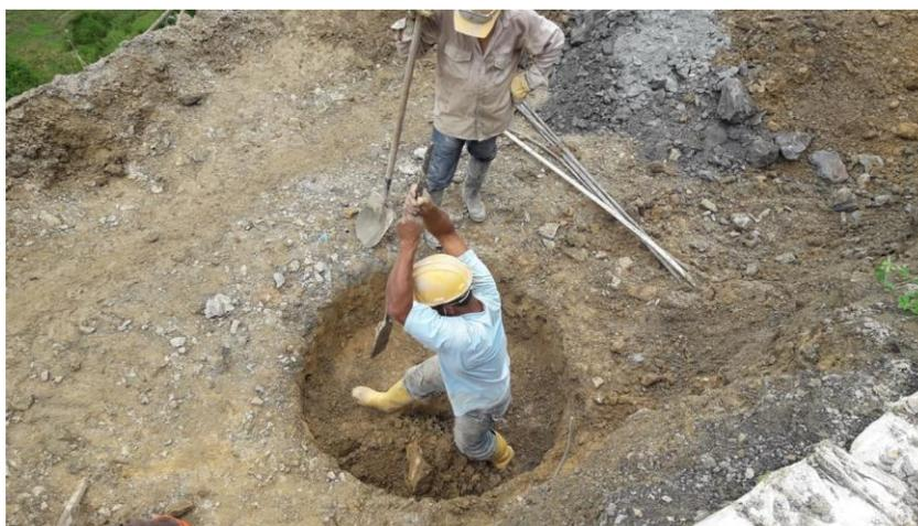
**Figura 6.** Excavación manual de material sin clasificar Prof. 0-8 metros.
