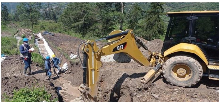
**Figura 59.** Excavación mecánica para instalar tubo de alcantarilla
