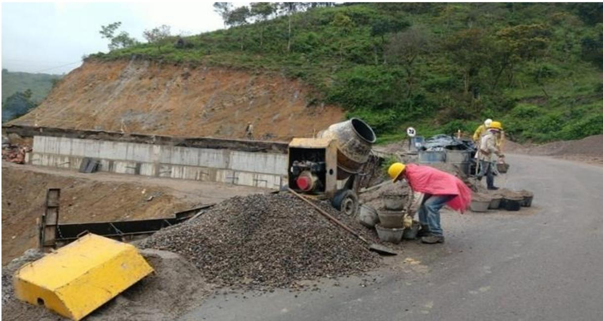
**Figura 21.** Fundida de pantalla de muro, en concreto de 24,5 Mpa.
