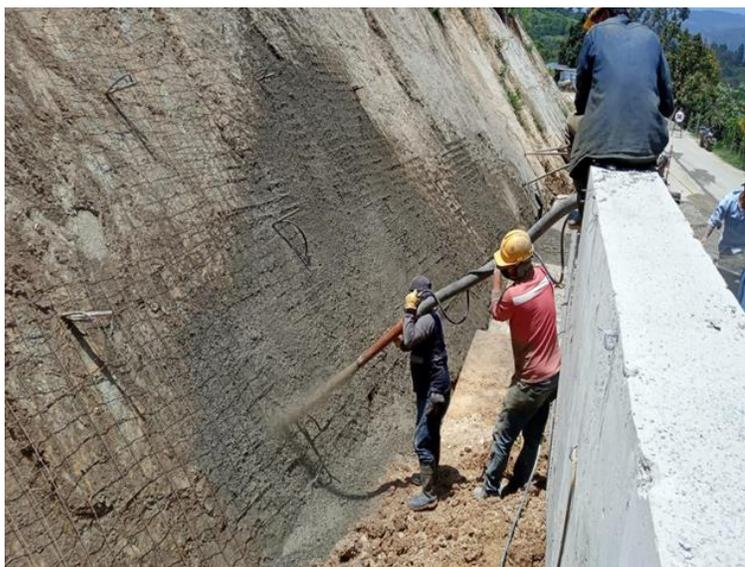
**Figura 36.** Concreto de 21 Mpa lanzado sobre talud, malla electrosoldada
