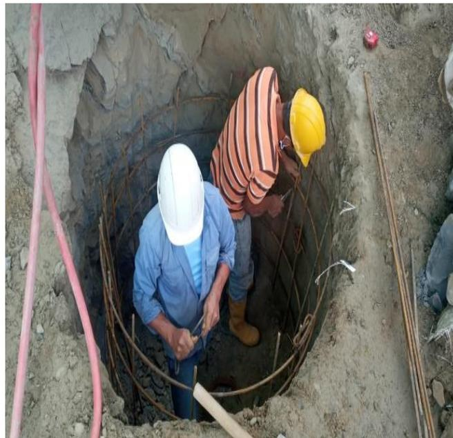
**Figura 8.** Acero de refuerzo para anillos.
