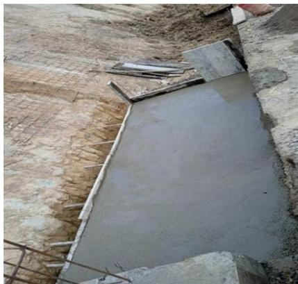
**Figura 32.** Solado fundido en concreto.
