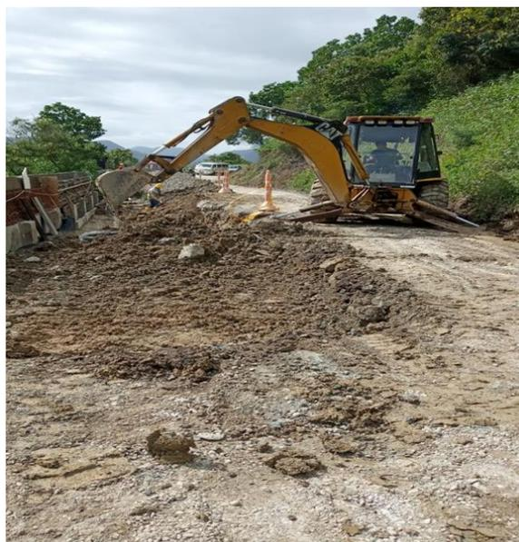
**Figura 47.** Relleno con material filtrante extendida humectada y compactada.
