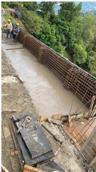
**Figura 46.** Fundida de losa en concreto de 28 Mpa.
