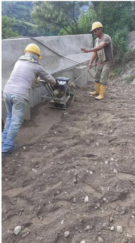
**Figura 48.** Relleno compactado mecánico
