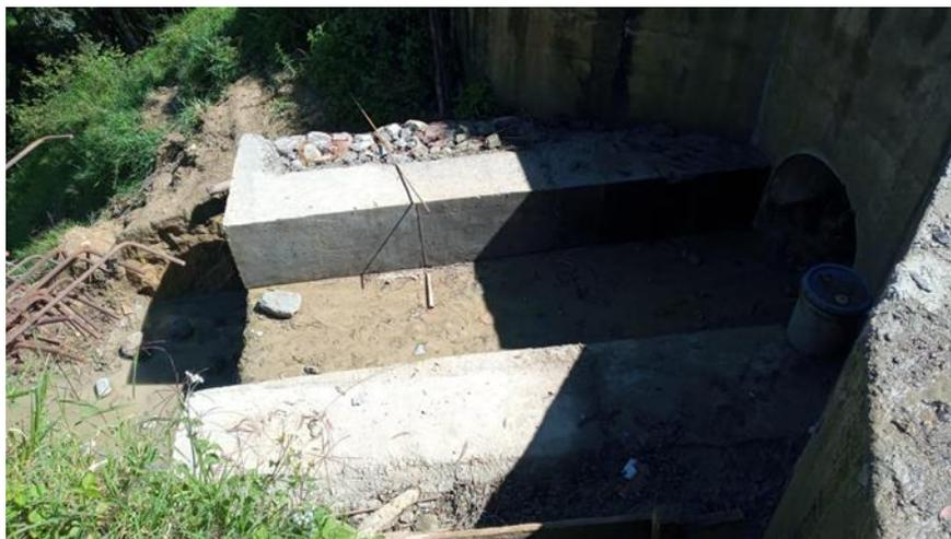
**Figura 63.** Gavión revestido y cimentado.
