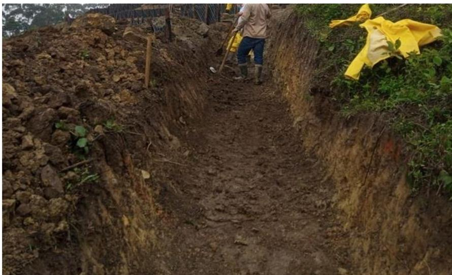
**Figura 57.** Excavación manual para grada disipadora
