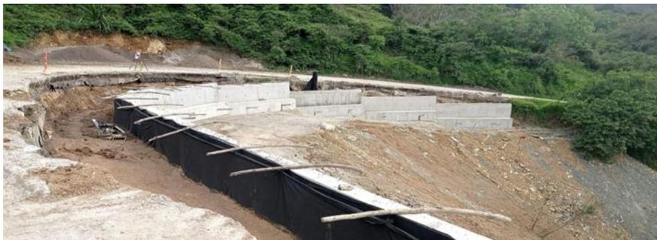
**Figura 23.** Instalación de manto geotextil
