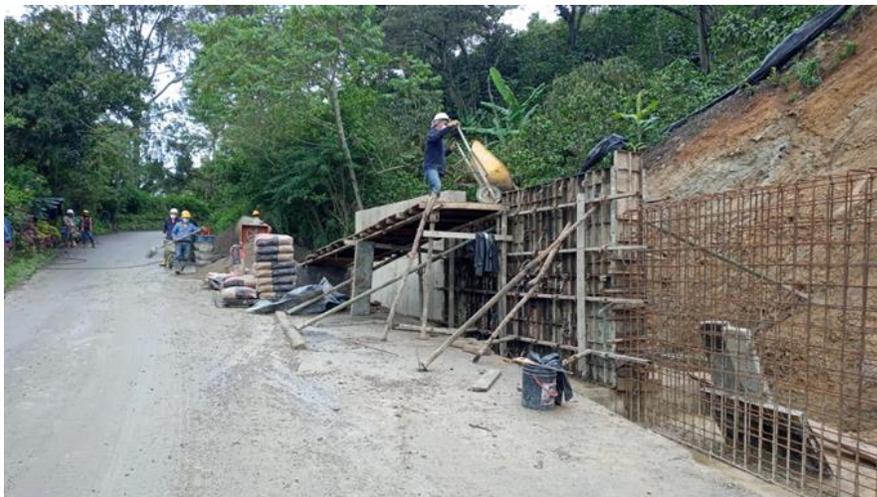
**Figura 35.** Fundida de pantalla, Se realiza con un concreto de 24,5 Mpa
