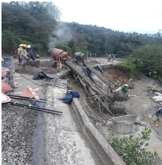
**Figura 14.** Fundida de Núcleo de caisson.
