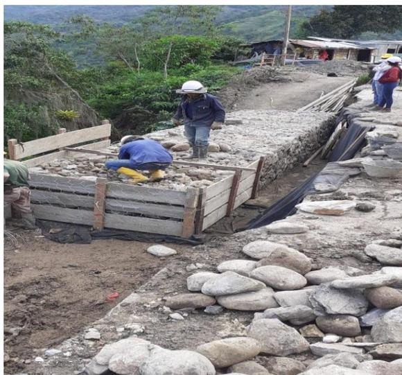
**Figura 28.** Gaviones en malla galvanizada.
