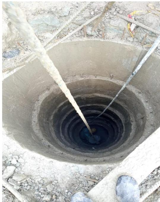
**Figura 12.** Instalación de solado en concreto de 17.5 Mpa.
