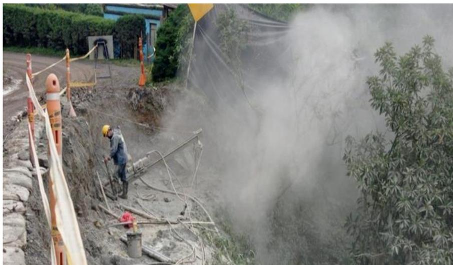
**Figura 51.** Perforación anclaje activo.
