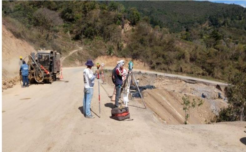
**Figura 3.** Localización, replanteo y control topográfico.
