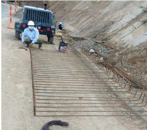
**Figura 31.** Armado de acero.
