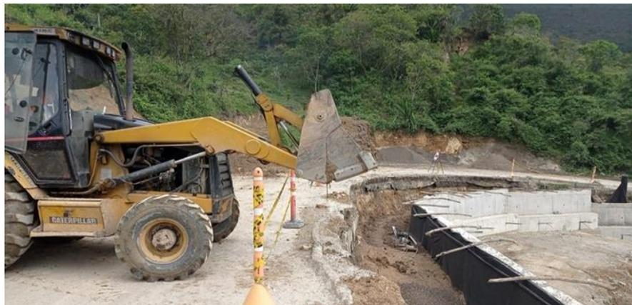
**Figura 24.** Relleno con material filtrante.
