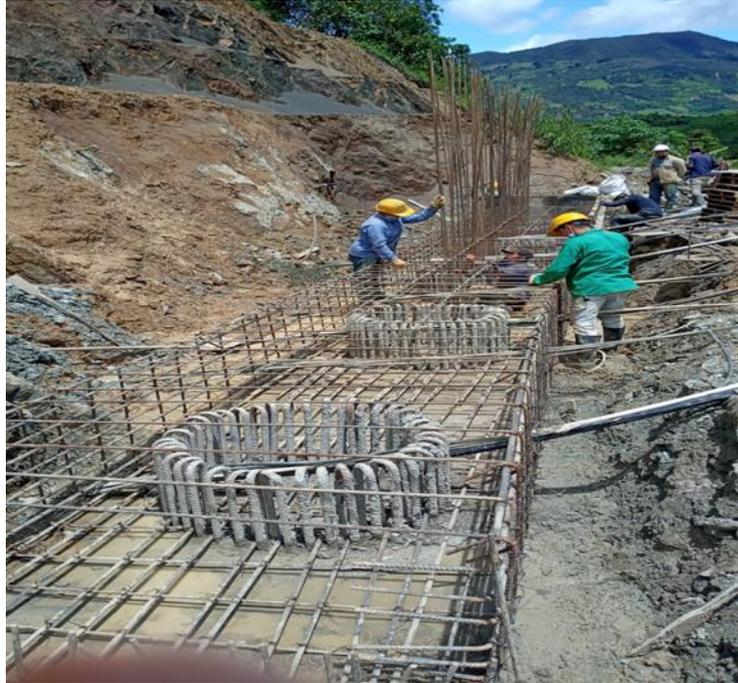
**Figura 38.** Armado de acero reforzado.
