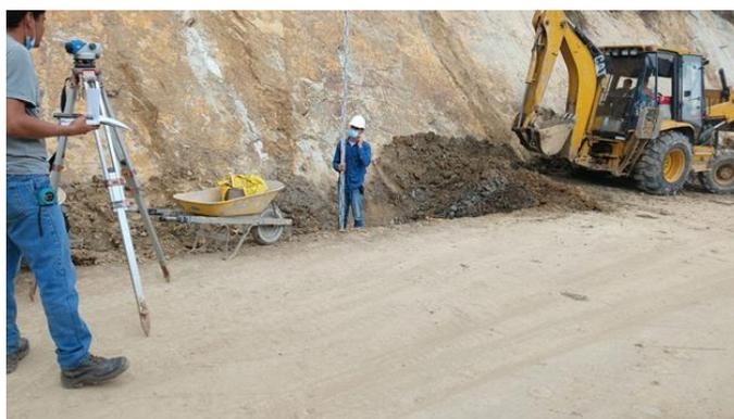
**Figura 29.** Localización y replanteo y control topográfico donde va a quedar ubicado el muro tipo alcancía.
