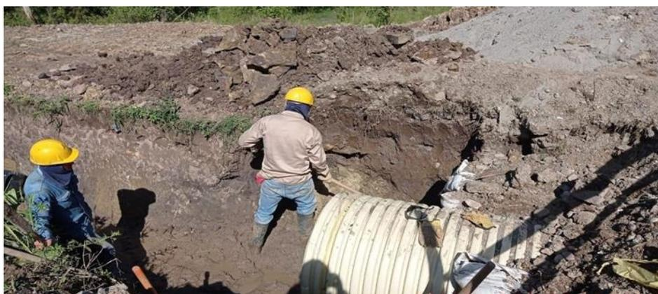
**Figura 60.** Excavación manual para descole en gaviones.
