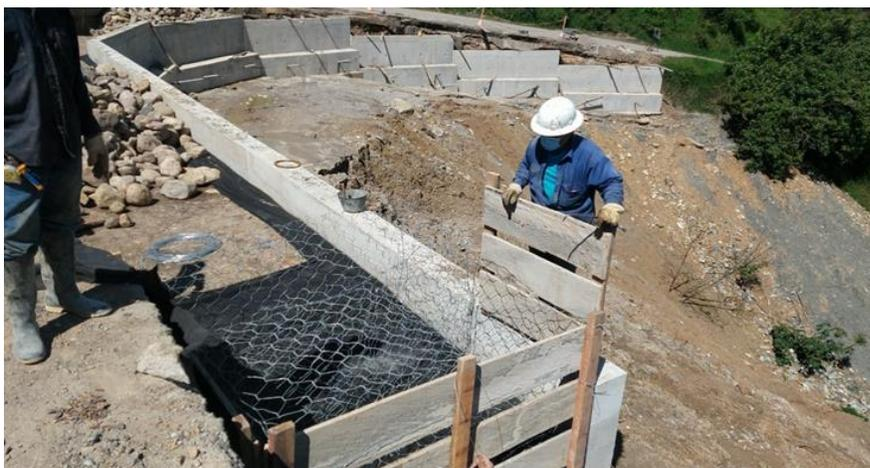
**Figura 27.** Instalación de malla galvanizada para muro en gaviones.
