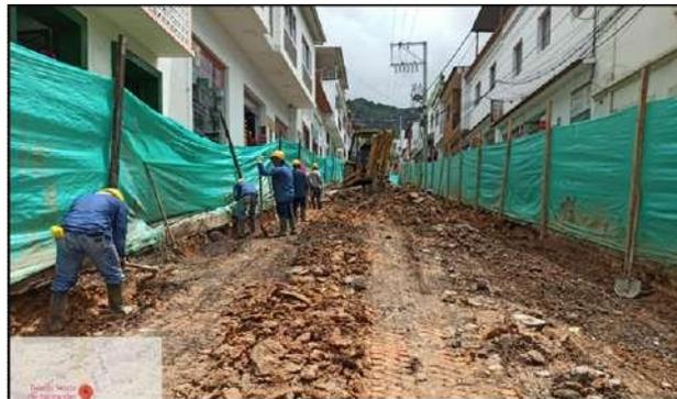
**Figura 9.** Demolición de pavimento existente y retiro de material.
