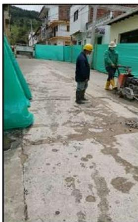
**Figura 3.** Inicio de corte en franja central para tubería de 12\".
