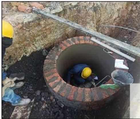
**Figura 8.** Levantamiento de pozo séptico con su respectivo pañete impermeabilizado.
