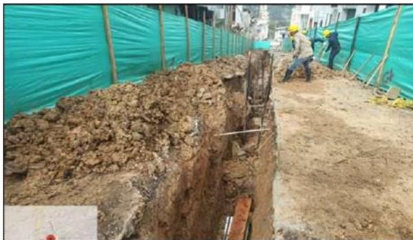
**Figura 6.** Excavación para instalación de tubería de 12".
