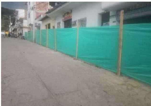
**Figura 1.** Inicio instalación de cerramiento en tela verde, costado derecho subiendo.
