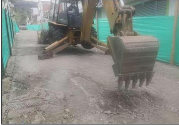
**Figura 4.** Inicio proceso de demolición pavimento en franja central para tubería 12".
