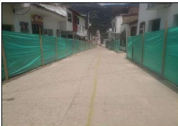
**Figura 2.** Demarcación de líneas de corte en franja central para tubería de 12\".
