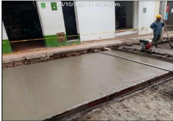
**Figura 10.** Instalación de concreto para pavimento MR.
