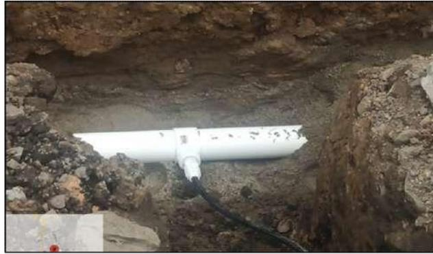
**Figura 7.** Conexión de collarin de 3" con adaptador PF y manguera de 20/40.
