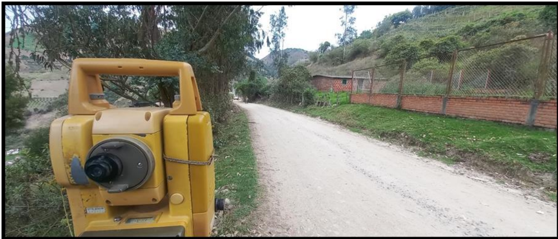
Figura 3. Topografía inicial con estación total TOPCOM.
