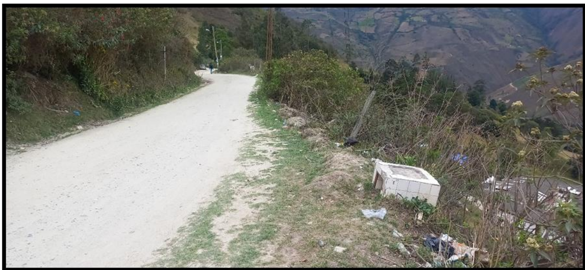
Figura 5. Vista general tramo vial.
