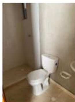
Foto 26 Baño hab. Principal terminado en obra gris
