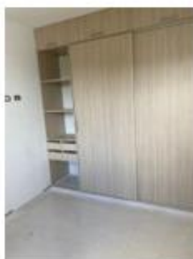
Foto 36. Instalación de closet habitación principal
