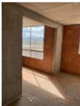
Foto 55. Espacio hab. Auxiliar 2 sin muro divisorio en obra gris
