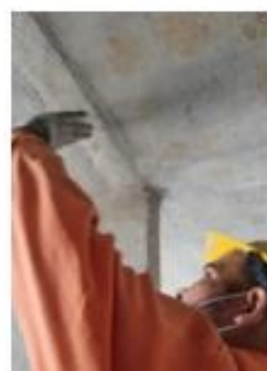
Foto 5. Pulir borde accesos a las habitaciones apto 503
