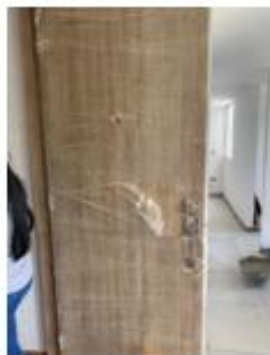
Foto 40. Apto tipo A Torre 1 – 801 con reforma especial, cambio de carpintería
