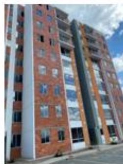
Foto 72. Fachada Torre 1 - lista para ser entregada a sus compradores
