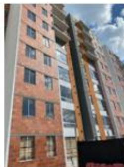
Foto 71. Fachada torre 2 pendiente de detalles
