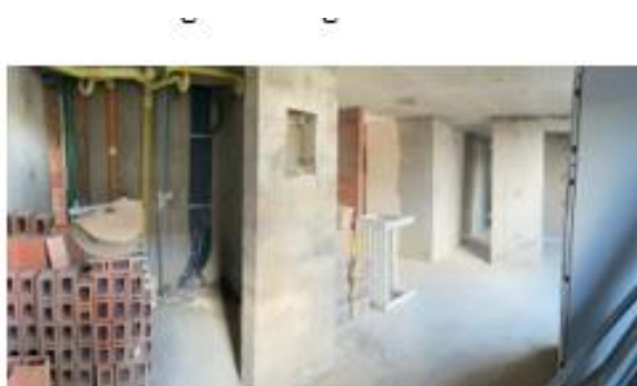
Foto 1. Apto en obra negra zona sala – comedor y cocina apto tipo A
