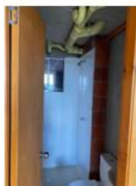
Foto 60. Baño terminado en obra gris apto tipo C 604 Torre 1
