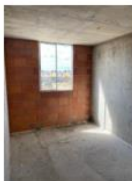
Foto 53. Hab. Auxiliar 2 en obra gris sin pulir
