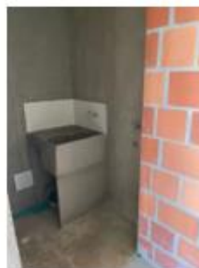
Foto 8. Zona de ropas apto tipo C, obra gris
