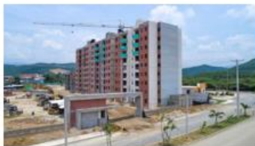
Foto 66. Obra en el mes de marzo
