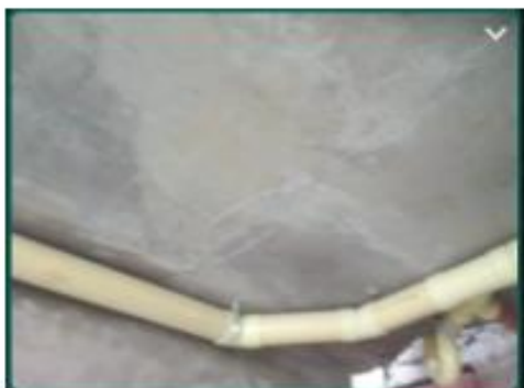
Foto 39. Placa en zona de ropas apto 101
