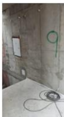
Foto 26. Piso 9 sin terminar
