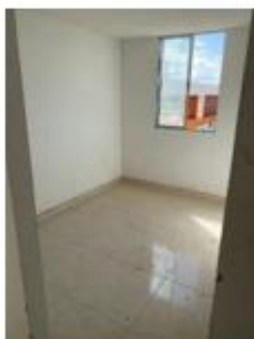
Foto 17. Hab. Auxiliar 1 con pisos y pintura
