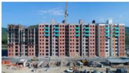
Foto 67. Fachada Torre 3 - 2 -1 mes de abril
