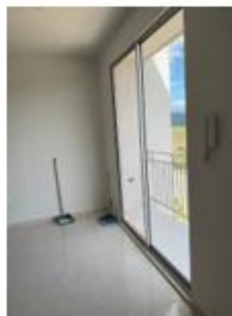
Foto 65. Zona sala comedor y balcón terminada con acabados apto tipo A 901 Torre 1
