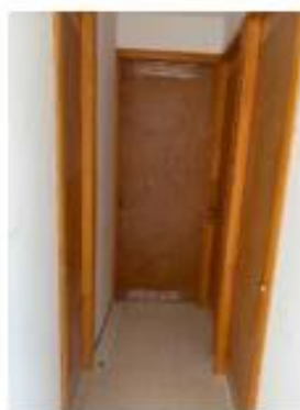
Foto 38. Vista de puertas entregadas por la constructora
