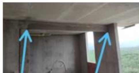
Foto 23. Se tapó dilatación de mampostería apto 802
