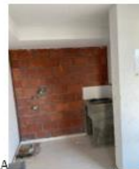
Foto 14. Zona de ropas apto tipo A, con bloque a la vista
