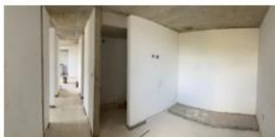
Foto 9. Instalación de "poyo" para adecuar closet de habitación principal apto tipo B con estuco
