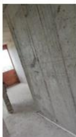
Foto 27. Resane paredes apto 904
