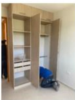
Foto 62. Hab. Auxiliar 1 terminada con acabados apto tipo A 901 Torre 1
