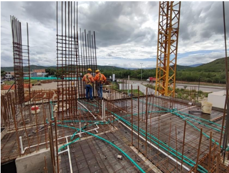
Figura 18. Armado de placas de entrepiso. Fuente, informe Ingescol
