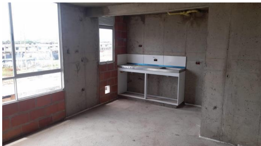
Figura 16. Mueble de cocina instalado debidamente
