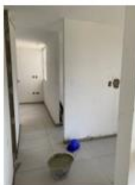
Foto 39. Apto tipo A Torre 1 – 801 con reforma especial solicitada por el cliente
