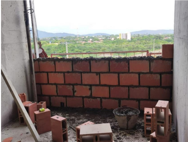
Figura 14. Instalación de mampostería. Fuente, comité de obra
