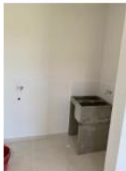
Foto 64. Zona de ropas terminada con acabados apto tipo A 901 Torre 1
