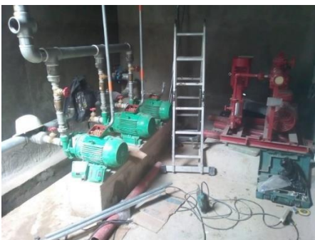
Figura 11. Tanque hidroneumático Eléctricas
