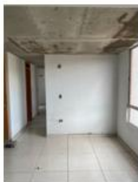
Foto 42. Zona sala comedor sin silcoplast en la placa y con muro divisorio apto tipo A
