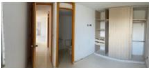
Foto 19. Apto tipo A con instalación de carpintería de madera hab. Principal
