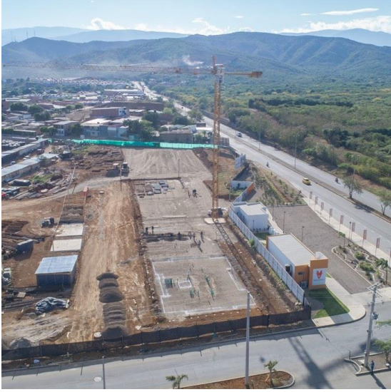
Figura 8. Cimentación de torres 1 – 2 – 3
