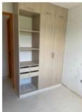
Foto 37. Instalación de closet habitación Auxiliar 1
