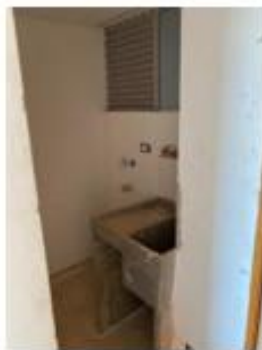
Foto 22. Zona de ropas Apto tipo B, se entrega sin puerta
