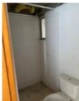
Foto 15. Baño pendiente por instalación de Dry Wall
