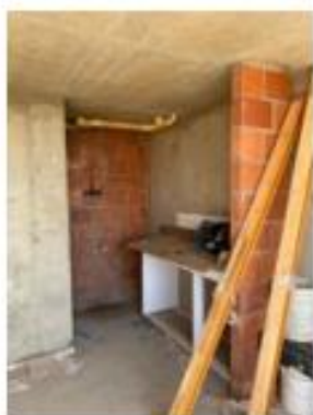
Foto 6. Instalación de base y mesón de cocina apto tipo C
