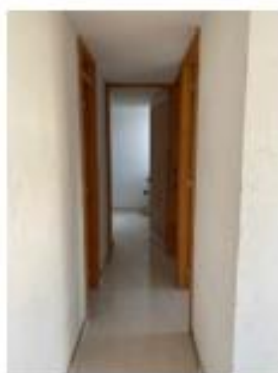
Foto 35. Instalación de puertas en madera de habitaciones
