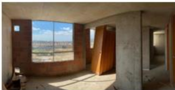
Foto 5. Sala comedor Tipo C, pendiente instalar rejillas de ventilación y pulir
