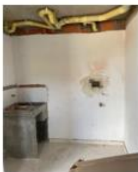
Foto 11. Zona de ropas con tubería a la vista de un apto tipo A
