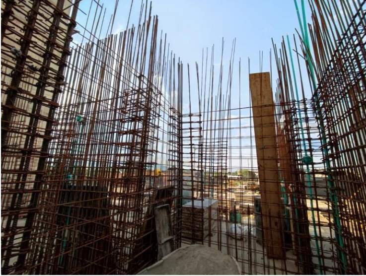
Figura 17. Armado de muros.
