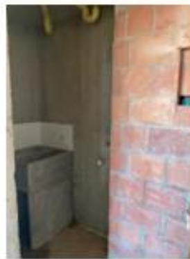
Foto 3. Zona de ropas en obra negra apto Tipo C
