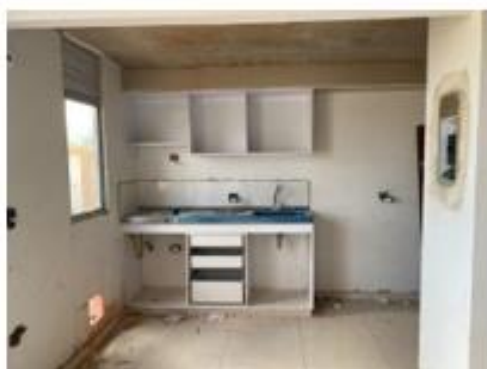
Foto 57. Zona de cocina en instalación de carpintería de madera
