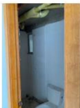
Foto 44. Baño pendiente instalación Dry Wall
