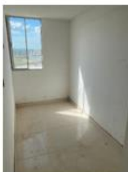
Foto 23. Hab. Auxiliar 2 con semiacabados y muro divisorio
