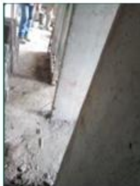
Foto 28. Nivelación piso apto 102
