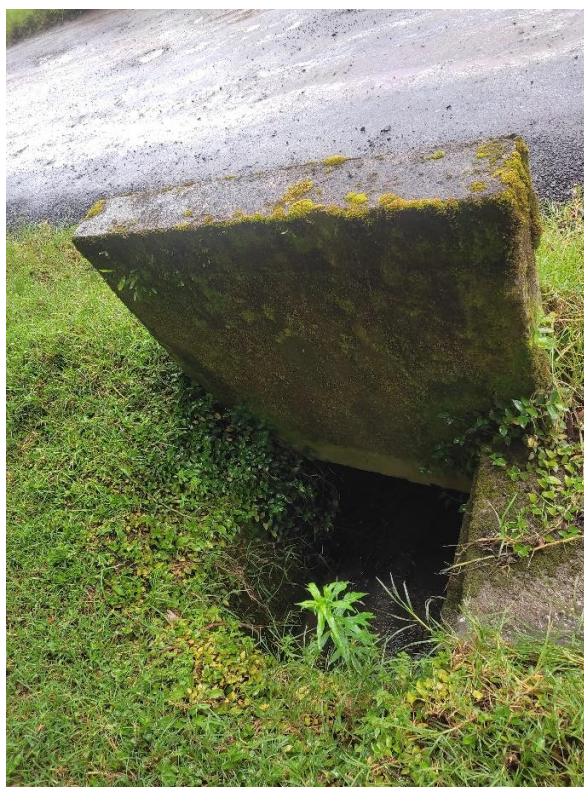
Figura 11. Modelo de alcantarilla tipo sobre el tramo.
