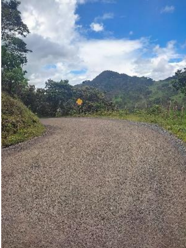
Figura 4. Vista general capa de rodadura en afirmado.
