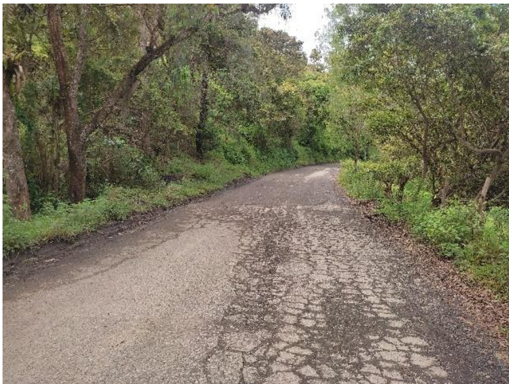
Figura 2. Vista general superficie de rodadura.
