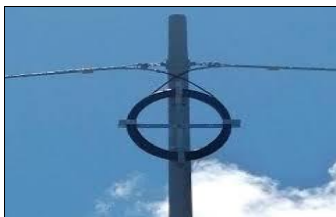
Figura 14. Reserva de fibra óptica.
