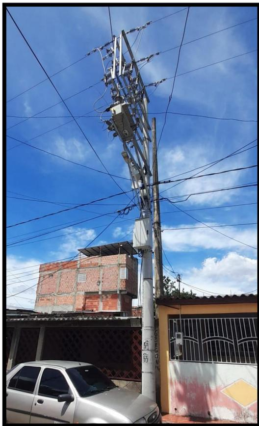
**Figura 21. Poste de 8 Mts, Rotura 750 kg de baja tensión, contiene empalme, y reserva de fibra.**
