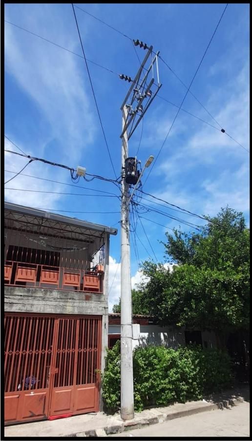
**Figura 19. Poste de 12 Mts, Rotura 1050 kg de media tensión, contiene transformador**
