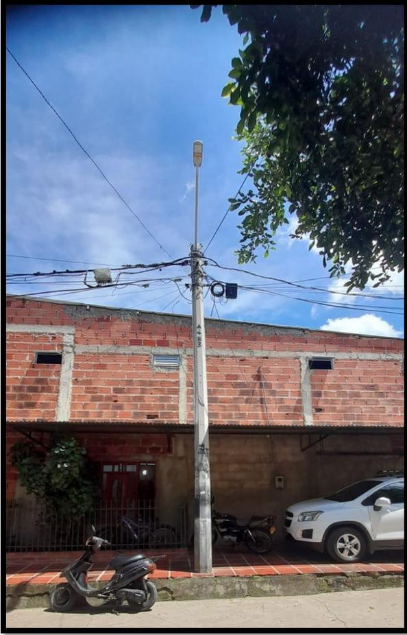
**Figura 18. Poste de 8 Mts, Rotura 1050 kg de baja tensión, contiene una caja Nap, y reserva de fibra**
