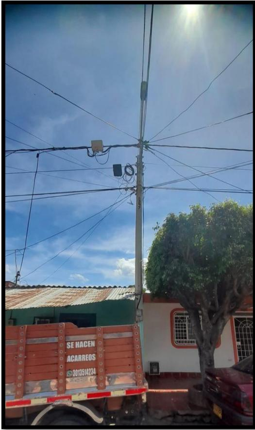
**Figura 20. Poste de 8 Mts, Rotura 750 kg de baja tensión, contiene caja nad, y reserva de fibra**
