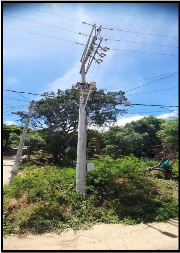
**Figura 17. Poste de 14 Mts Rotura 1050, que lleva media tensión y un transformador para distribuir baja tensión.**
