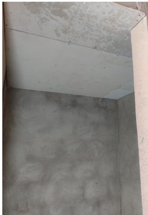
Imagen 66. Pañete Baño Interno con Drywall. Tomada en Obra, Elaboración Propia. CEIMLAB.
