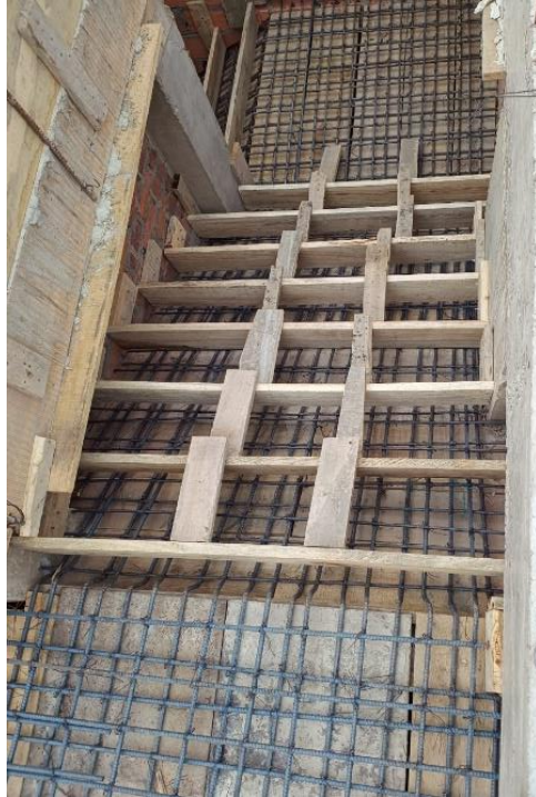
Imagen 84. Armado de Refuerzo y Pasos Escalera del Nivel 5 a la Terraza. Tomada en Obra, Elaboración Propia. CEIMLAB.
