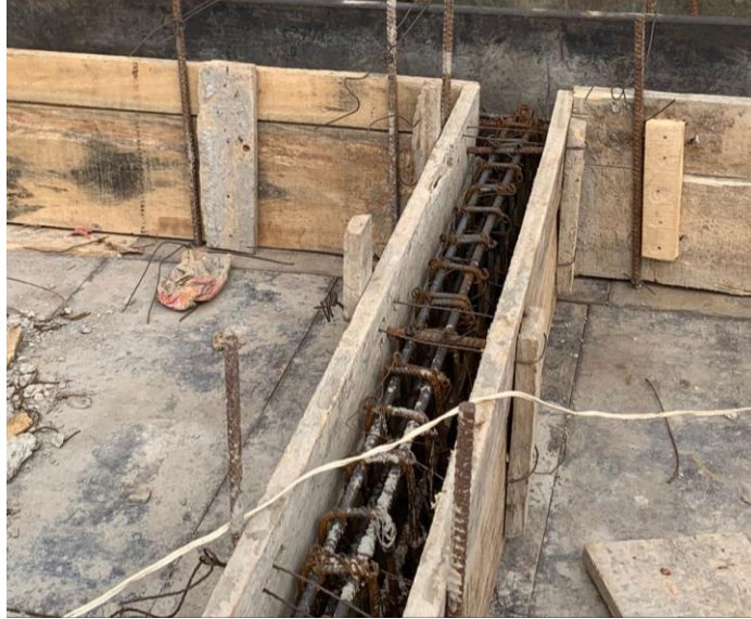
Imagen 27. Encofrado de Vigas. Tomada en Obra, Elaboración Propia. CEIMLAB.
