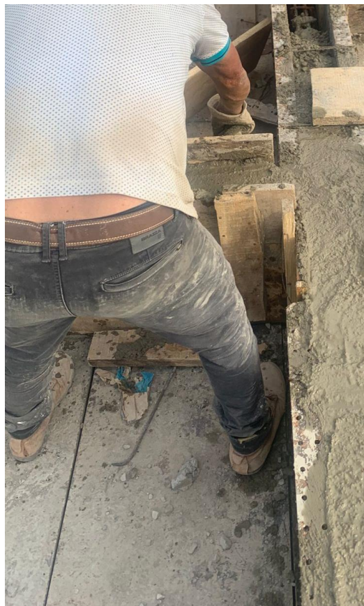
Imagen 28. Fundida de Vigas 202 y 204. Tomada en Obra, Elaboración Propia. CEIMLAB.
