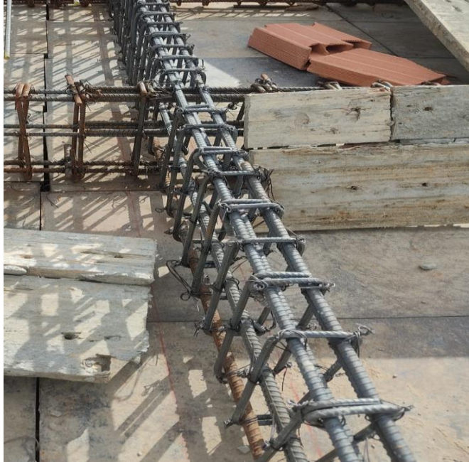
Imagen 25. Finalización de Armado. Tomada en Obra, Elaboración Propia. CEIMLAB.
