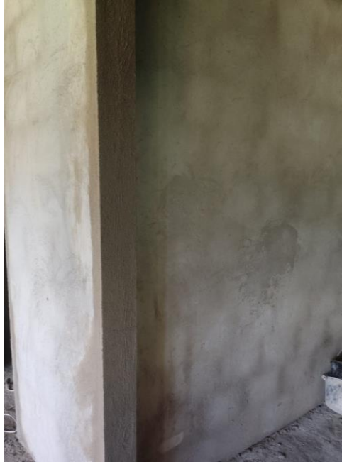
Imagen 63. Pañete Baños. Tomada en Obra, Elaboración Propia. CEIMLAB.
