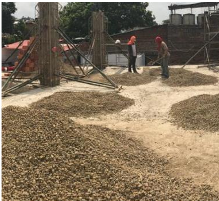
Imagen 12. Encofrado Finalizado. Tomada en Obra, Elaboración Propia. CEIMLAB.
