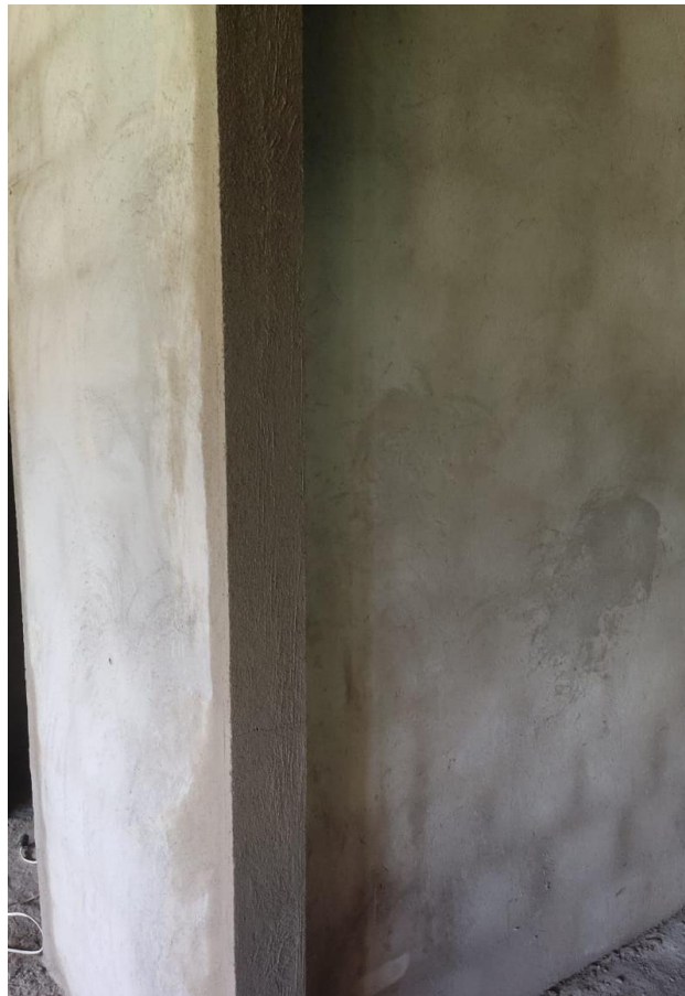
Imagen 62. Pañete en Muros de Galleta. Tomada en Obra, Elaboración Propia. CEIMLAB.
