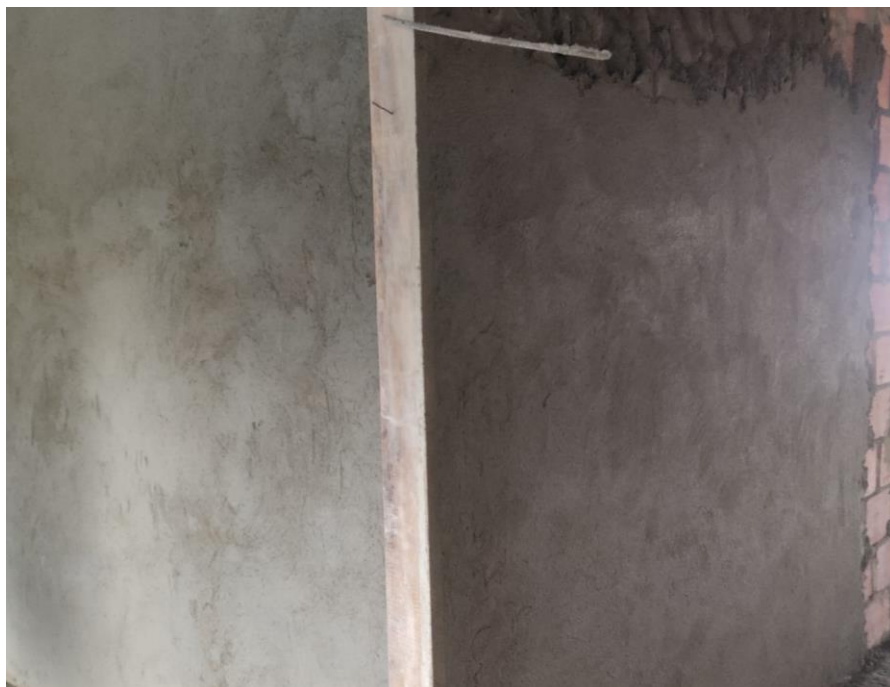
Imagen 61. Revoque Muros en Galleta. Tomada en Obra, Elaboración Propia. CEIMLAB.
