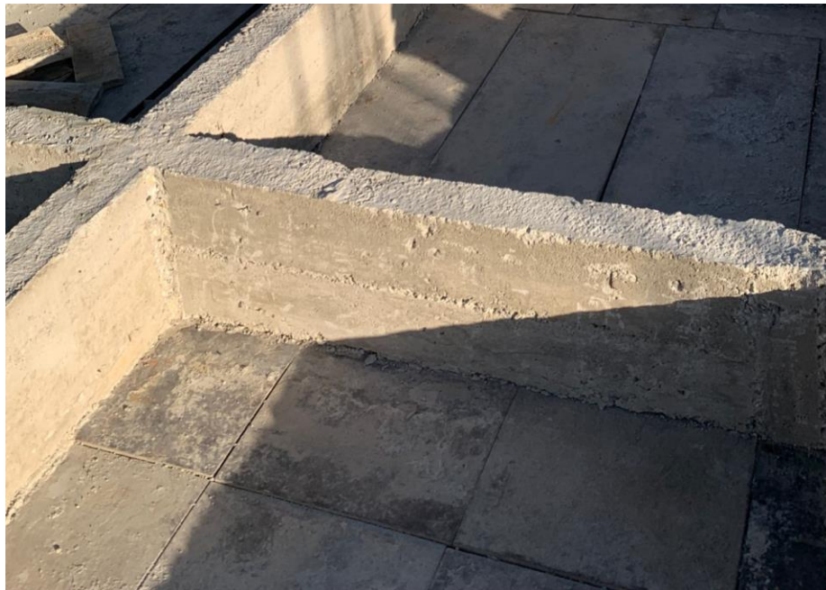
Imagen 31. Desencofrado de Vigas Secundarias, 202 y 205. Tomada en Obra, Elaboración Propia. CEIMLAB.
