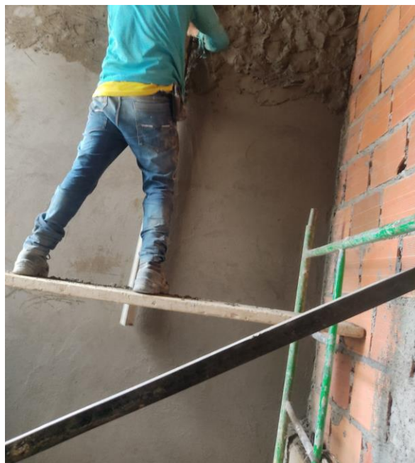
Imagen 48. Levantamiento Muros Divisionales y Pañete. Tomada en Obra, Elaboración Propia. CEIMLAB.
