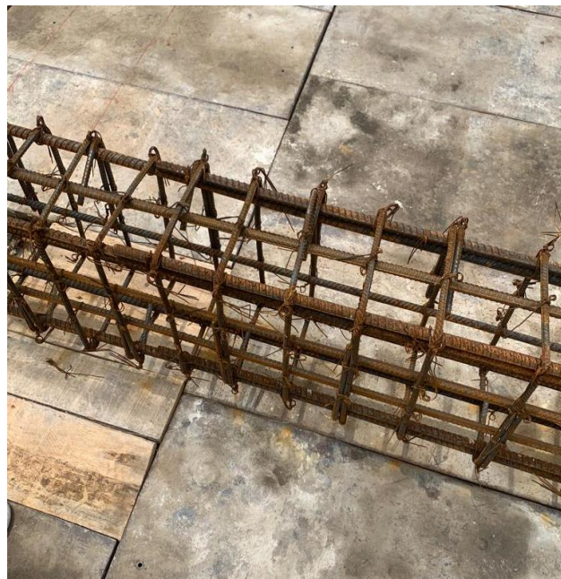
Imagen 24. Armado de las Vigas Principales. Tomada en Obra, Elaboración Propia. CEIMLAB.
