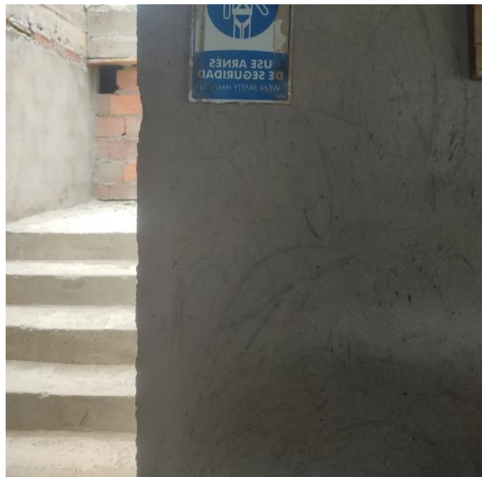
Imagen 85. Escalera del Nivel 5 a la Terraza Fundida. Tomada en Obra, Elaboración Propia. CEIMLAB.
