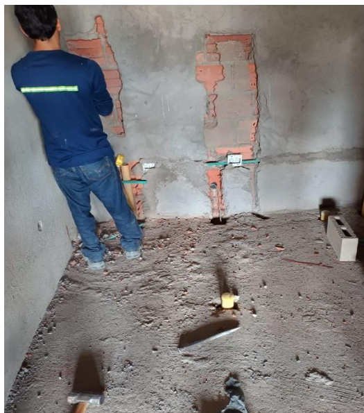
Imagen 69. Regatas para Instalaciones. Tomada en Obra, Elaboración Propia. CEIMLAB.
