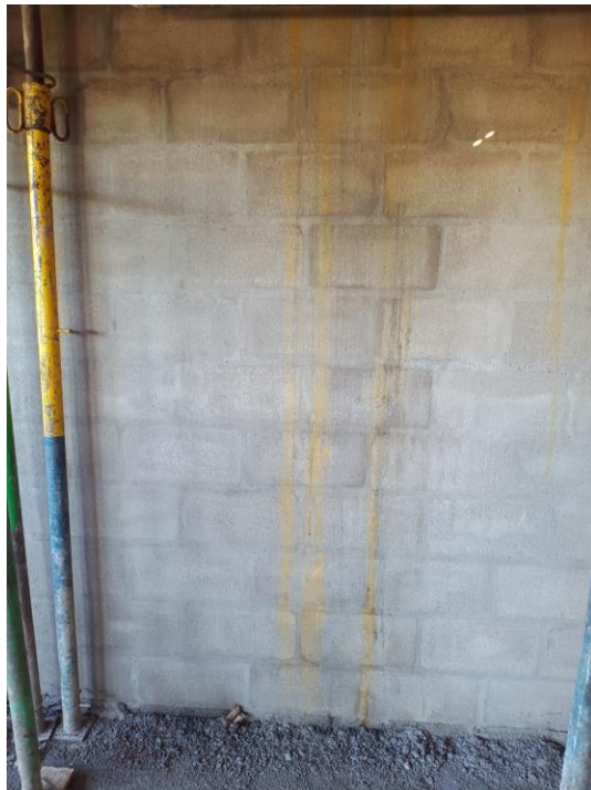
Imagen 59. Muros Laterales en Bloque Concreto. Tomada en Obra, Elaboración Propia. CEIMLAB.
