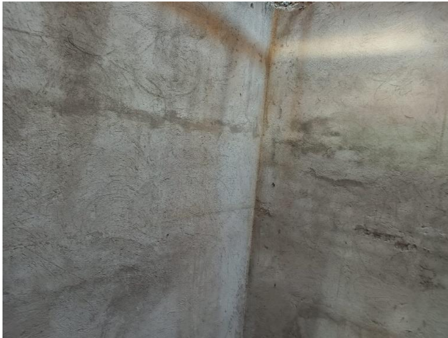
Imagen 68. Pañete Interno Foso Ascensor. Tomada en Obra, Elaboración Propia. CEIMLAB.
