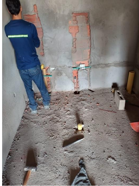
Imagen 71. Regatas para las Instalaciones. Tomada en Obra, Elaboración Propia. CEIMLAB.
