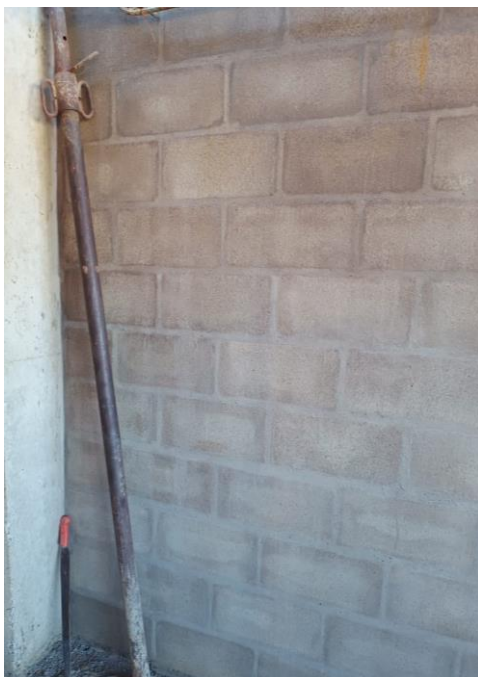
Imagen 58. Muro Lateral en Bloque #10. Tomada en Obra, Elaboración Propia. CEIMLAB.
