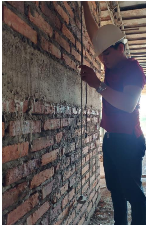
Imagen 55. Muro Exterior Foso Ascensor. Tomada en Obra, Elaboración Propia. CEIMLAB.
