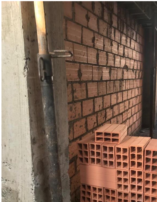
Imagen 47. Levantamiento Muros Divisionales. Tomada en Obra, Elaboración Propia. CEIMLAB.
