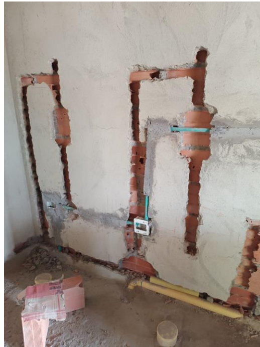
Imagen 73. Regatas Instalación Eléctrica. Tomada en Obra, Elaboración Propia. CEIMLAB.
