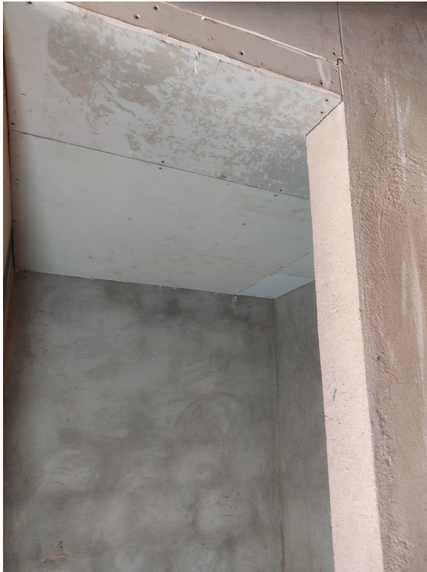
Imagen 77. Drywall en los Baños. Tomada en Obra, Elaboración Propia. CEIMLAB.
