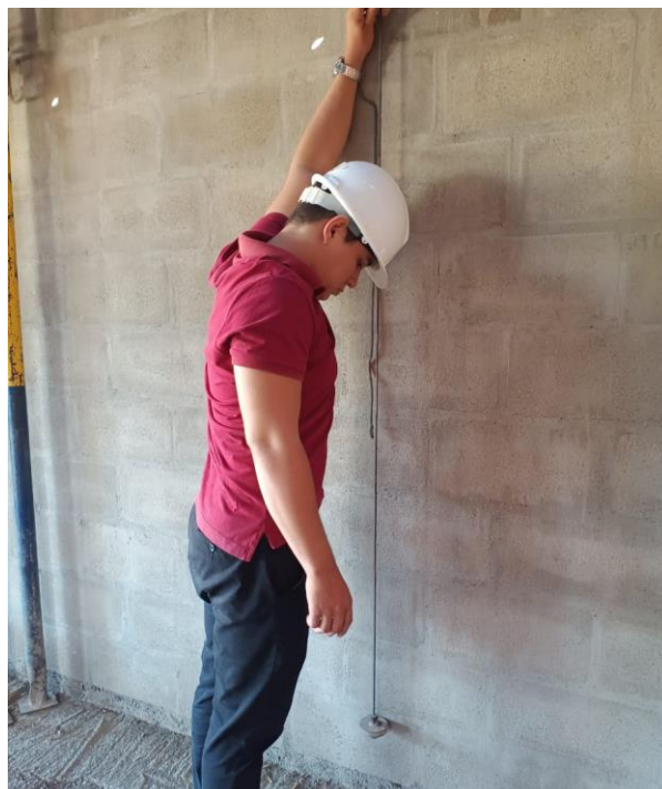
Imagen 60. Muros Laterales Aplomados. Tomada en Obra, Elaboración Propia. CEIMLAB.
