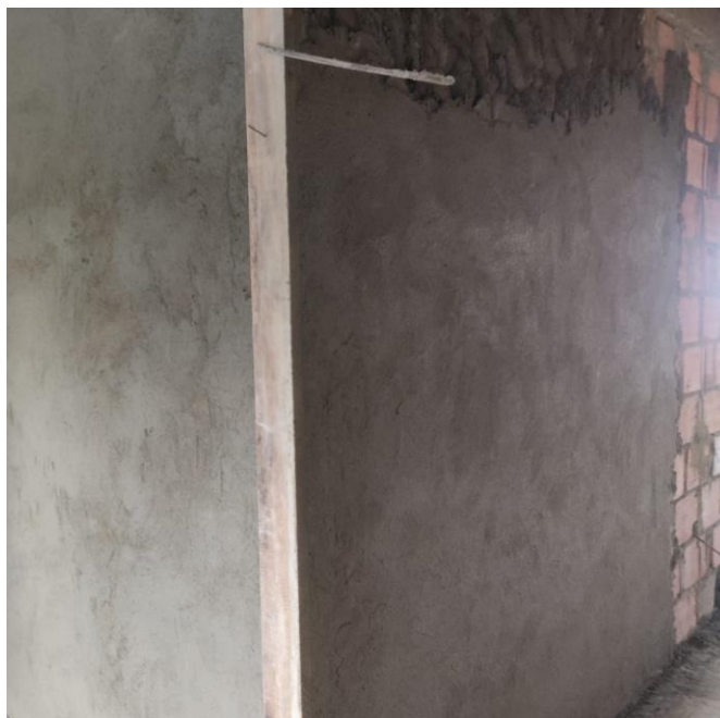
Imagen 46. Muros en Bloque #5. Tomada en Obra, Elaboración Propia. CEIMLAB.
