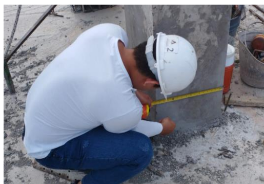
Imagen 13. Seguimiento De cada una de las Columnas. Tomada en Obra, Elaboración Propia. CEIMLAB.
