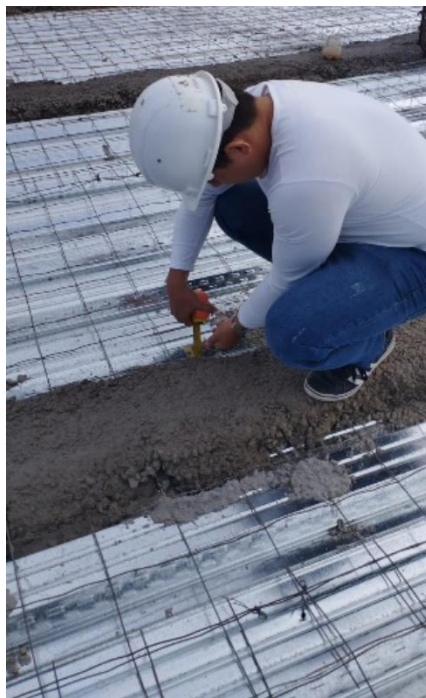
Imagen 40. Verificación de Espesor de las Alistadas. Tomada en Obra, Elaboración Propia. CEIMLAB.
