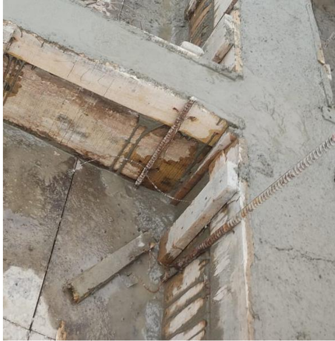
Imagen 29. Fundida de Vigas 201 y 205. Tomada en Obra, Elaboración Propia. CEIMLAB.
