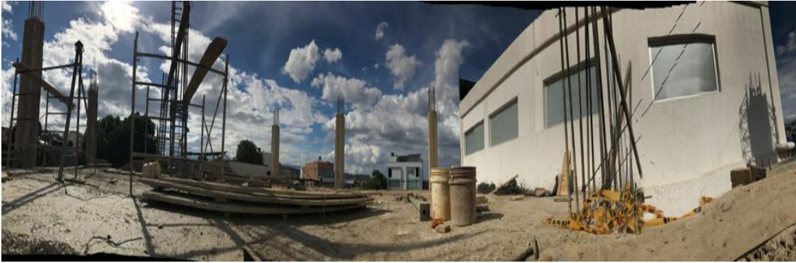
Imagen 15. Fundida de Columnas casi Terminado y Desencofrado.
