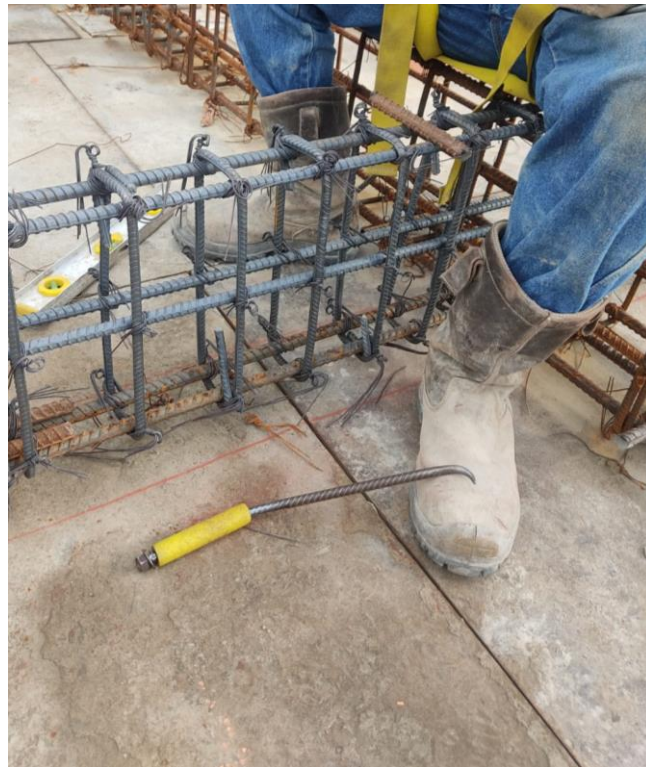
Imagen 26. Amarrado de Pines o Separadores. Tomada en Obra, Elaboración Propia. CEIMLAB.
