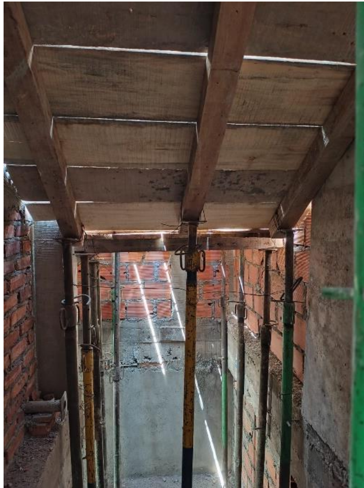
Imagen 83. Cama Escalera del Nivel 5 a la Terraza. Tomada en Obra, Elaboración Propia. CEIMLAB.
