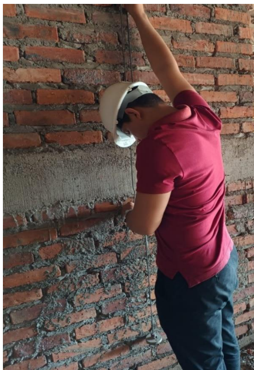
Imagen 54. Muro Ascensor otra Cara. Tomada en Obra, Elaboración Propia. CEIMLAB.
