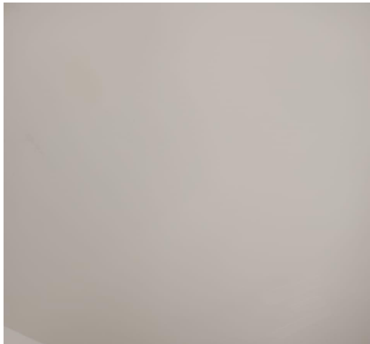
Imagen 82. Estuco en Drywall del Baño. Tomada en Obra, Elaboración Propia. CEIMLAB.
