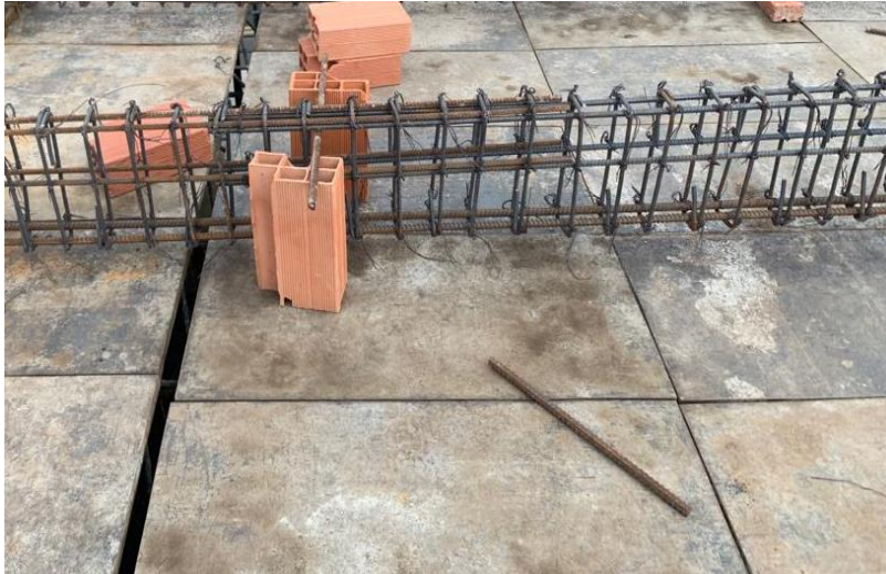
Imagen 23. Armado de Vigas Secundarias. Tomada en Obra, Elaboración Propia. CEIMLAB.
