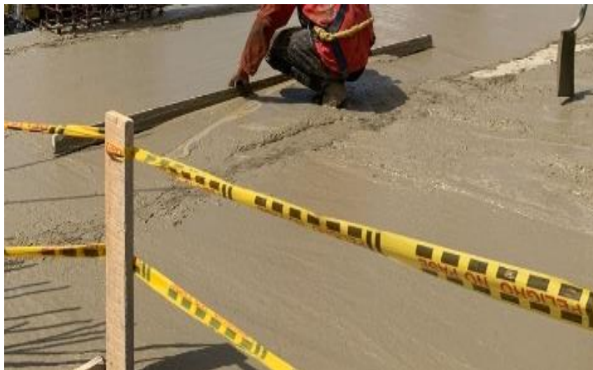
Imagen 42. Fundida Placa Entrepiso. Tomada en Obra, Elaboración Propia. CEIMLAB.
