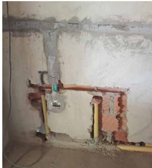
Imagen 72. Regatas Instalación Sanitaria. Tomada en Obra, Elaboración Propia. CEIMLAB.
