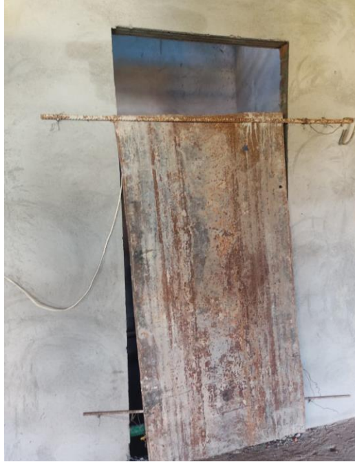
Imagen 67. Pañete Frente Foso Ascensor. Tomada en Obra, Elaboración Propia. CEIMLAB.
