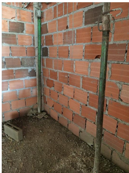
Imagen 52. Muro para Baños. Tomada en Obra, Elaboración Propia. CEIMLAB.
