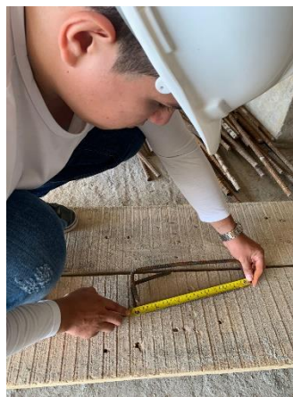
Imagen 1. Seguimiento Estribo de Viga 202 y 205. Tomada en Obra, Elaboración Propia. CEIMLAB.
