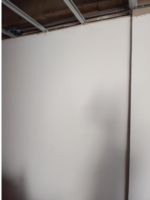
Imagen 79. Bases o Perfiles para Drywall. Tomada en Obra, Elaboración Propia. CEIMLAB.
