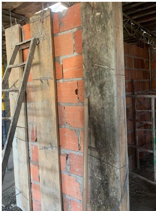
Imagen 51. Muro Baños. Tomada en Obra, Elaboración Propia. CEIMLAB.
