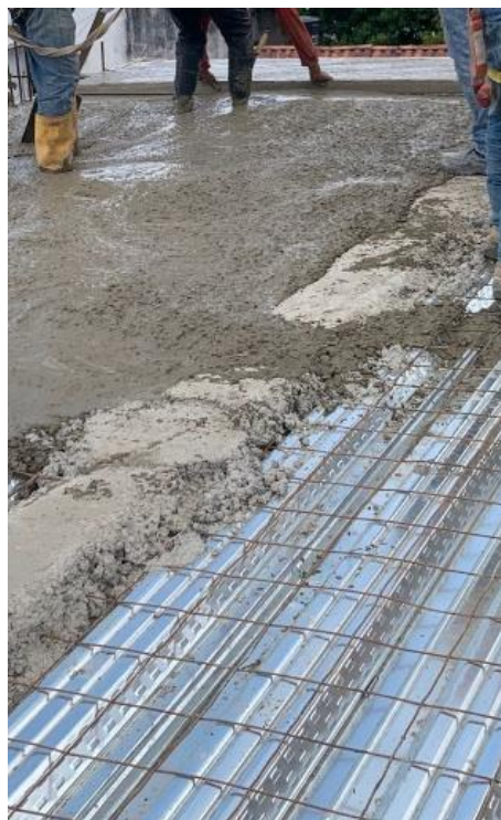
Imagen 41. Fundida de Placa Entrepiso. Tomada en Obra, Elaboración Propia. CEIMLAB.
