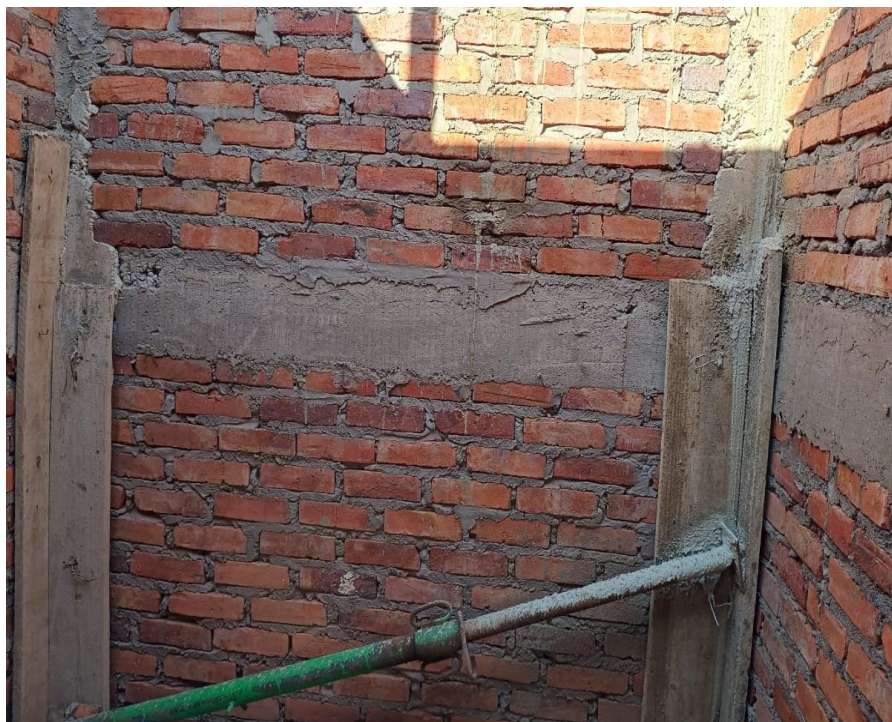
Imagen 56. Interior Foso Ascensor. Tomada en Obra, Elaboración Propia. CEIMLAB.
