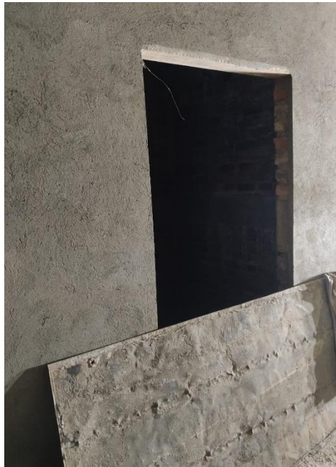
Imagen 64. Pañete Exterior Ascensor. Tomada en Obra, Elaboración Propia. CEIMLAB.
