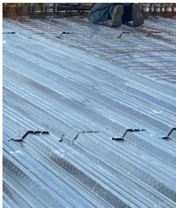
Imagen 39. Instalación de la Malla electrosoldada. Tomada en Obra, Elaboración Propia. CEIMLAB.
