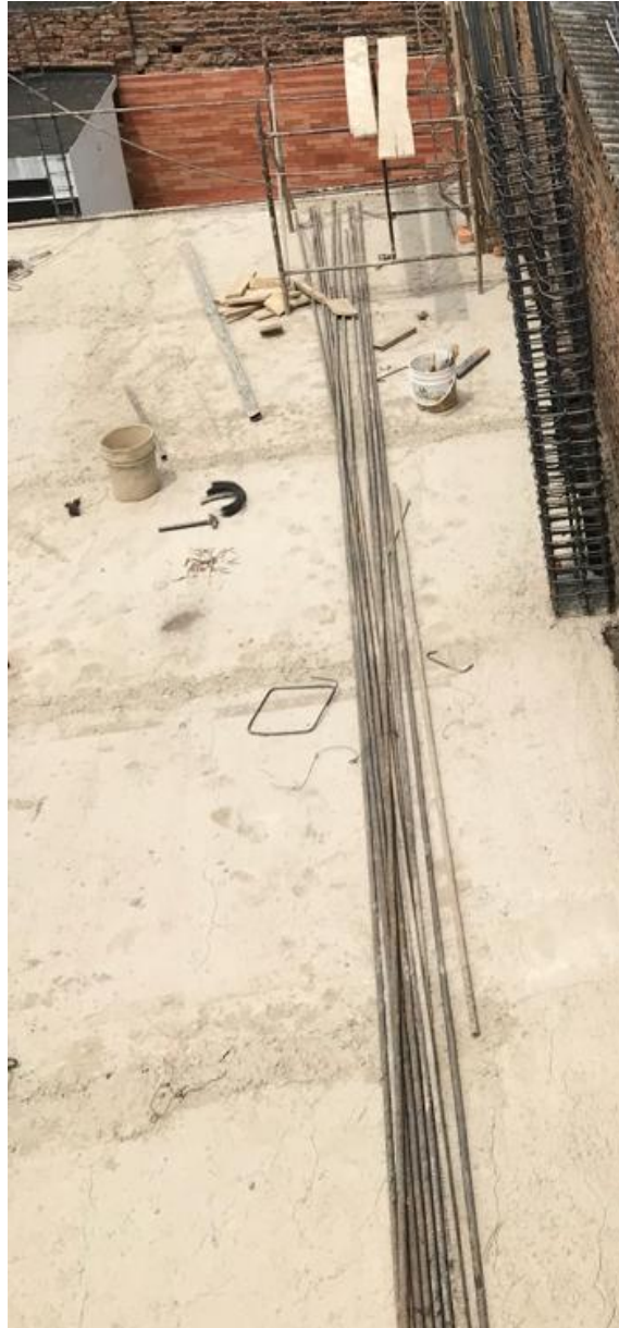
Imagen 9. Armado de Columnas C1 y C2. Tomada en Obra, Elaboración Propia. CEIMLAB.
