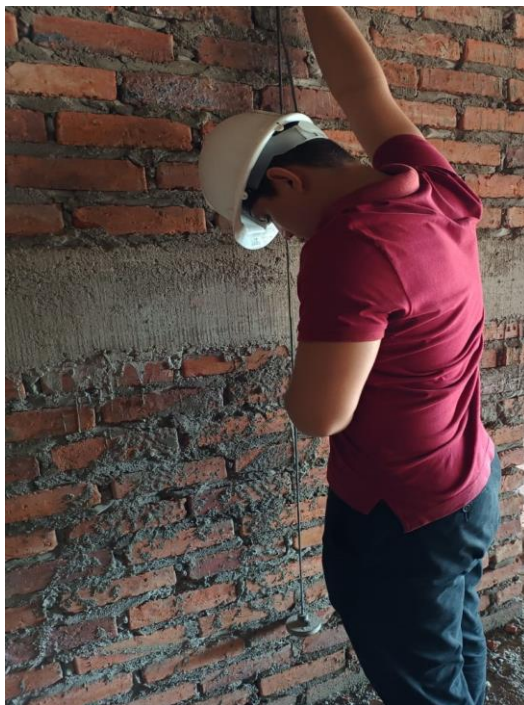
Imagen 53. Verificación Aplome Muro Foso Ascensor. Tomada en Obra, Elaboración Propia. CEIMLAB.
