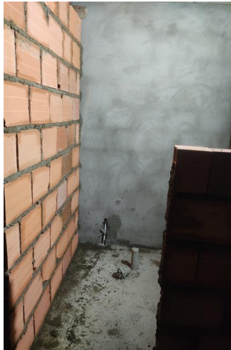
Imagen 50. Muro para Baño de Consultorio. Tomada en Obra, Elaboración Propia. CEIMLAB.
