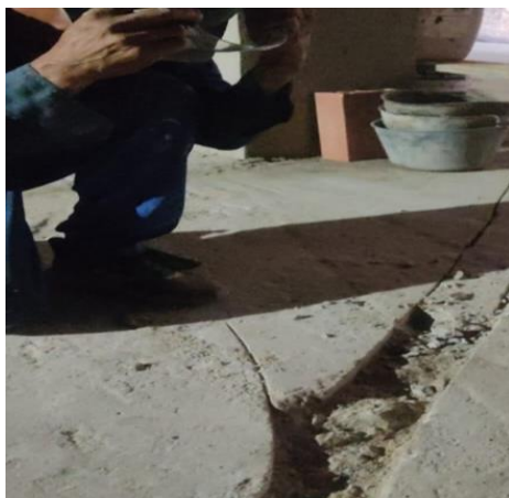
Imagen 70 Regatas en Placa para Instalación Eléctrica. Tomada en Obra, Elaboración Propia. CEIMLAB.
