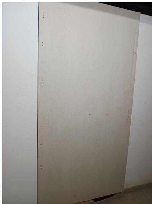
Imagen 80. Estuco Frente Ascensor. Tomada en Obra, Elaboración Propia. CEIMLAB.
