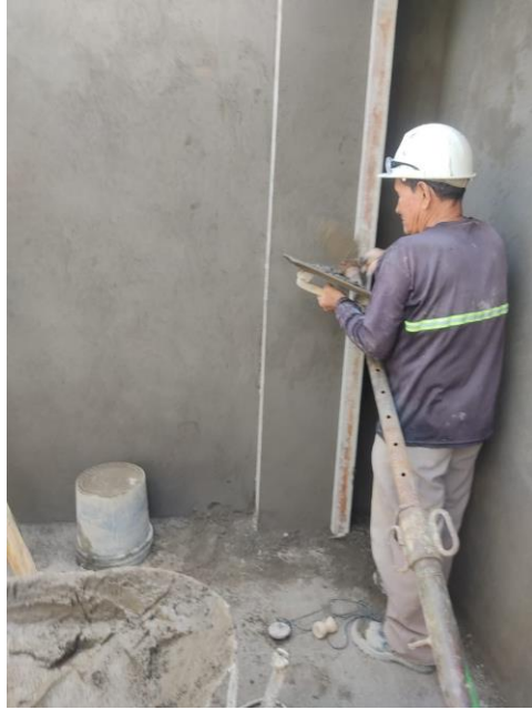
Imagen 65. Pañete Baños. Tomada en Obra, Elaboración Propia. CEIMLAB.
