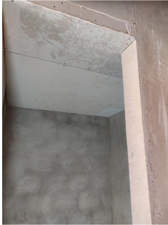
Imagen 81. Drywall en los Baños. Tomada en Obra, Elaboración Propia. CEIMLAB.
