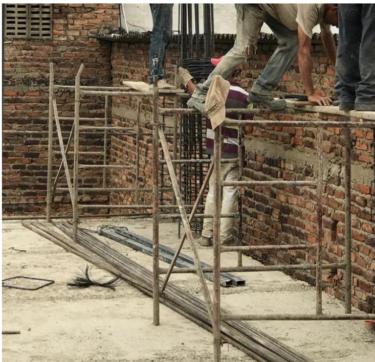
Imagen 10. Andamio para Colocar y Amarrar los Flejes. Tomada en Obra, Elaboración Propia. CEIMLAB.
