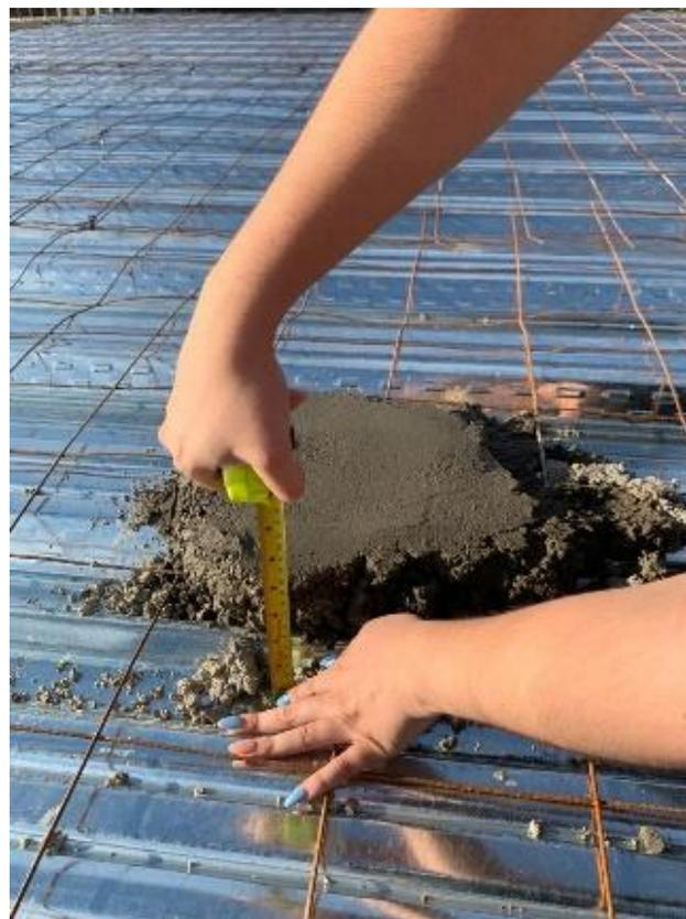
Ilustración 123. verificación de puntos de 0.12 m nivel para placa nivel 5
