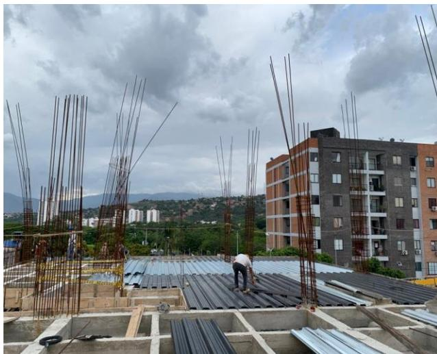
*Ilustración 50. Instalación de metaldeck 2" Edificio Wiedii*
