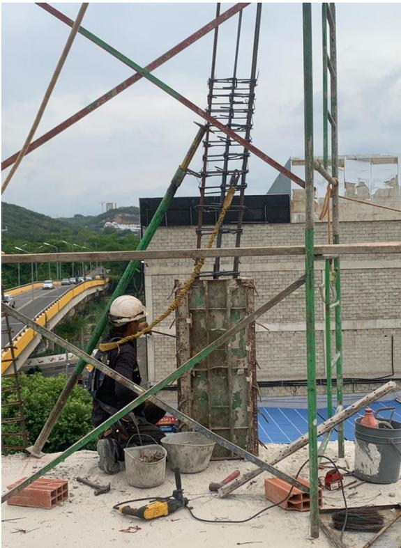
*Ilustración 134. Encofrado de columna 2B.*
