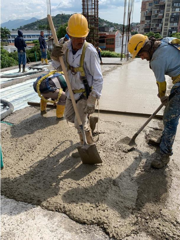
*Ilustración 62. Fundida de placa metaldeck eje E-G Edificio Wiedii*
