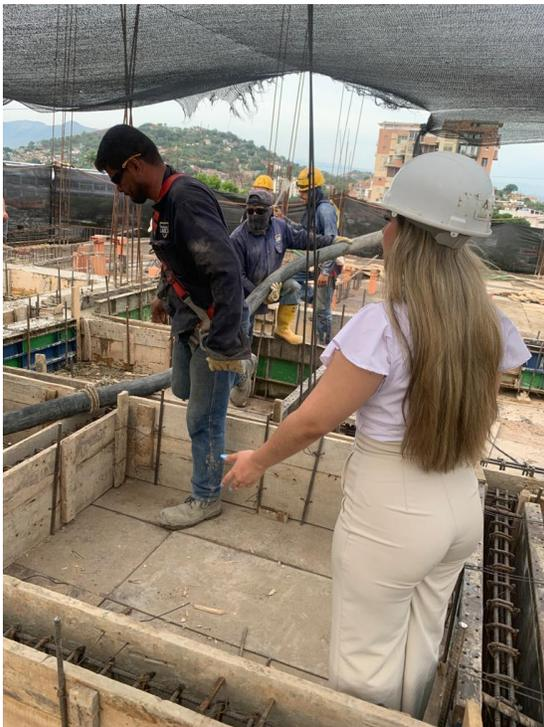
*Ilustración 112. Fundida de vigas nivel 5*
