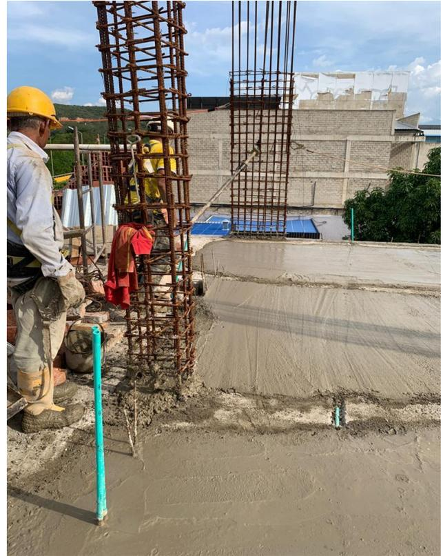
*Ilustración 63. finalización de fundida de placa metaldeck nivel 4 Edificio Wiedii*
