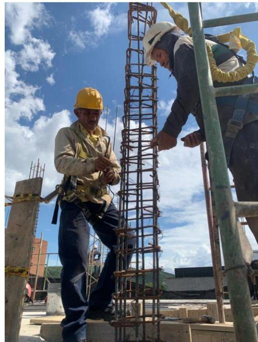
*Ilustración 130. Armado de columna ascensor nivel 5.*
