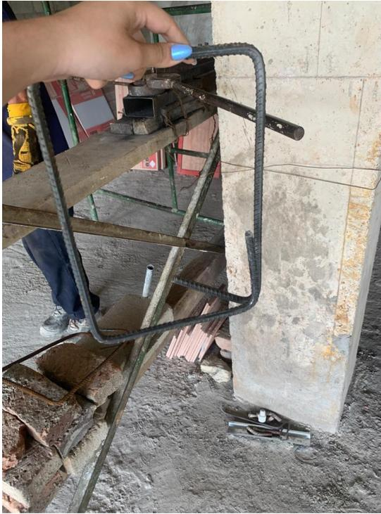
*Ilustración 96. Figurado de hierro para viga principal nivel 5*
