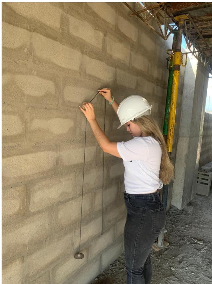
*Ilustración 71. Aplomada de muro eje 1 nivel 4 Edificio Wiedii*
