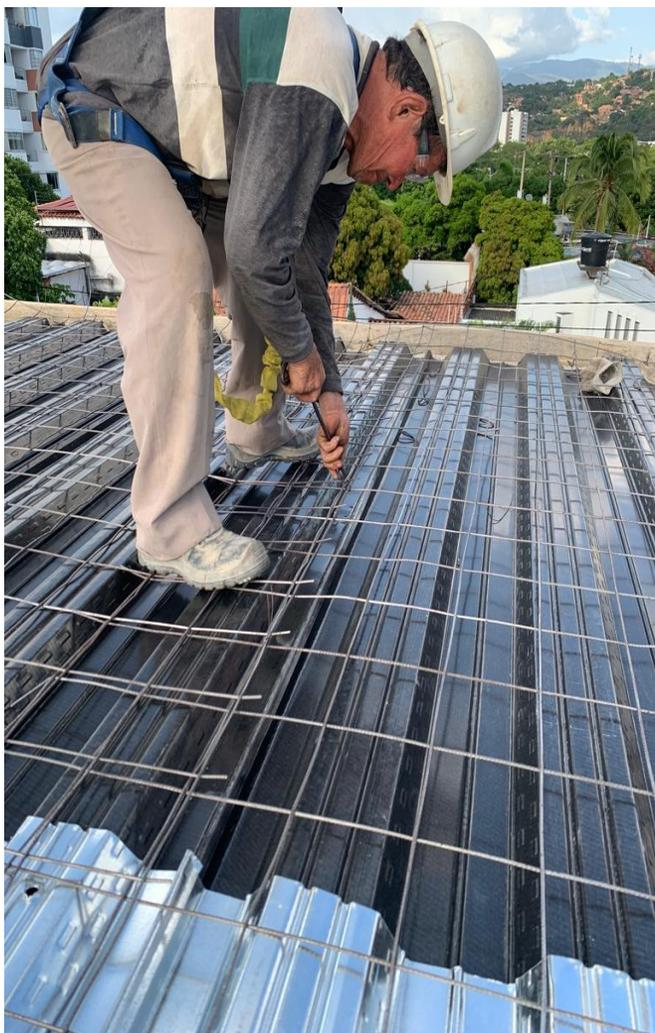
*Ilustración 54. Instalación de malla amarre con pines
