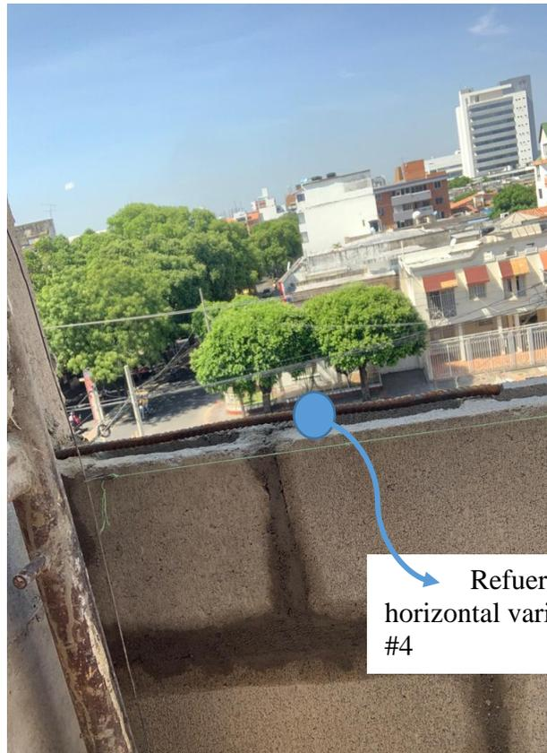
*Ilustración 70. Refuerzo lateral de muro en concreto Edificio Wiedii*
