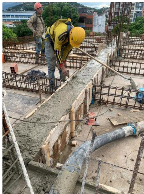
Ilustración 40. Fundida de viga principal Edificio Wiedii
