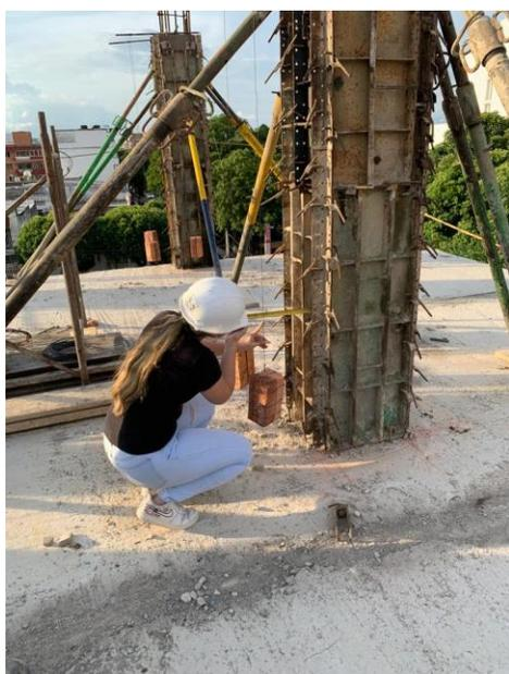
Ilustración 90. revisión de aplomada de columnas nivel 4
