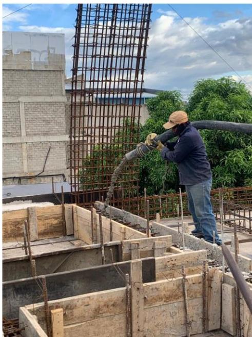
Ilustración 41. Fundida de viga principal 403 Edificio Wiedii
