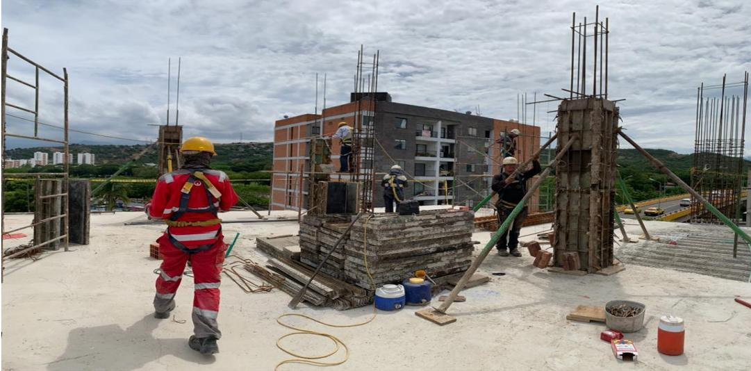
*Ilustración 132. Encofrado de las columnas primer tramo.*
