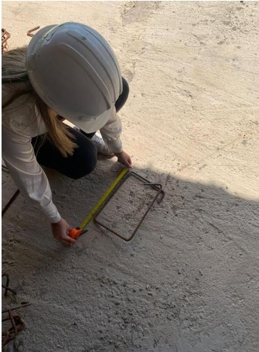
*Ilustración 5. Supervisión estribos de vigas principales*
