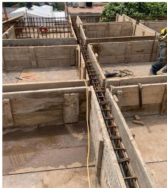
*Ilustración 36. Encofrado de vigas secundarias Edificio Wiedii*
