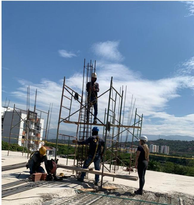
*Ilustración 131. Armado de columna 2C nivel 5.*
