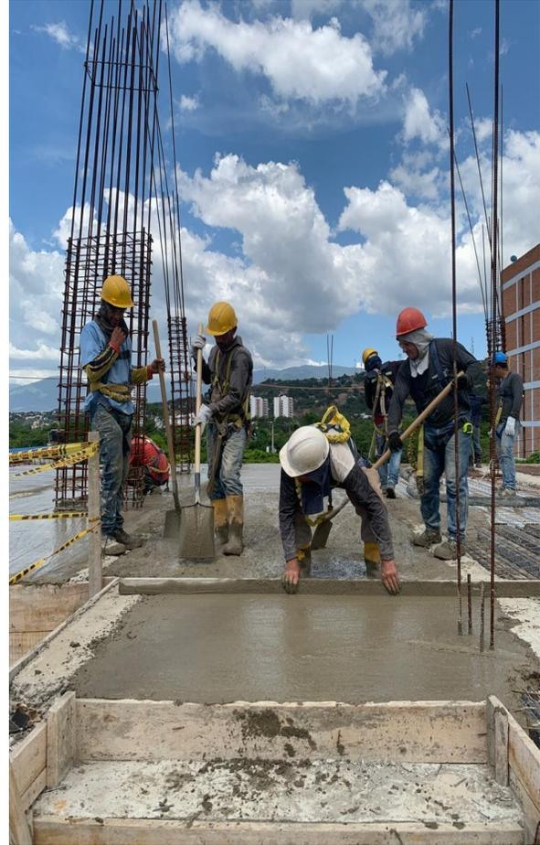
*Ilustración 55. Nivelacion con nivel de placa nivel 4 Edificio Wiedii*
