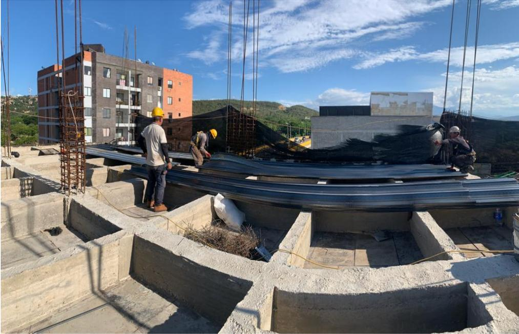
*Ilustración 118. Instalación de metaldeck nivel 5 Edificio Wiedii*
