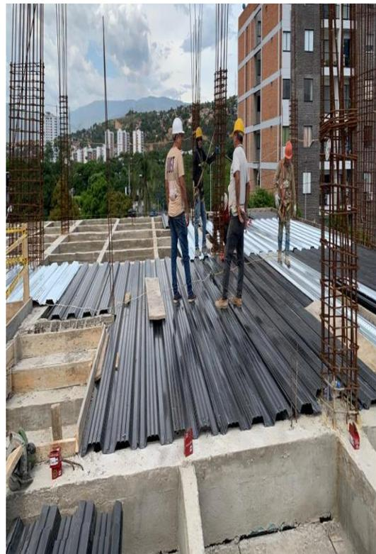
*Ilustración 51. Instalación de metaldeck 2" Edificio Wiedii*
