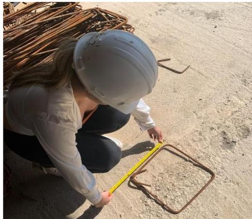
Ilustración 9. Supervisión de armado de estribos columnas T-1.
