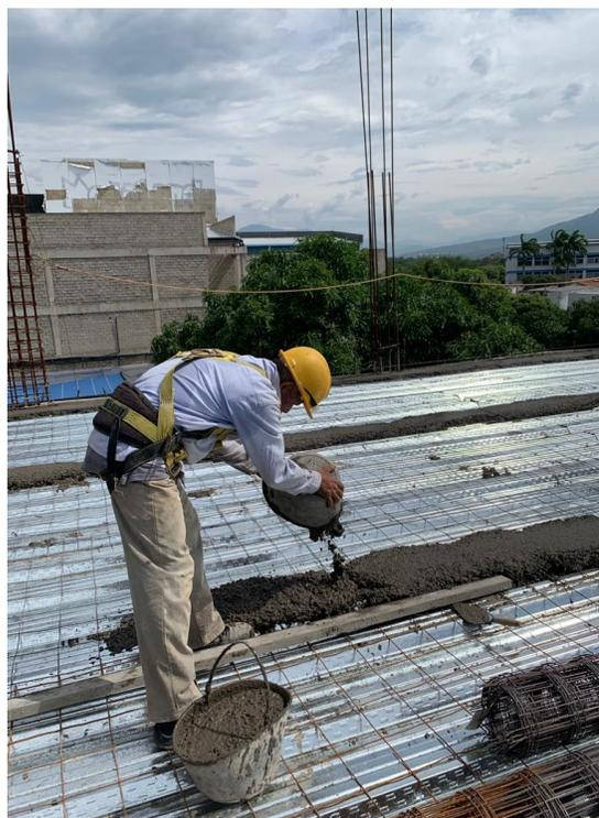
*Ilustración 61. Alineamiento número 3 de los ejes E-G para fundida de placa metaldeck Edificio Wiedii*
