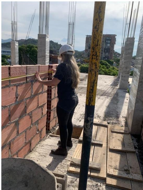
Ilustración 74. Muro bloque galleta escalera de 2.10m Edificio Wiedii
