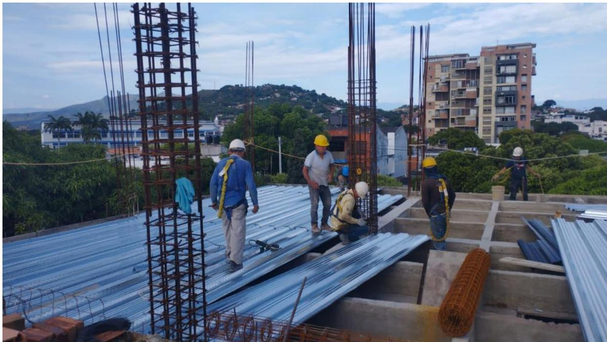
*Ilustración 58. Instalación de metaldeck galvanizado ejes E-G Edificio Wiedii*
