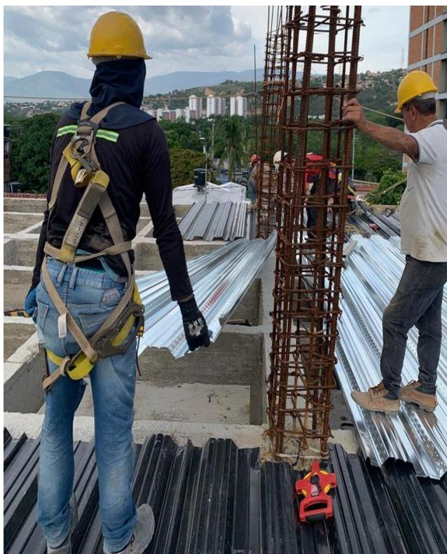
*Ilustración 52. Instalación metaldeck 2" Edificio Wiedii*
