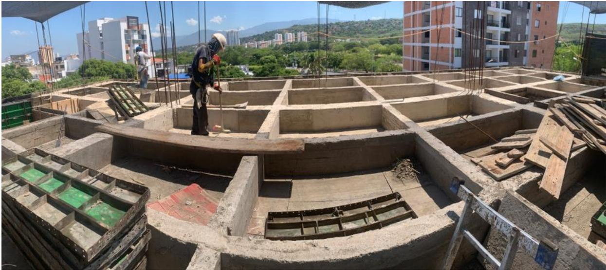
*Ilustración 114. Primera parte de desencofrado de vigas nivel 5.*
