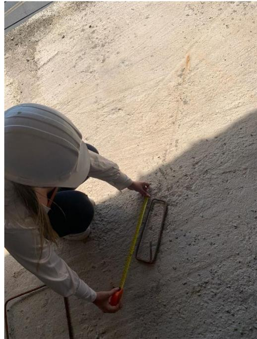
*Ilustración 4. Supervisión estribos de vigas secundarias.*
