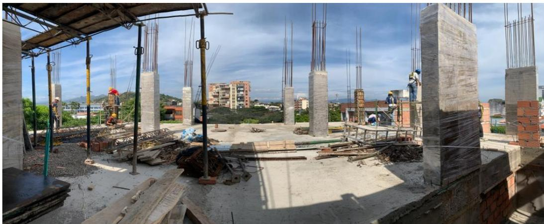
*Ilustración 92. Desencofrado y curado de columnas nivel 4.*
