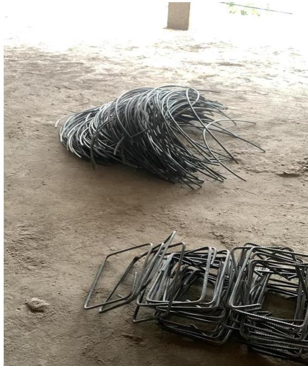
*Ilustración 98. corte y figurado de flejes para nivel*
