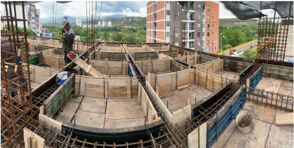
*Ilustración 109. Encofrado de vigas nivel 5 ejes 1-4 (A-C)*
