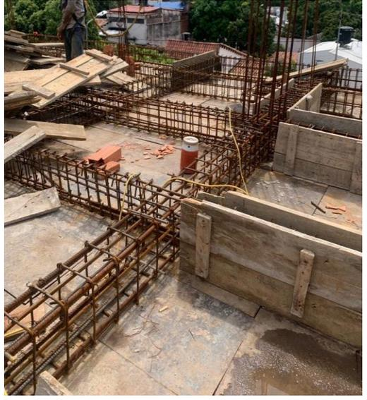
*Ilustración 34. Encofrado de vigas secundarias Edificio Wiedii*
