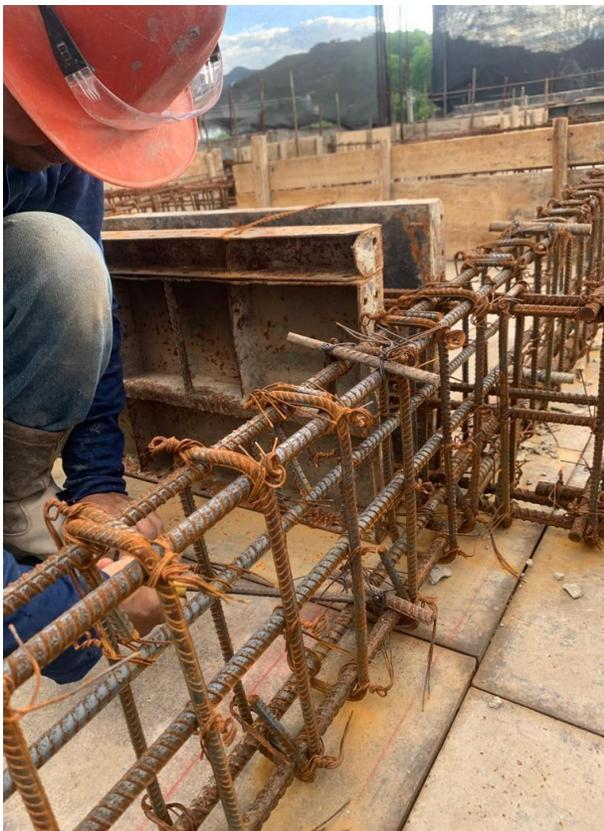
*Ilustración 22. Amarre de pines de viga secundaria 0.4x0.15 Edificio Wiedii.*
