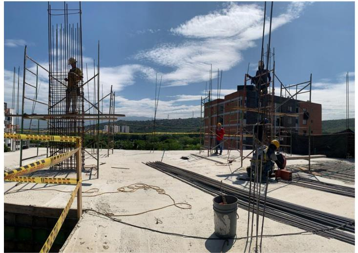
*Ilustración 128. Panorámica de armado de columnas primer tramo N5*
