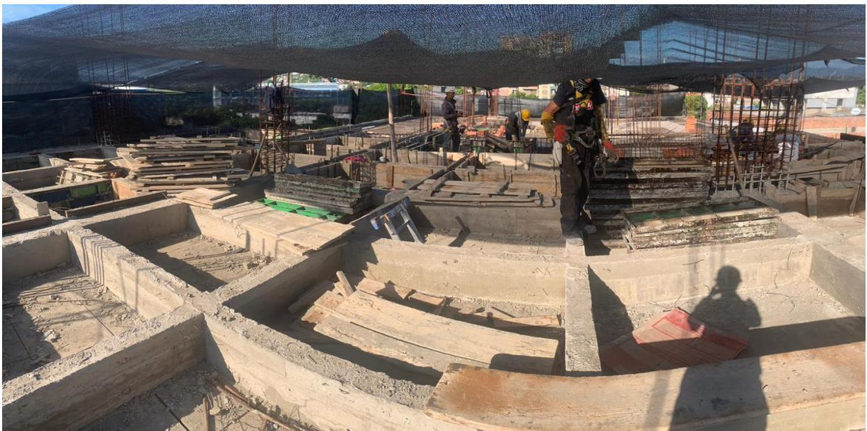
*Ilustración 115. Segunda parte de desencofrado de vigas nivel 5.*
