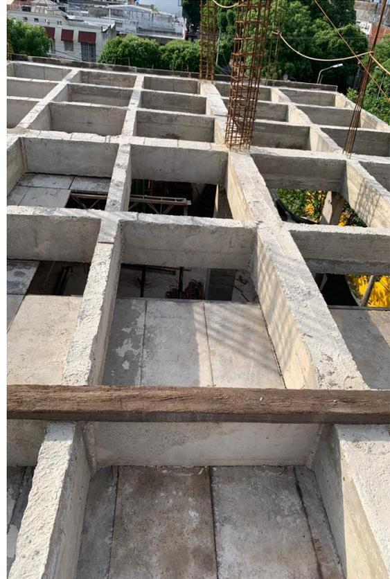
*Ilustración 39. Desencofrado de vigas secundarias ejes A-C Edificio Wiedii*
