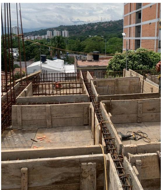
*Ilustración 37. Encofrado de vigas secundarias ejes 1-2 (A-E), Edificio Wiedii*
