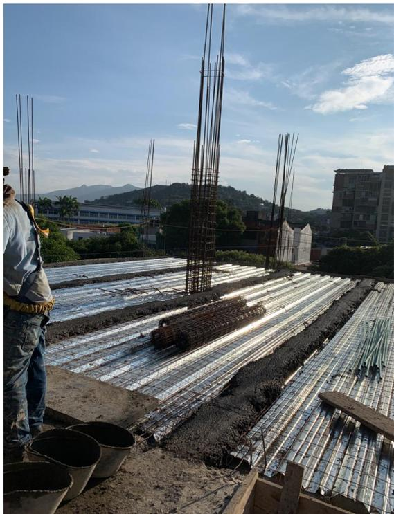
*Ilustración 60. Alineamientos para fundida de placa metaldeck Edificio Wiedii*
