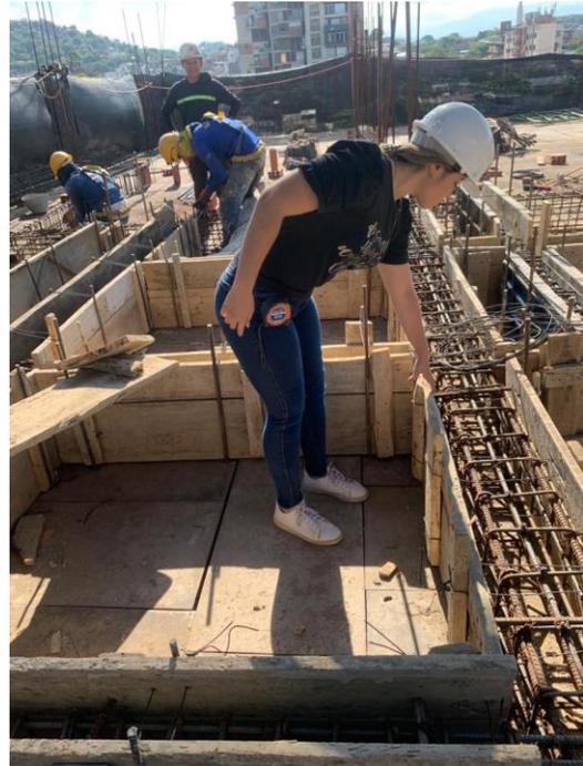
*Ilustración 107. Encofrado de vigas nivel 5eje 2C-D, Edificio Wiedii.*
