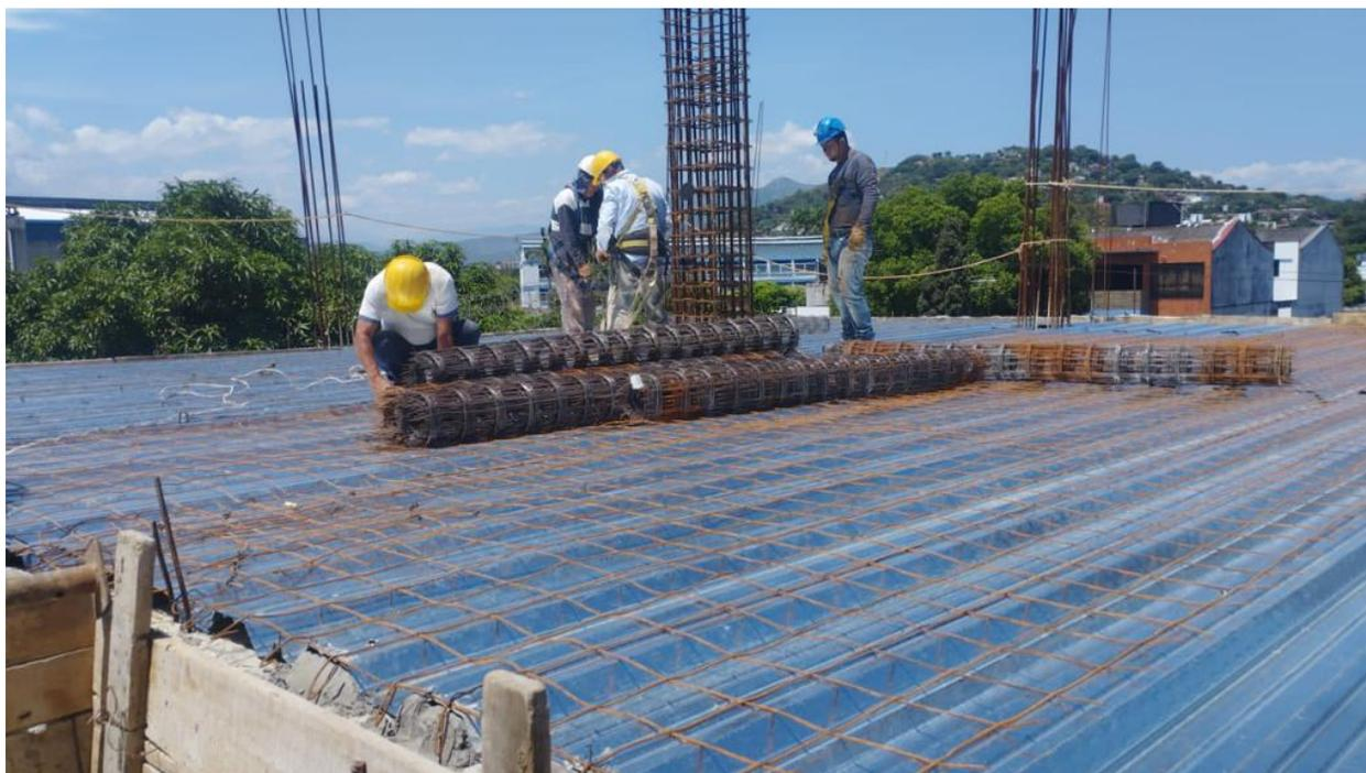
*Ilustración 59. Instalación de malla electrosoldada ejes E-G Edificio Wiedii*
