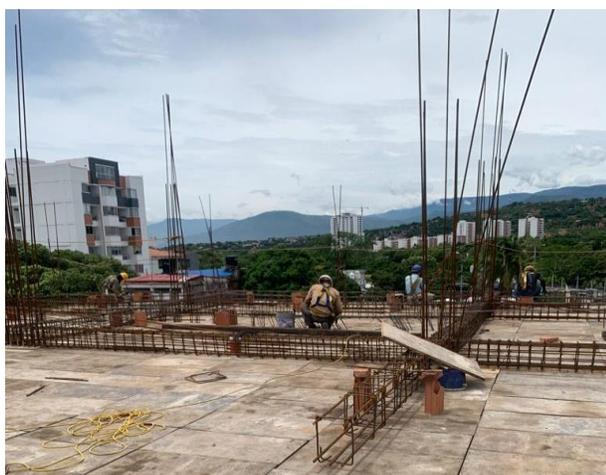
Ilustración 27. Armado de vigas secundarias eje 2-3 Edificio Wiedii.
