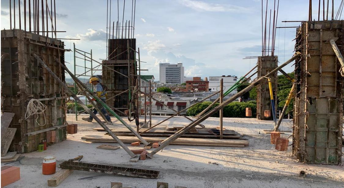
*Ilustración 91. Encofre de columnas nivel 4 ejes 1-4 (E-H)*
