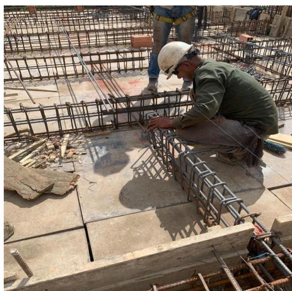
Ilustración 26. Armado de viga secundaria Edificio Wiedii
