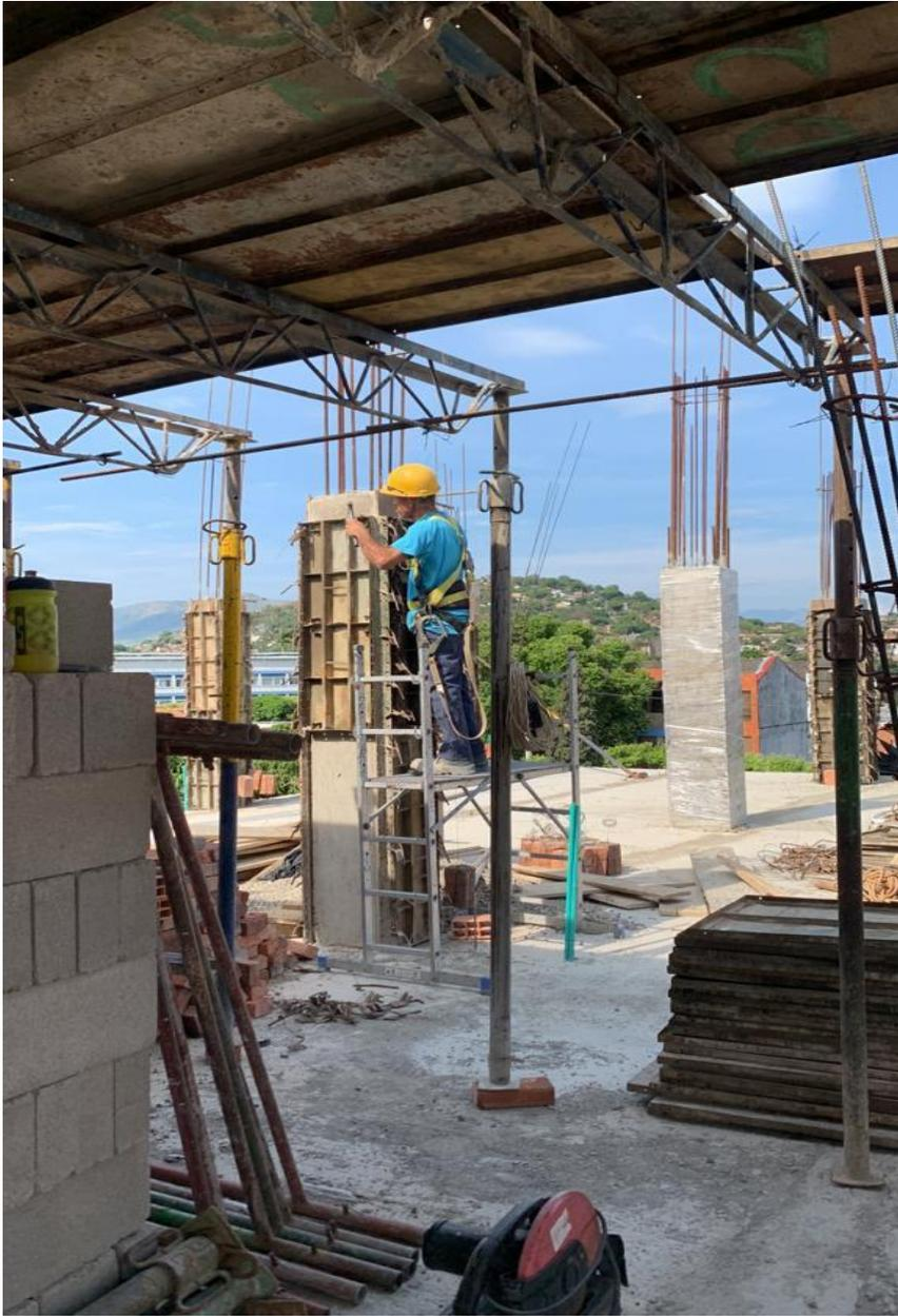
*Ilustración 93. Desencofrado de columna 2E.*
