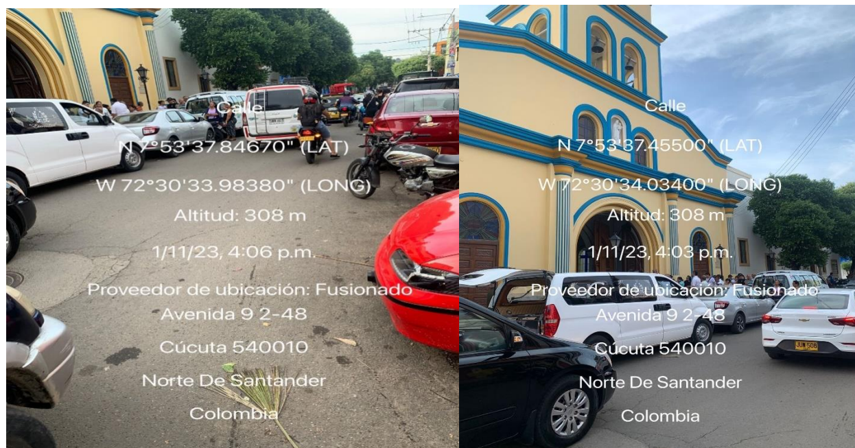
Figura 18. Tráfico y mal Estado de las Vías.
