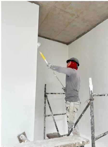
**Figura 9.** Aplicación de pintura en interiores.
