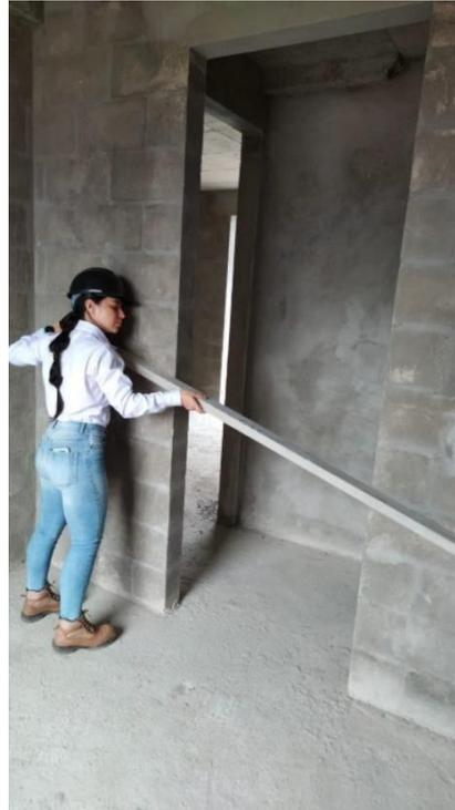
**Figura 11.** Codaleo en el recibimiento de una vivienda.
