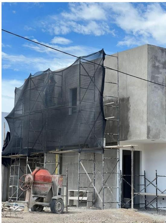
**Figura 4.** Lona protectora de material particulado.
