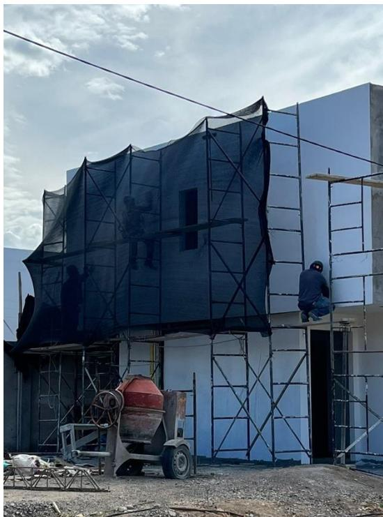
**Figura 6.** Empastado con lona de protección hacia el vecino incapacitado.
