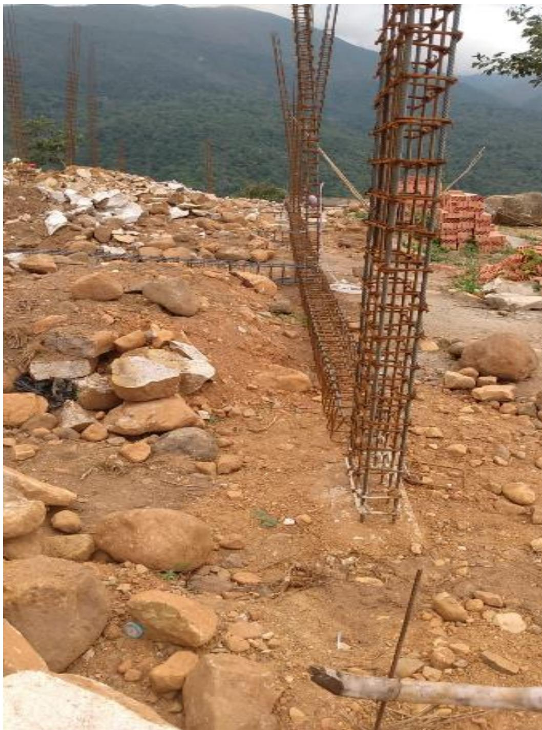
**Figura 13. Armadura de viga de amarre**
