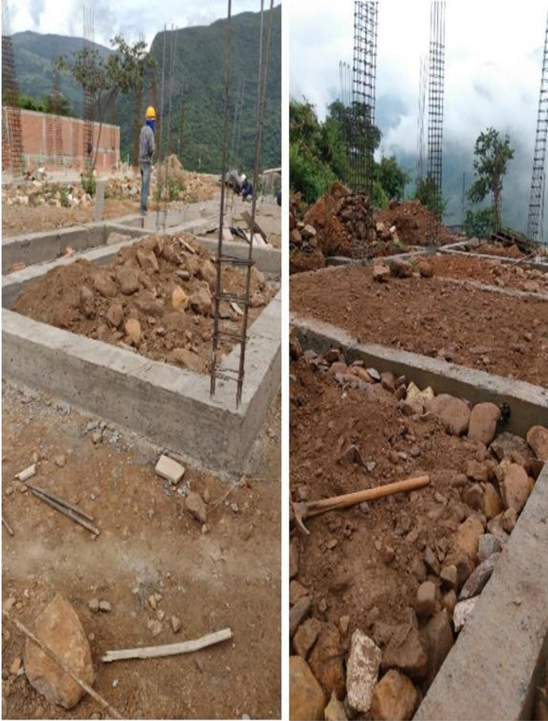
**Figura 14. Vigas de amarre de cimentación fundidas**
