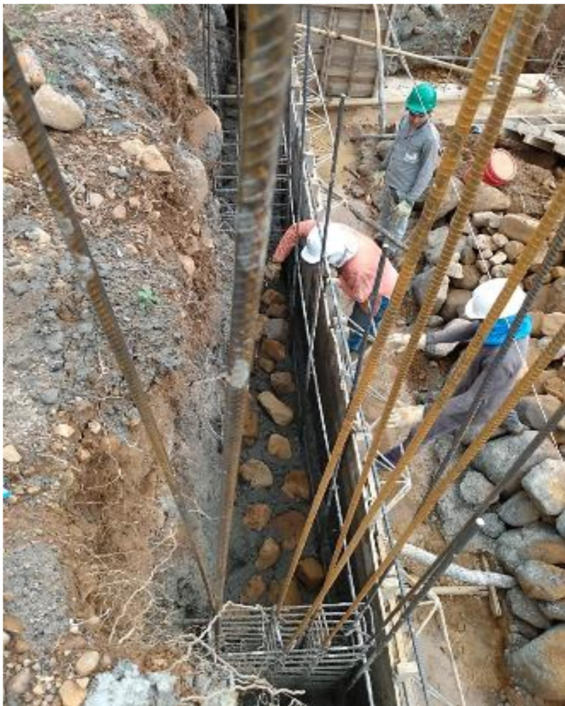
**Figura 10. Muro de contención en concreto ciclópeo**
