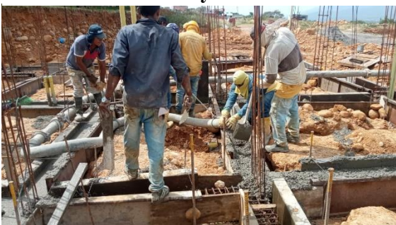
Figura 49 Fundida de viga de cimentación casa 10 y 11 Mz D
