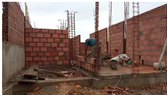
Figura 30 Mampostería en bloque casa 1 Mz E
