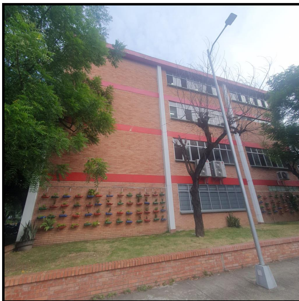
Ilustración 17. Edificio Aulas Generales. Fuente: elaboración propia.
