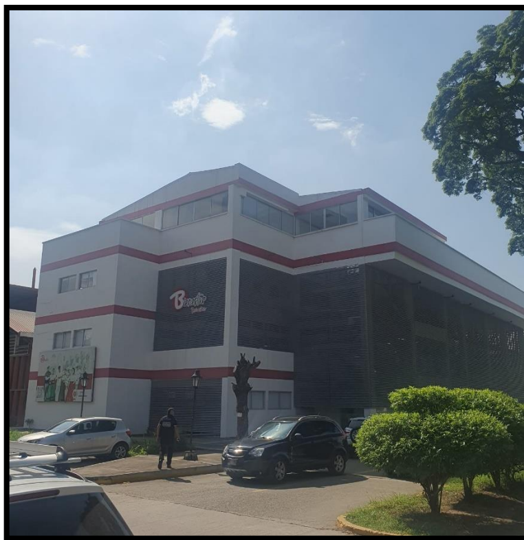
Ilustración 31. Edificio Bienestar Universitario. Fuente: elaboración propia.
