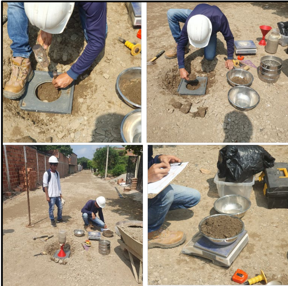
Ilustración 66. Toma de muestra para ensayo de cono de arena.
