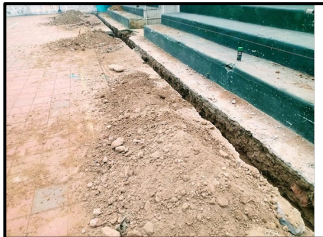
Ilustración 40. Excavación de vigas longitudinales.
