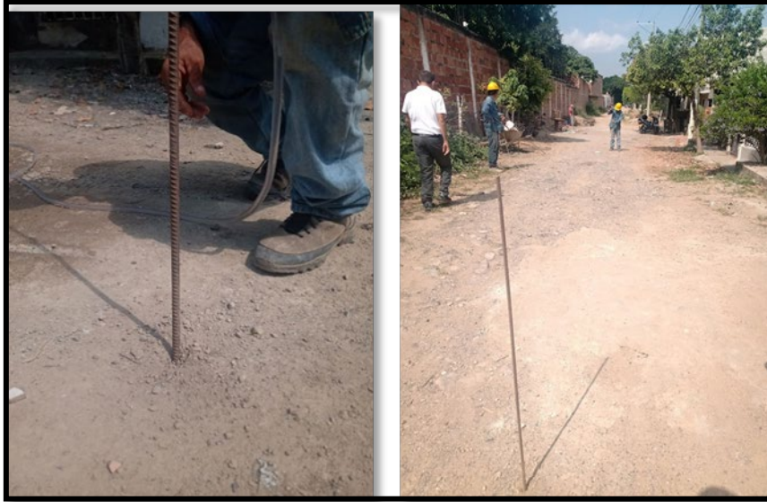
Ilustración 7. Toma de Niveles con Manguera.
