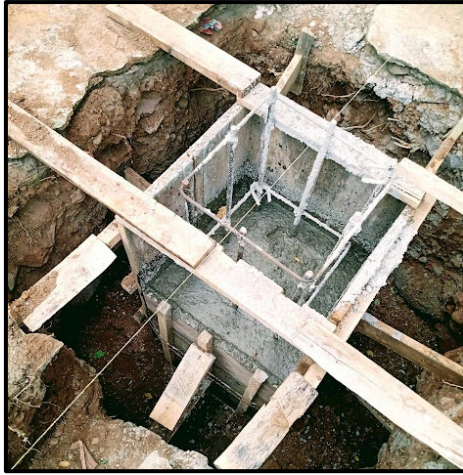
Ilustración 57. Vaciado y secado del concreto.
