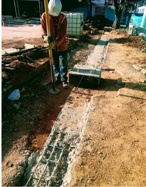
Ilustración 44. Compactación completa del material escogido hasta losa terreno.
