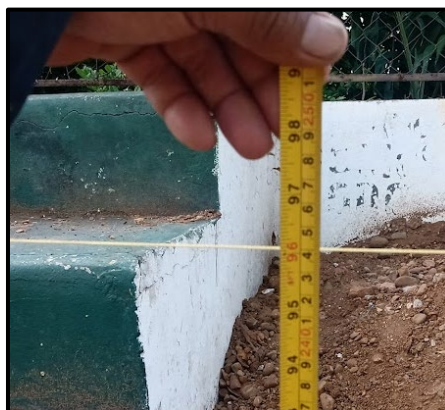
Ilustración 49. Control del Nivel de Zapatas.
