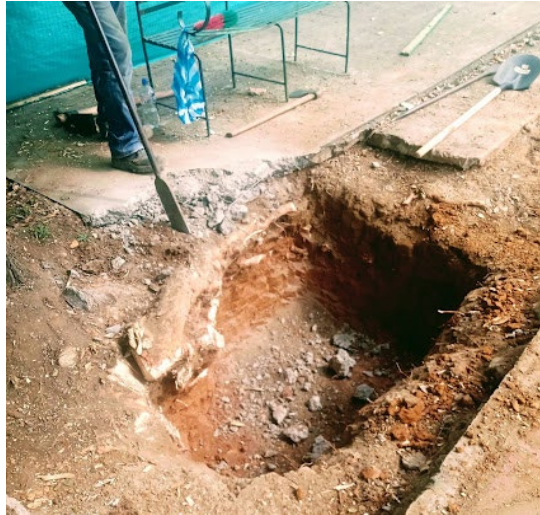
Ilustración 34. Excavación parcial en la zapata "E"
