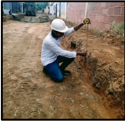
Ilustración 10. Verificación de los niveles de corte.
