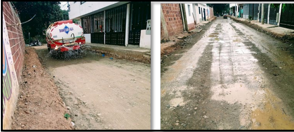
Ilustración 14. Suministro de agua para mejor compactación de la subbase granular.
