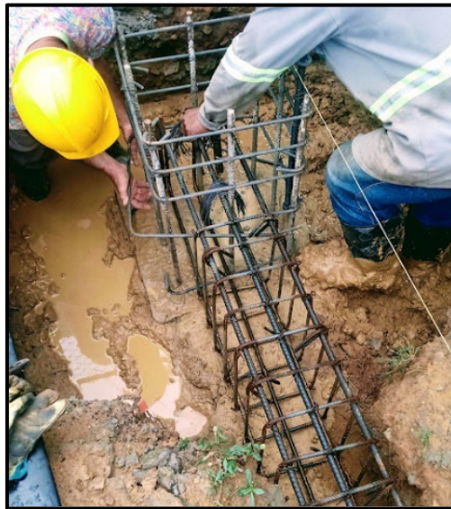
Ilustración 43. Retiro de material por motivos de lluvia.
