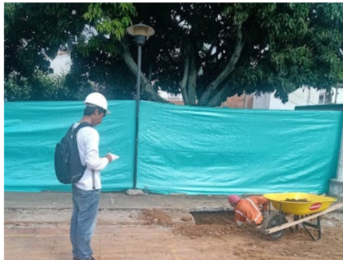
Ilustración 33. Control y supervisión de la excavación de las zapatas.
