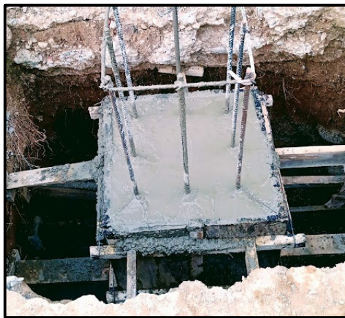
Ilustración 58. Fundida del pedestal.
