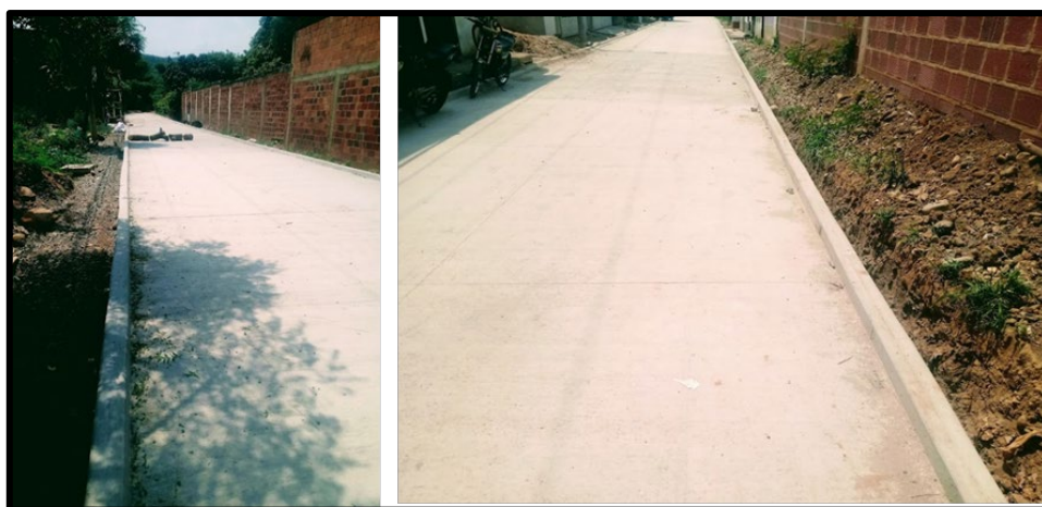
Ilustración 27. Finalización de Calzada y Sardineles.
