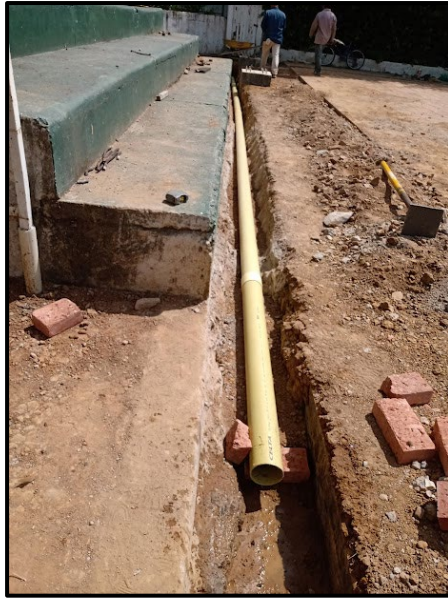
Ilustración 63. Tubería de PVC 4" de caja a caja y caja hacia calle.
