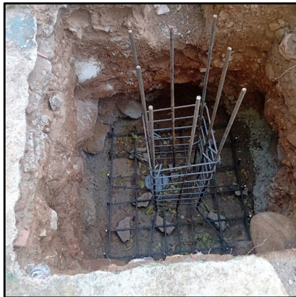
Ilustración 62. Acero de la zapata aislada.
