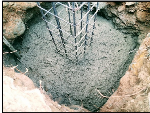
Ilustración 47. Instalación de concreto para zapatas.
