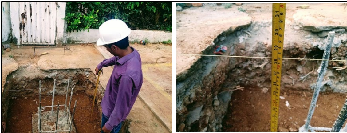
Ilustración 41. Nivel de relleno del material escogido.
