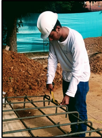
Ilustración 61. Verificaciones de las distancias de la parrilla.
