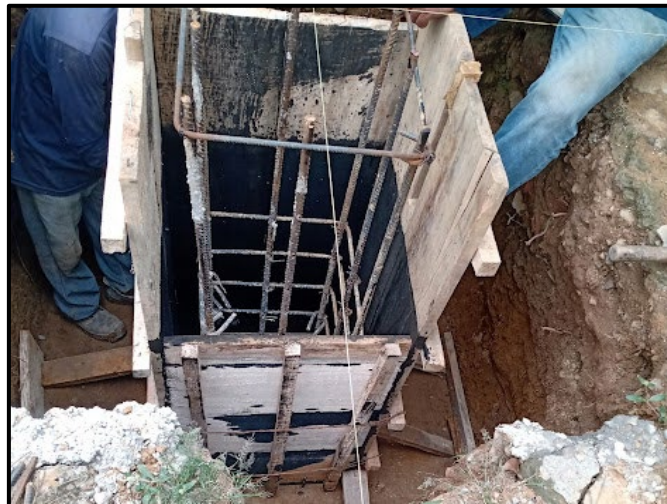
Ilustración 56. Formaleta usada para los pedestales.
