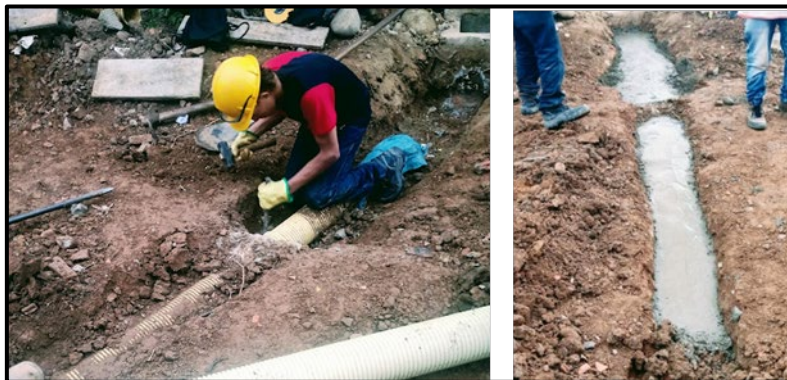
Ilustración 20. Reparación de domiciliaria de alcantarillado con concreto.
