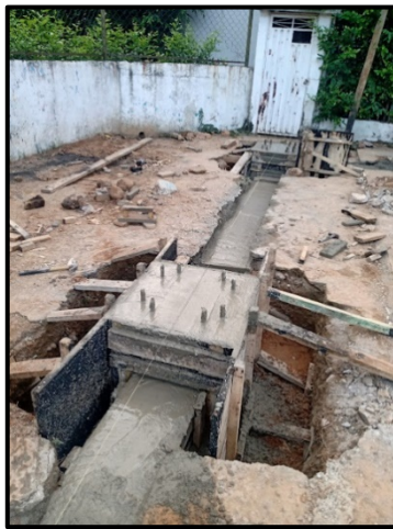
Ilustración 53. Vigas de cimentación concluidas.
