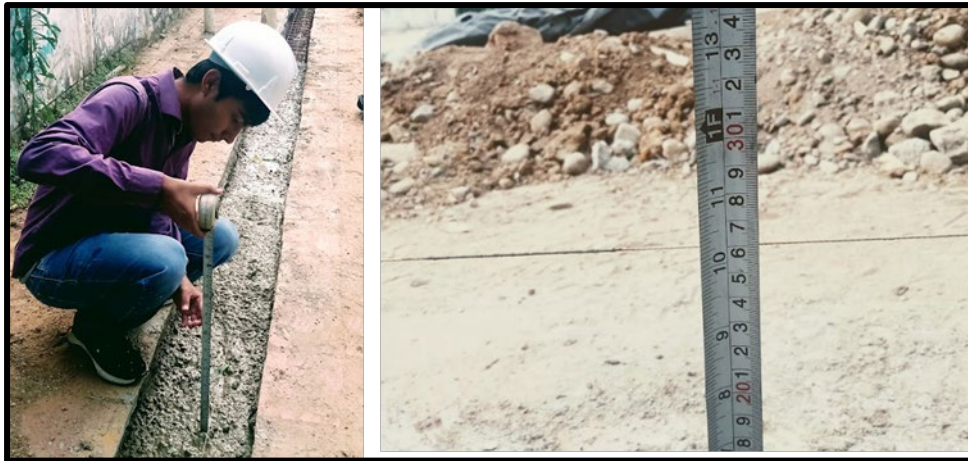
Ilustración 55. Verificación de los niveles de las vigas.
