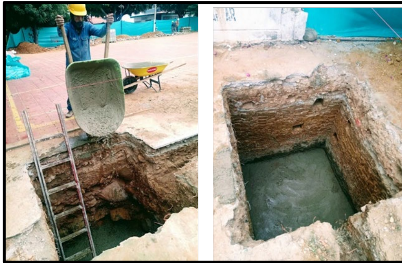
Ilustración 45. Suministro de solado a Zapatas.
