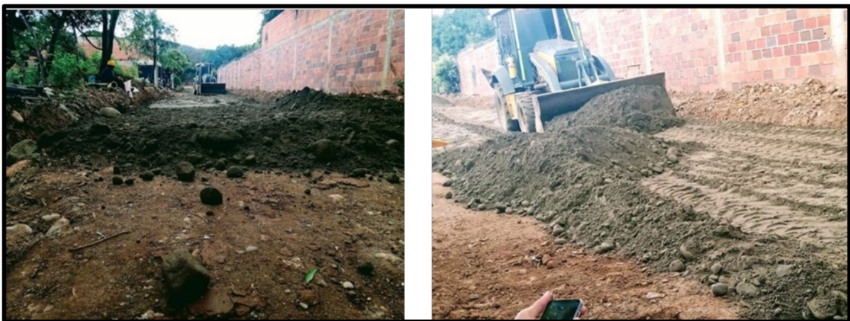
Ilustración 12. Extendido del material en K0+080.
