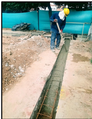
Ilustración 54. Viga transversal.
