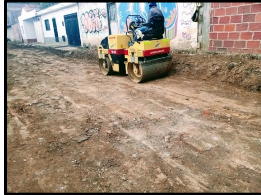
Ilustración 11. Compactación del terreno después de la actividad de cajeo.
