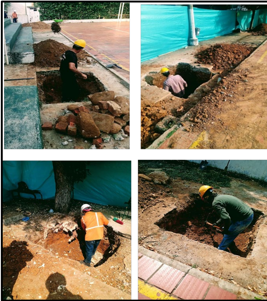
Ilustración 36. Excavaciones parciales de las diferentes zapatas.
