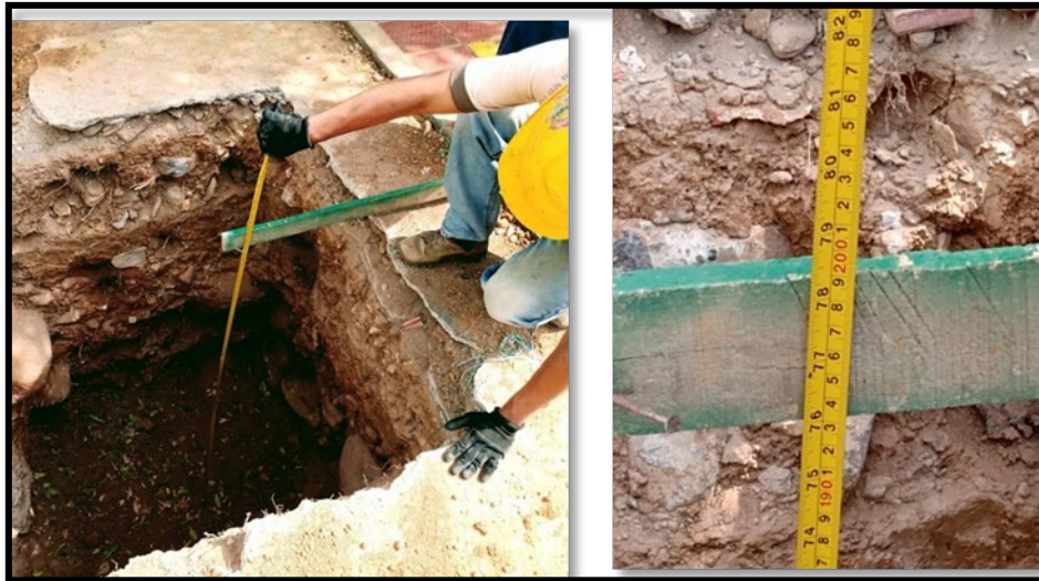
Ilustración 39. Verificación de los niveles de excavación.
