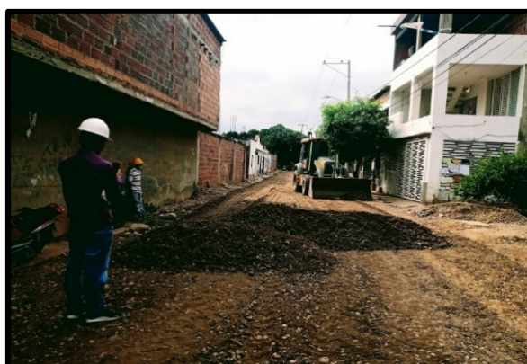
Ilustración 16. Suministro de material de base granular.
