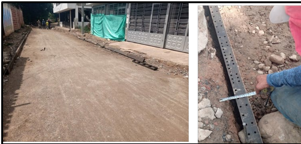
Ilustración 21. Armado de formaleta para el vaciado de concreto.
