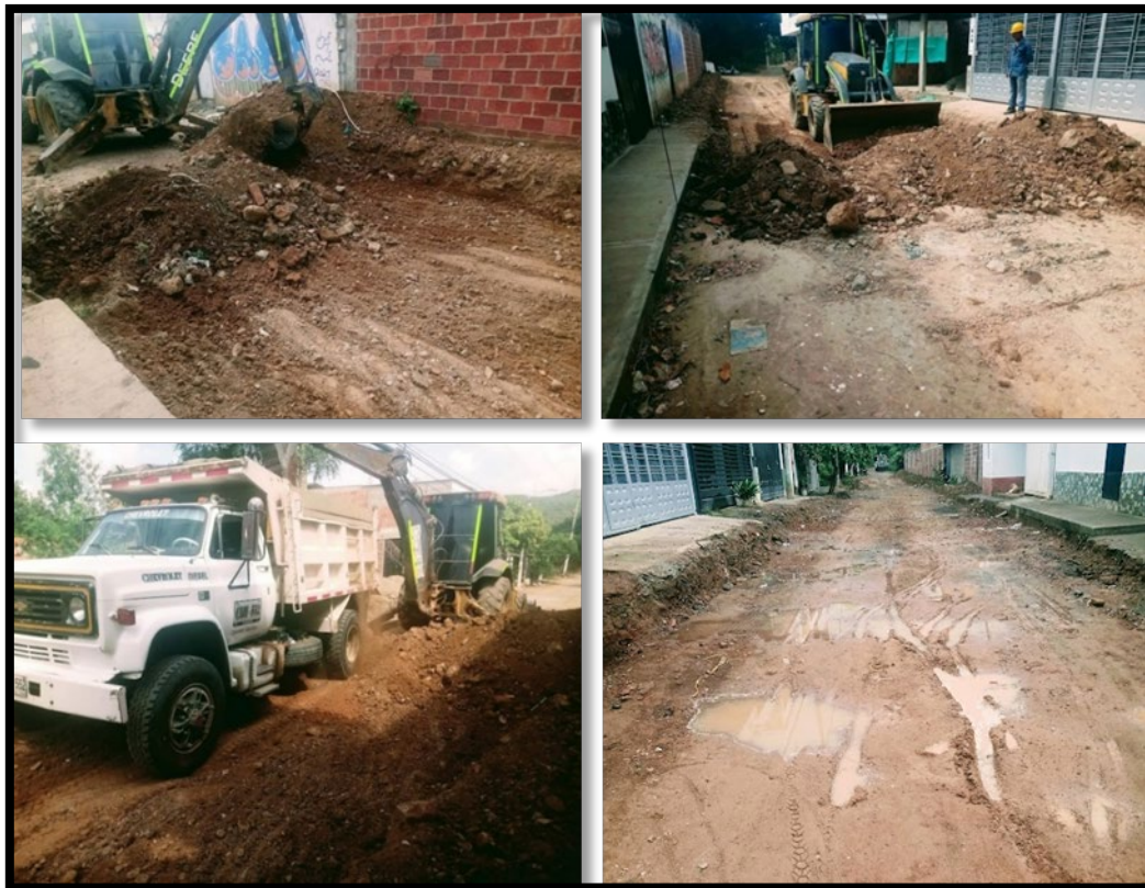
Ilustración 9. Cajeo o corte de 152metros lineales de arcilla dura.
