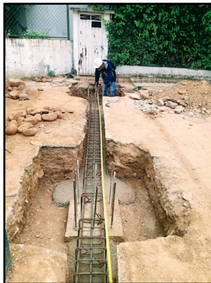
Ilustración 60. Verificación de longitudes de las varillas.
