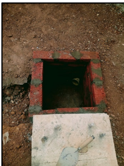
Ilustración 65. Cajas de inspecciones concluidas.
