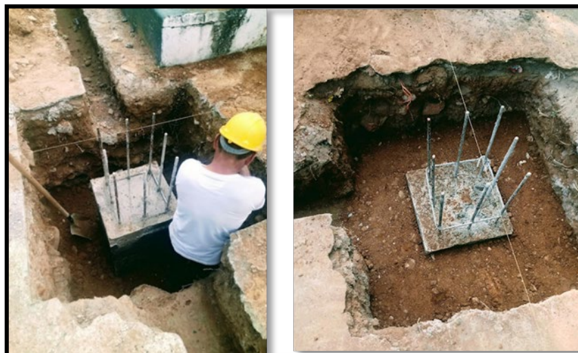
Ilustración 42. Relleno seleccionado y compactación con tizón.
