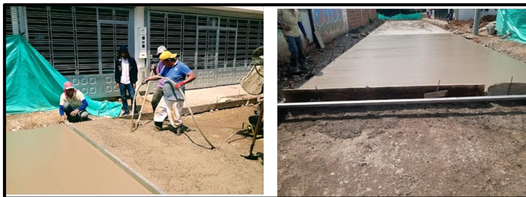
Ilustración 23. Acompañamiento en el vaciado y vibrado de concreto, desde K0+015 hasta K0+030.
