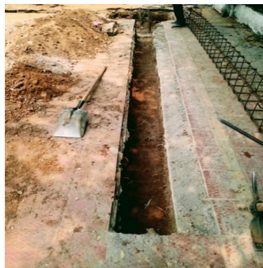
Ilustración 32. Demolición de tableta roja
