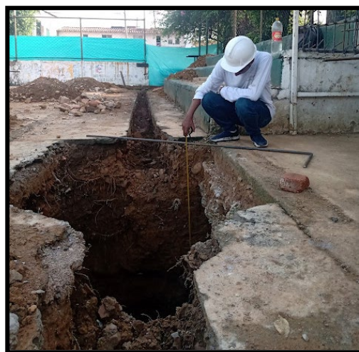
Ilustración 46. Control de los niveles estipulados en el plano.
