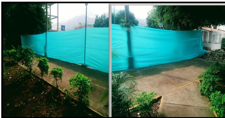
Ilustración 30. Cerramiento de tela verde.
