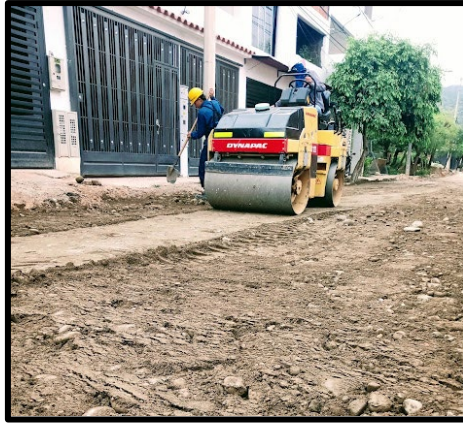
Ilustración 13. Compactación de la subbase granular.
