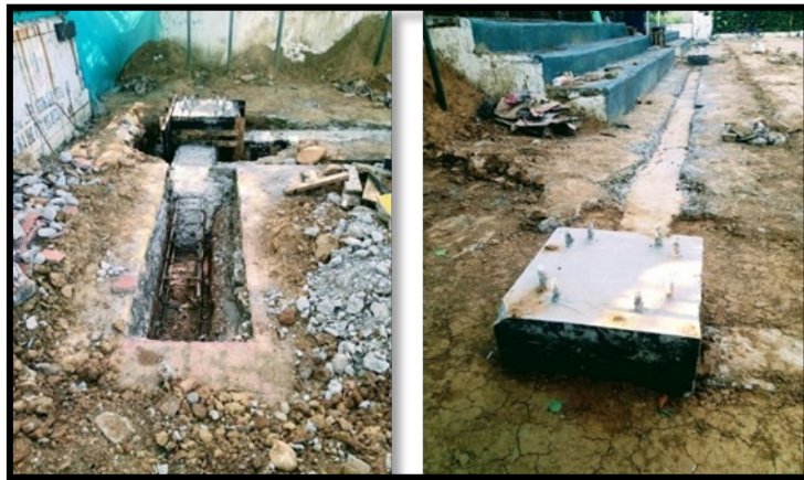
Ilustración 31. Demolición de piso en concreto.
