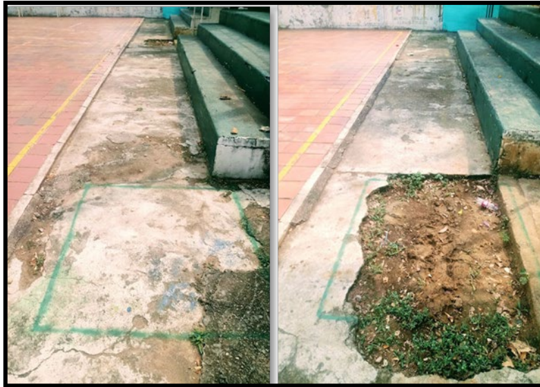
Ilustración 29. Localización y replanteo de las zapatas.
