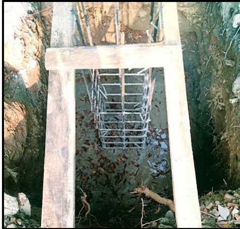
Ilustración 50. Secado de concreto en zapatas.
