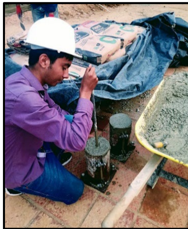
Ilustración 51. Toma de muestras de concreto para ensayo de compresión.
