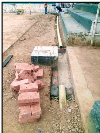
Ilustración 64. Excavación de cajas y tuberías, construcción de las cajas.
