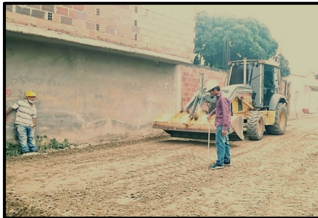
Ilustración 15. Control de los niveles de base granular.
