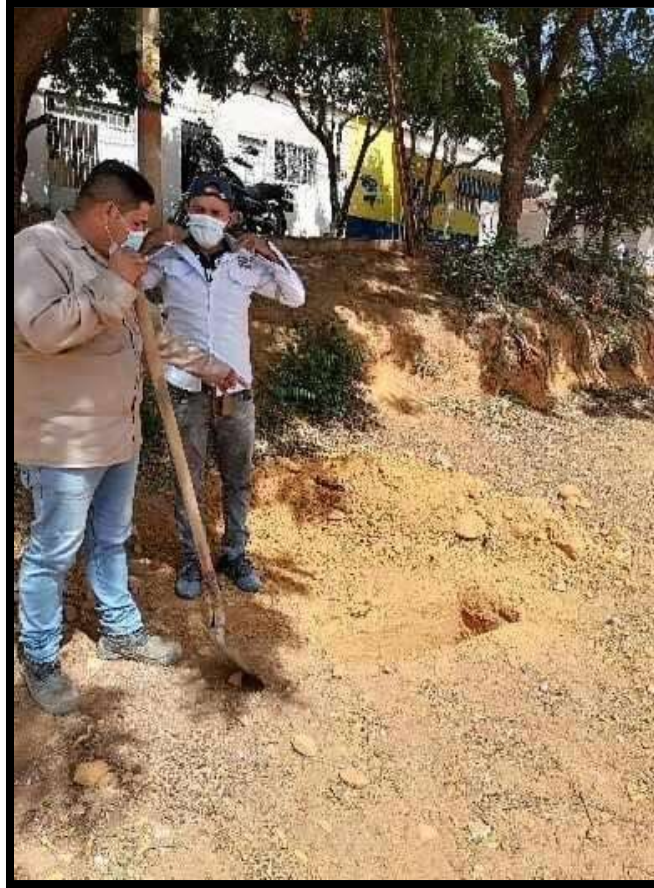
Ayuda de la comunidad en el levantamiento topográfico de la urbanización Caño Fístolo
