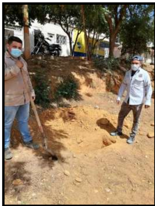
Realización del primer apique con una profundidad de 1 metro.
