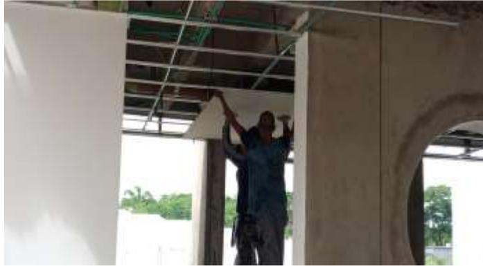
En la figura 11 se evidencia mi supervisión como asistente técnico para el proceso de instalar de forma correcta el cielo raso en Drywall.
