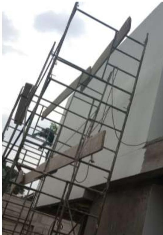
En la figura 5 se evidencia la aplicación de pasta en la zona externa en el muro del segundo piso de la vivienda.
