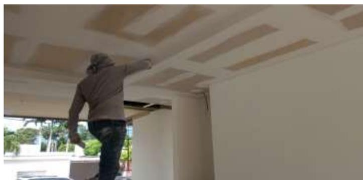
En la figura 13 se evidencia mi supervisión como asistente técnico para el cubrimiento de las uniones y juntas de las placas del cielo raso en Drywall. 4.1.5.2 Programado vs ejecutado
