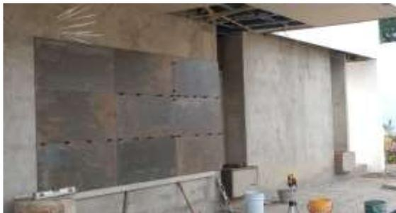
En la figura 16 se evidencia la instalación de porcelanatos en muro exterior de la vivienda
