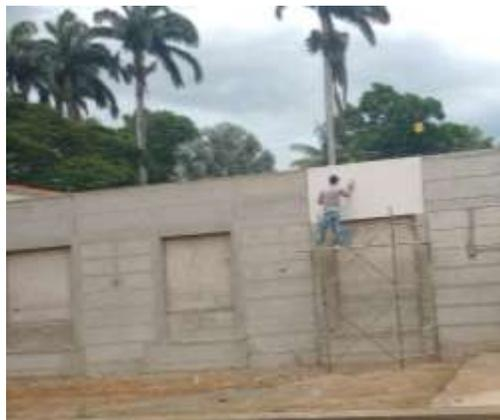
En la figura 3 de evidencia mi supervisión como asistente técnico sobre el proceso de la primera aplicación de pasta gruesa en los muros exteriores de la vivienda en la zona de la piscina
