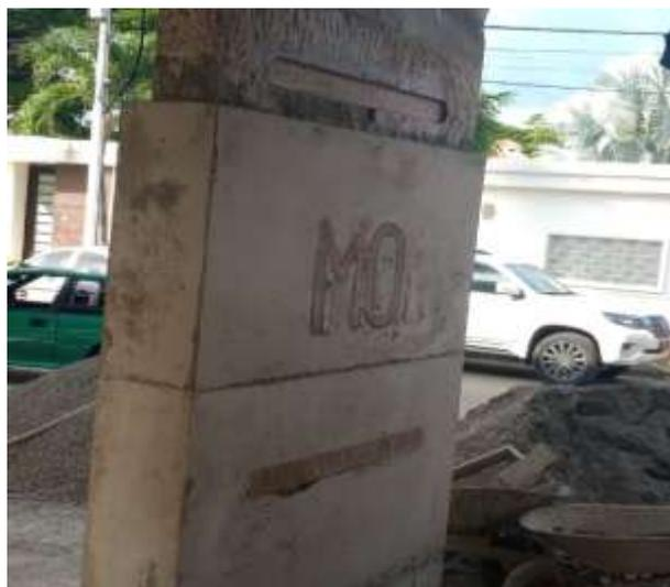
En la figura 24 se evidencia el resultado al día siguiente de haber vaciado el concreto en la columna.
