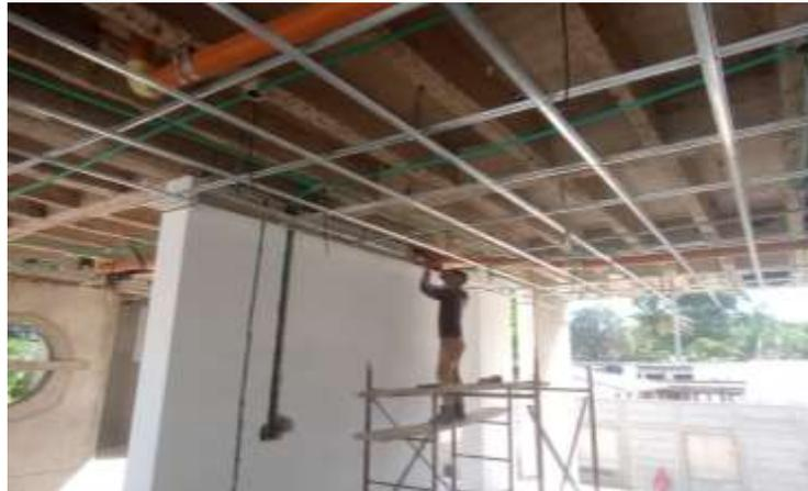
En la figura 9 se evidencia mi supervisión como asistente técnico para el proceso de instalar de forma correcta los soportes para el cielo raso en Drywall.
