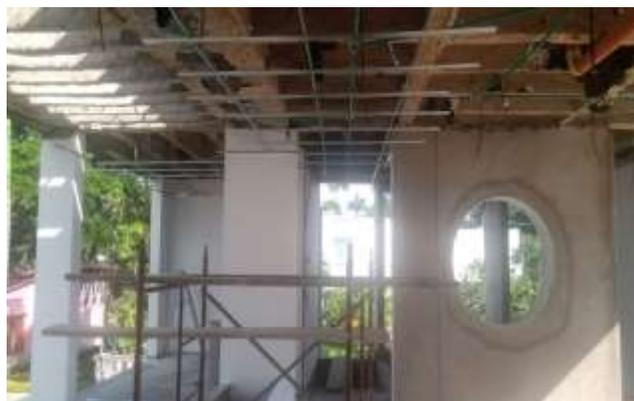
En la figura 10 se evidencia la forma en la que quedaron instalados los soportes de los cielos raso en la zona del pasillo del segundo piso.
