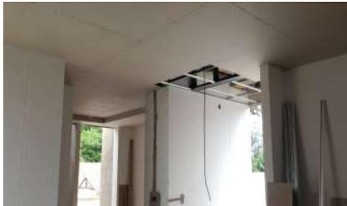
En la figura 12 se evidencia como quedo el montaje de las placas de cielo raso en el sector de pasillo del segundo piso.
