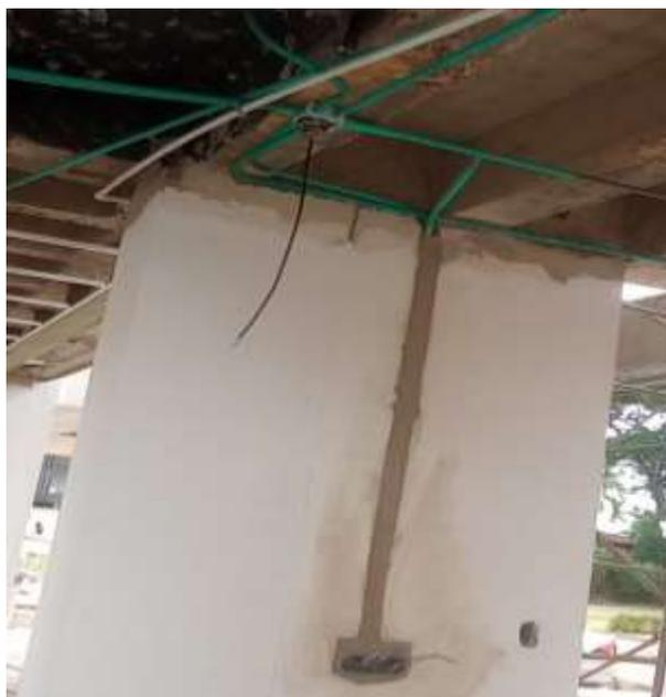
En la figura 29 se evidencia la estructura de la red eléctrica en una columna del primer piso
