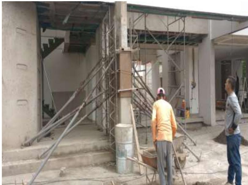
En la figura 23 se evidencia mi supervisión como asistente técnico de obra al proceso de vaciado de concreto en la columna donde se encuentra el indicativo de la vivienda.
