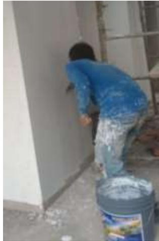
En la figura 4. de evidencia mi supervisión como asistente técnico a los obreros que se encuentran encargados de la aplicación de pasta, se evidencia la aplicación de pasta fina en una columna.
