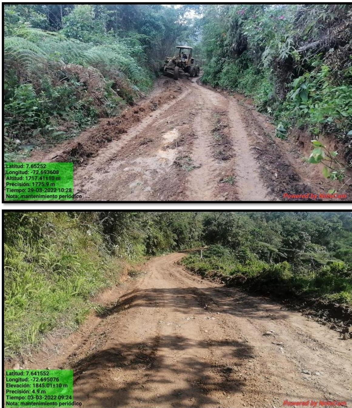
Figura 21. Conformación de la calzada existente
