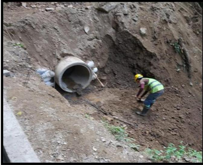
**Figura 19. Tubería de concreto reforzado 21 Mpa de 900 mm de diámetro interior**
