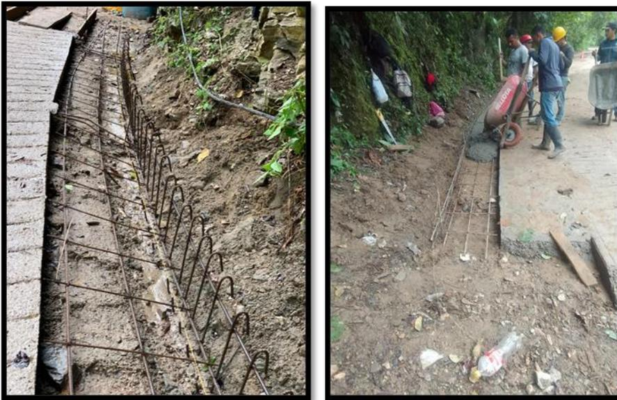
**Figura 8. Cuneta de concreto vaciada: incluye la conformación de la superficie de apoyo**
