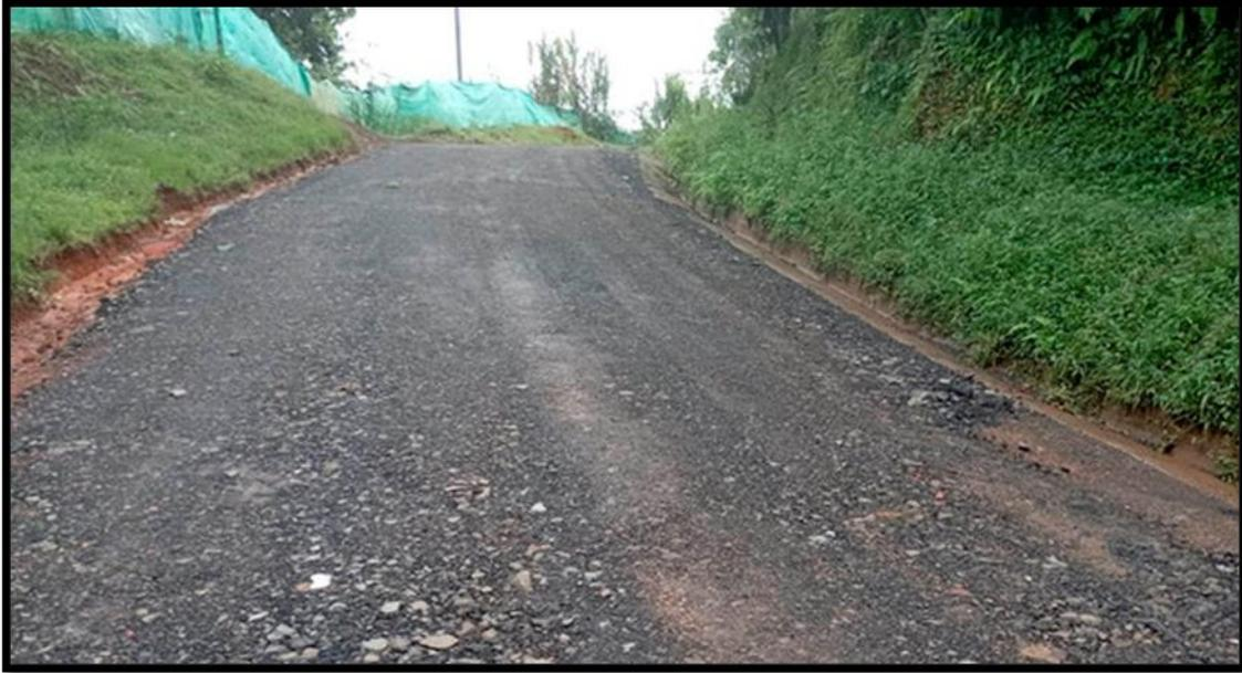
**Figura 5. Sub- base granular clase c**
