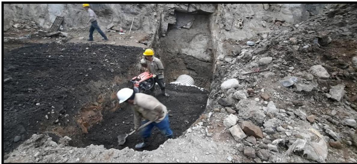
**Figura 18. Rellenos para estructura con material de excavación**
