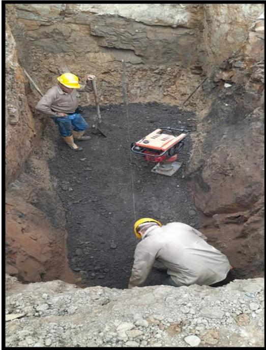
**Figura 13. Rellenos para estructura con material de excavación**
