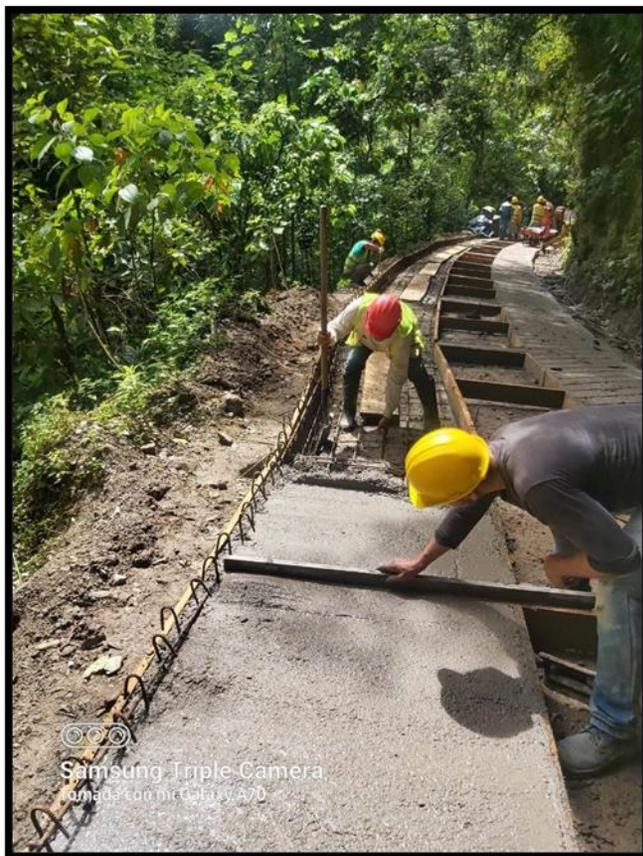
**Figura 3. Concreto resistencia 21 Mpa**
