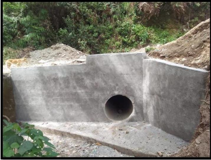
**Figura 17. Concreto clase F (140 kg/cm<sup>2</sup> 6 2000 psi)**
