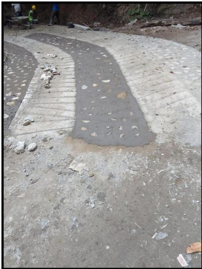
**Figura 6. Concreta resistencia 14 Mpa (g) (ciclópeo)**
