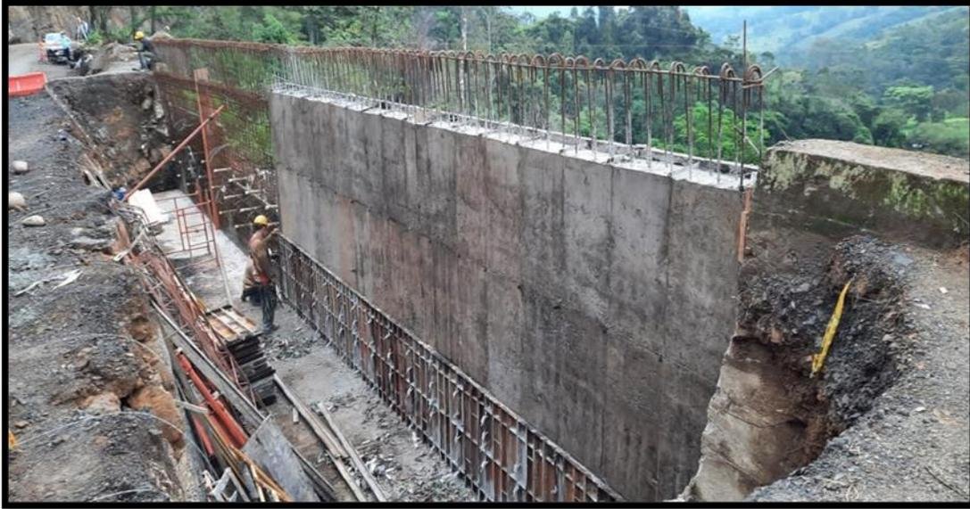
**Figura 11. Concreto resistencia 21 Mpa (d)**
