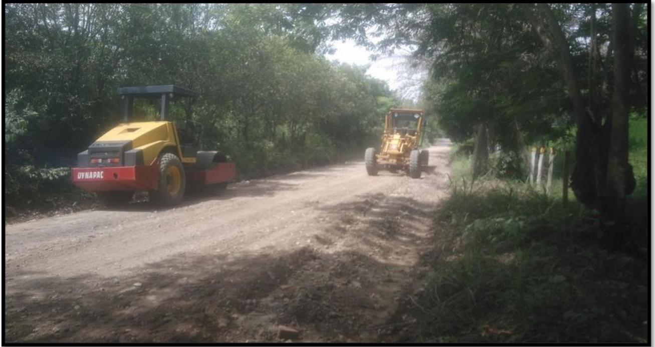
**Figura 22. Mejoramiento de la subrasante con adición de material**
