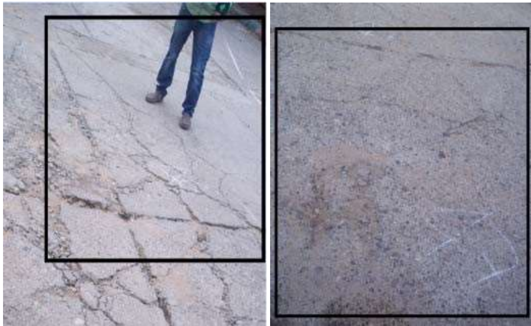
Grieta en bloque. Grieta en bloque.
