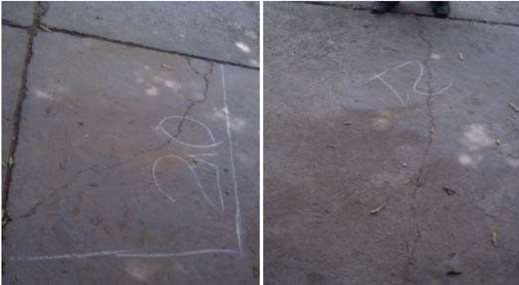
Grieta en bloque. Grieta en bloque.
