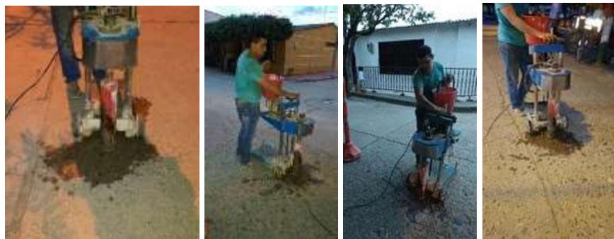
Figura 3. Toma de núcleos de concreto a las losas del pavimento
