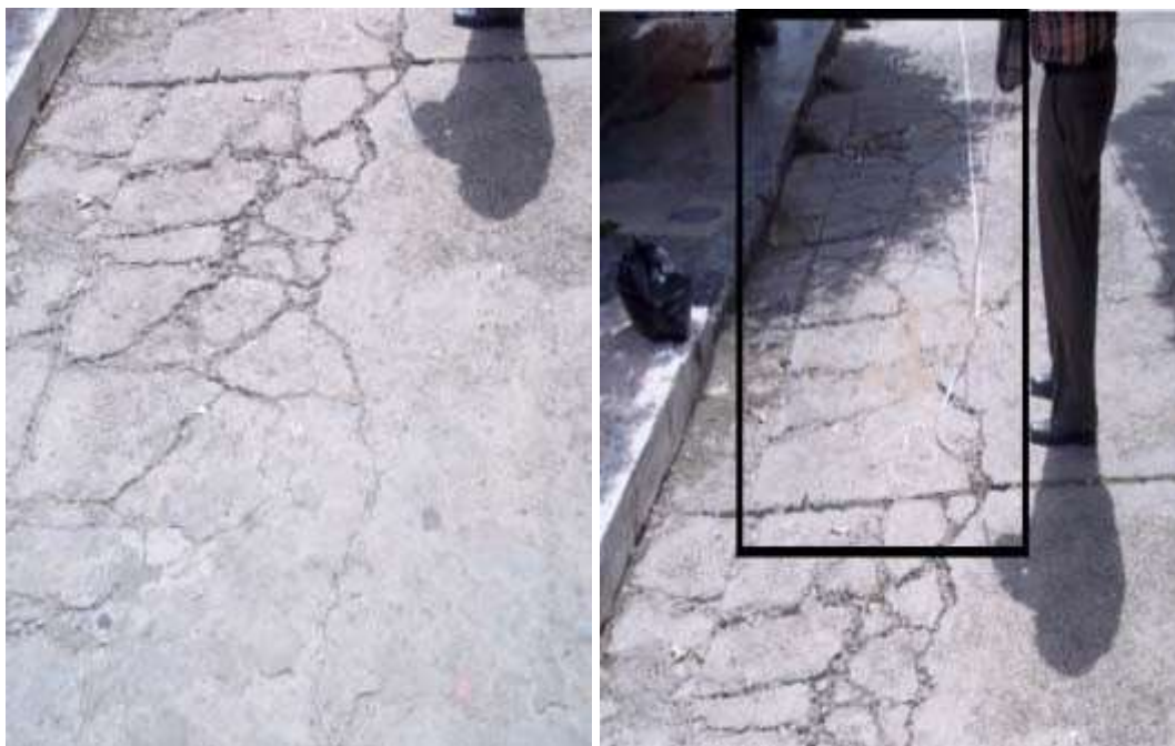
Grieta en bloque. Grieta en bloque.
