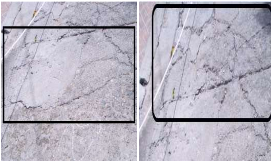
Grieta en bloque. Grieta en bloque.
