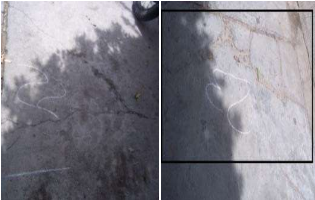
Grieta en bloque. Grieta en bloque.
