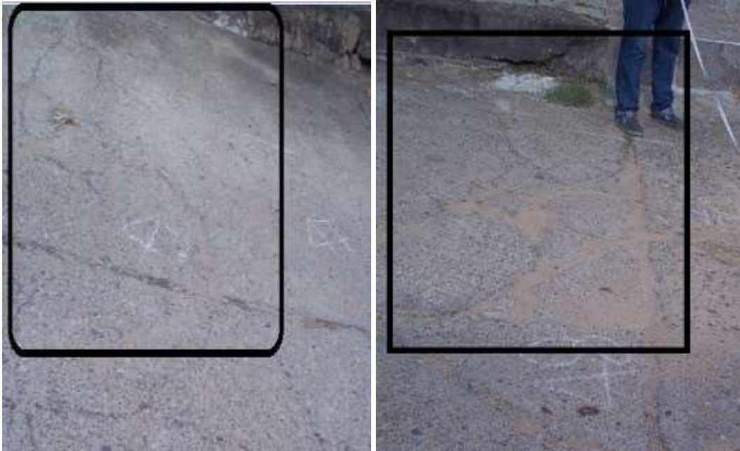
Grieta esquina. Grieta esquina en losas A9 y B9.
