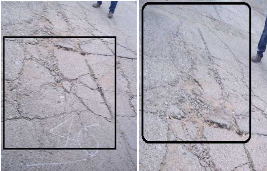
Grieta en bloque. Grieta en bloque.
