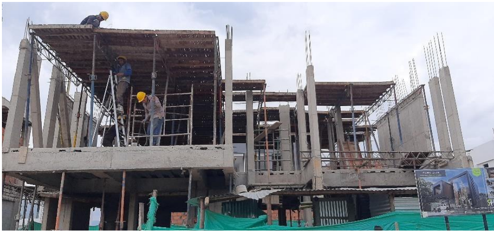
Figura 58. Tarima placa entre piso, tercer nivel
