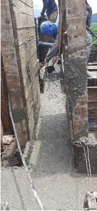
Figura 65. Vaciado en concreto vigas de entre piso, tercer nivel
