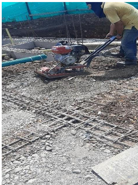
Figura 11. Compactación subbase granular
