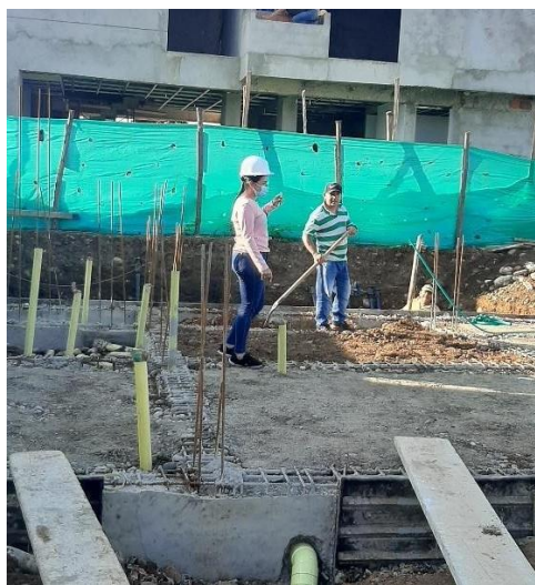
Figura 12. Supervisión compactación de la subbase granular
