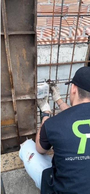
Figura 45. Instalación red eléctrica en muros estructurales
