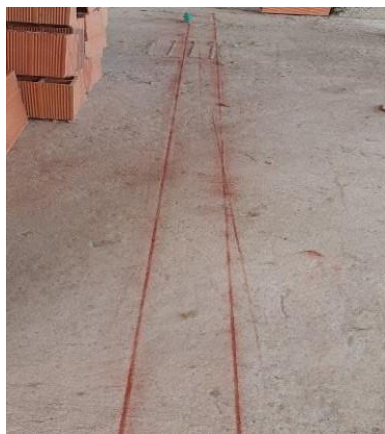
Figura 53. Cimbrado para muros en mampostería, segundo nivel
