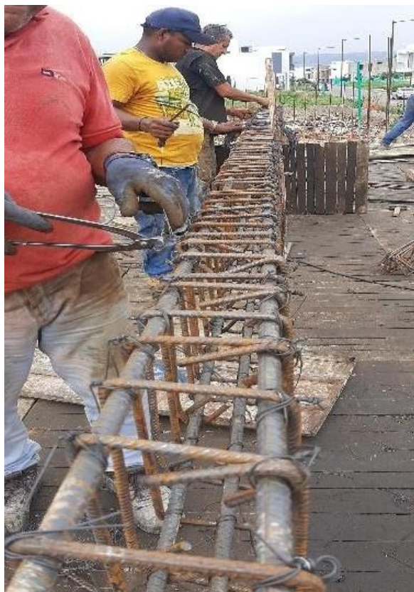
Figura 32. Armadura vigas de entre piso, segundo nivel
