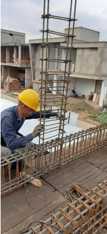
Figura 35. Instalación arranque de columnas y muros pantalla, segundo piso
