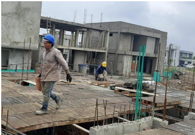
Figura 31. Tarima placa segundo piso, visto desde la parte superior
