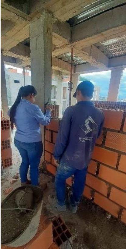
Figura 57. Verificación plomada muros en mampostería, segundo nivel
