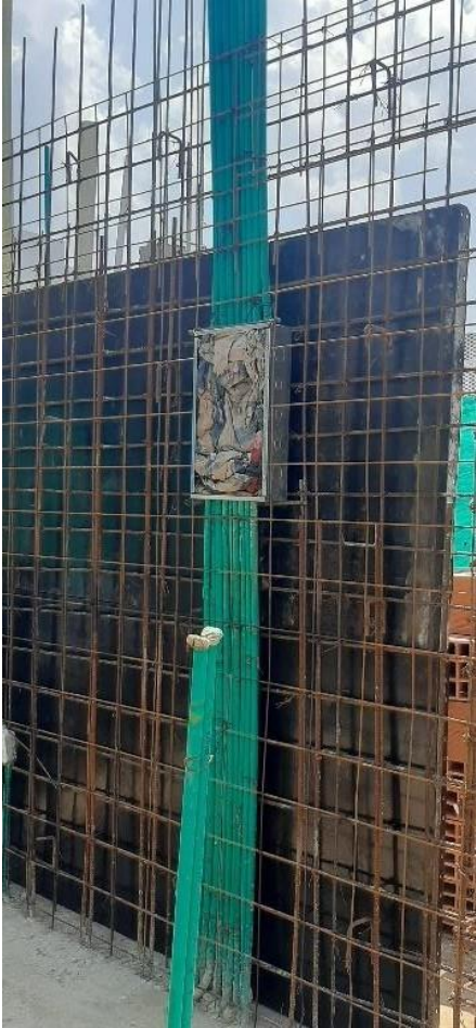
Figura 22. Instalación red eléctrica en el muro pantalla
