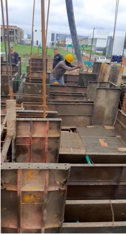
Figura 37. Vaciado concreto vigas de entre piso, segundo nivel
