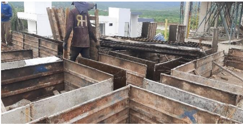
Figura 63. Encofrado vigas de entre piso, tercer nivel
