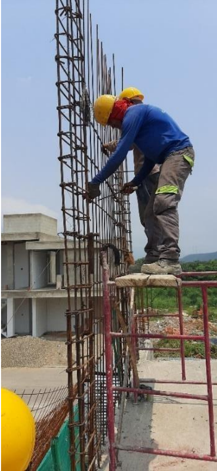
Figura 43. Armadura en varilla 9mm en muros pantalla segundo piso
