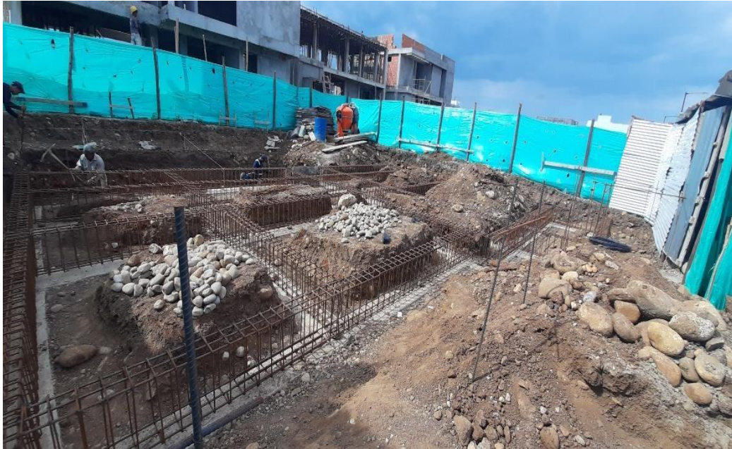
Figura 4. Vigas de cimentación
