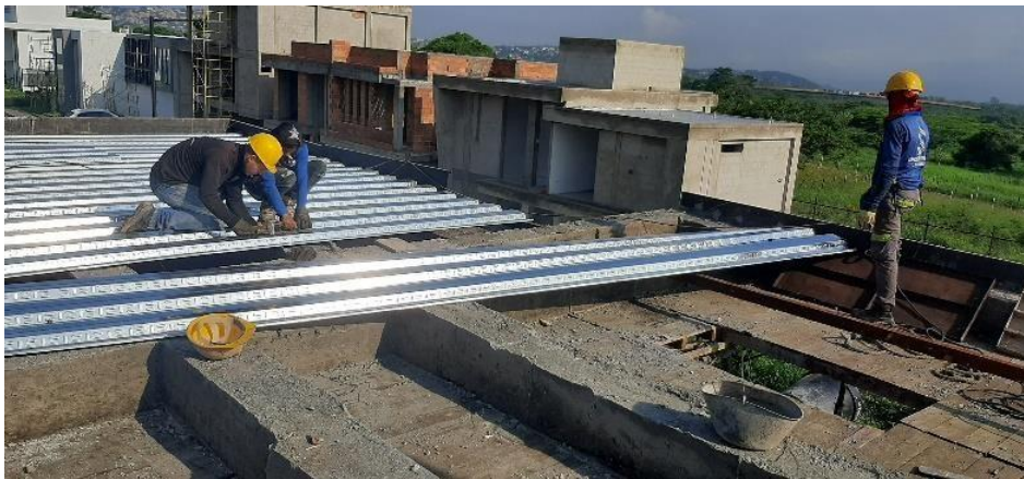
Figura 67. Instalación lamina de metaldeck, placa de entre piso, tercer nivel
