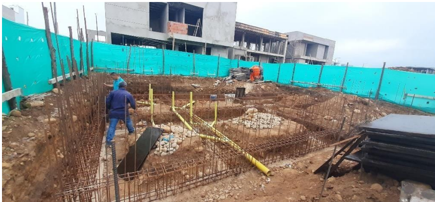
Figura 6. Instalación red hidrosanitaria
