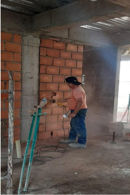
Figura 29. Regata para instalación de las respectivas redes
