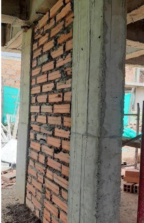
Figura 27. Muro en mampostería primer nivel
