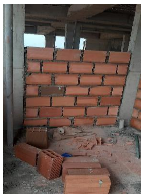
Figura 55. Muro en mampostería, levantado hasta la mitad
