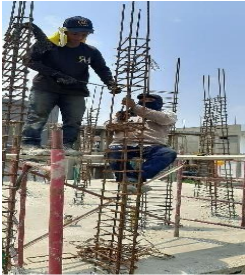
Figura 42. Armadura columnas segundo piso
