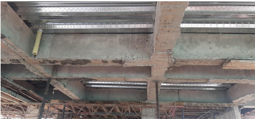
Figura 41. Tubos pasantes red hidrosanitaria segundo nivel
