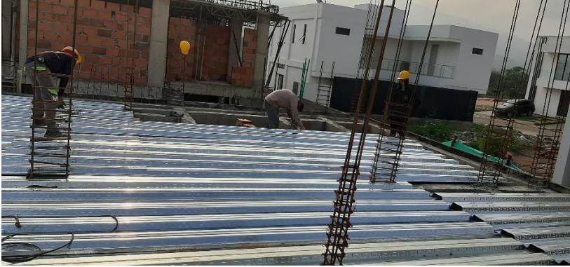
Figura 39. Instalación láminas de metaldeck, placa entre piso, segundo nivel
