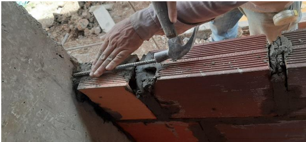
Figura 28. Refuerzo de varilla 3/8" cada 2 hiladas un largo de 20cm
