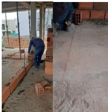
Figura 54. Colocación de bloque primeras hiladas
