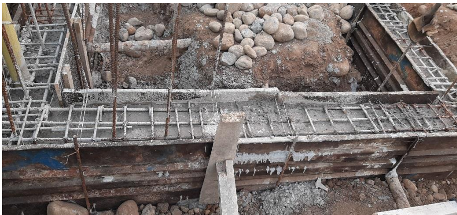
Figura 9. Vaciado concreto vigas de cimentación
