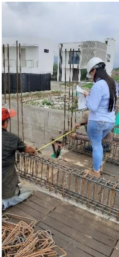
Figura 33. Supervisión armadura vigas de entre piso, segundo nivel
