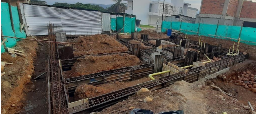
Figura 8. Encofrado vigas de cimentación
