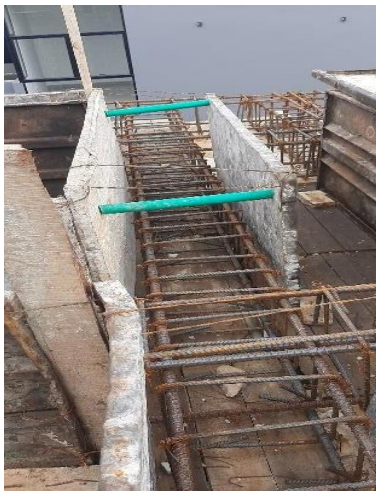
Figura 64. Separación formaleta de las vigas de entre piso, tercer nivel
