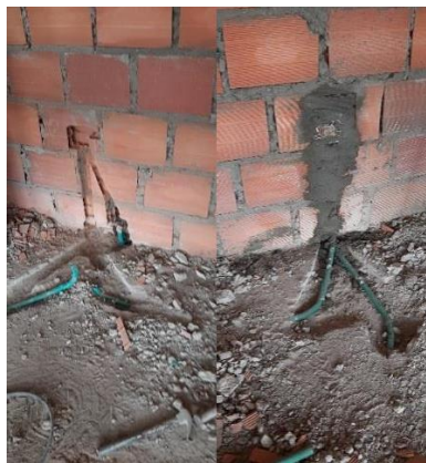
Figura 56. Regata muros en mampostería, segundo nivel
