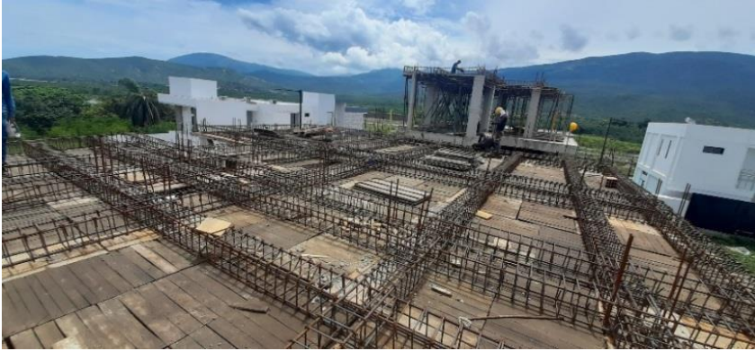
Figura 62. Vigas de entre piso, tercer nivel, terminadas
