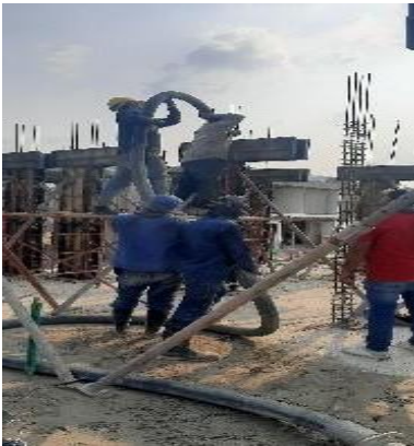
Figura 48. Vaciado en concreto muros estructurales y columnas, segundo piso
