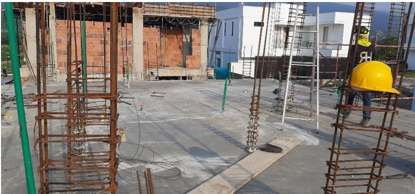
Figura 40. Placa de entre piso segundo nivel fundida
