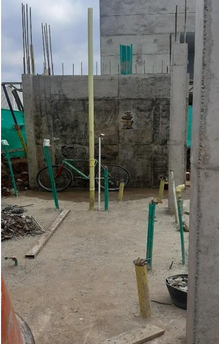
Figura 24. Muros estructurales terminados del primer nivel
