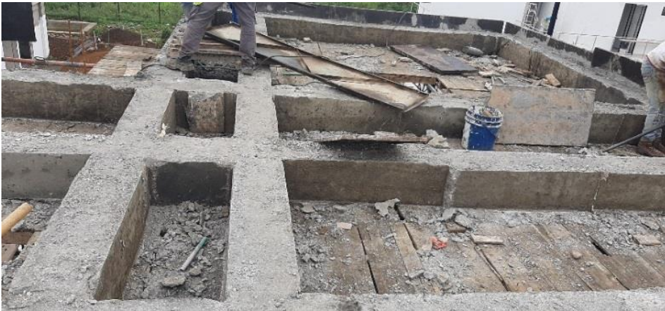
Figura 66. Desencoframiento de las vigas de entre piso, tercer nivel
