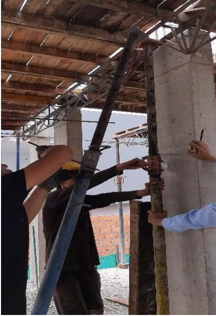
Figura 59. Alineación tarima de placa entre piso, tercer nivel
