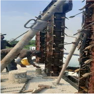
Figura 47. Alineación de la formaleta
