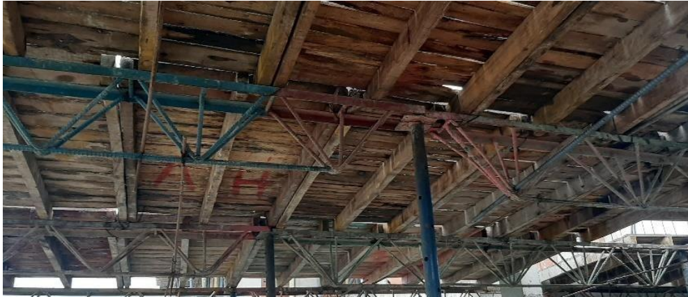
Figura 30. Tarima placa segundo piso, visto desde la parte inferior
