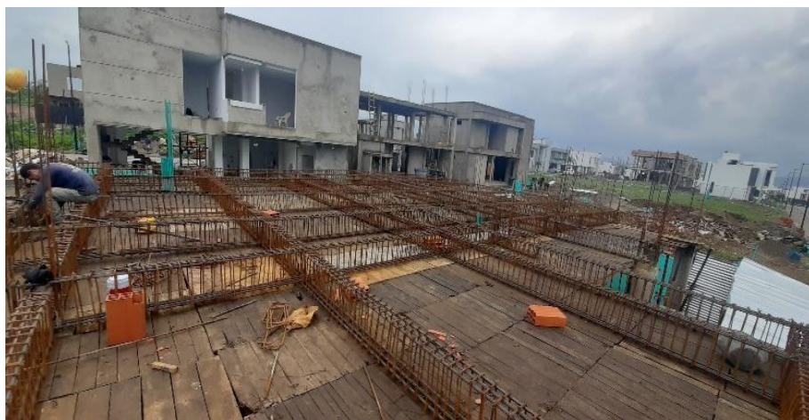
Figura 34. Vigas de entre piso, segundo piso
