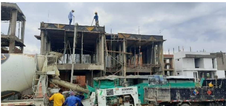
Figura 68. Vaciado en concreto placa de entre piso, tercer nivel
