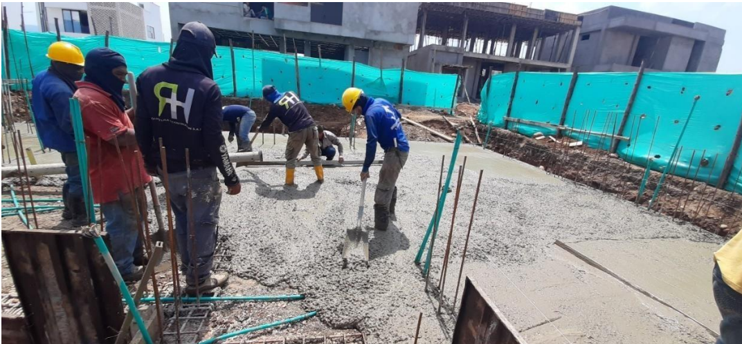
Figura 14. Vaciado concreto losa de cimentación
