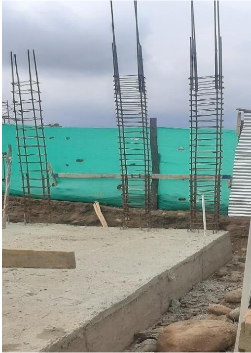
Figura 19. Armadura columnas primer nivel.
