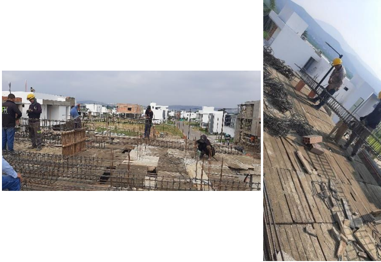
Figura 60. Armadura vigas de entre piso, tercer nivel
