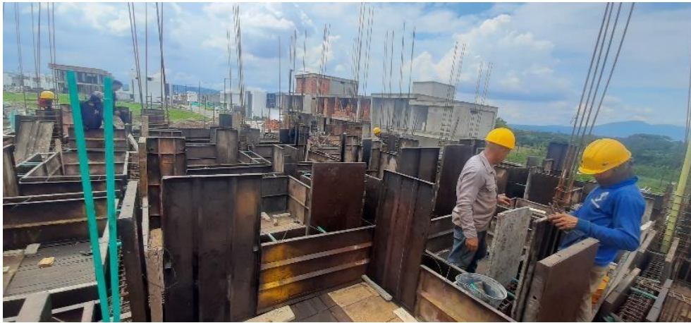
Figura 36. Encofrado vigas de entre piso, segundo piso
