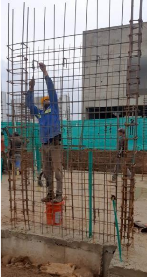
Figura 21. Instalación malla electrosoldada
