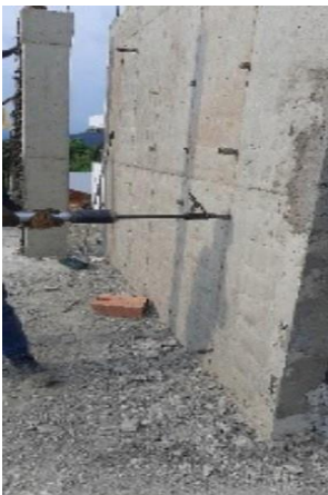
Figura 52. Se están sacando las corbatas de un muro terminado
