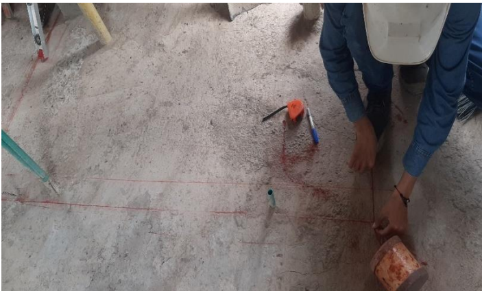
Figura 26. Cimbrado del piso para poder pegar los bloques del primer nivel
