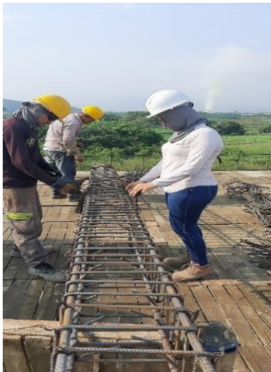
Figura 61. Verificación separación de los flejes de la viga de entre piso, tercer nivel
