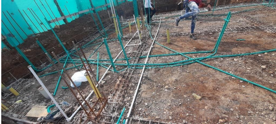
Figura 7. Instalación red hidráulica y eléctrica
