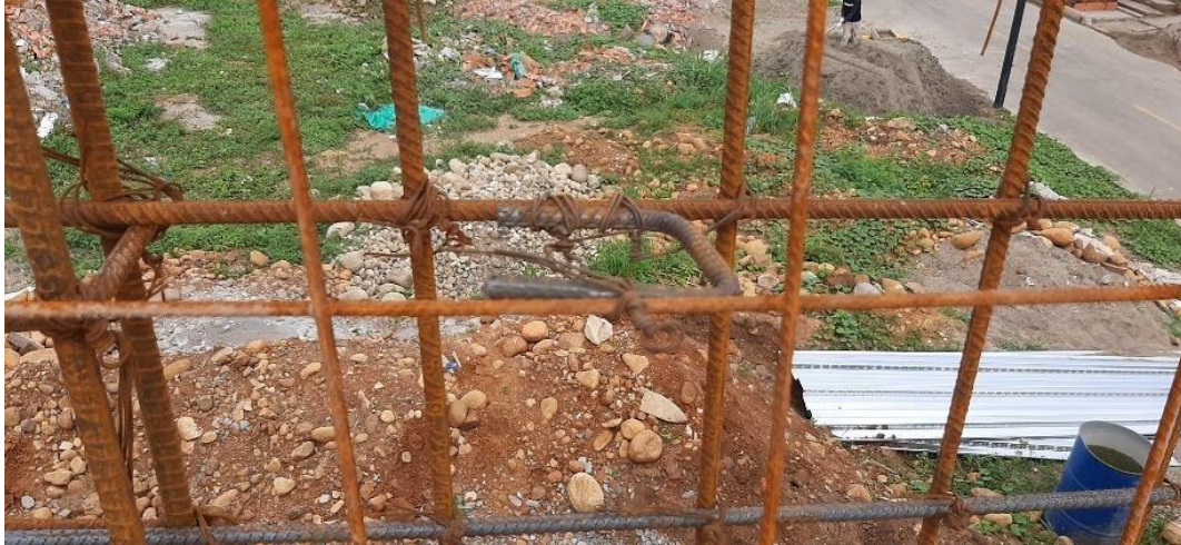
Figura 44. Separadores entre la malla electrosoldada y malla de 9mm
