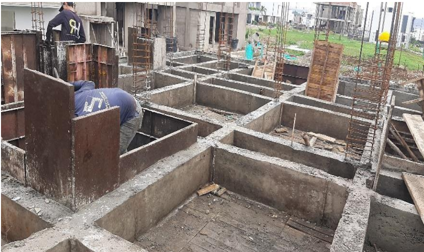
Figura 38. Desencofrado vigas de entre piso, segundo nivel
