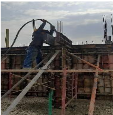
Figura 49. Vibración del concreto, para eliminar las burbujas con aire
