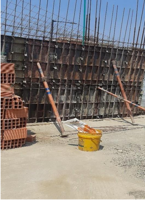
Figura 23. Encofrado muros pantalla primer nivel
