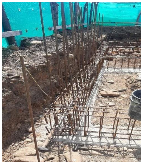
Figura 16. Arranques de muros estructurales
