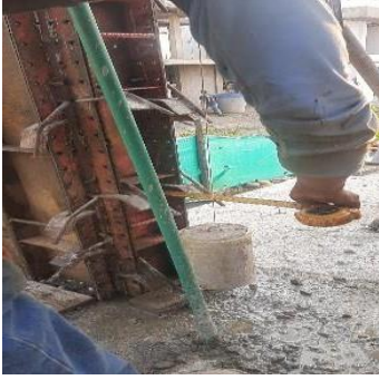
Figura 50. Rectificación de alineamiento de los muros y columnas después de fundidos.
