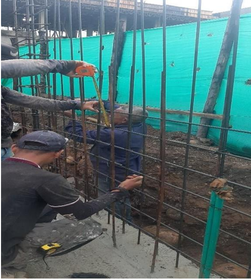
Figura 20. Armadura muros estructurales primer nivel
