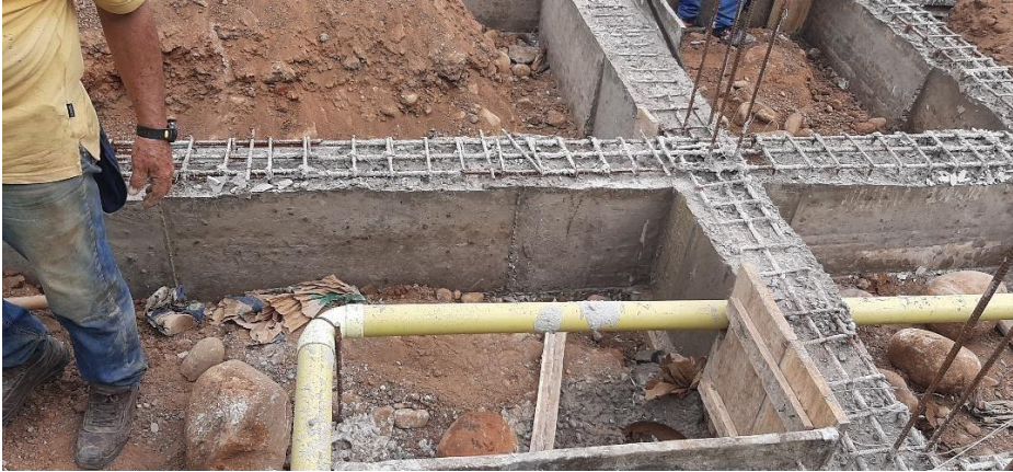
Figura 10. Desenclafado vigas de cimentación
