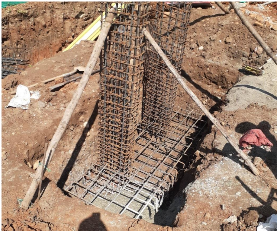
Figura 24. Evidencia fotográfica de sujecion y alineación de pedestales.
