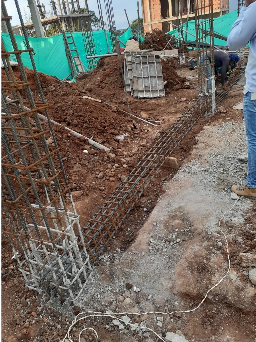
Figura 27. Evidencia fotográfica – viga de cimentación.
