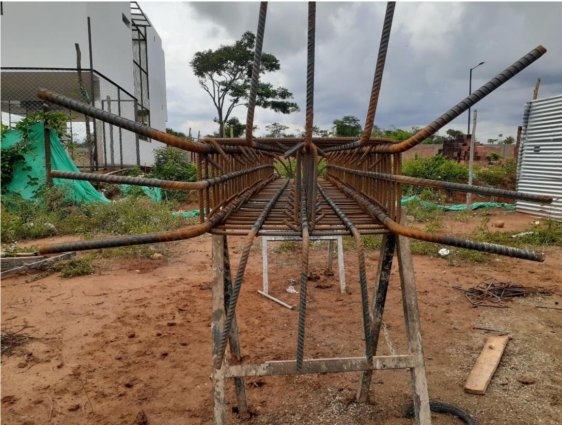
Figura 18. Detalle del refuerzo interno.
