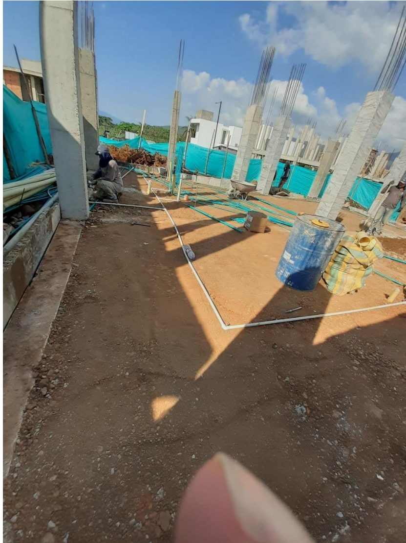
Figura 32. Columnas desencofradas – primer piso.
