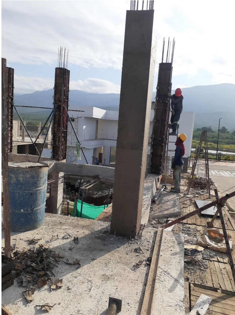
Figura 35. Desencofrado de columnas – segundo piso.
