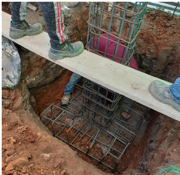
Figura 20. Evidencia fotográfica de la instalación de pedestal con la zapata.
