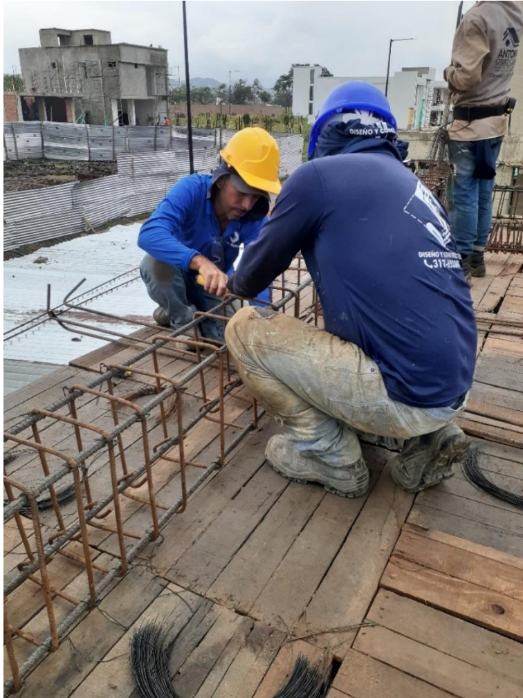
Figura 38. Armado de vigas de entrepiso.
