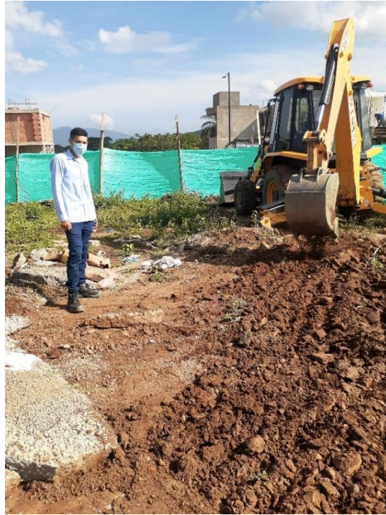
Figura 4. Descapote, nivelación y terraceo.
