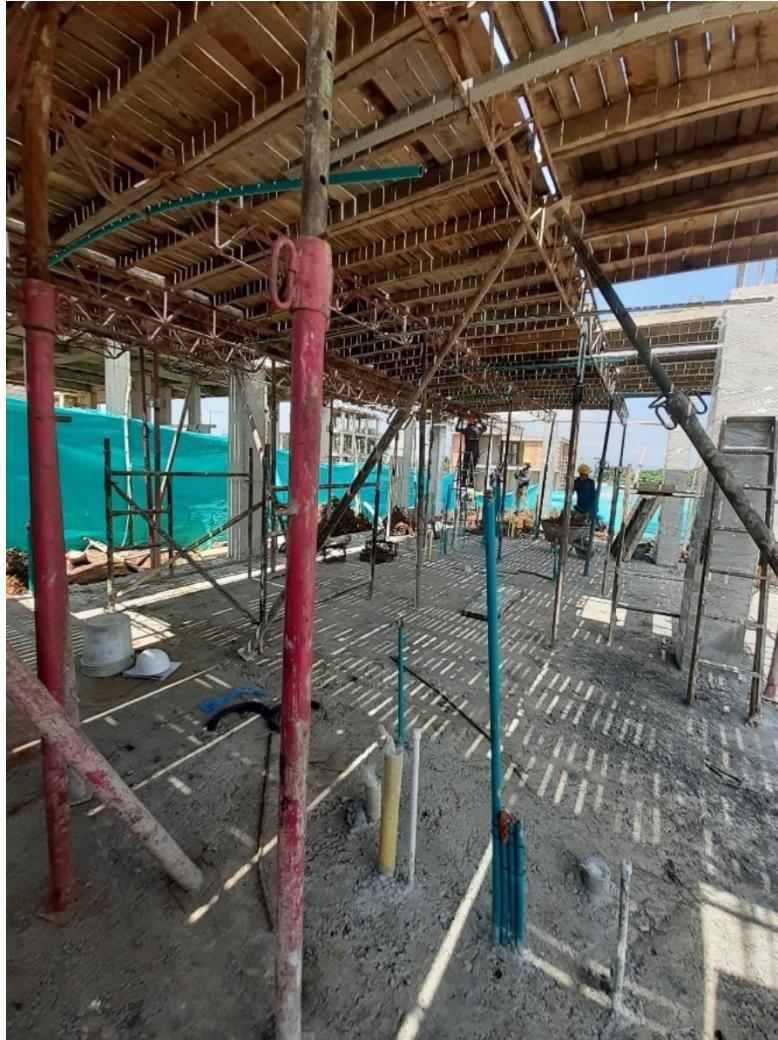
Figura 36. Armado de tarima para placa de entrepiso.
