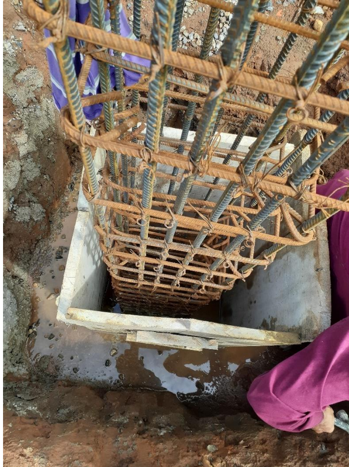
Figura 23. Encofrado de pedestal con formaleta de madera.
