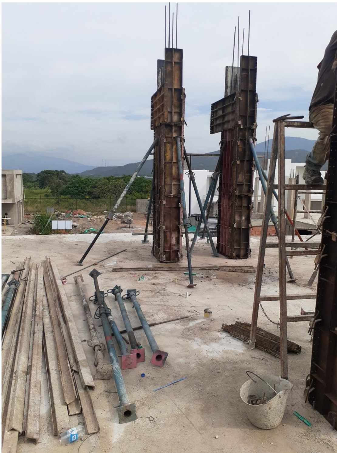
Figura 33. Encoframiento de columnas – segundo piso.
