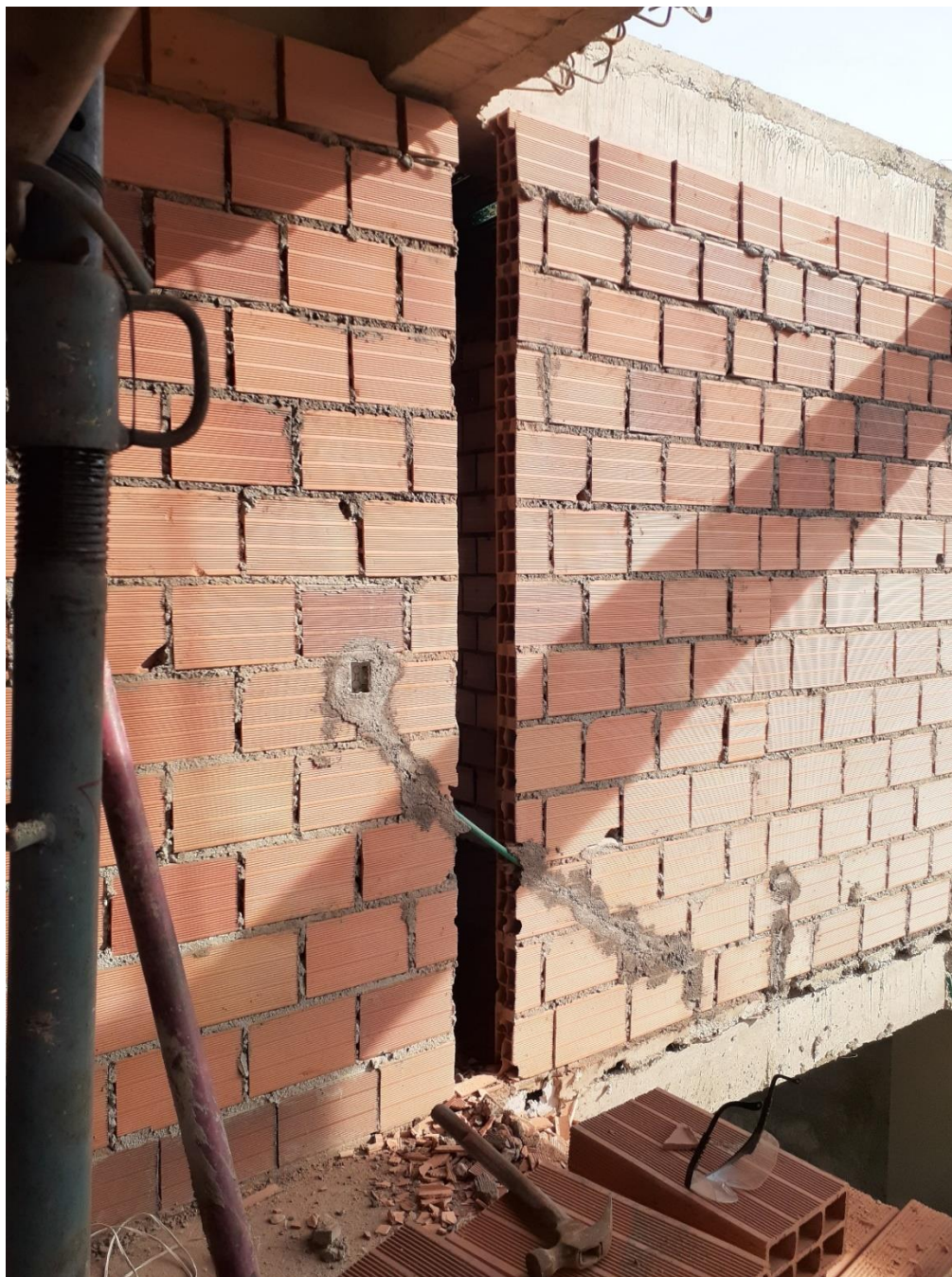
Figura 49. Evidencia fotografía de mampostería.
