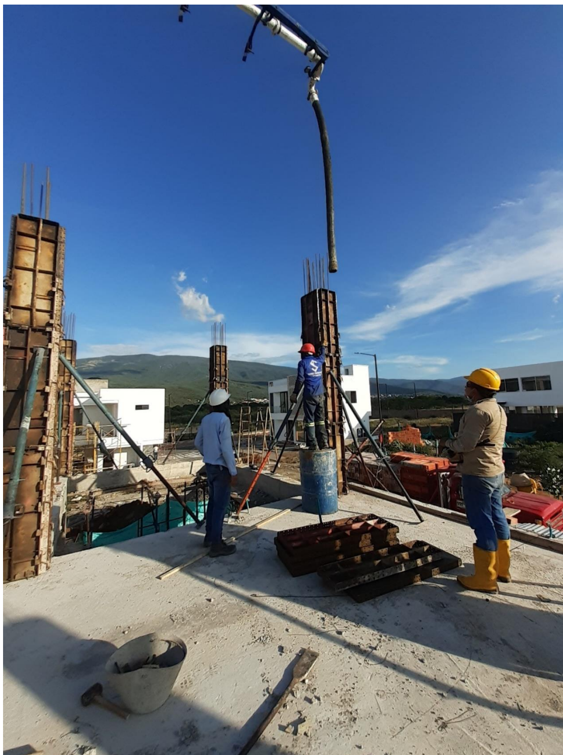
Figura 34. Vaciado de concreto – columnas de 2 piso.
