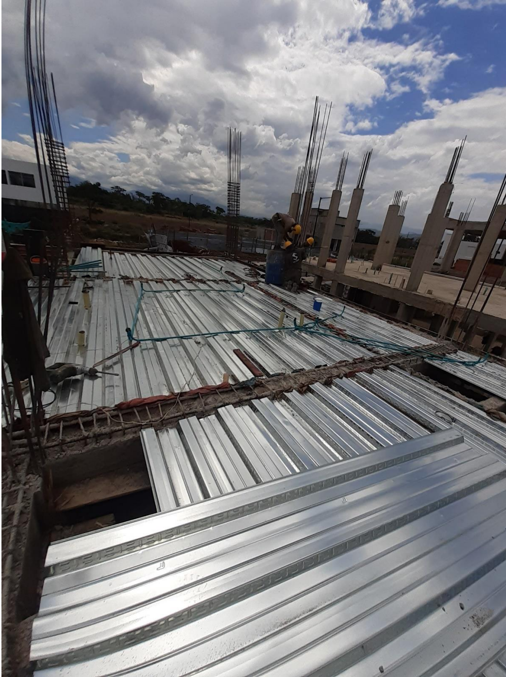
Figura 44. Instalacion de Metaldeck.
