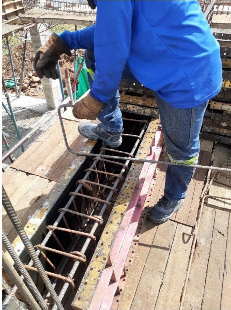
Figura 39. Encofrado de vigas de entrepiso.
