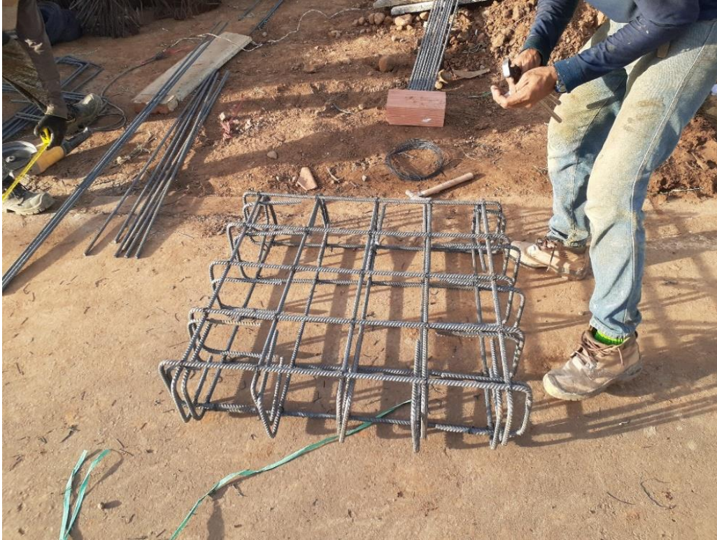
Figura 16. Inspección y evaluación del acero.
