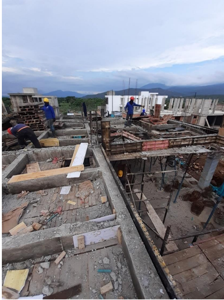
Figura 40. Desencofrado de vigas de entrepiso.
