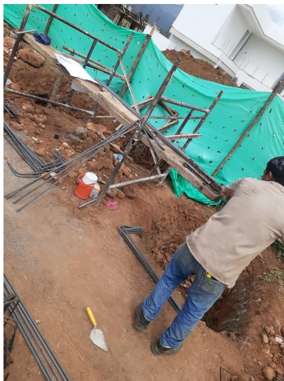
Figura 15. Inspección y evaluación del acero.
