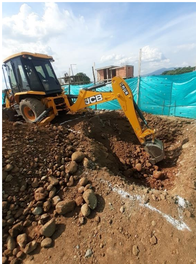
Figura 6. Excavación de zapatas – piscina.
