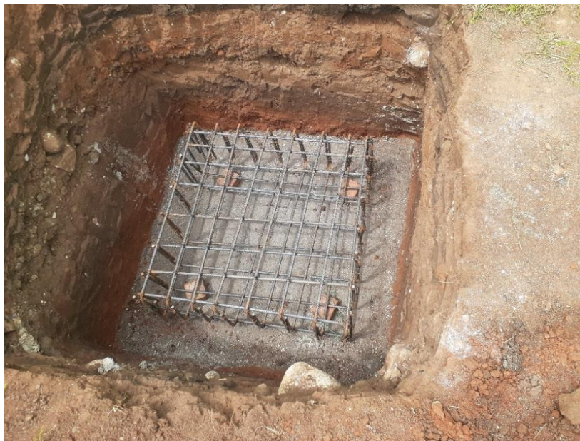
Figura 17. Instalación de canastas de acero para zapatas.
