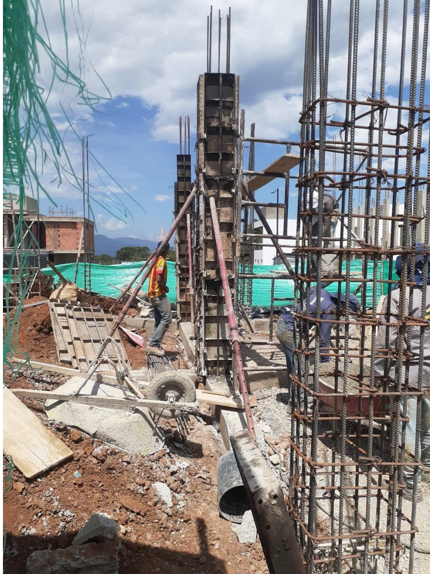
Figura 31. Evidencia fotografía, encofrado de columnas, primer piso.
