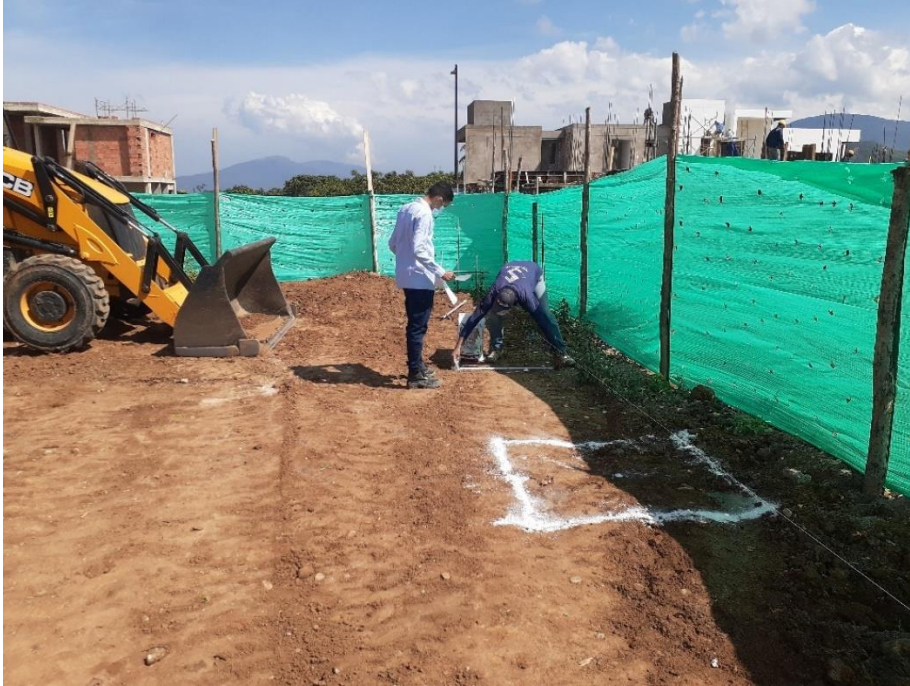
Figura 5. Localización y trazado de zapatas.
