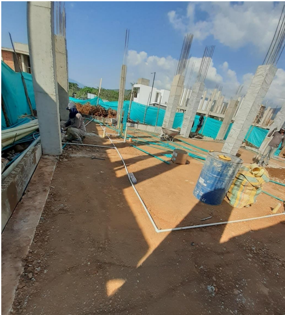
Figura 42. Placa de cimentación en terminación de detalles para vaciado de concreto.
