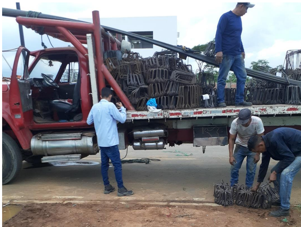
Figura 14. Inspección y evaluación del acero.
