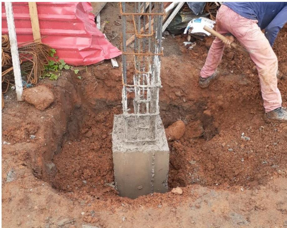
Figura 25. Pedestal terminado y en fase de rellenos.
