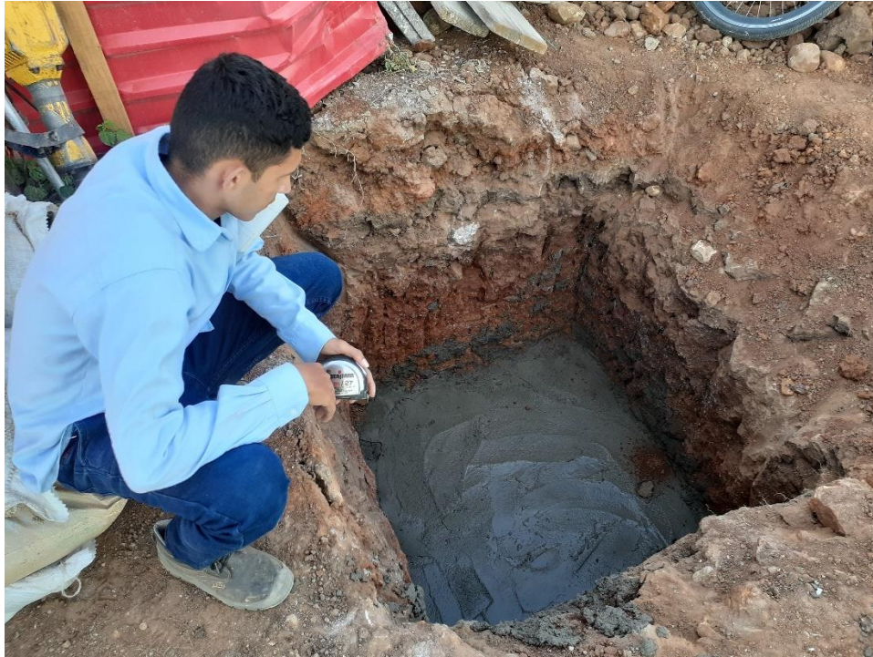
Figura 9. Vaciado de solado en zapata aislada.
