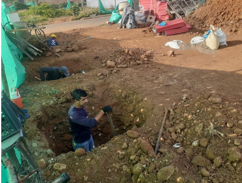
Figura 7. Detalles en las paredes laterales y fondo de excavación.
