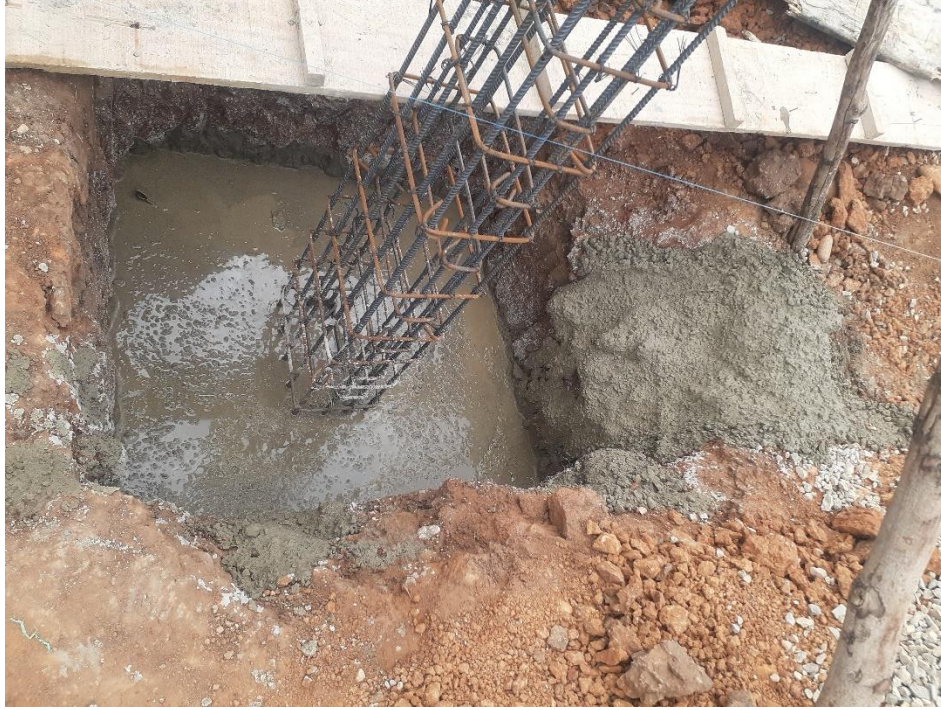
Figura 22. Vaciado de concreto en zapata aislada.
