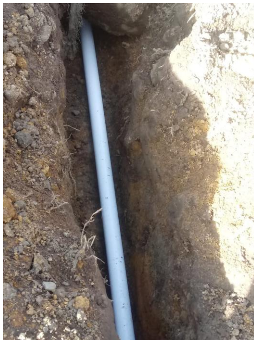
Figura 14. Instalación Tubería en PVC de 2" para Red de Acueducto
