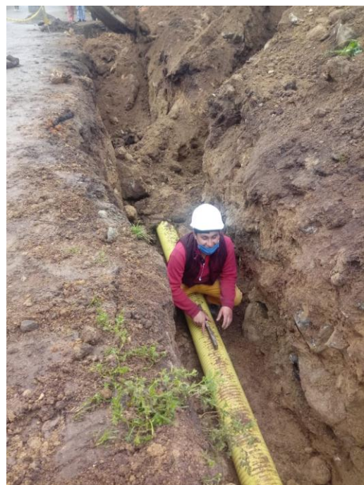
Figura 5. Tubería de 8" Lista para su Instalación
