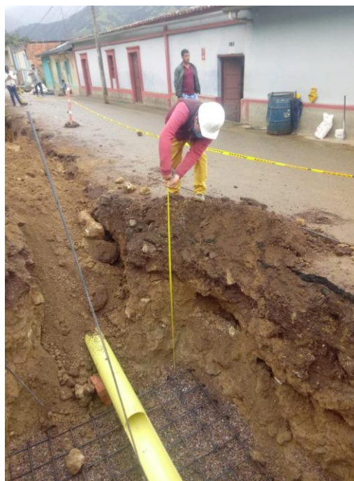
Figura 8. Actividades Inicio Construcción Pozo de 4 Inspección
