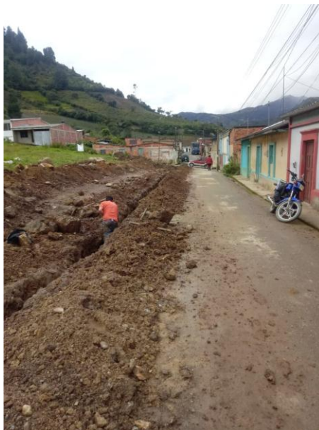
Figura 4. Excavación para la Red de Acueducto
