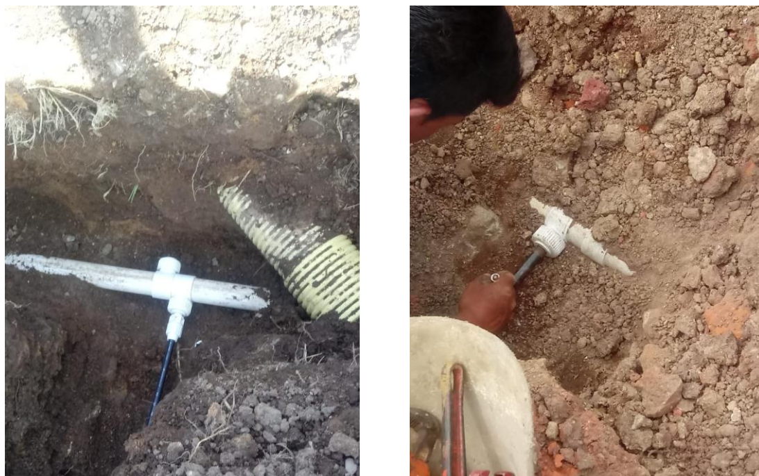
Figura 15. Instalación de Domiciliarias Red de Acueducto
