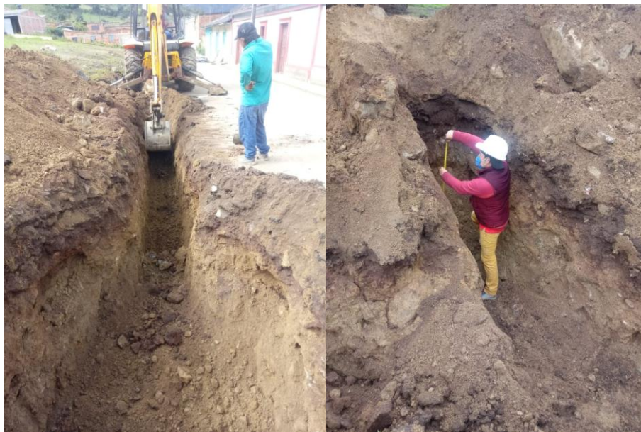
Figura 3. Excavación para la Red de Alcantarillado
