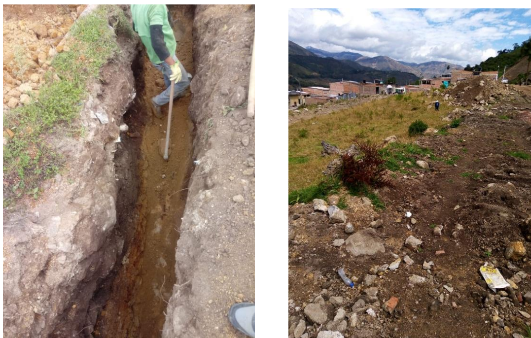
Figura 12. Relleno de las Excavaciones
