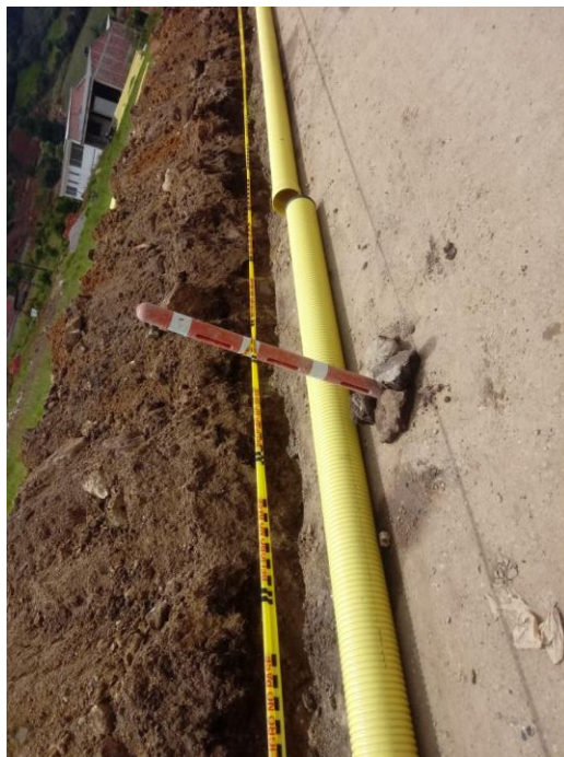
Figura 5. Tubería de 8" Lista para su Instalación
