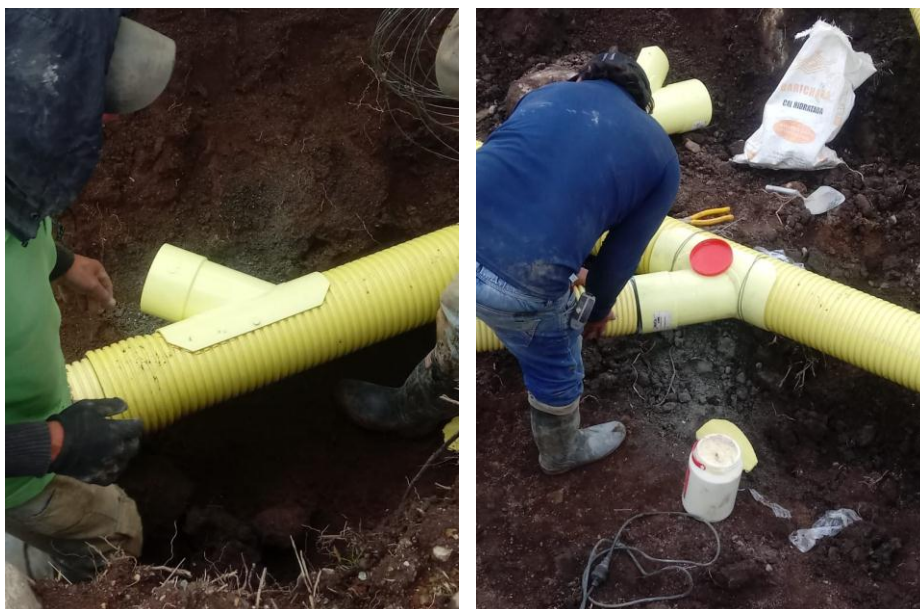
Figura 11. Conexiones Domiciliarias Sanitarias en Tubería PVC de 6"
