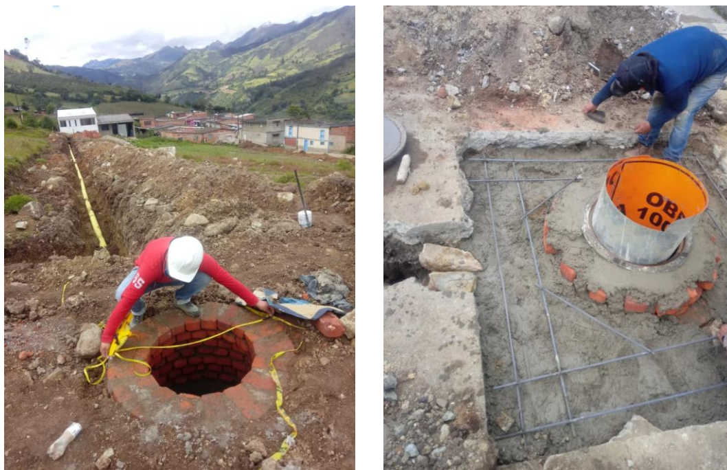
Figura 10. Enrasado de Pozo de Inspección
