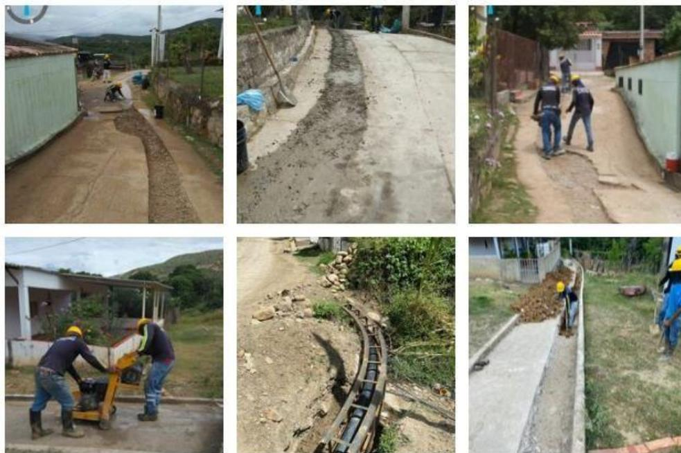
En las imágenes se puede evidenciar la excavación de las zanjas, colocación de tubería, compactación para la colocación de tubería, relleno de la zanja luego de la colocación de la tubería y construcción de una armadura de hierro para un paso elevado de un tramo de la tubería por una alcantarilla de desagüe fluvial.
