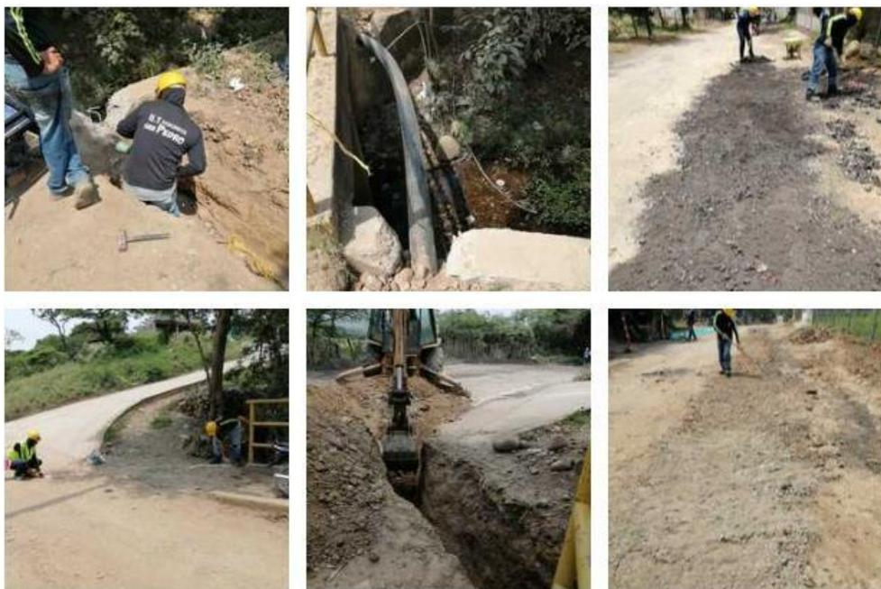
En las imágenes se puede evidenciar la excavación de las zanjas, colocación de tubería, relleno de la zanja luego de la colocación de la tubería.
