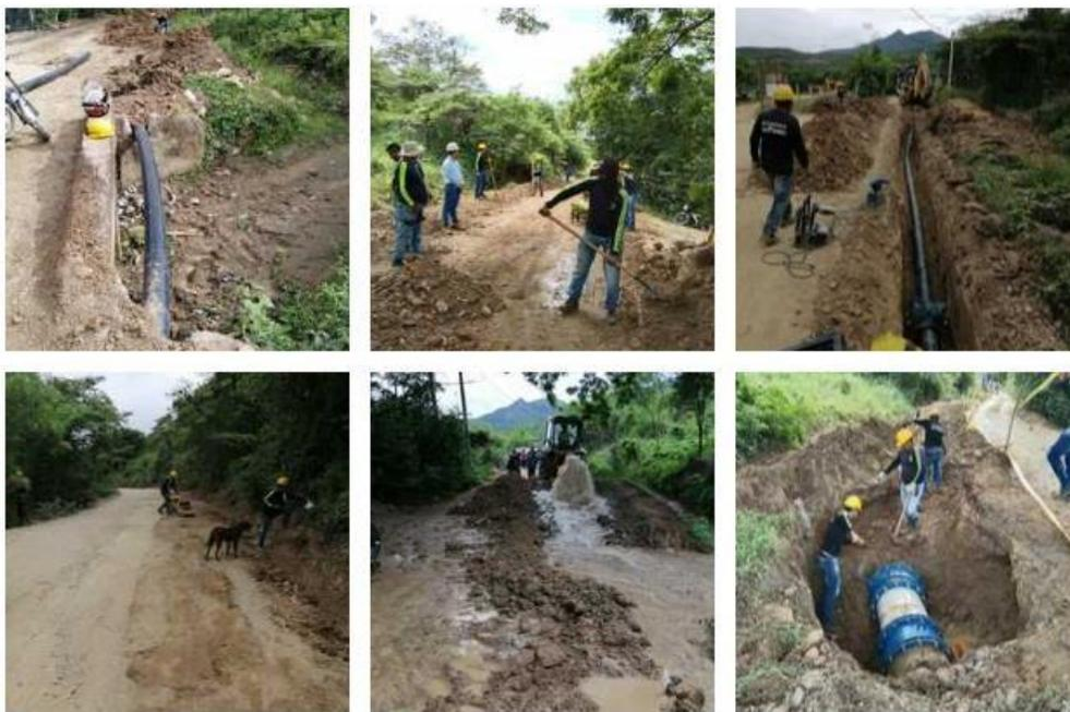
En las imágenes se puede evidenciar la excavación de las zanjas, colocación de tubería, compactación para la colocación de tubería, relleno de la zanja luego de la colocación de la tubería y reparación de tubería de 30".
