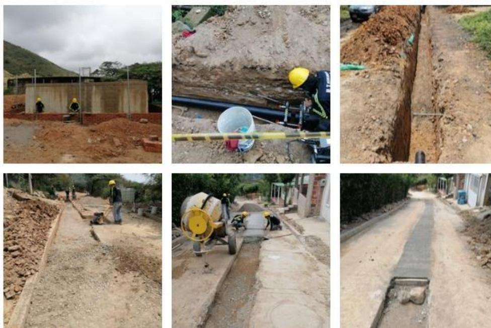
En las imágenes se puede evidenciar la unión de tubería por termo fusión, excavación de zanja, relleno y construcción de sección de pavimento rígido a intervenir.
