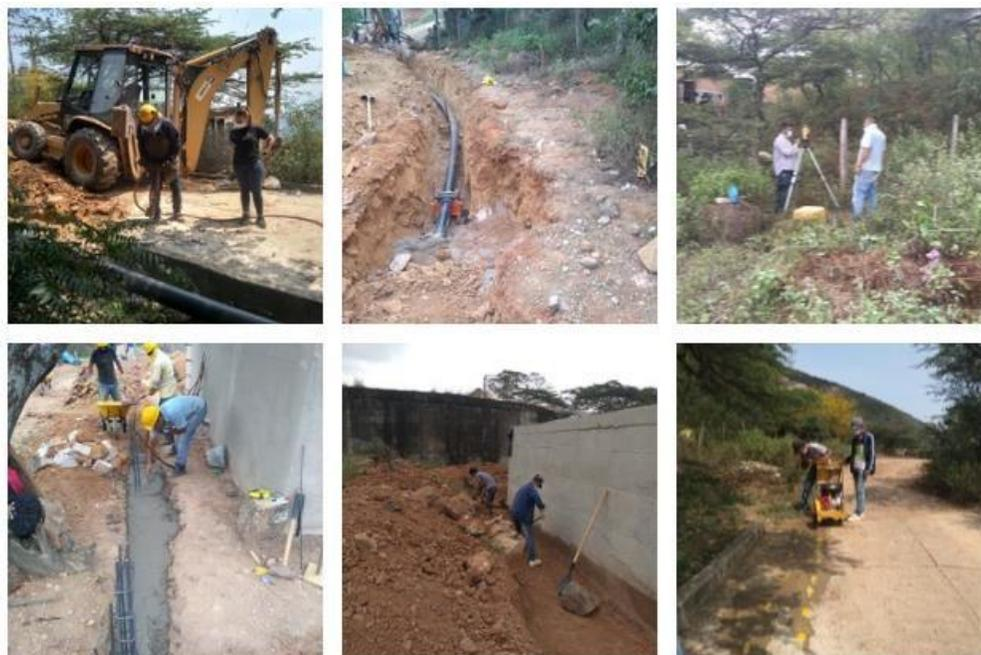
En las imágenes se logra evidenciar unión de tubería por termo fusión, demolición de pavimento rígido, fundición de vigas de arrastre y topografía.
