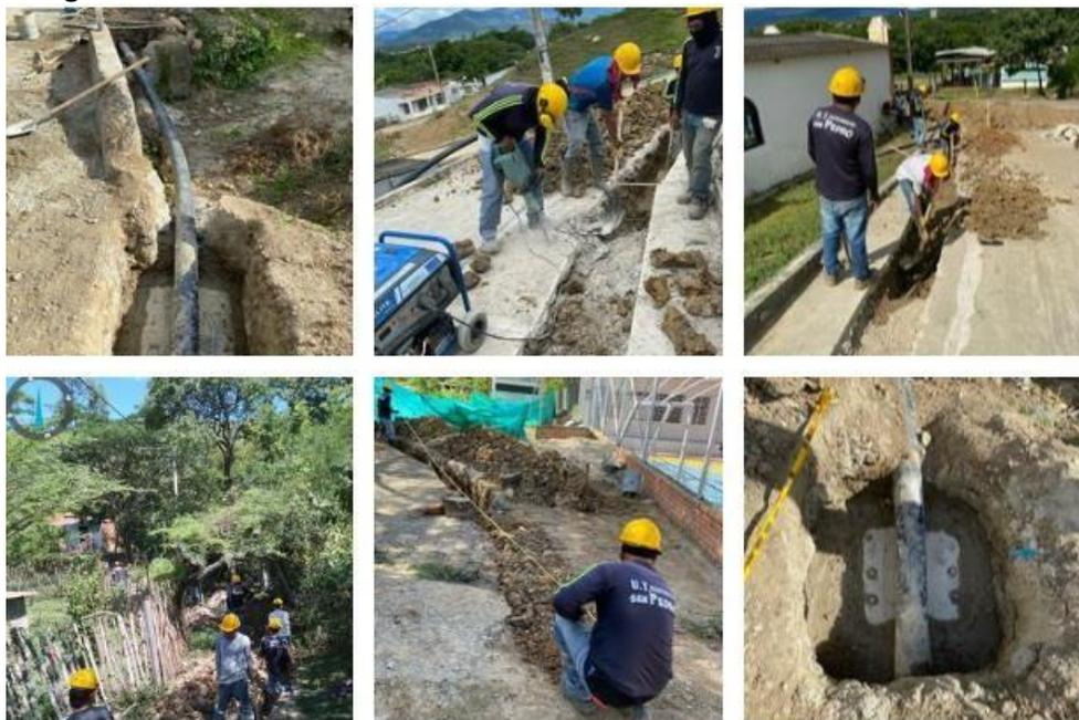
En las imágenes se puede evidenciar la excavación de las zanjas, colocación de tubería, compactación para la colocación de tubería y relleno de la zanja luego de la colocación de la tubería.
