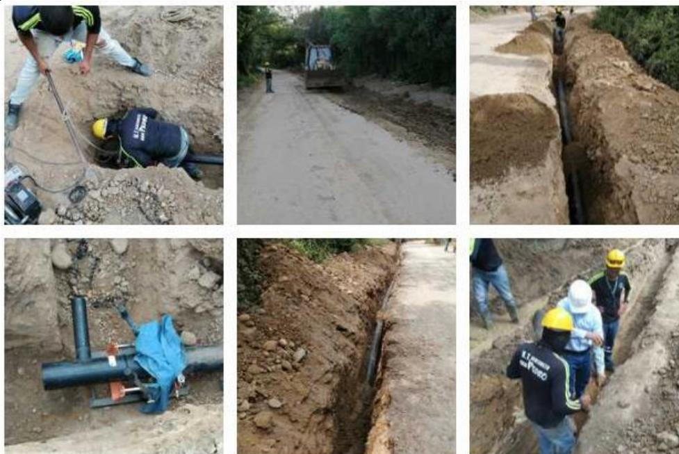
En las imágenes se puede evidenciar la excavación de las zanjas, colocación de tubería, medición de las especificaciones técnicas (profundidad) y relleno de la zanja luego de la colocación de la tubería.
