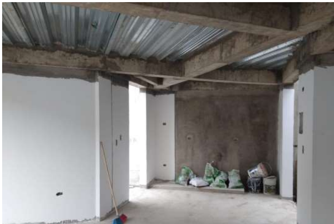
Figura 23. Aplicación pintura – primer piso.
