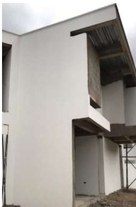
Figura 21. Aplicación pintura–fachada.
