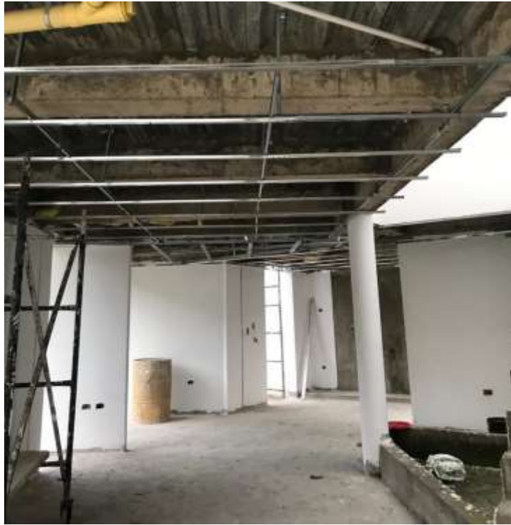
Figura 25. Instalación estructura Drywall.
