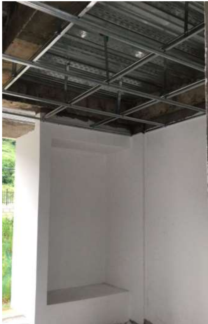
Figura 24. Instalación estructura Drywall.
