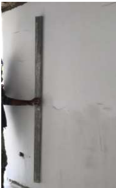
Figura 16. Revisión de muros codaleados y nivelados correctamente.
