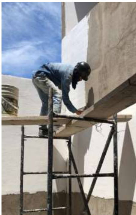
Figura 14. Aplicación de pasta exterior.
