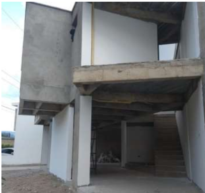
Figura 18. Aplicación de pasta exterior – fachada.
