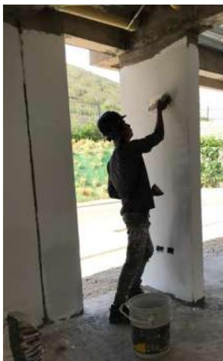
Figura 15. Aplicación de pasta interior.
