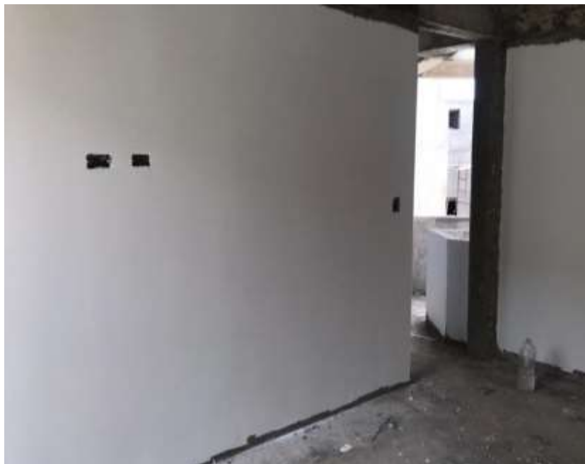
Figura 22. Aplicación pintura - alcoba.
