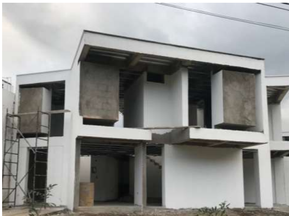
Figura 19. Aplicación de pasta exterior – fachada.
