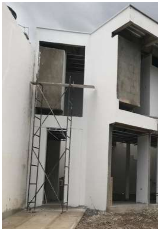
Figura 20. Aplicación Pintura – fachada.
