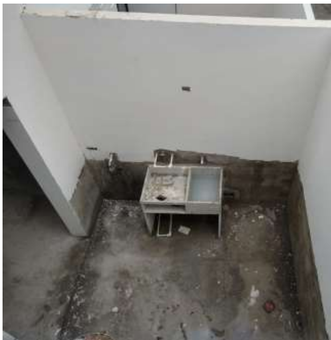
Figura 17. Aplicación de pasta – zona patio.
