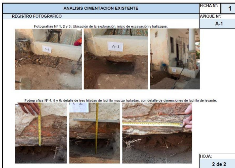
Figura 30. Análisis de cimentación existente 1
