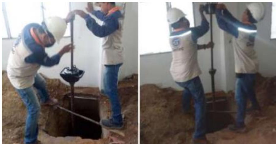
Figura 37. Exploración suelo de cimentación – interfaz suelo-estructura
