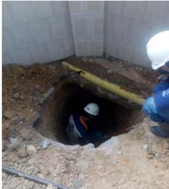
Figura 38. Apique de cimentación esquinera
