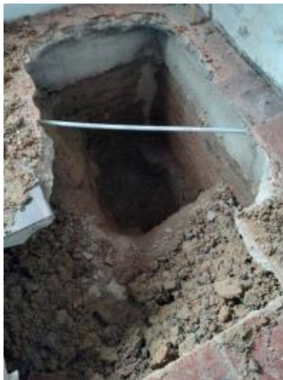
Figura 42. Muros de sobre cimiento en ladrillo doble-contención material
