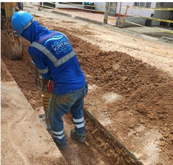
Figura 22. Compactación de material común
