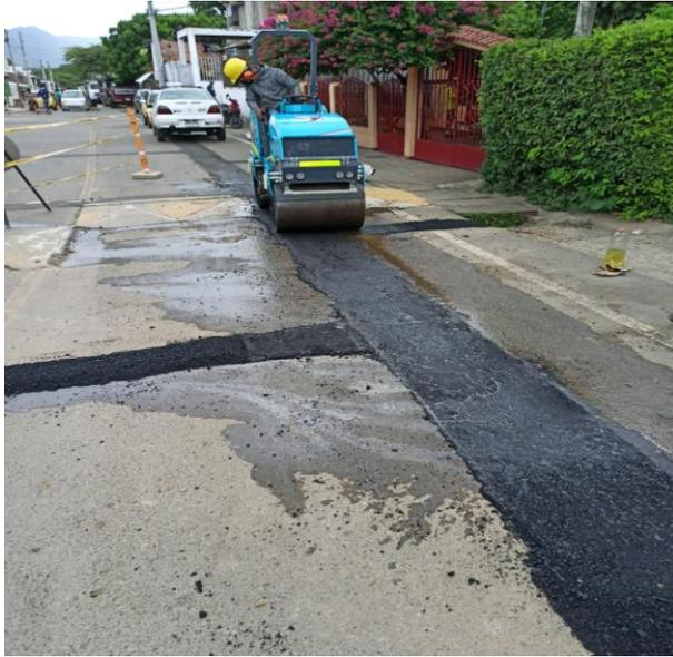
Figura 32. Sellamiento de mezcla asfáltica
