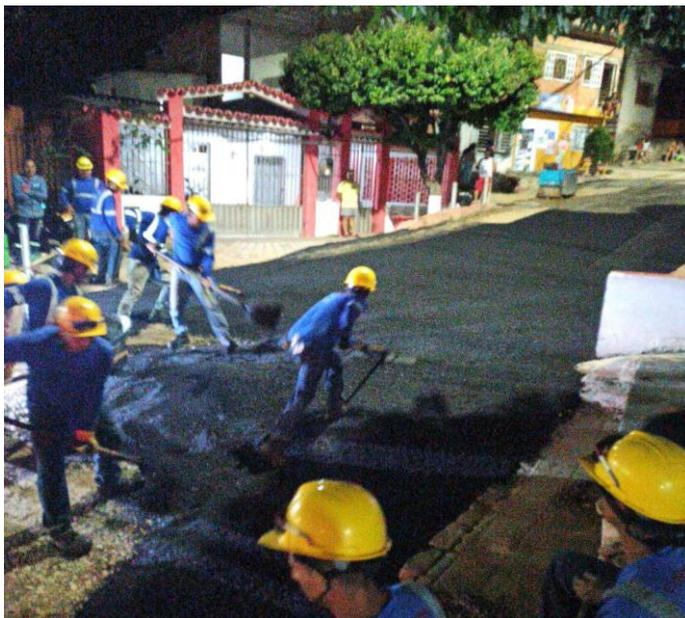
Figura 31. Extendida de asfalto
