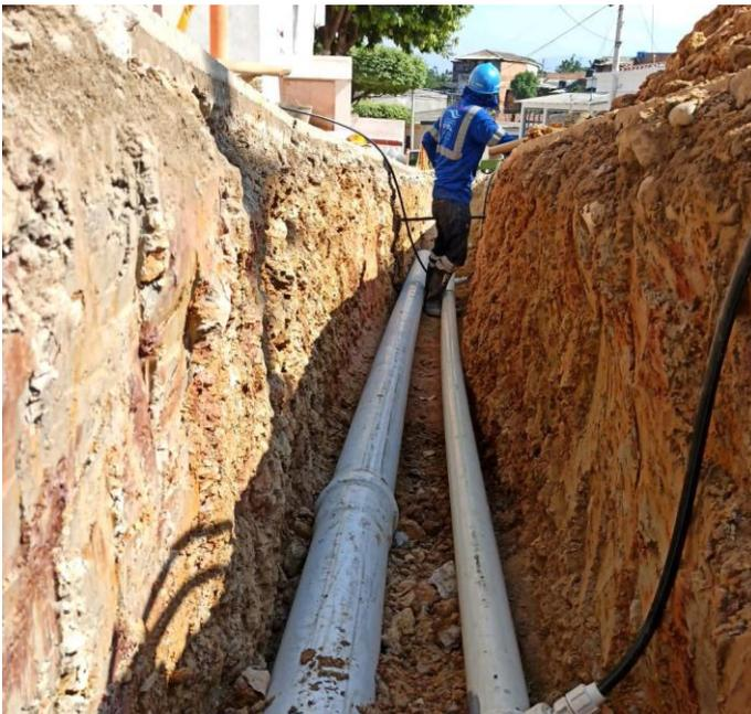
Figura 17. **Instalación de collarines**
