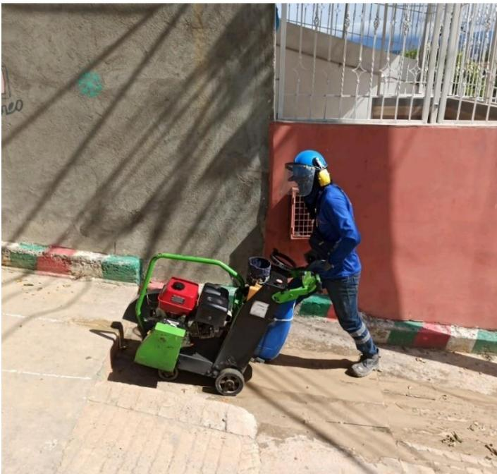
Figura 6. Corte de pavimento
