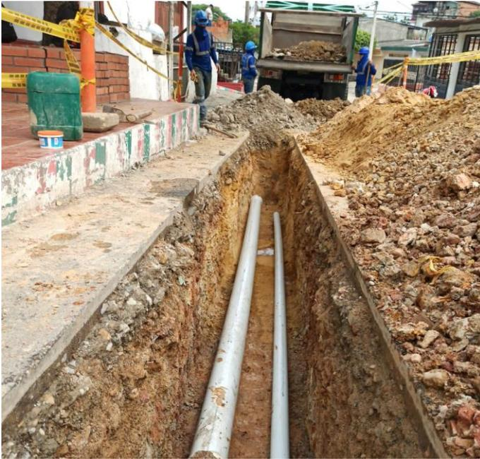
Figura 16. **Instalación tubería de 3'' y 6''**
