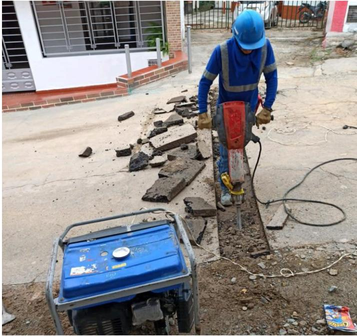
Figura 12. Demolición capa de asfalto
