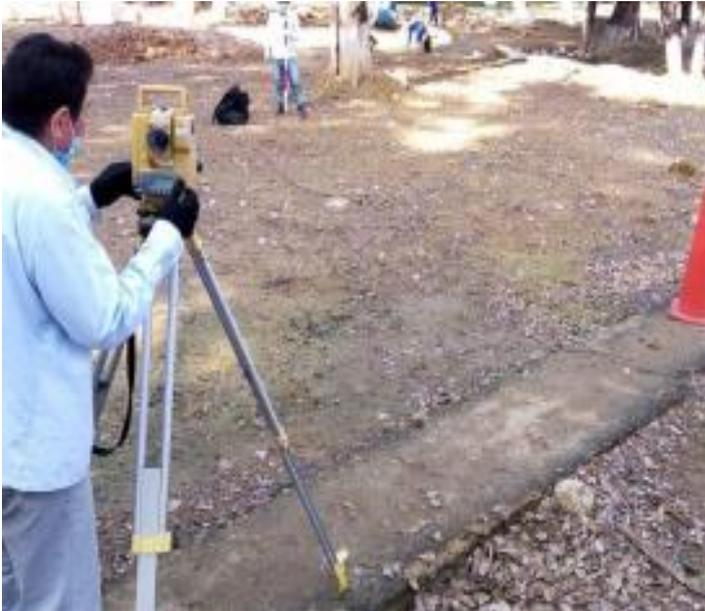
Figura 7. Verificación topográfica para abscisado
