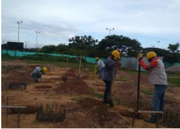
Imagen 9: Excavación manual
