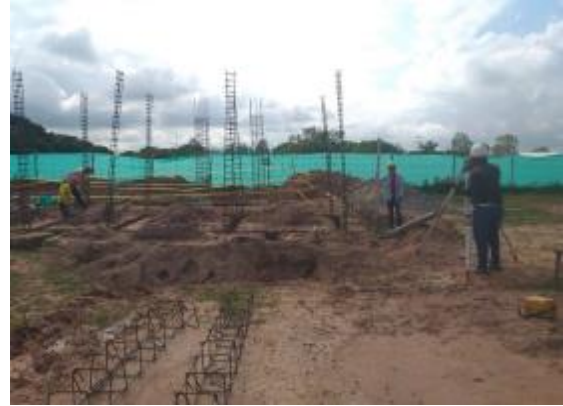
Imagen 21: Acero de refuerzo
