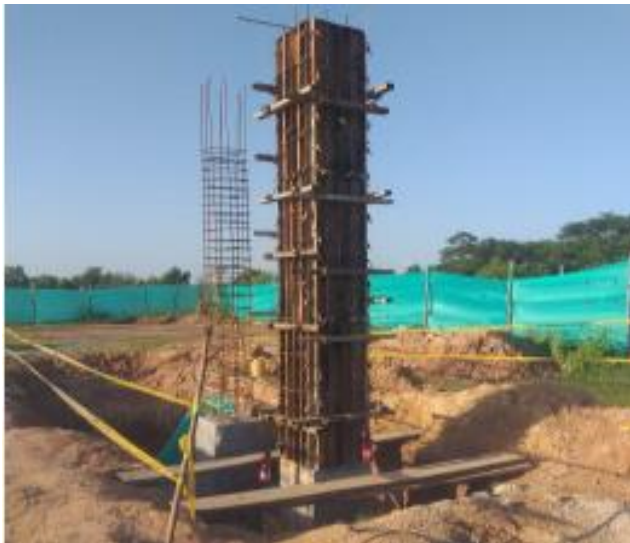
Imagen 18: Concreto para columnas
