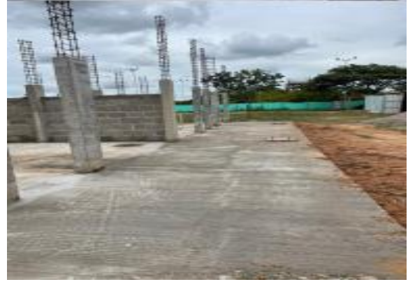
Imagen 16: Losa de cimentación
