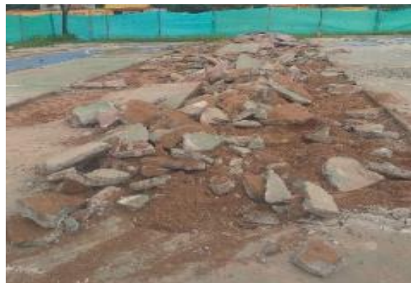
Imagen 5: Demolición de pisos
