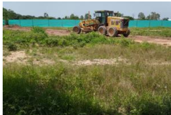
Imagen 7: Descapote a maquina
