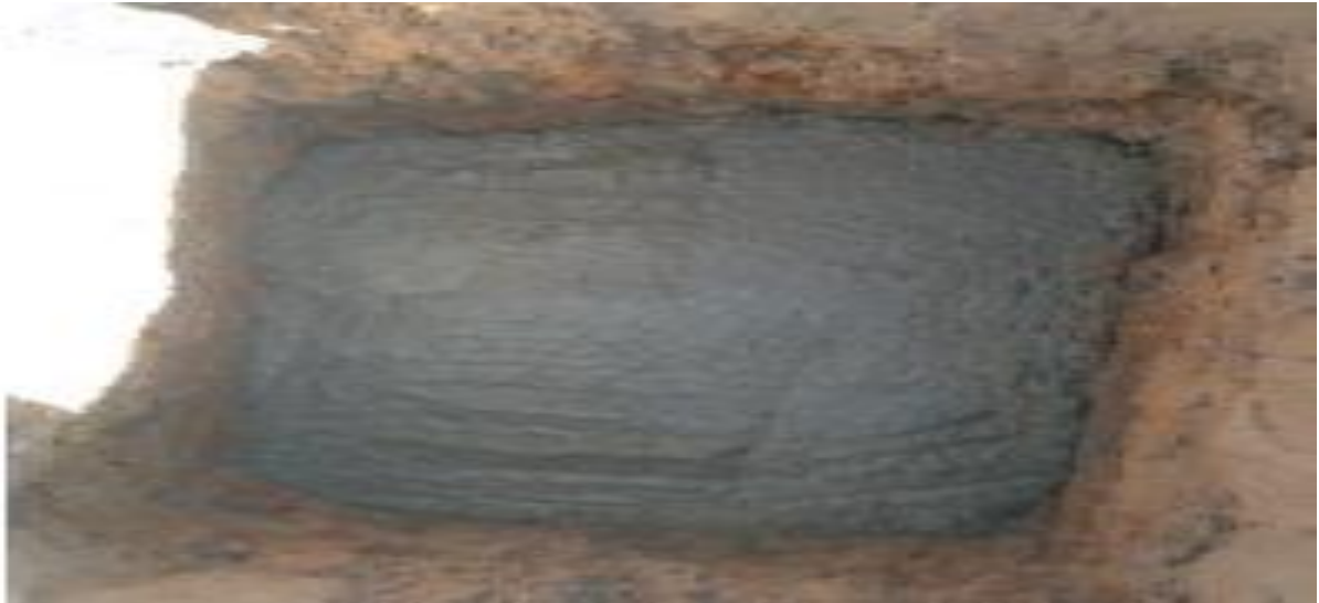
Imagen 17: Solado concreto
