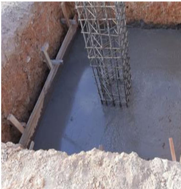
Imagen 13: Zapatas en concreto
