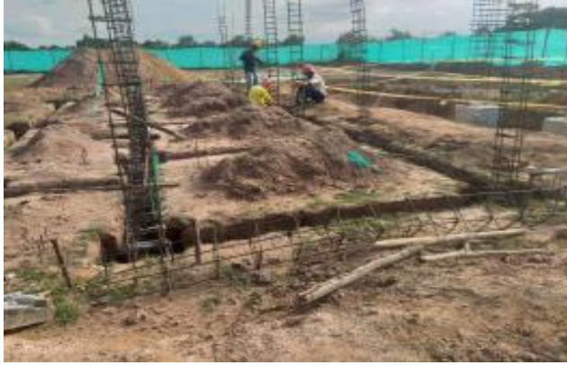
Imagen 20: Acero de refuerzo
