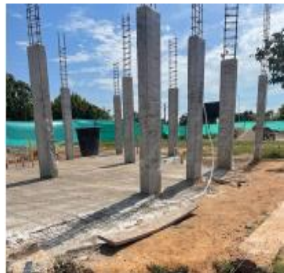
Imagen 19: Concreto para columnas
