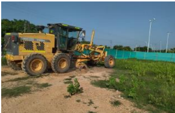
Imagen 6: Descapote a máquina
