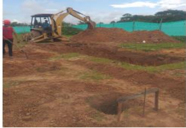
Imagen 10: Excavación mecánica y manual
