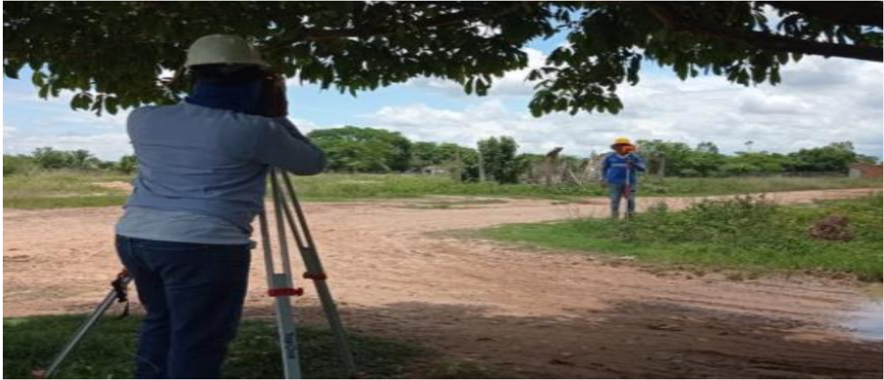
Imagen 3: Trazado y replanteo topográfico
