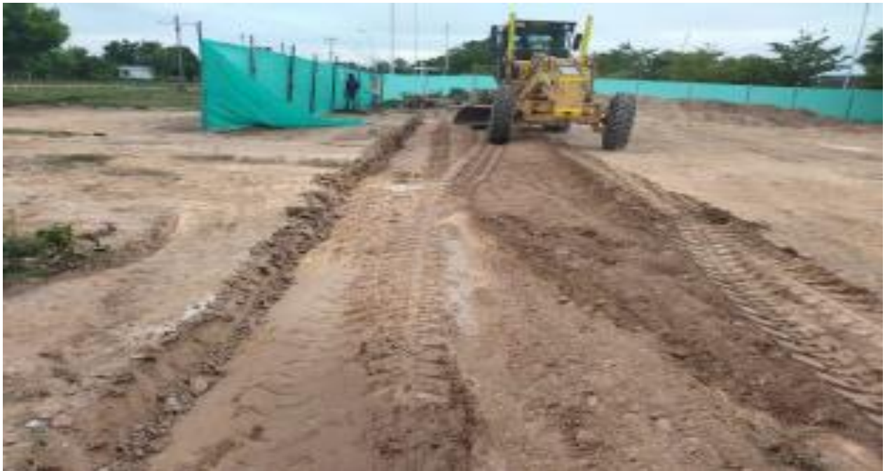
Imagen 8: Excavación a máquina para nivelación
