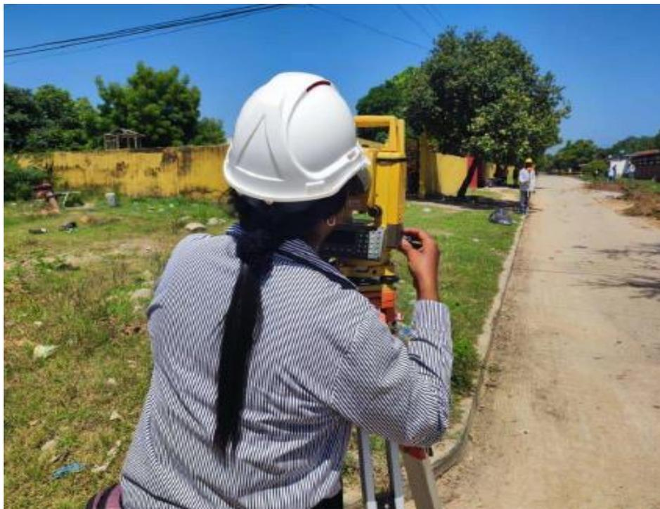
**Imagen 7.** Localización, trazado y replanteo topográfico tramo 30
