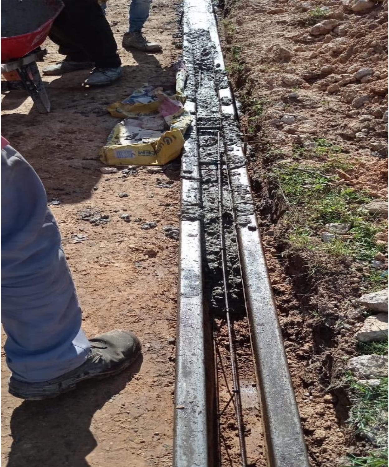
**Imagen 15.** Fundida de bordillos en concreto rígido de 3000 psi
