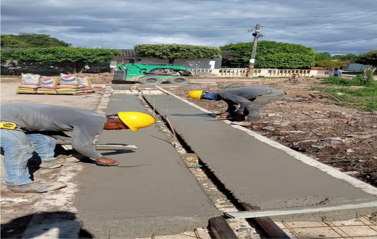
**Imagen 18.** Losa anden concreto de 3000 psi h=10 cm tramo 15
