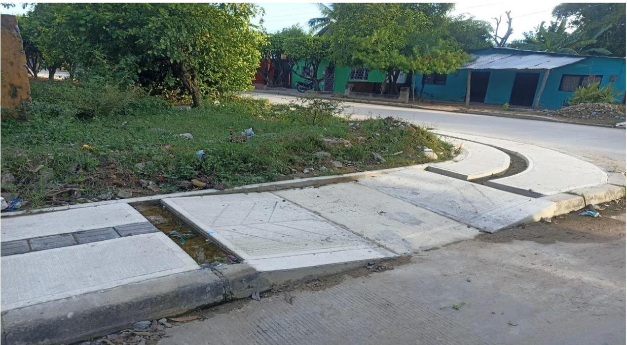
**Imagen 19.** Losa anden concreto de 3000 psi h=10 cm tramo 17
