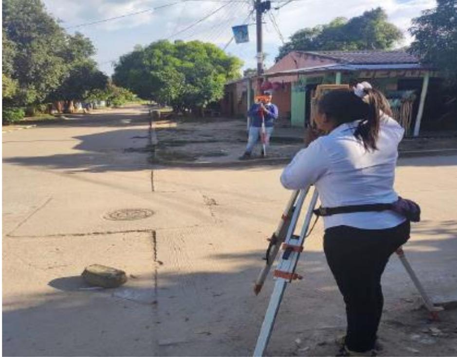
**Imagen 6.** Localización, trazado y replanteo topográfico tramo 9
