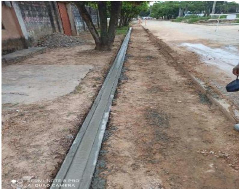
**Imagen 17.** Fundida de bordillos sección 0.30 x 0.10 m. psi en tramo 54
