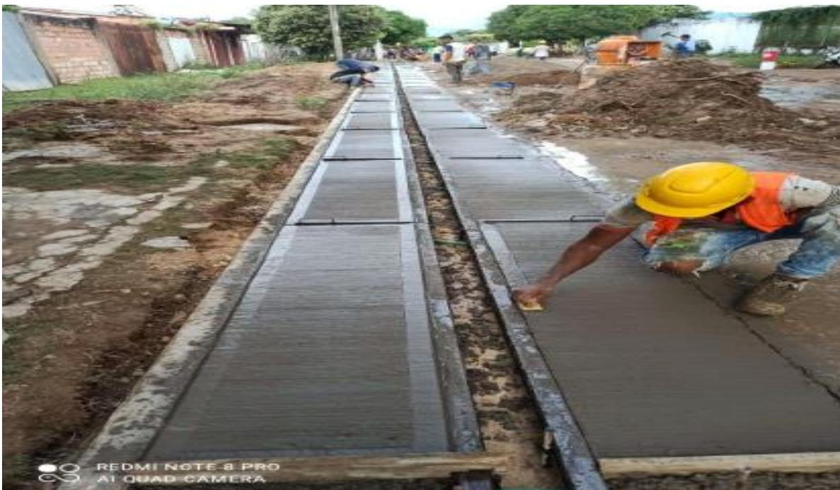
**Imagen 21.** Losa anden concreto de 3000 psi h=10 cm tramo 21
