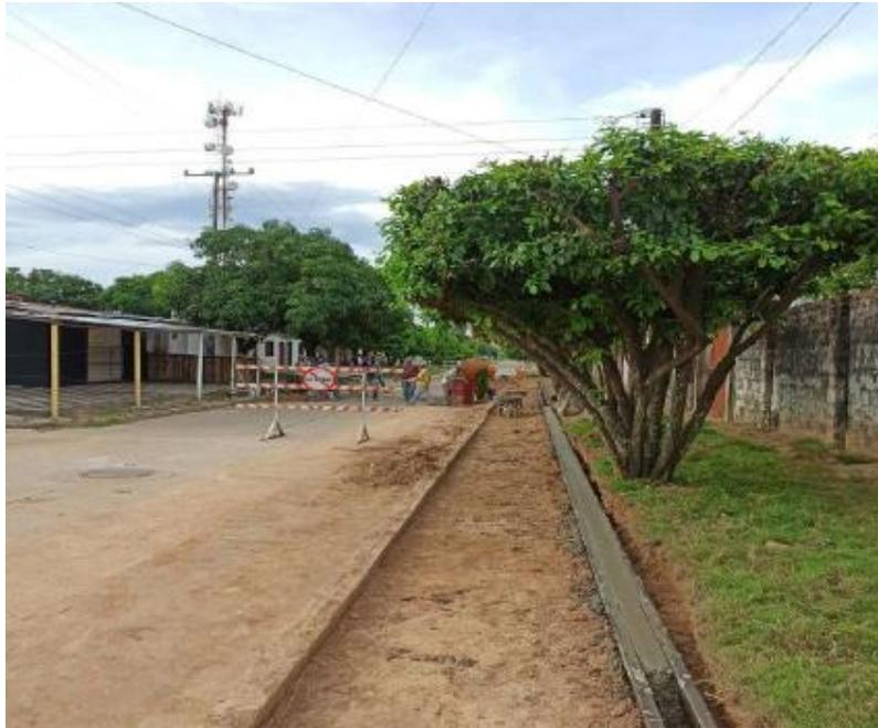
**Imagen 16.** Fundida de bordillos sección 0.30 x 0.10 m. en tramo 57
