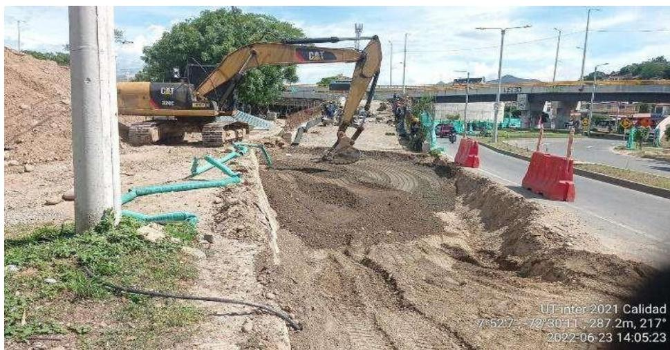
**Figura 33. Extendido de subbase**
