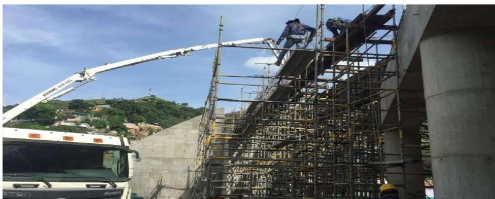
**Figura 58. Fundida de viga longitudinal N°1.**
