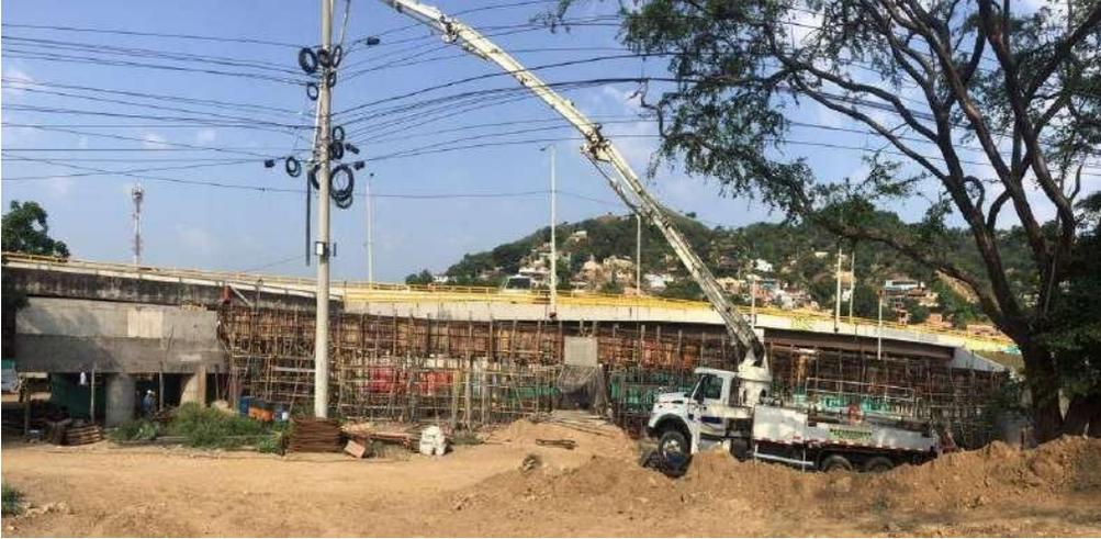
**Figura 16. Fundida de concreto de viga longitudinal.**
