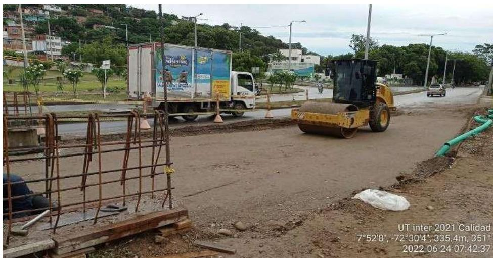
**Figura 35. Paso del vibro, listo para toma de densidades.**
