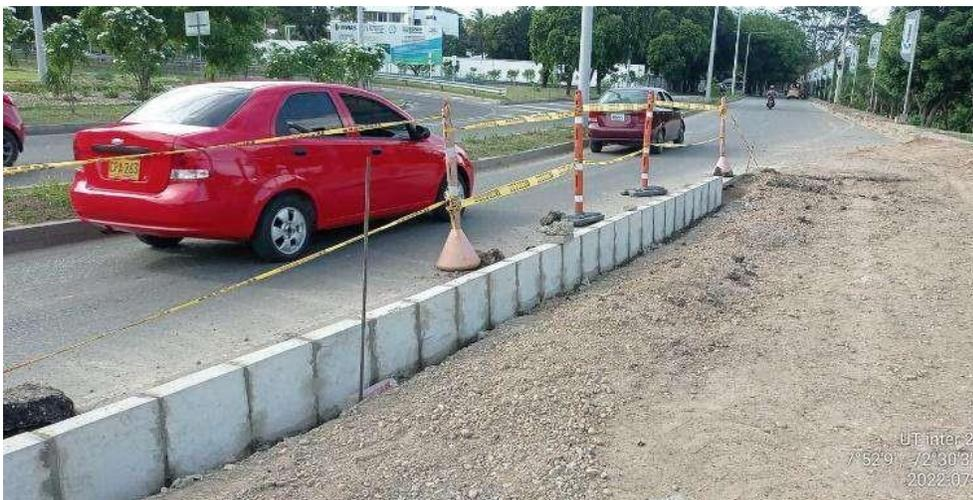
**Figura 45. Instalación de bordillo prefabricado**
