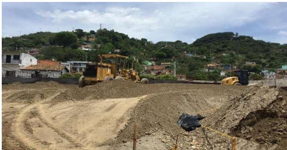
**Figura 66. Extendido de capas de subbase del terraplén**
