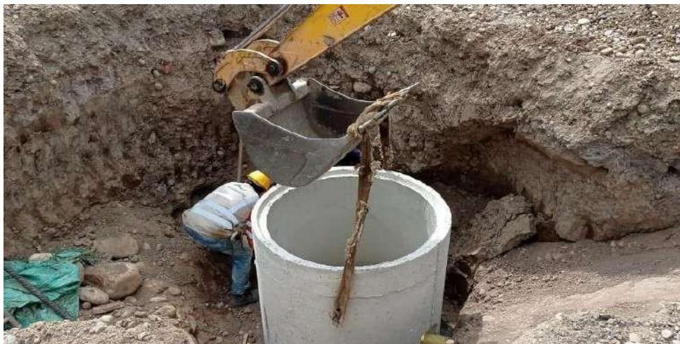
**Figura 72. Instalación de pozo – Ramal 11**
