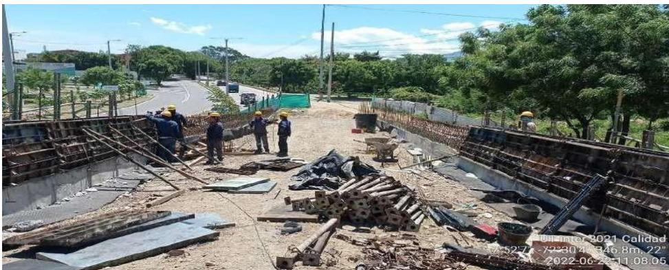
**Figura 30. Encofrando New Jersey del terraplén.**
