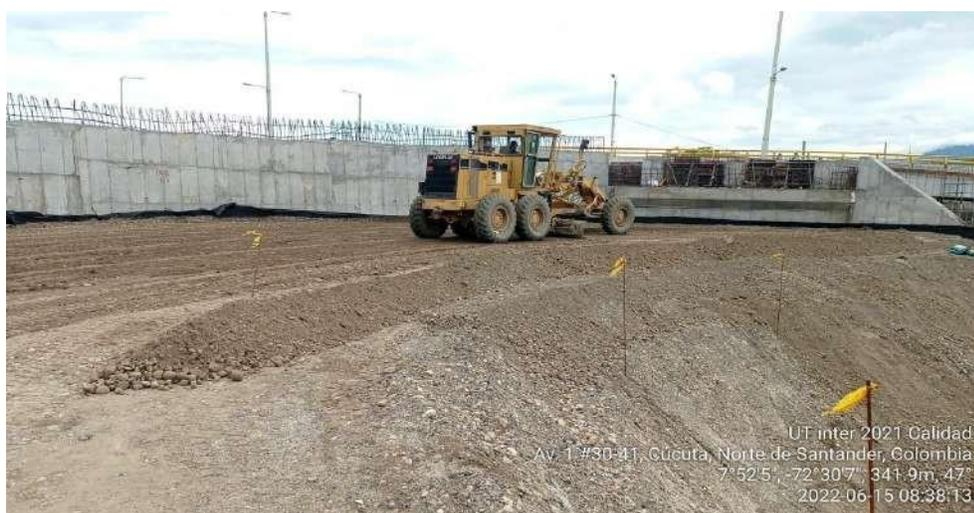
**Figura 65. Extendiendo subbase en las últimas capas en tierra armada**
