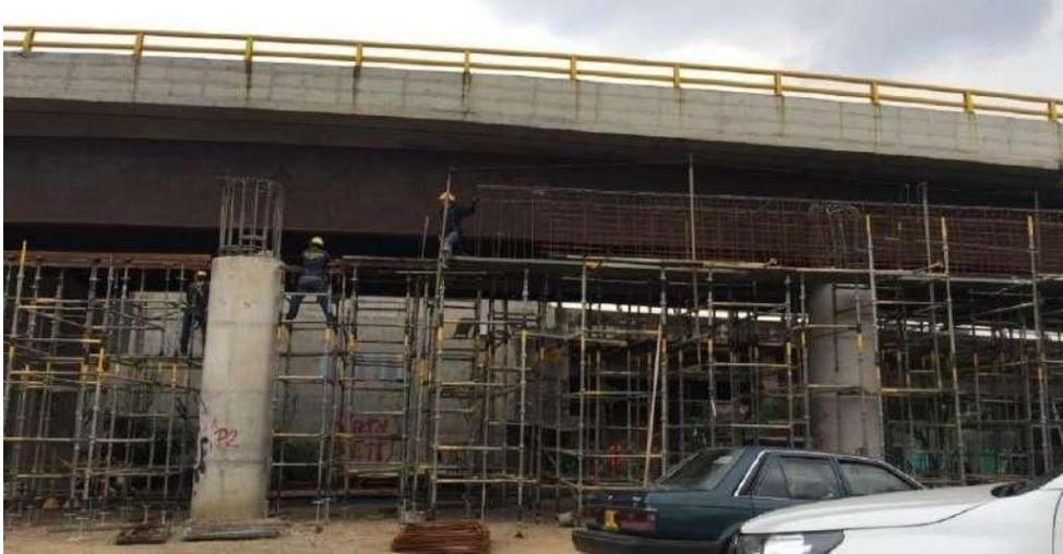
**Figura 55. Amado de viga cabezal**
