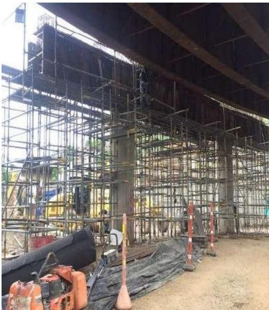
**Figura 56. Encofrado de viga cabezal**
