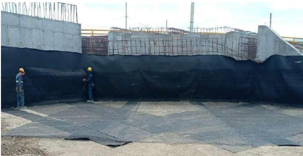
**Figura 63. Instalación de lloraderos y geomalla**
