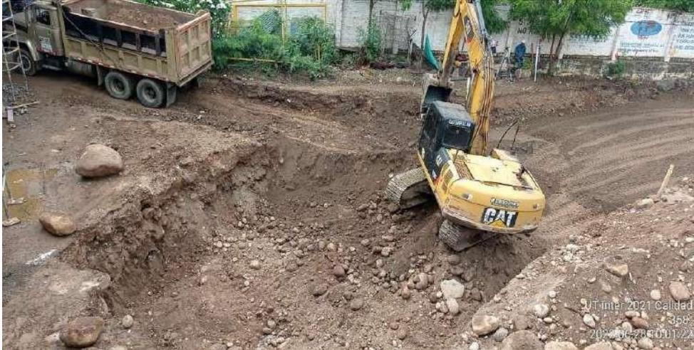
**Figura 68. Excavación de caja**
