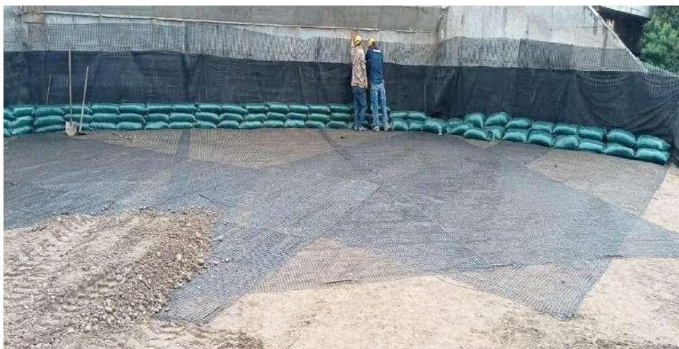
**Figura 64. Capa de 3 costales combinados con suelo cemento.**
