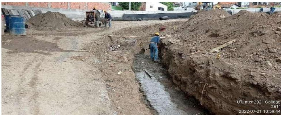
**Figura 84. Solado para el diente del muro derecho.**
