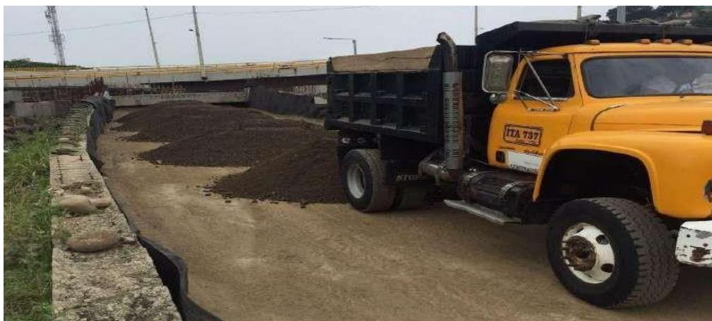
**Figura 24. Material de subbase para terraplén - Ramal 14.**
