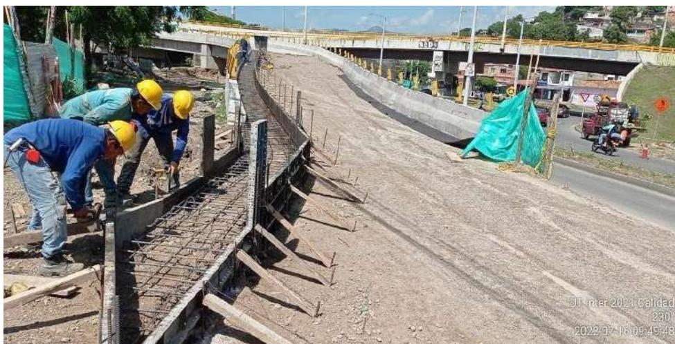
**Figura 36. Armado de parrilla de acero y encofrado de andén**
