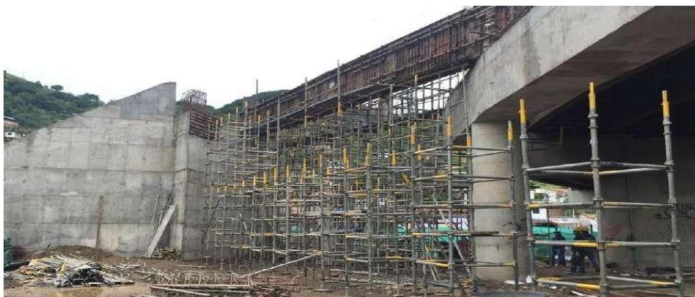
**Figura 57. Encofrado viga longitudinal N°2.**
