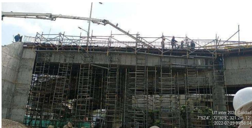
**Figura 78. Fundida de concreto acelerado de la placa.**
