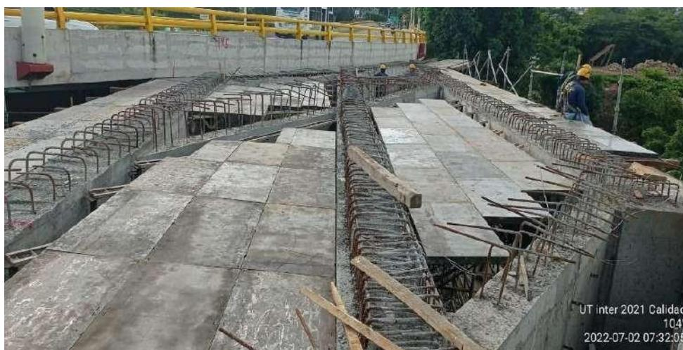
**Figura 75. Instalación de tableros para placa**
