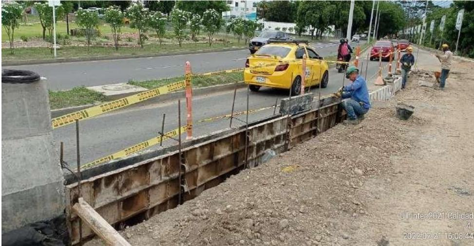
**Figura 44. Encofrado y fundida del bordillo**
