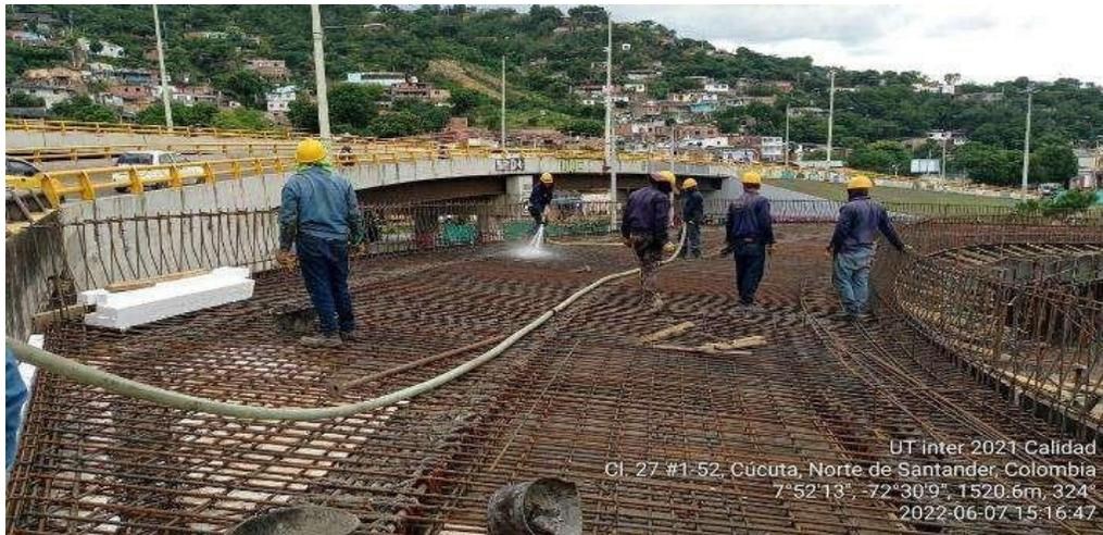
**Figura 20. Terminado de acero y limpieza de armadura.**
