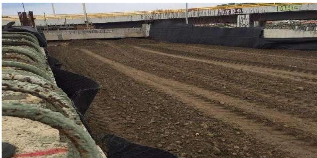
**Figura 25. Extendido de material de subbase mediante motoniveladora**
