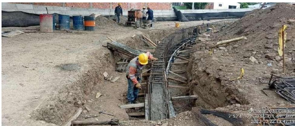
**Figura 86. Fundido con concreto en obra el diente del muro derecho.**
