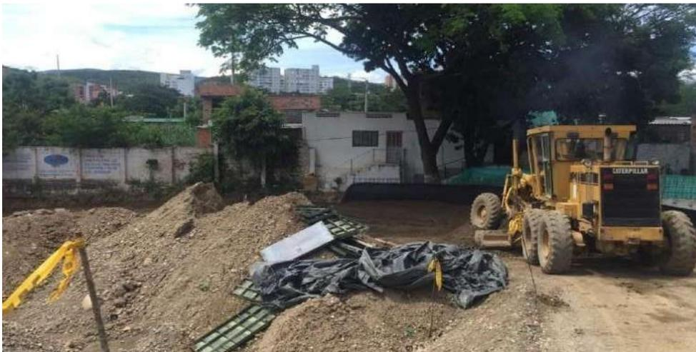
**Figura 69. Extendido de subbase después de excavación de la caja**
