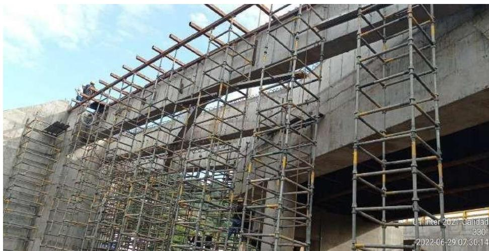
**Figura 74. Armado de andamios para la obra falsa de la placa**
