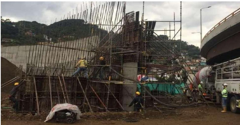
**Figura 53. Fundida del estribo**
