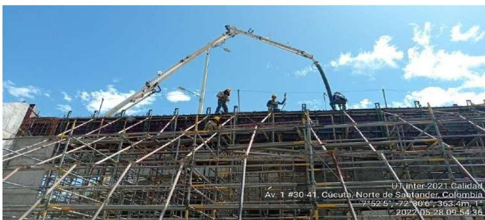
**Figura 59. Fundida de viga N°3.**
