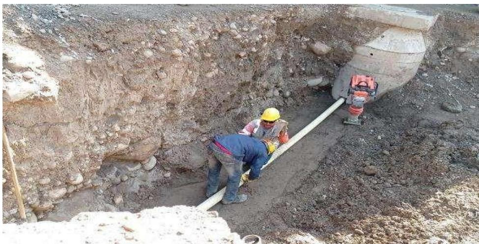
**Figura 73. Conexión del pozo prefabricado con el pozo existente**
