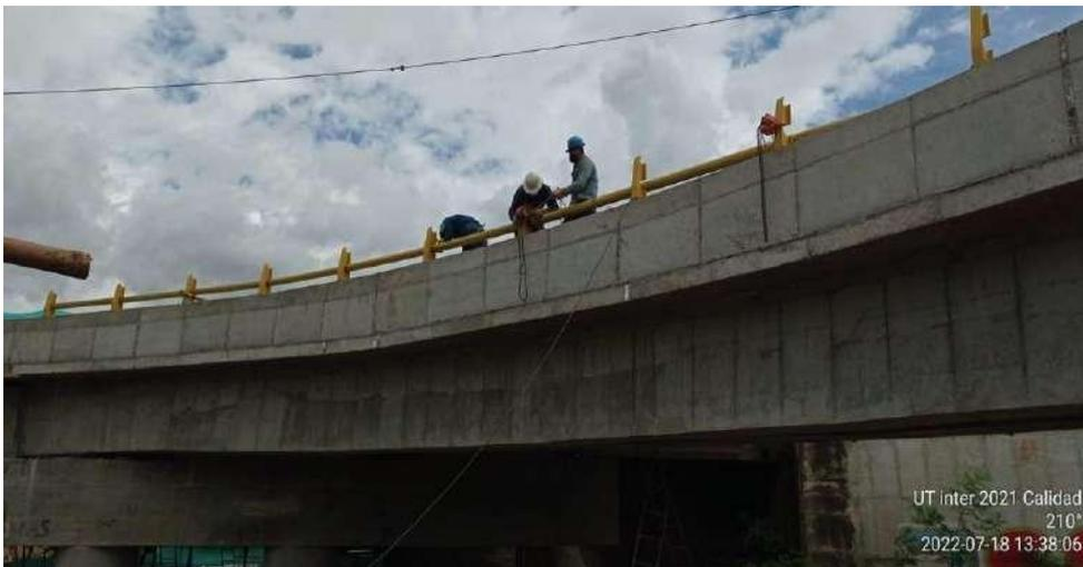
**Figura 47. Instalación de barandas**
