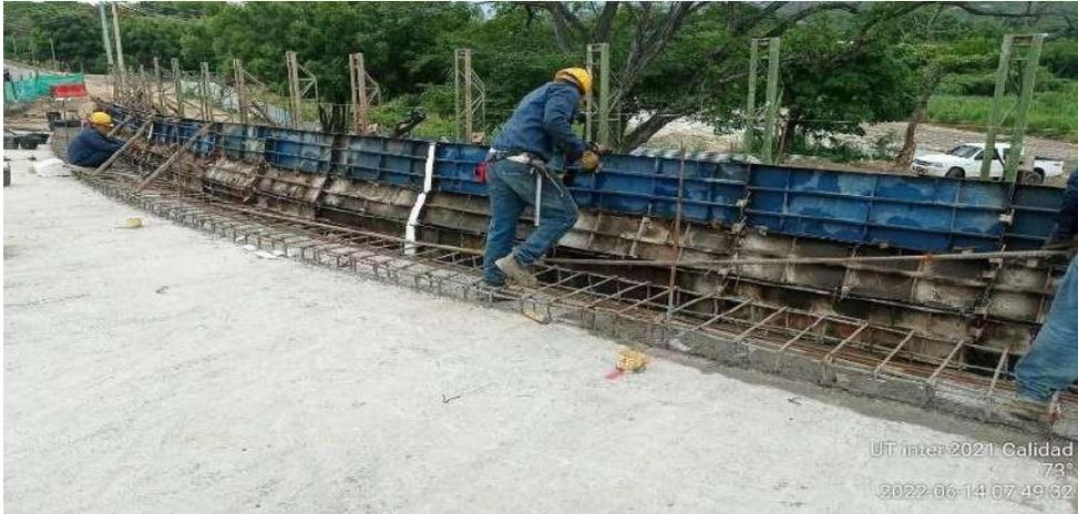
**Figura 28. Encofrando New Jersey de la placa**
