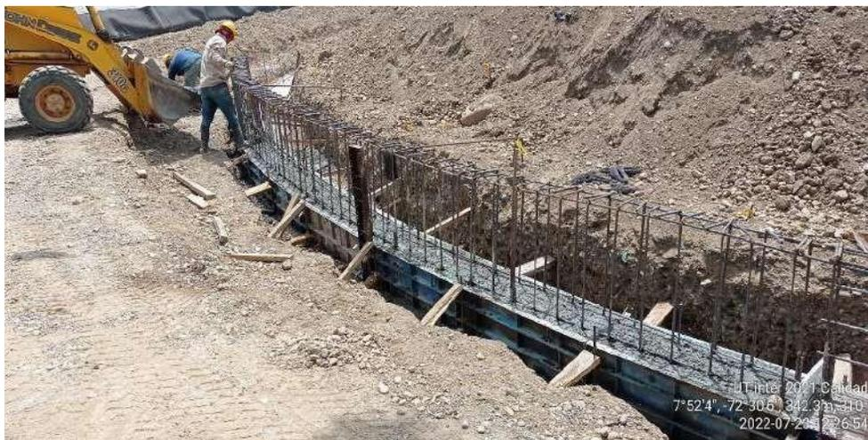
**Figura 85. Solado para el diente del muro derecho.**
