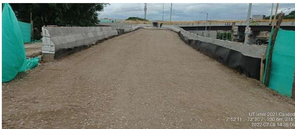
**Figura 41. Capa completa de base instalada**
