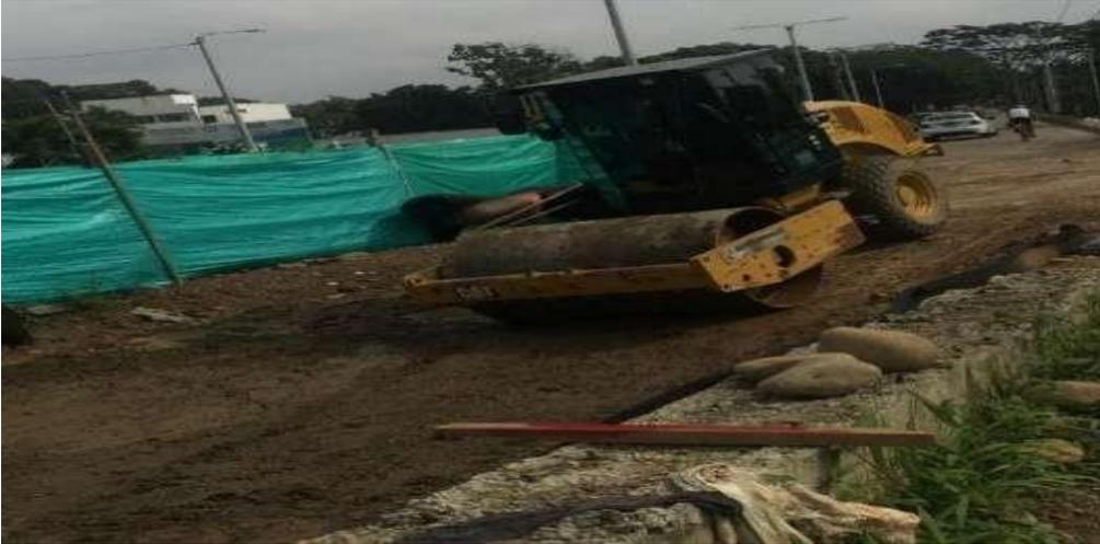
**Figura 26. Paso del vibro compactador por el terraplén - Ramal 14.**
