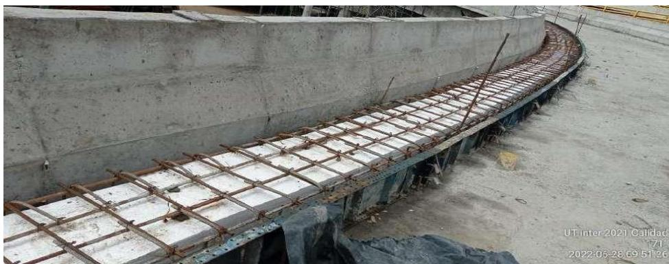
**Figura 37. Armado de parrilla de acero y encofrado de andén**
