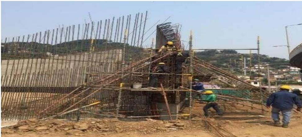
**Figura 52. Encofrado de estribo**
