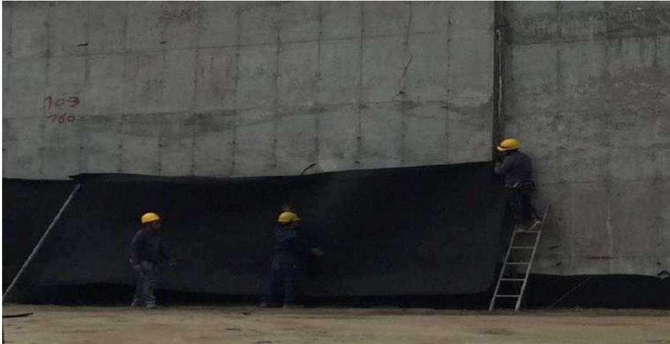
**Figura 62. Instalación de geodren en muro de tierra armada**
