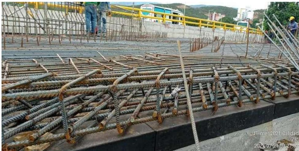
**Figura 76. Armado de la parrilla de acero de la placa**
