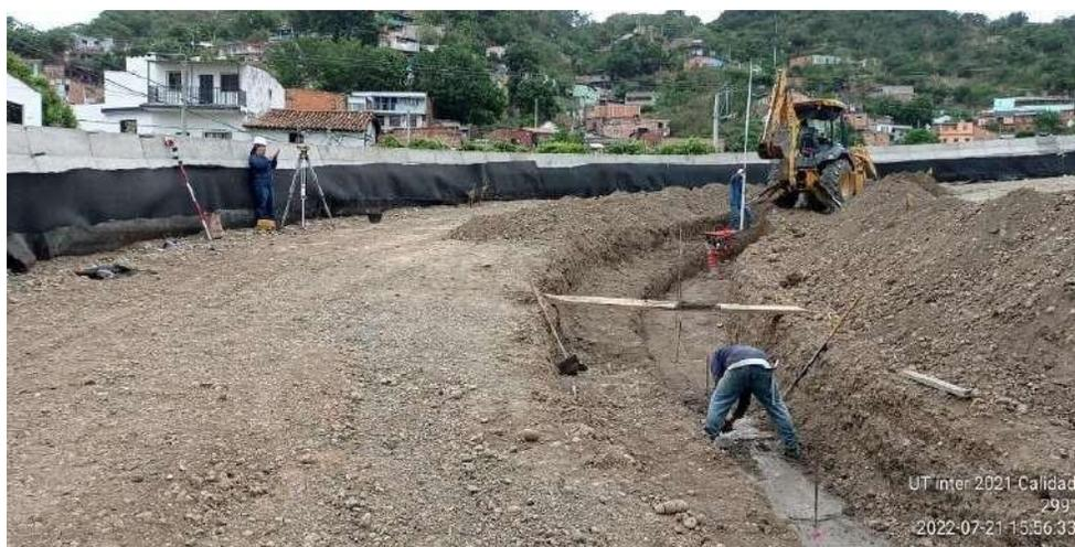
**Figura 83. Excavación de muro derecho.**
