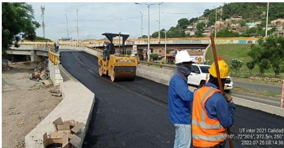
**Figura 49. Compactado de material de asfalto**
