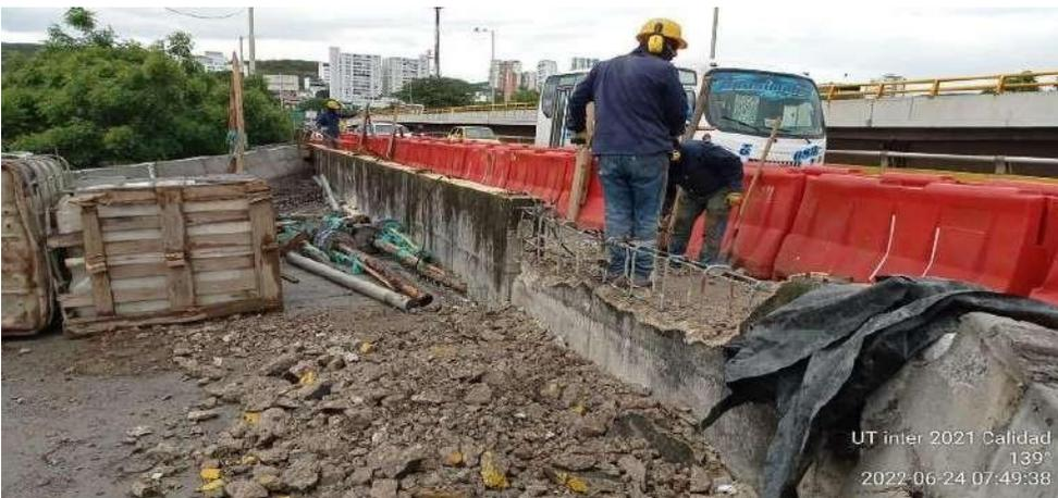
**Figura 32. Demolición muro contra impacto**
