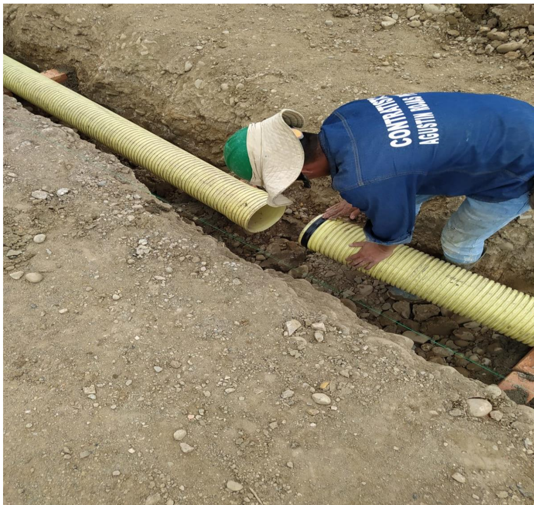
Figura 22. Adición de lubricante. Construcción de la obra madeira, ciudad de Cúcuta.
