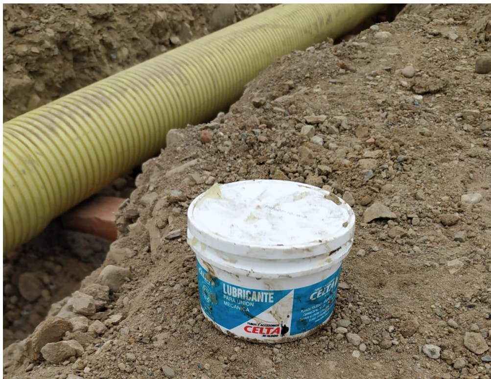
Figura 23. Lubricante para unión mecánica. Construcción de la obra madeira, ciudad de Cúcuta.
