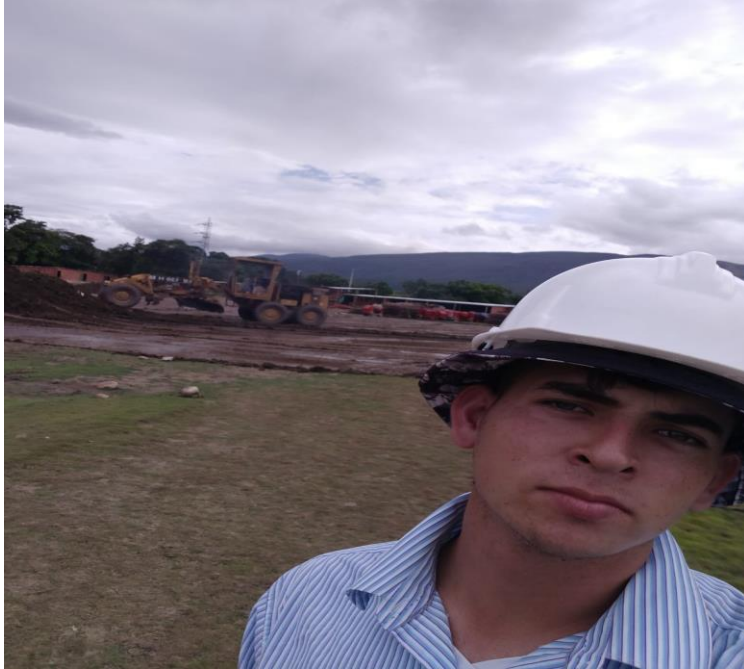
Figura 10. Rendimiento motoniveladora. Construcción de la obra madeira, ciudad de Cúcuta
