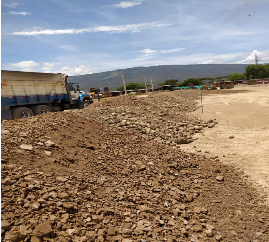
Figura 27. Descargue de los materiales. Construcción de la obra madeira, ciudad de Cúcuta.
