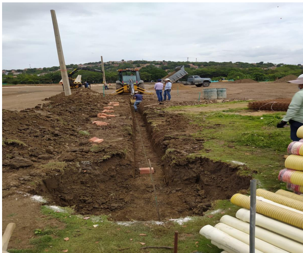
Figura 20. Excavación de pozos y alcantarillado principal. Construcción de la obra madeira, ciudad de Cúcuta
