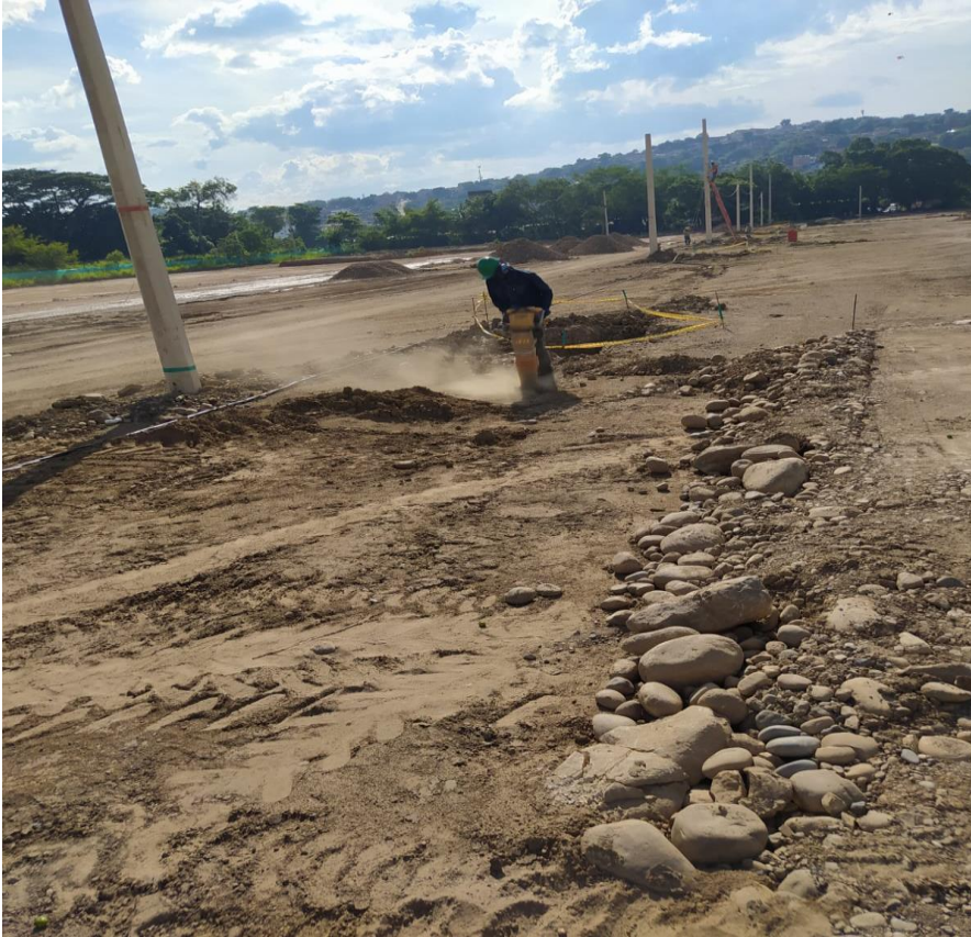
Figura 25. Compactación del alcantarillado principal. Construcción de la obra madeira, ciudad de Cúcuta.
