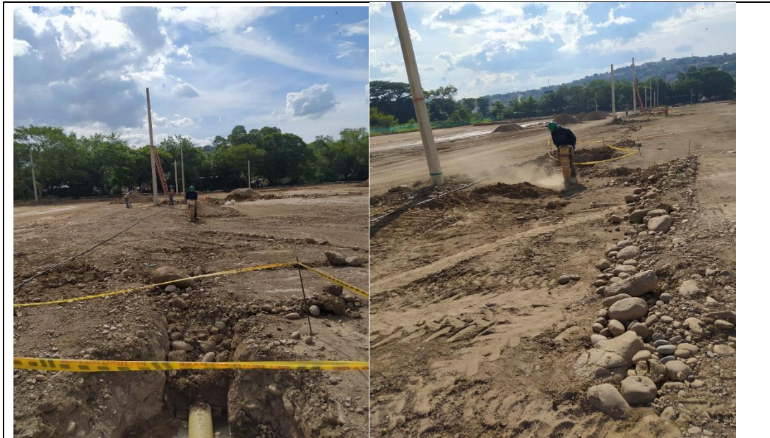
Relleno y compactación de alcantarillado
