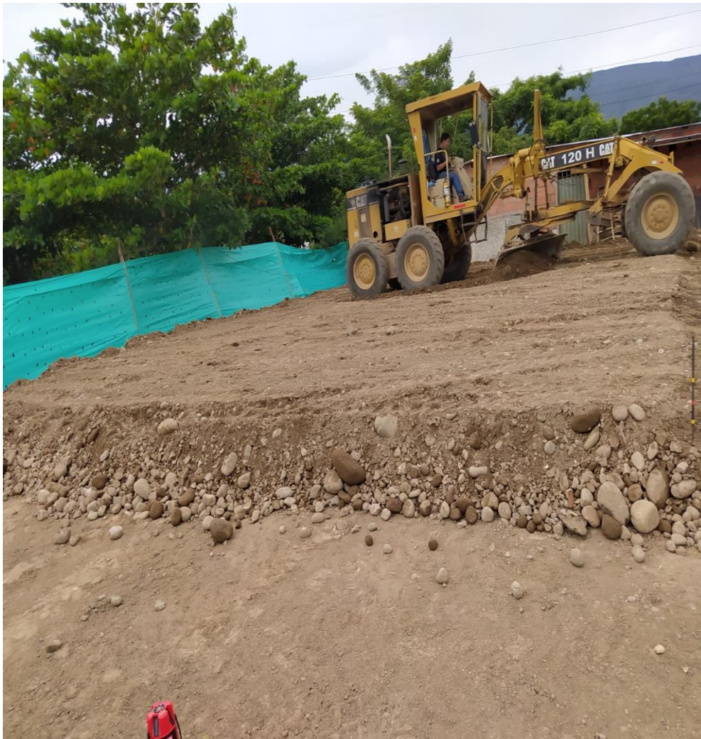
Figura 18. Cálculo de áreas. Construcción de la obra madeira, ciudad de Cúcuta
