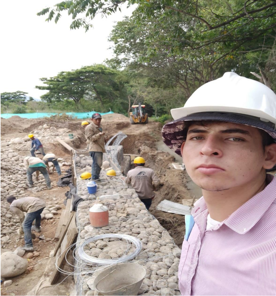
Figura 2. Acompañamiento y supervisión de gaviones. Construcción de la obra madeira, ciudad de Cúcuta
