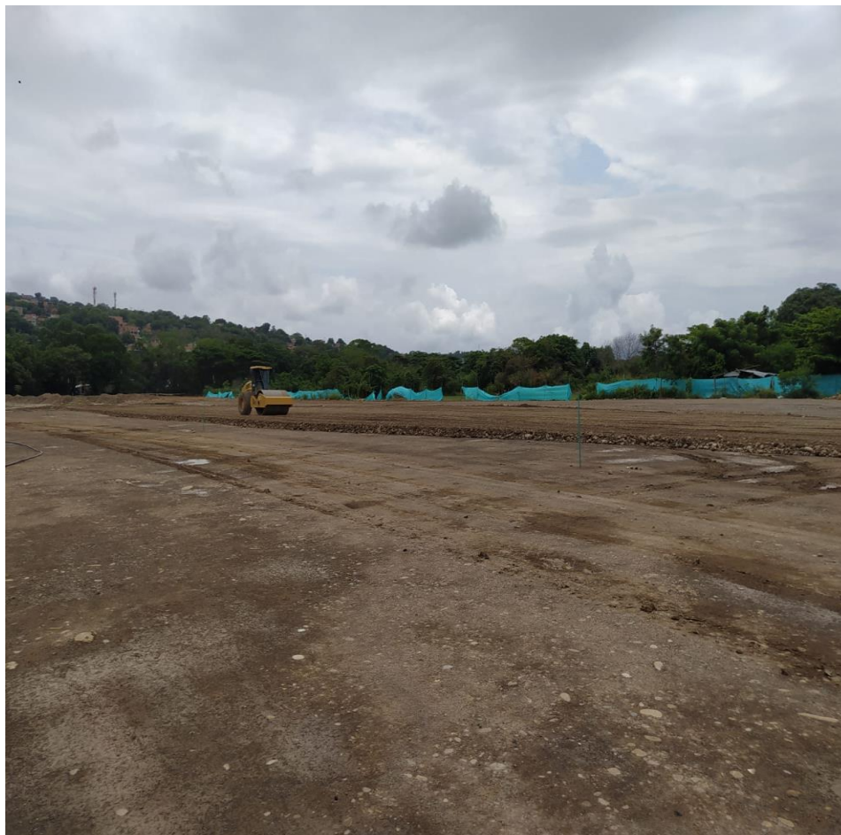
Figura 15. Compactación del material. Construcción de la obra madeira, ciudad de Cúcuta.
