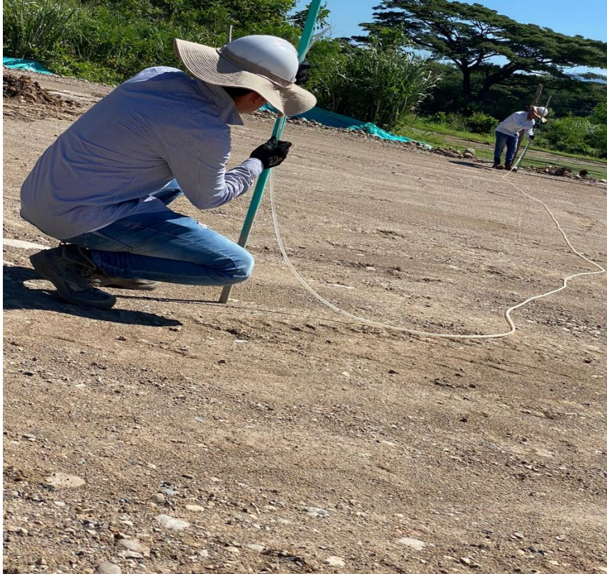
Figura 17. Verificación de cotas. Construcción de la obra madeira, ciudad de Cúcuta.
