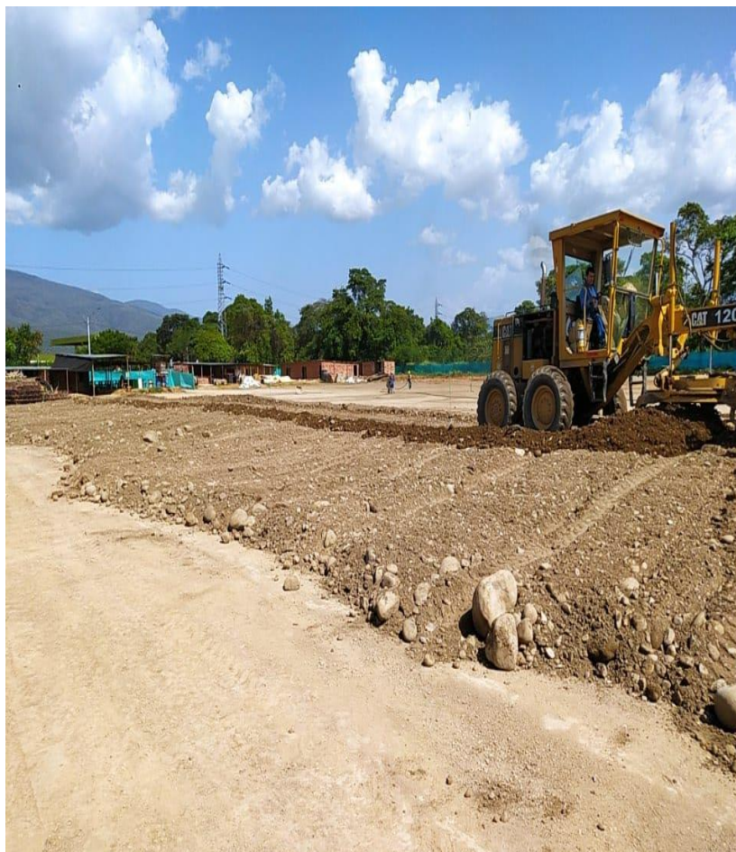
Figura 14. Nivelación de las terrazas. Construcción de la obra madeira, ciudad de Cúcuta.
