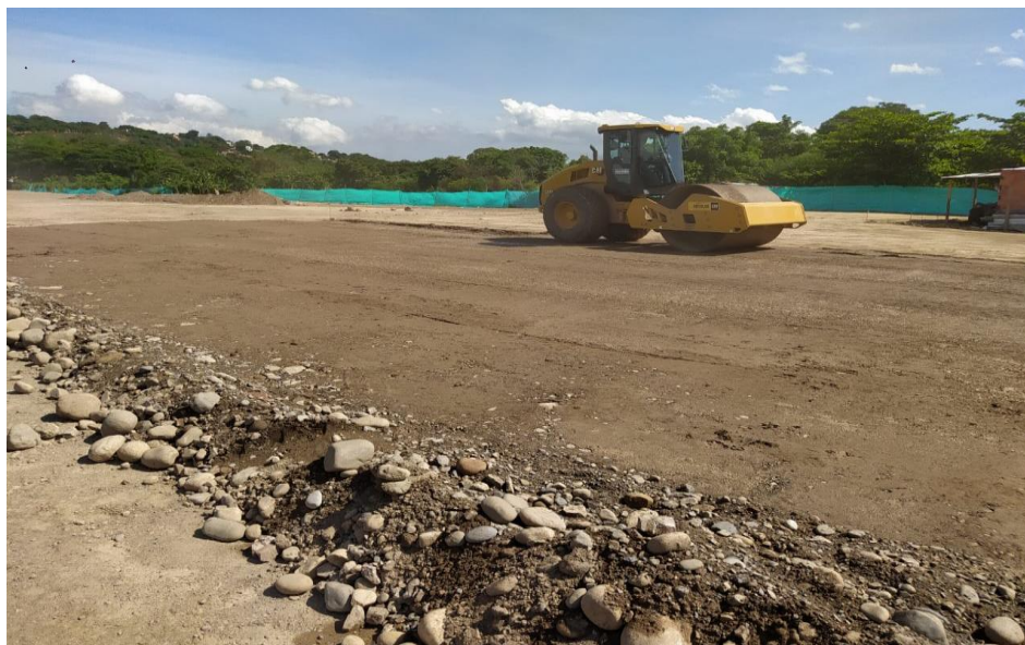
Figura 12. Rendimiento vibrocompactador. Construcción de la obra madeira, ciudad de Cúcuta.
