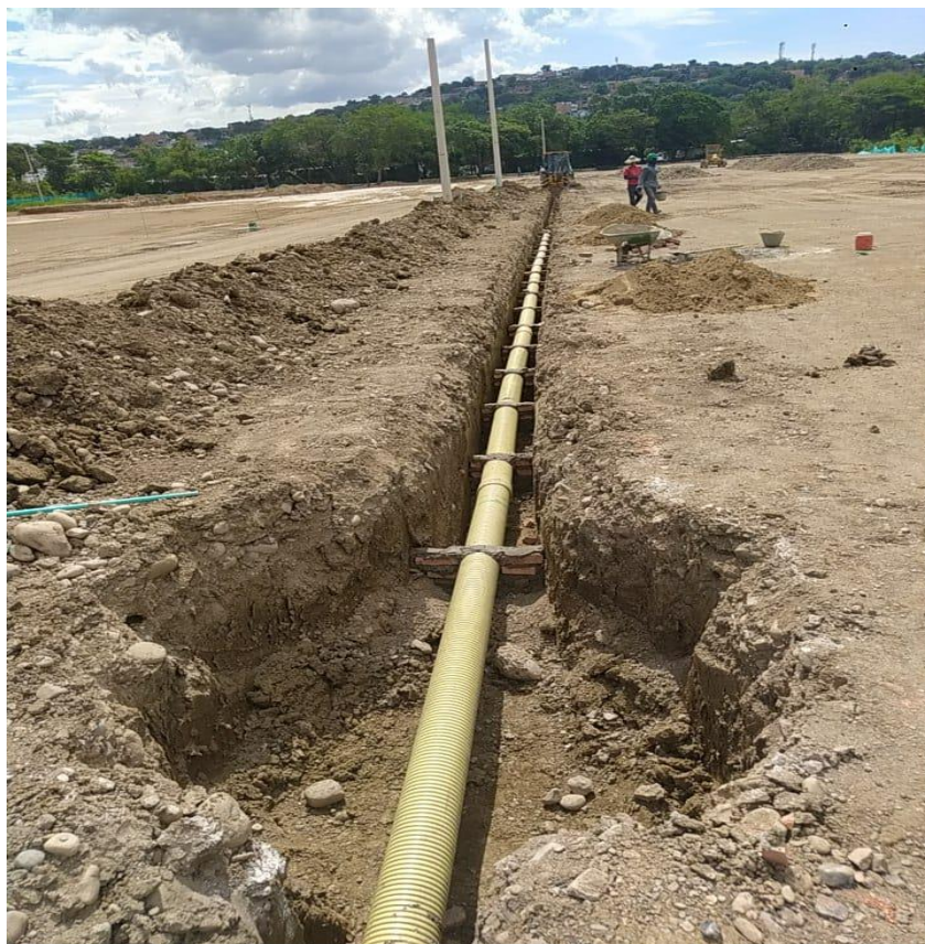
Figura 21. Instalación de tubería del alcantarillado principal. Construcción de la obra madeira, ciudad de Cúcuta.
