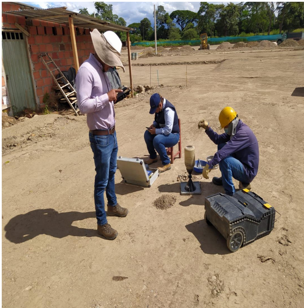
Figura 16. Toma de densidades. Construcción de la obra madeira, ciudad de Cúcuta.
