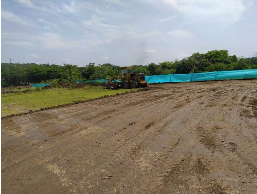
Figura 4. Limpieza y descapote del terreno. Construcción de la obra madeira, ciudad de Cúcuta.
