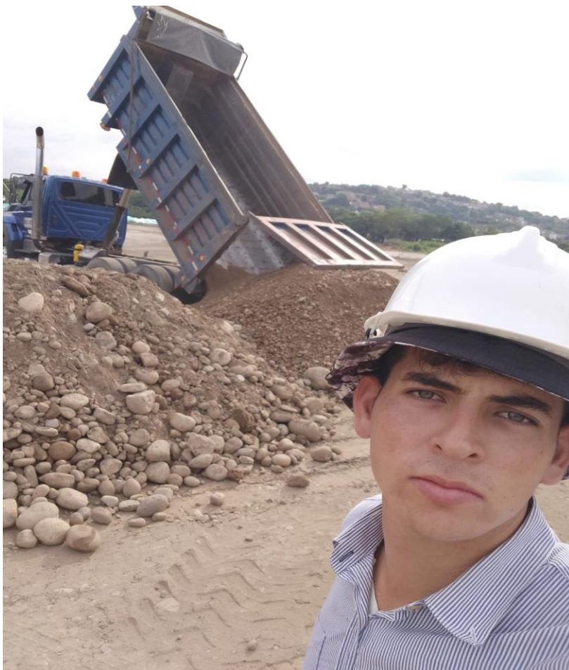
Figura 26. Recibimiento y ubicación del material. Construcción de la obra madeira, ciudad de Cúcuta.
