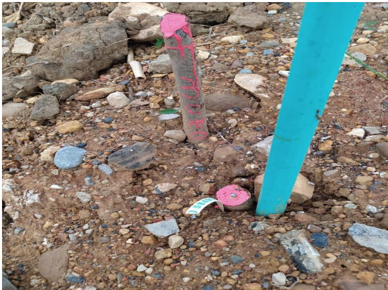
Figura 8. Ubicación de los puntos. Construcción de la obra madeira, ciudad de Cúcuta
