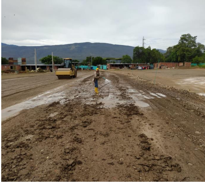
Figura 13. Mezcla del material. Construcción de la obra madeira, ciudad de Cúcuta.
