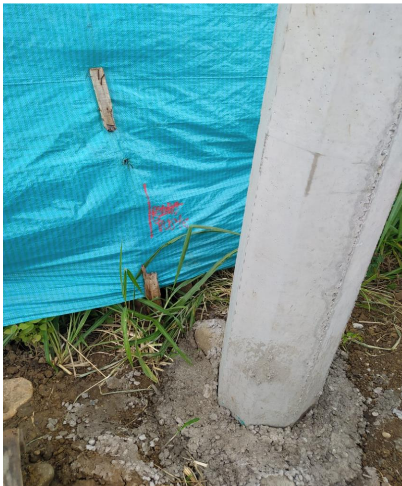
Figura 9. Ubicación de los puntos. Construcción de la obra madeira, ciudad de Cúcuta
