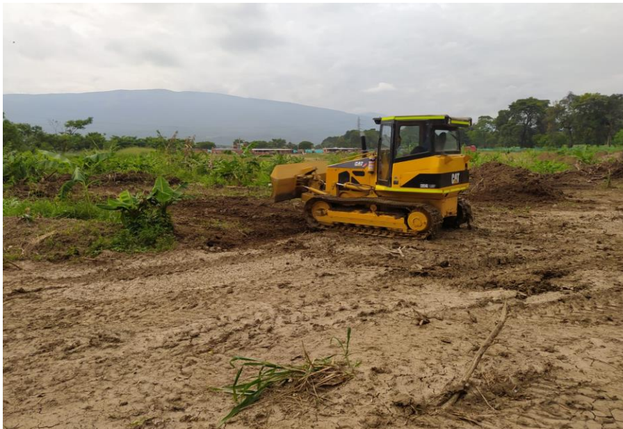
Figura 3. Limpieza y descapote del terreno. Construcción de la obra madeira, ciudad de Cúcuta.
