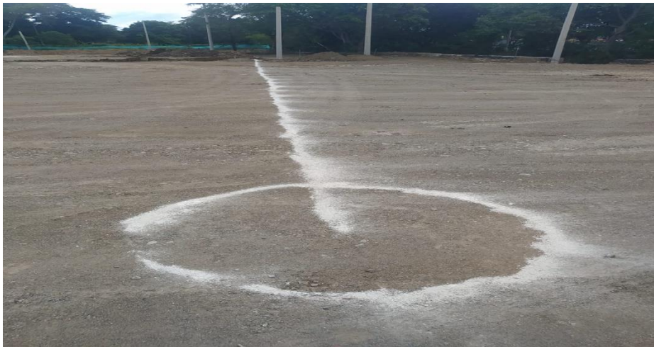
Figura 19. Trazado de pozos y alcantarillado. Construcción de la obra madeira, ciudad de Cúcuta
