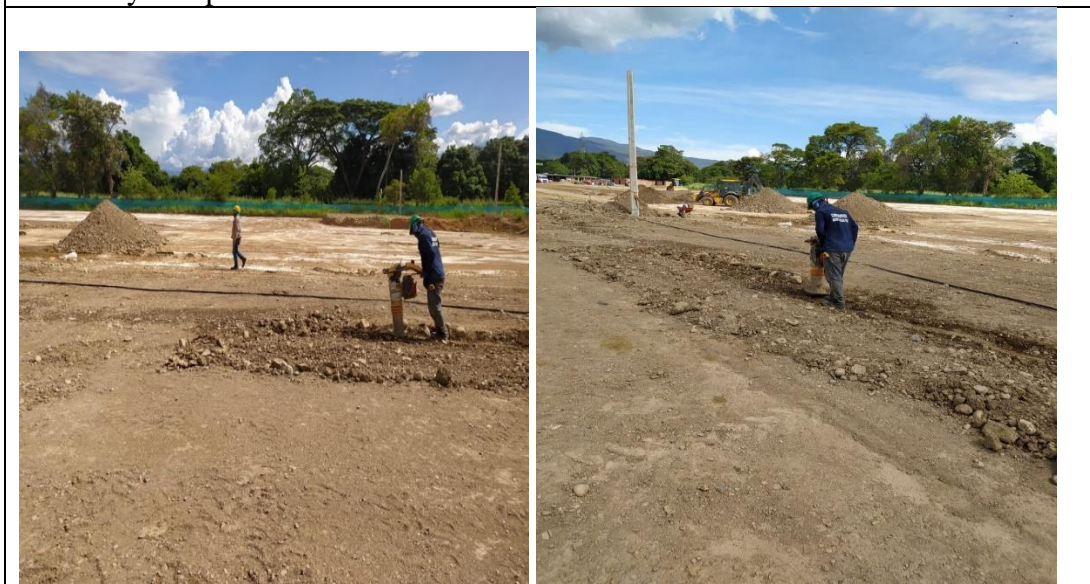
Relleno y compactación de alcantarillado
