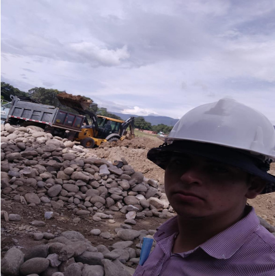
Figura 6. Retiro de escombros. Construcción de la obra madeira, ciudad de Cúcuta.
