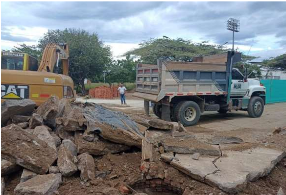
Figura 6. Retiro de los materiales de construcción.
