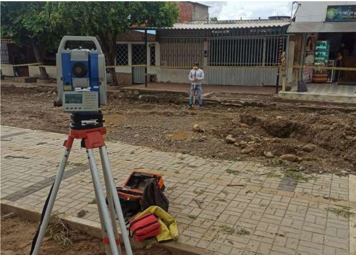
Figura 7. Topógrafo utilizando estación total para labores de topografía.
