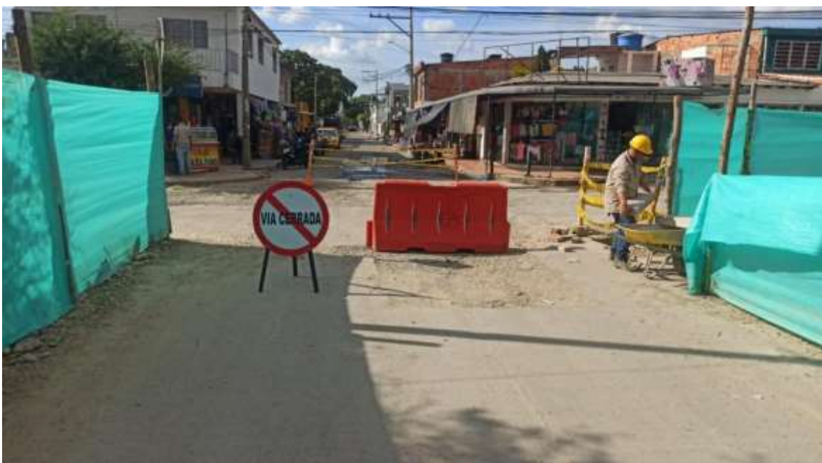
Figura 2. Cerramientos y señalización.
