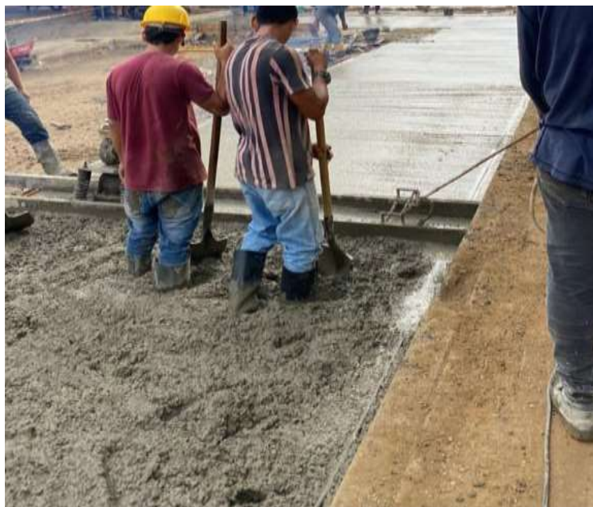
Figura 14. Fundición del pavimento rígido.
