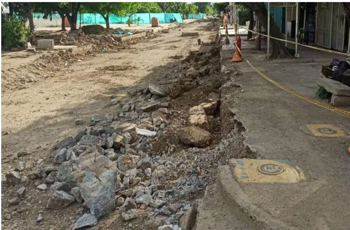
Figura 5. Retiro del bordillo del andén.
