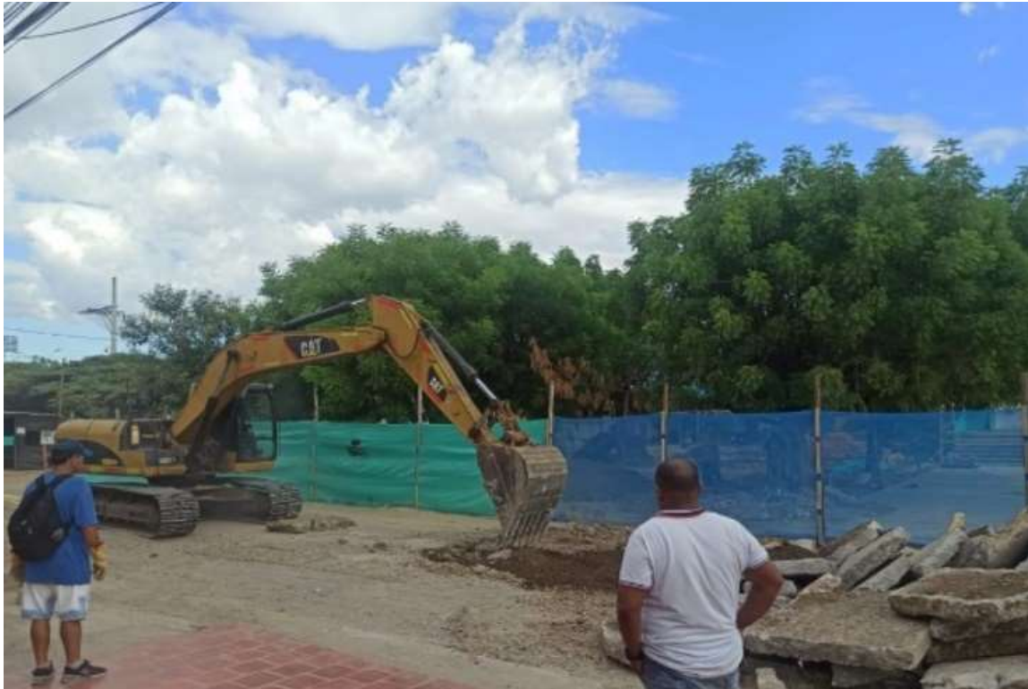
Figura 3. Retiro del pavimento rígido antiguo.
