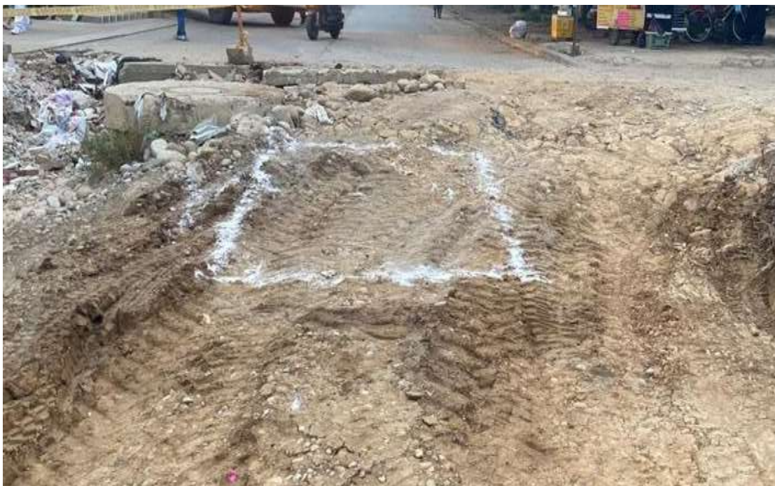
Figura 8. Localización y replanteo de los pozos de alcantarilla.
