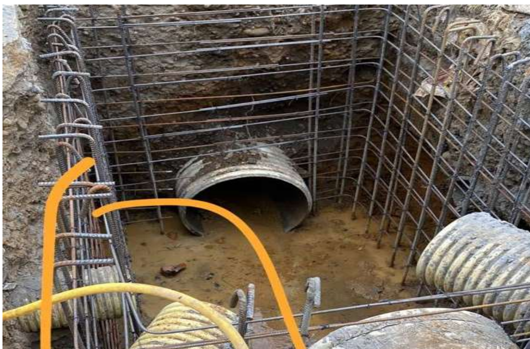
Figura 12. Armado de hierro para pozo de alcantarilla.
