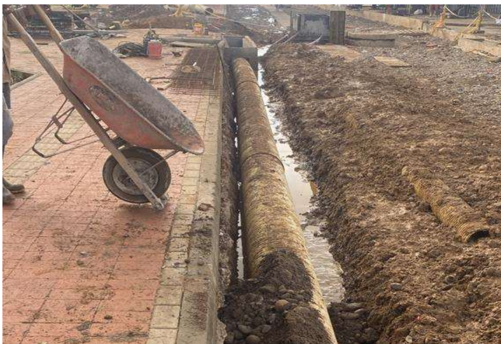
Figura 13. Llenado de material después de las instalaciones de tubería.
