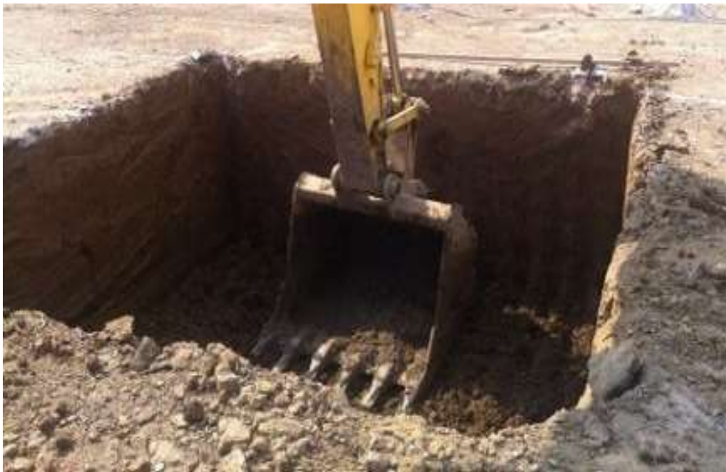
Figura 9. Excavaciones para pozo y tuberías de alcantarilla.
