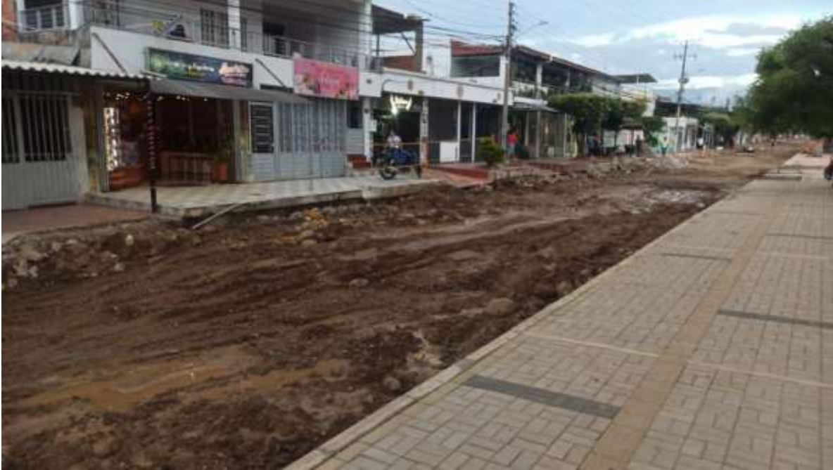
Figura 4. Terreno natural después de retirar el pavimento rígido antiguo.
