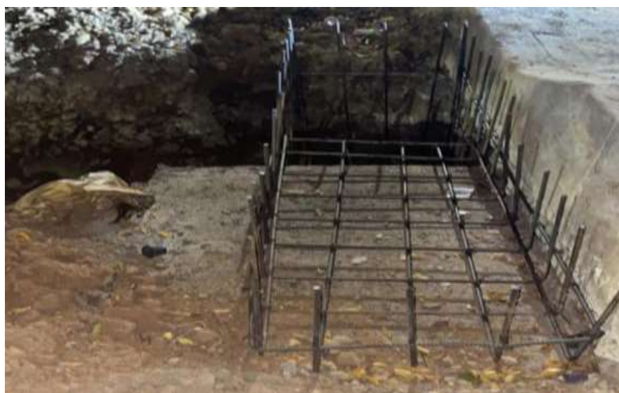
Figura 10. Hierro de la caja de alcantarilla pluviales.
