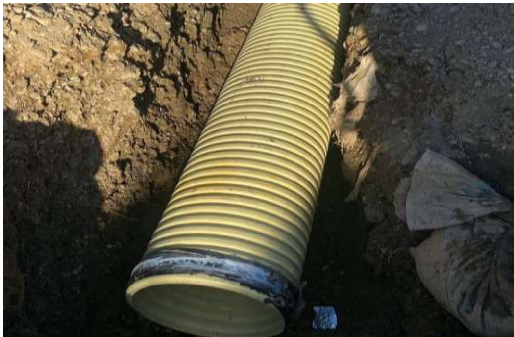
Figura 11. Instalación de tubería de 24 pulgadas para alcantarilla.
