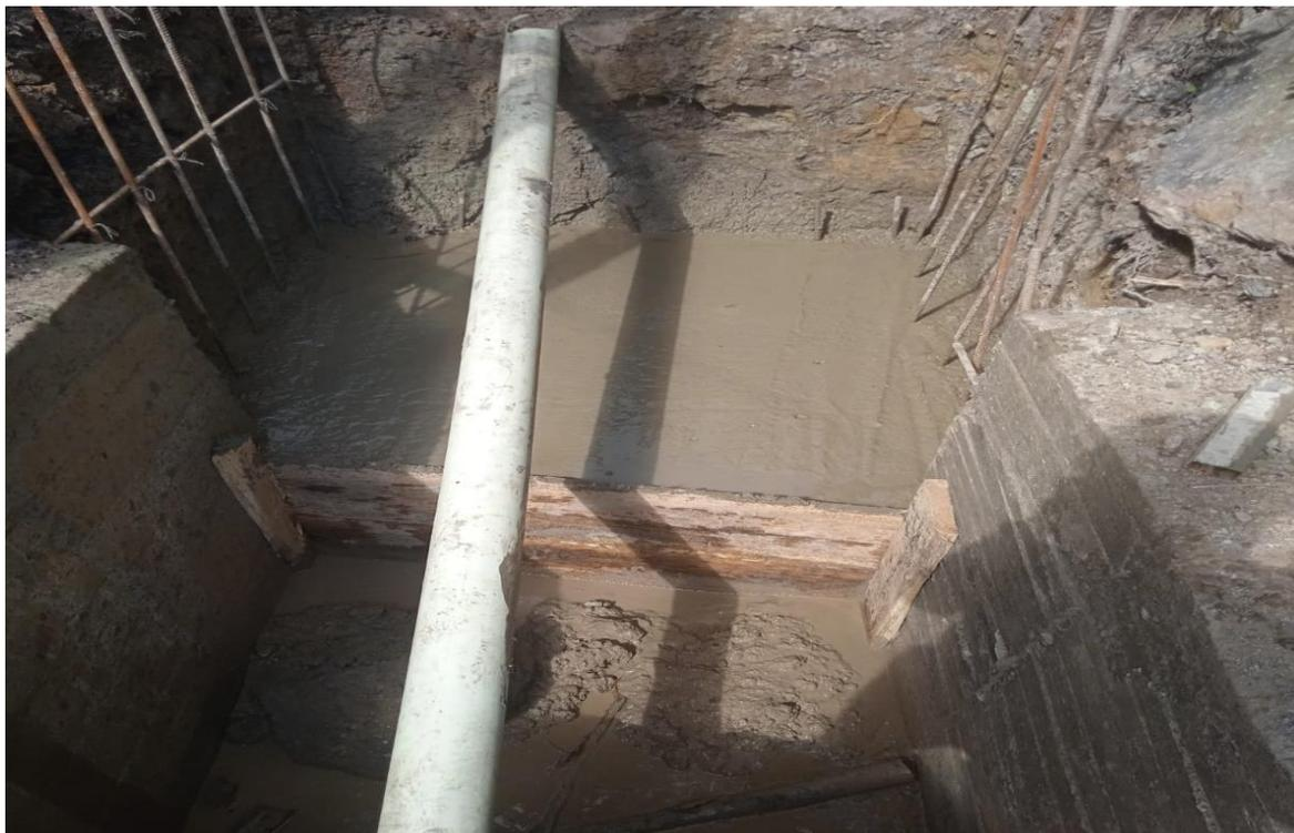
imagen # 60 losa fundida en concreto reforzado
