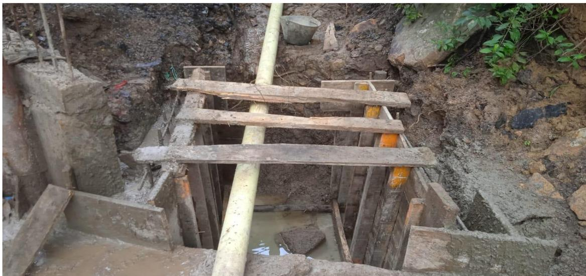
Imagen #58 muros de canal ascendente, fundidos
