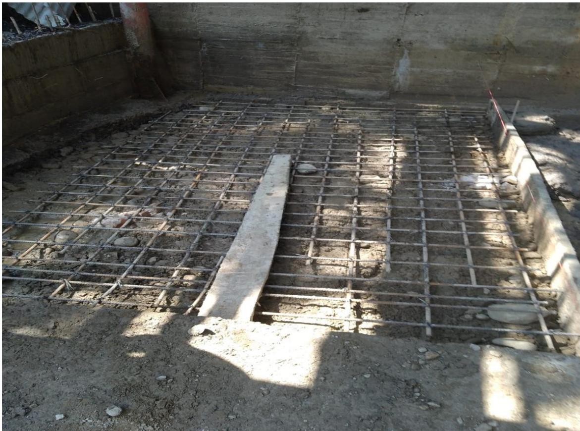
imagen #50 se observa acero figurado y amarrado de losa de concreto
