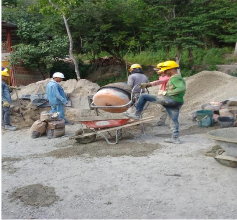
Imagen #17 se muestra preparación de concretos
