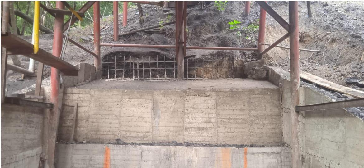
Imagen #55 muros de contención frontales
