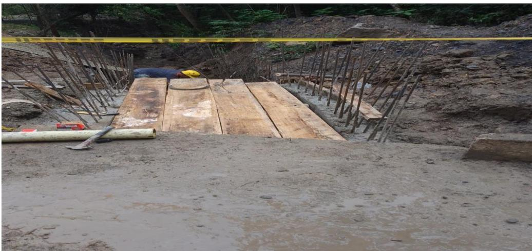
imagen #78 se observa encofrado para otro tramo de box coulver
