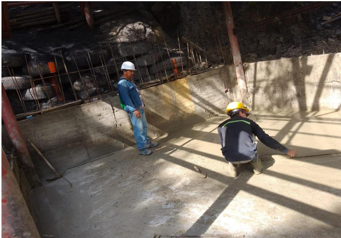
imagen #51 se observa terminación de losas de concreto por la supervisión del maestro de la obra
