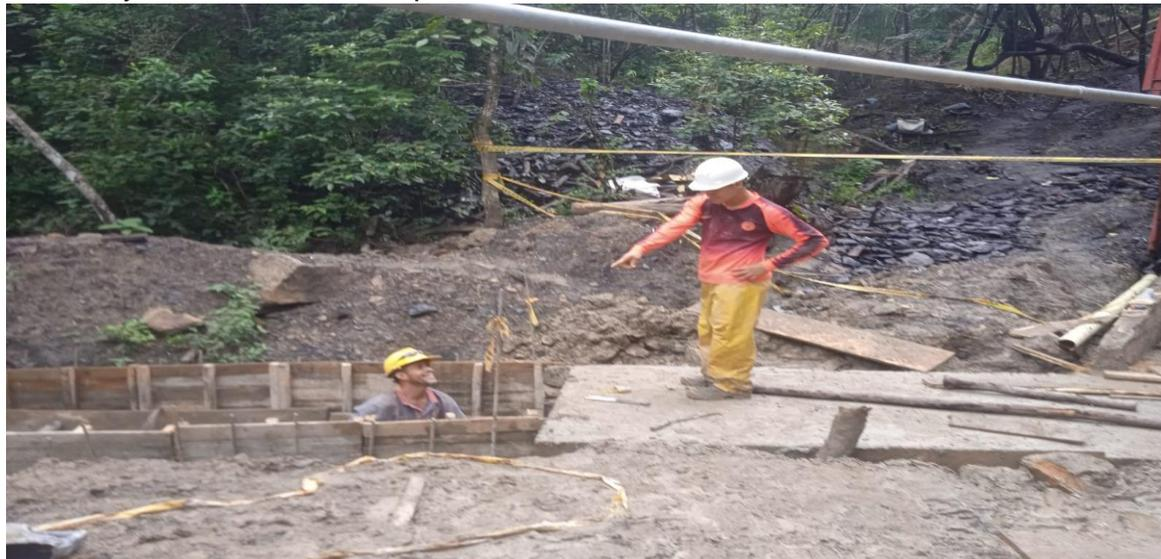
Imagen #75 se observa dando pautas para el encofrado de muros
