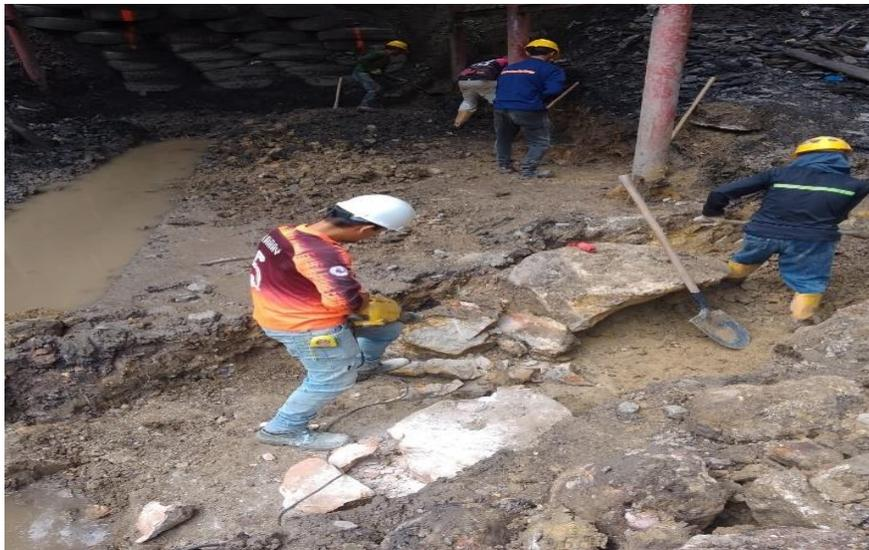
imagen #12 demolición a roca con taladro manual
