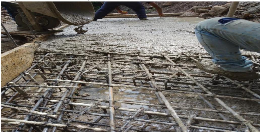
imagen #81 se observa fundición de losa de concreto
