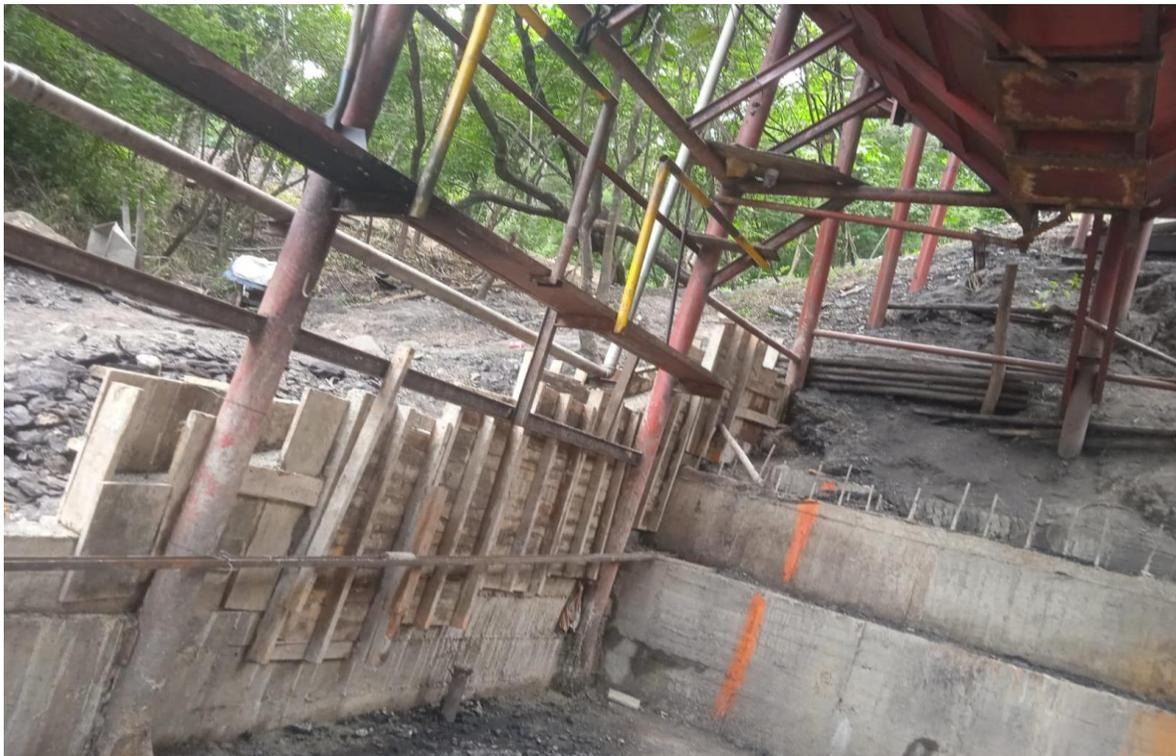
imagen #52 se observa muros encofrados para fundir
