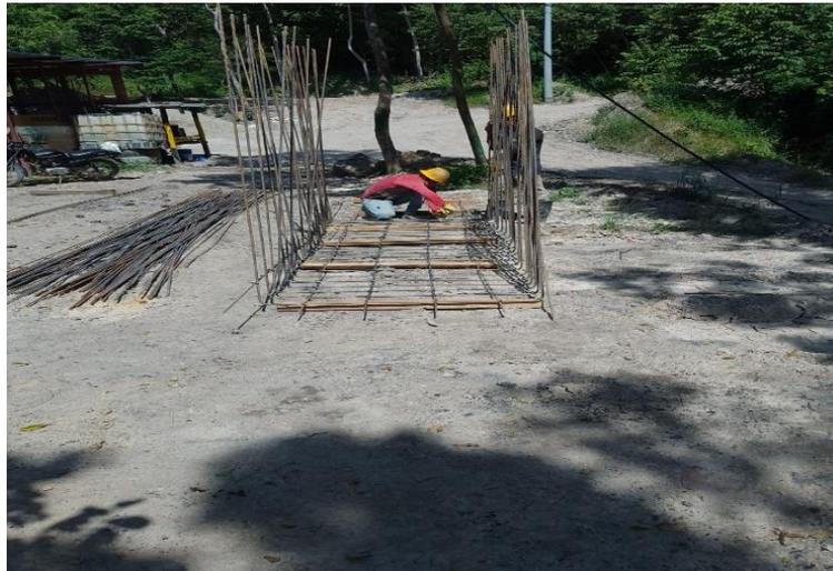
imagen # 25 se observa el figurado y amarrado de acero de canasta
