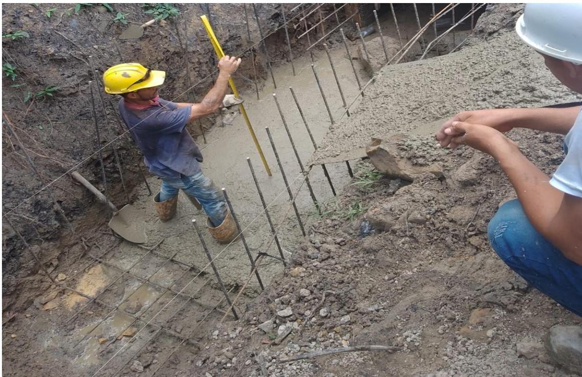
Imagen #73 se observa obrero tomando medidas para altura con pendiente
