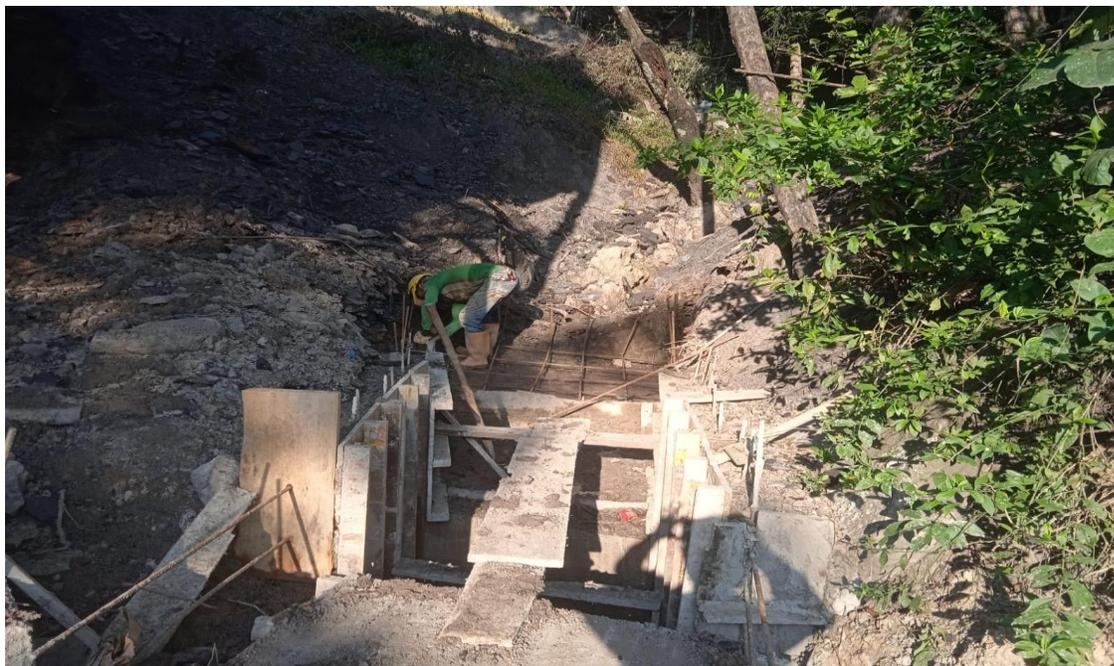
imagen #61 se observa encofrado de muros
