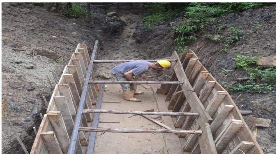
imagen #89 continuación de muros encofrados
