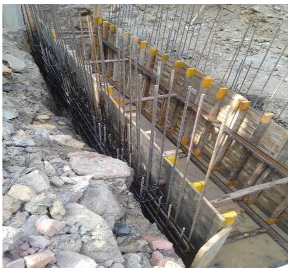
Imagen #37 encofrado de muros
