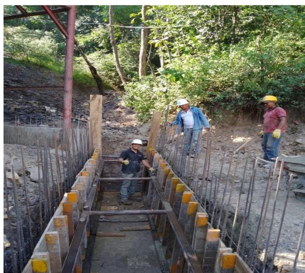
imagen #38 encofrado de muros
