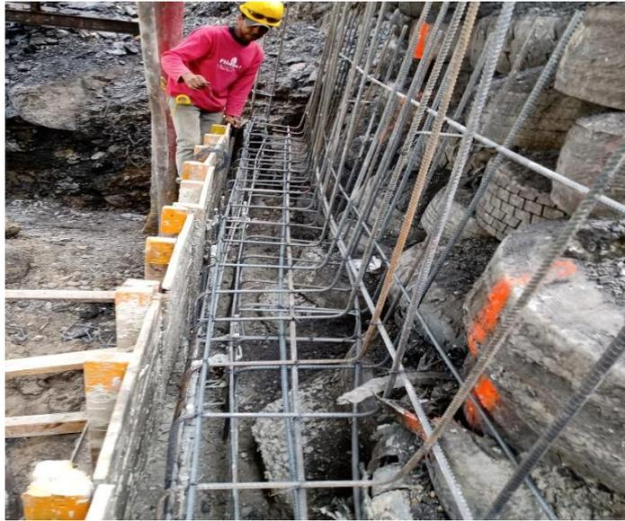
Imagen #26 se muestra encofrado y amarrado de acero
