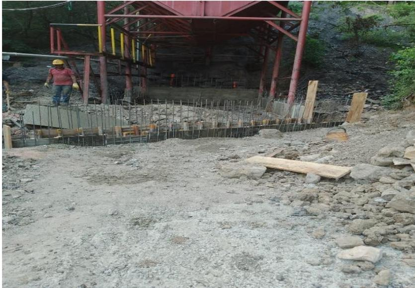
imagen #39 vista frontal de tolva en obra con los muros encofrados
