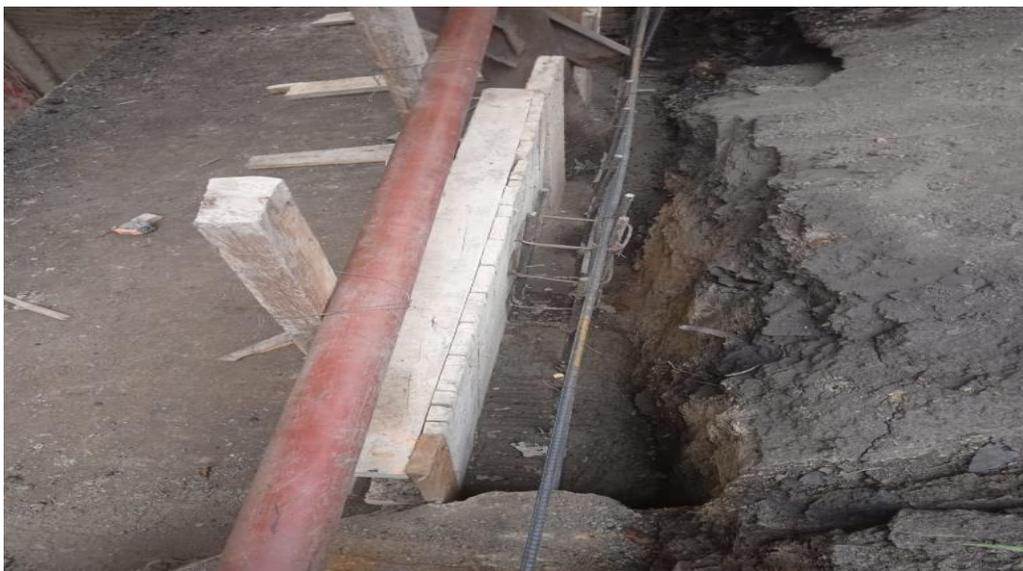
Imagen #22 se divisan muros figurados y amarrados para su fundición en concreto
