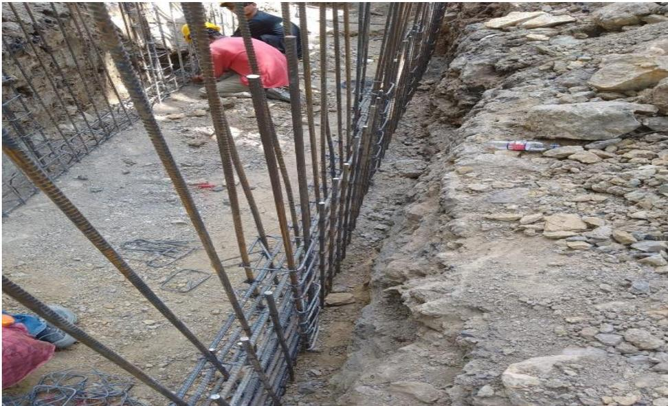
Imagen #34 se muestra personal amarrando acero para muros
