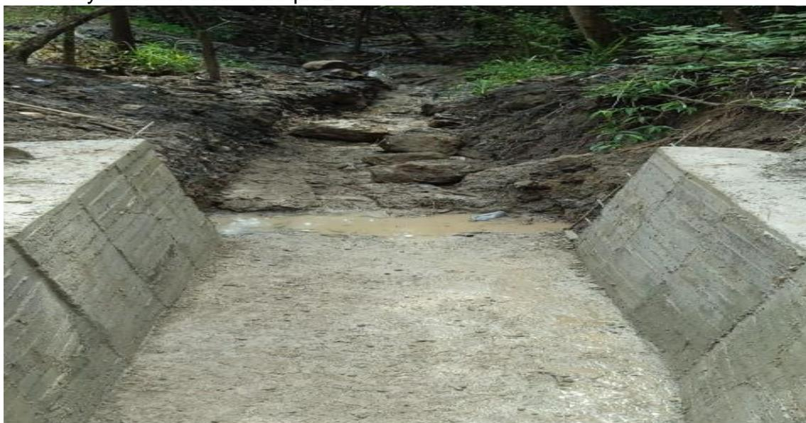
imagen #91 muros y piso en concreto reforzado
