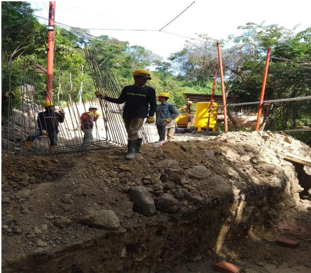
Imagen #28 se muestra personal ingresando canasta a la excavación
