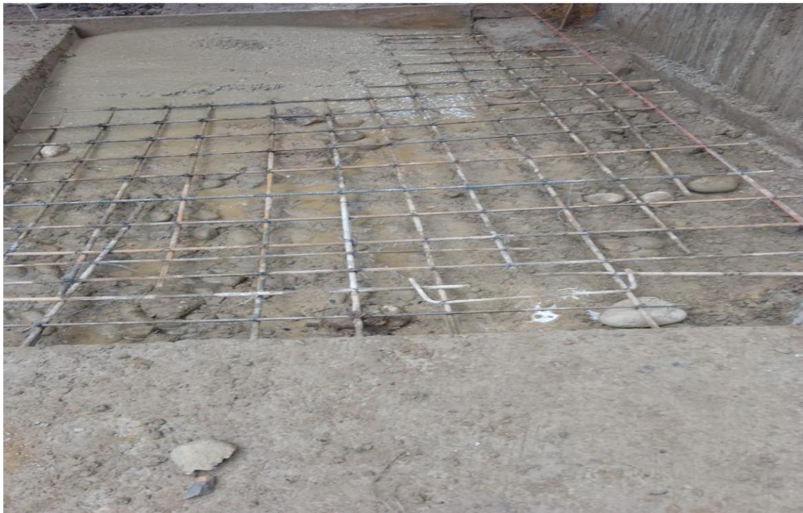
Imagen #49 se observa inicio de fundida de losa de concreto
