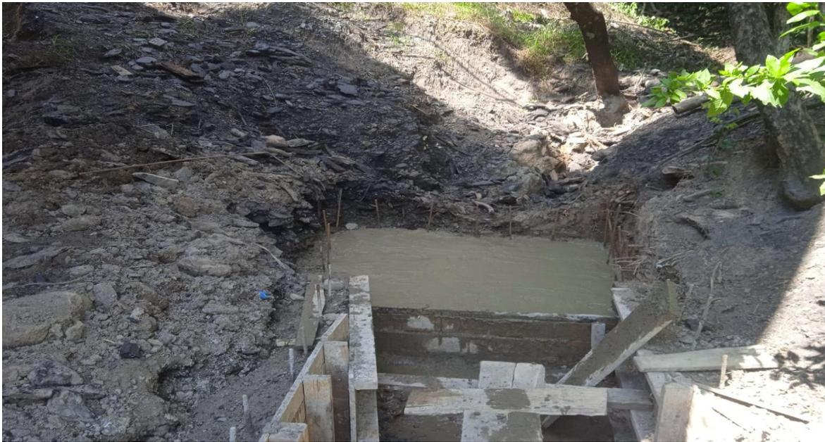
Imagen #62 se observa fundida de losa en concreto reforzado
