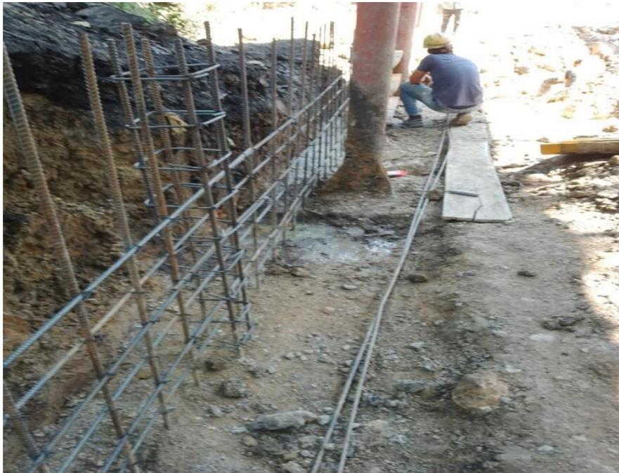
imagen #18 se muestra el amarrado de acero para muros
