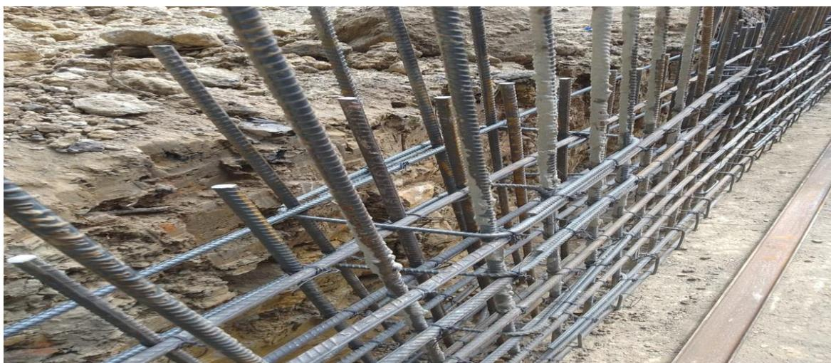
Imagen #74 se observa acero figurado y amarrado para muros
