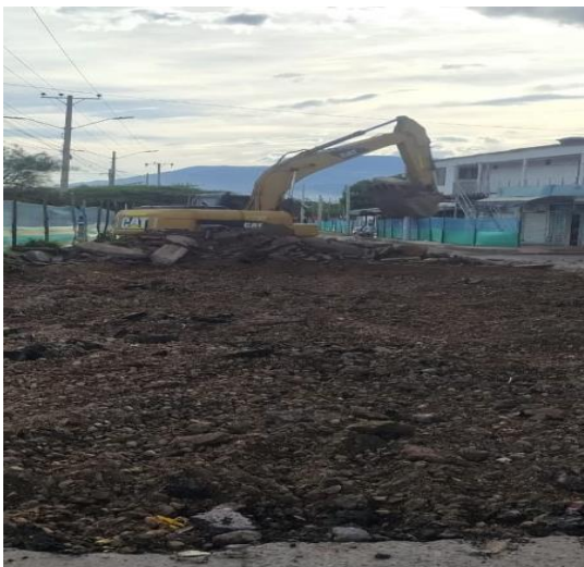
1. Retroexcavadora oruga CAT
