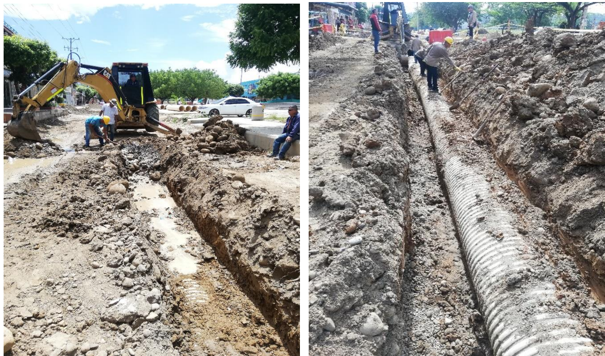
Figura 7. Excavación Avenida 20 a la 21 con calle 4.
