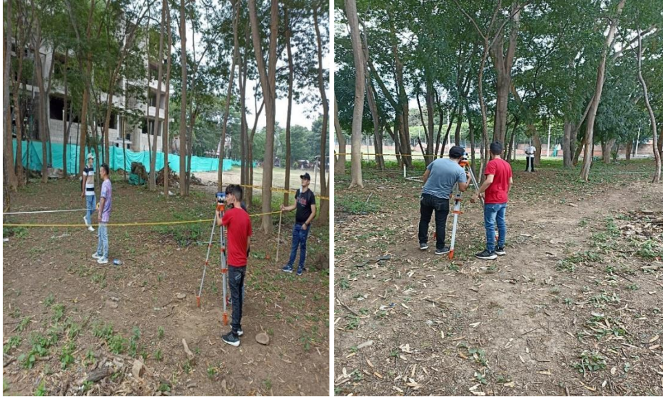
Armado y nivelación del nivel de precisión
