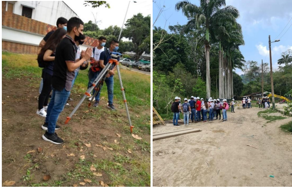
Armado y nivelación del nivel de precisión
