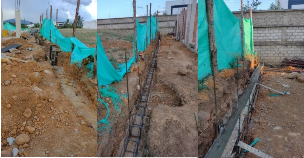
Figura 8. Armado y fundida de viga
