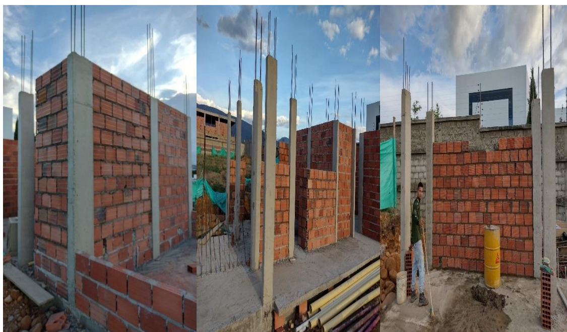
Figura 3. Mampostería primer piso
