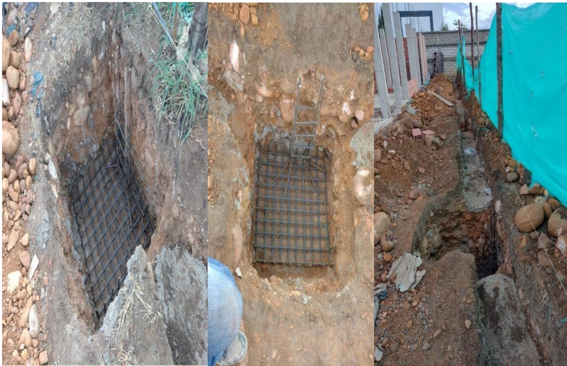
Figura 7. Armado de zapata
