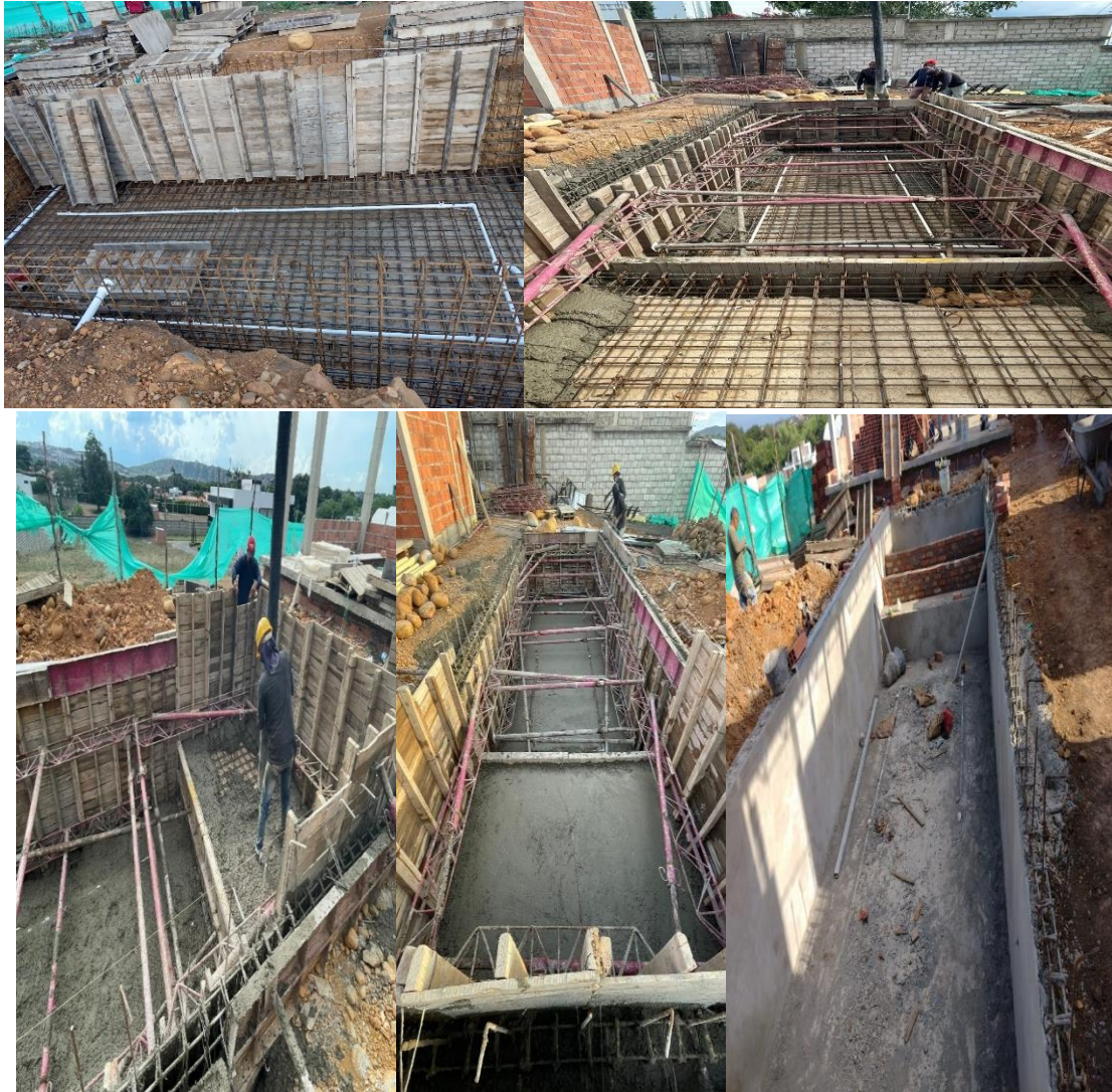
Figura 6. Encofrado y fundida de piscina
