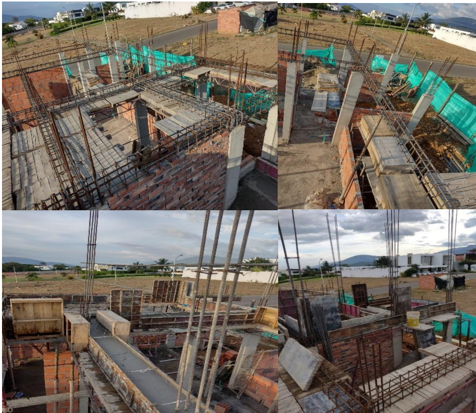
Figura 4. Armado y fundida de vigas
