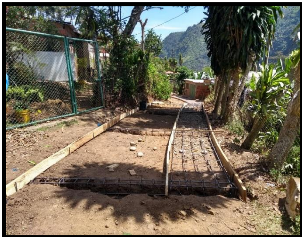
Figura 18. Ubicación vigas de refuerzo. Tramo4
