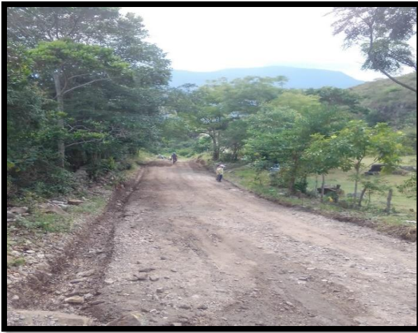
Figura 16. Alisado y compactación del suelo. Tramo1
