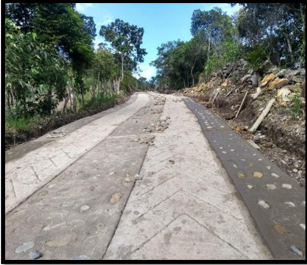
Figura 32. Fundición de sobre anchos, con piedra rajón.
