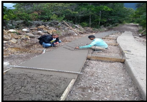
Figura 26. Demarcación espina de pescado. Tramo1
