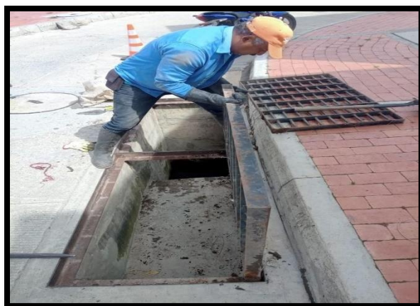
Figura 42. Limpieza de sumidero
