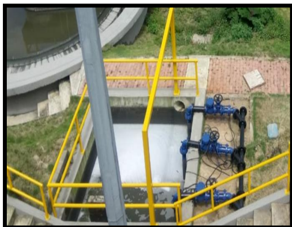
Figura 46. Revisión pozo de bombeo
