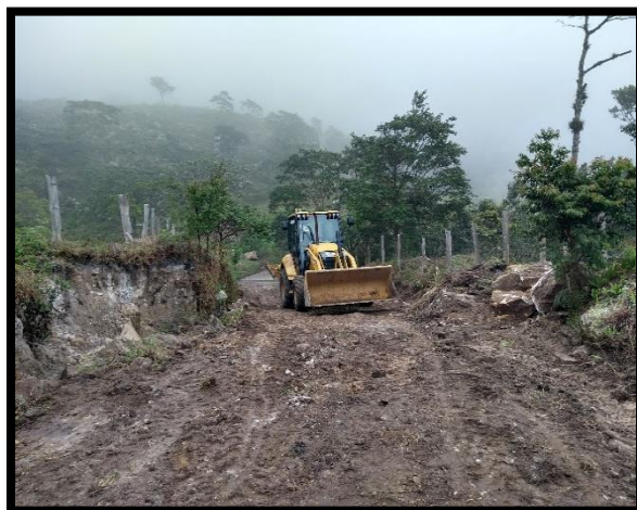
Figura 13. Escarificación. Tramo 3
