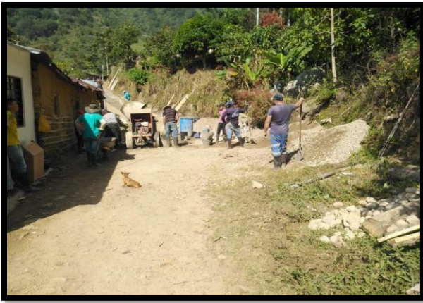
Figura 20. Preparación de concreto Tramo hidráulico clase D. Tramo 4
