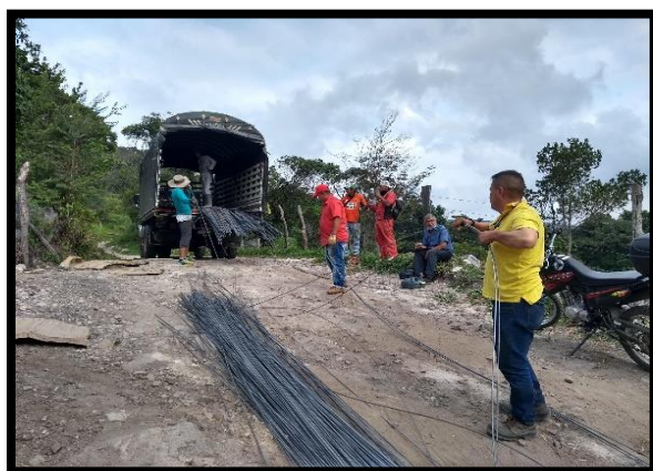
Figura 8. Entrega de varilla #2- #3 6 metro de longitud
