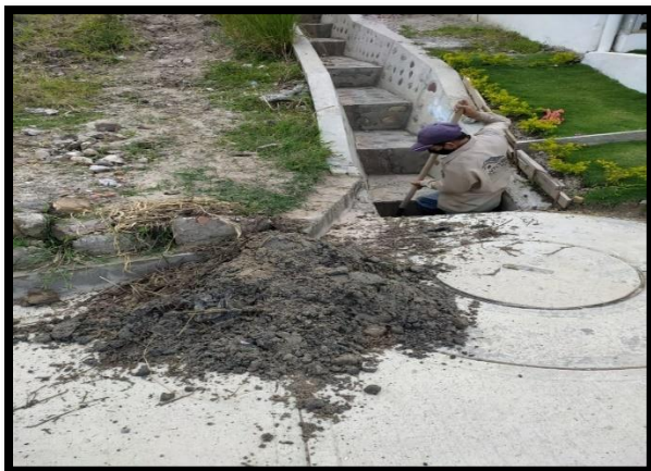
Figura 41. Limpieza red alcantarillado
