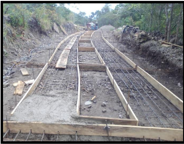
Figura 22. Fundición de la placa huella. Tramo 1
