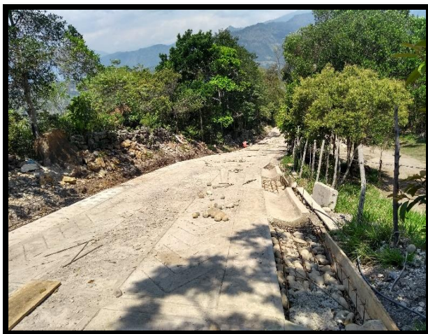
Figura 35. Acero de refuerzo y piedra rajón
