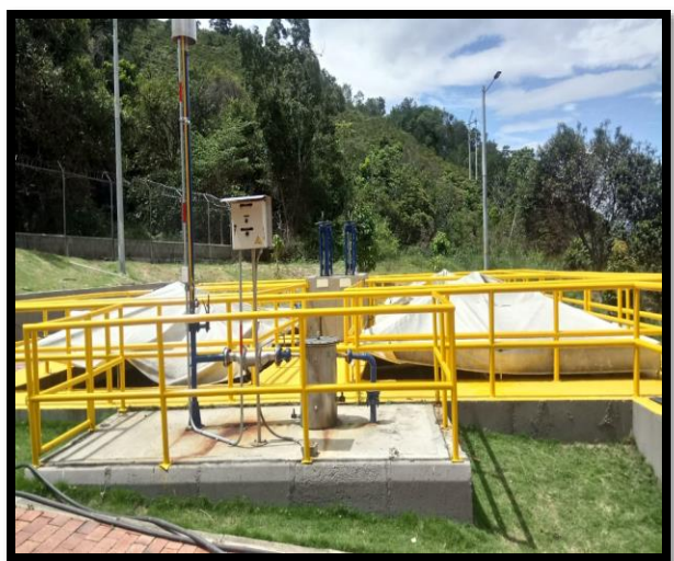
Figura 47. Inspección Reactor UASB
