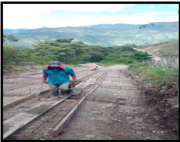
Figura 23. Fundición franjas laterales, placa huella. Tramo 1
