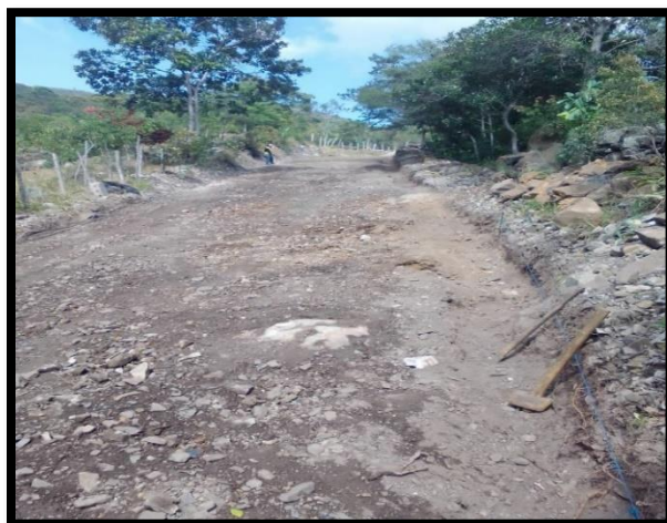
Figura 15. Escarificación y adecuación. Tramo 1
