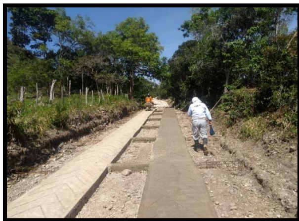
Figura 27. Retiro cajones de formaleta. Para fundir la placa central. Tramo1
