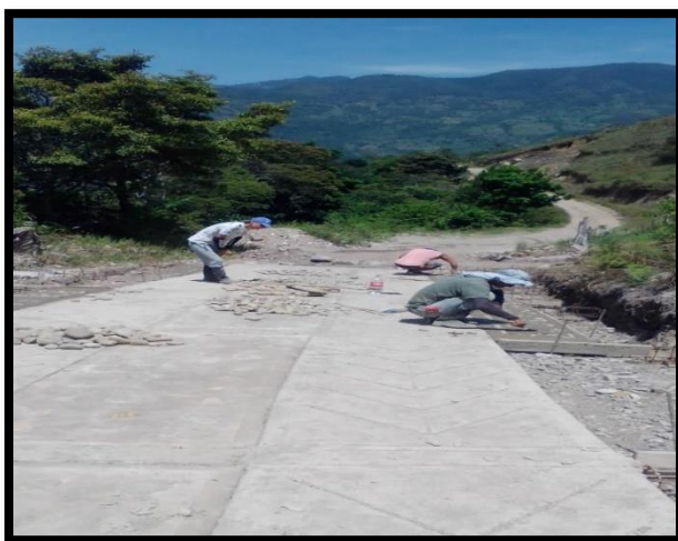
Figura 29. Placa central fundida. Tramo1
