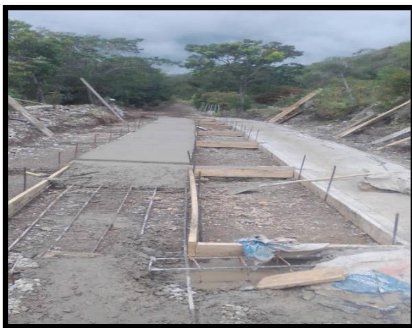
Figura 25. Fundición Demarcación espina de pescado. Tramo1
