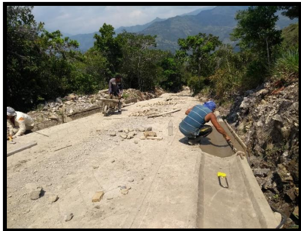
Figura 36. Fundición de cuneta y bordillo.
