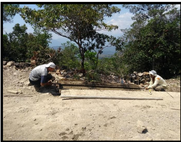
Figura 33. Formaleta de cuneta y bordillo
