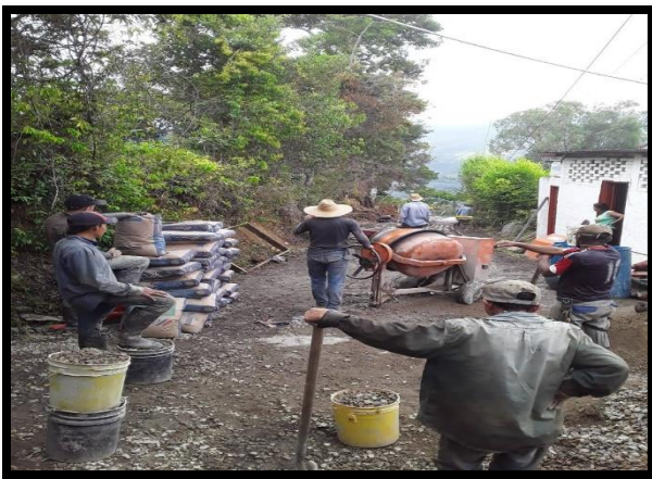
Figura 21. Preparación de concreto clase D. Tramo 4
