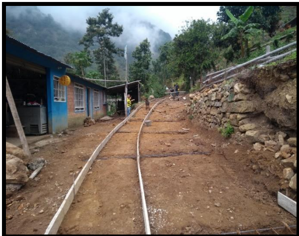
Figura 17. Ubicación de la formaleta. Tramo 4.
