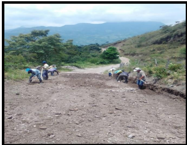
Figura 14. Escarificación y adecuación. Tramo 2.
