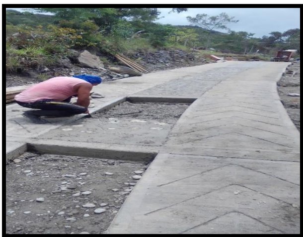
Figura 28. Fundición placa central, concreto y piedra rajón. Tramo 1
