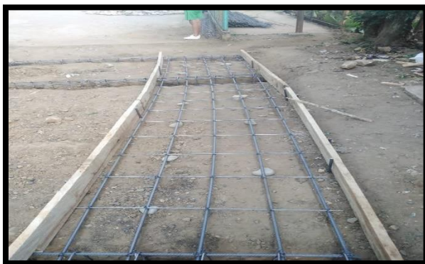
Figura 19. Ubicación malla y viga de refuerzo. Tramo4
