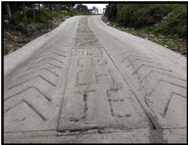
Figura 40. Tramo 3. Sector Garza – Zumbador
