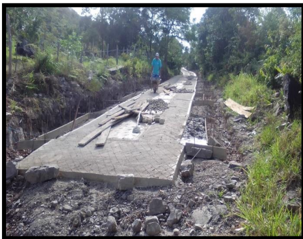
Figura 31. Fundición de sobre anchos
