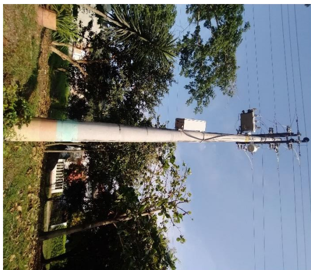
Poste de hormigón de 8 metros
